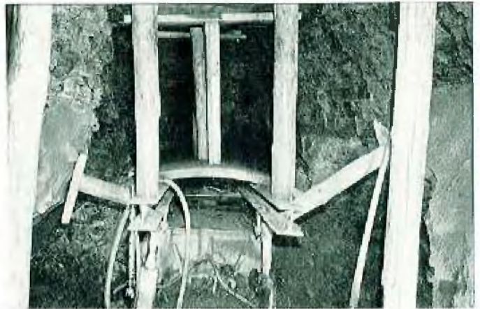
Firststollen über dem Dach der verschütteten TVM
