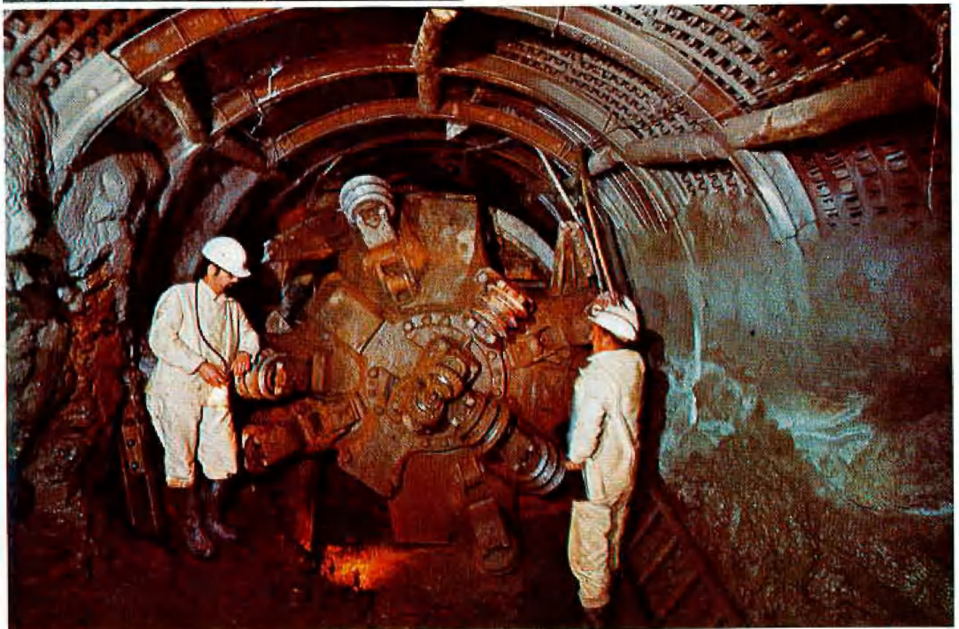
Stahlbogenausbau im Bereich über der TVM
