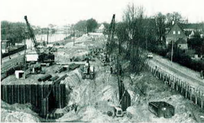
Blick vom Pumpenhaus auf Auslaufbauwerk und Pumpwerkskanal
