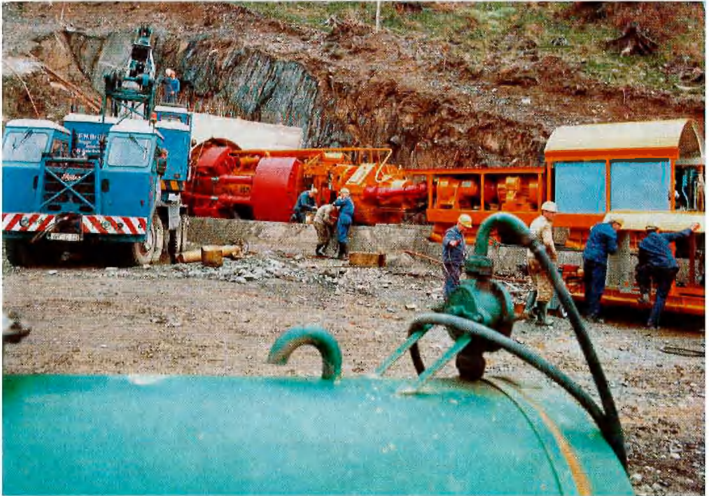
Montage der Tunnelvortriebsmaschine
