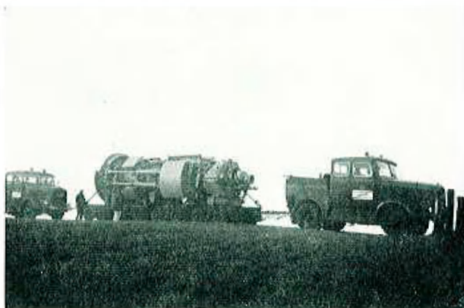
Antransport des Verspannteiles der TVM (Gewicht: 85t)
