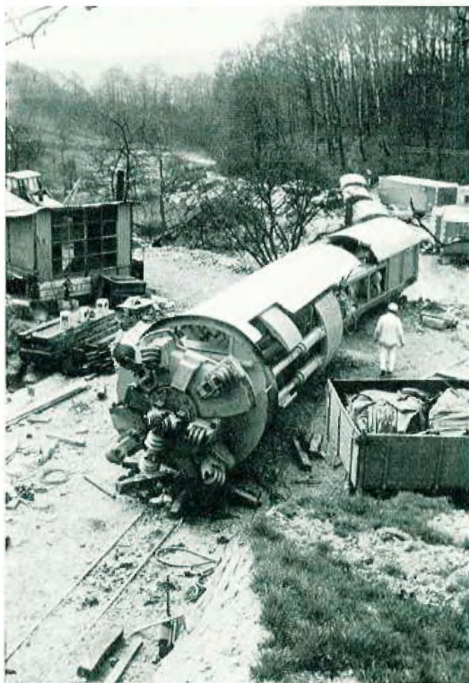
Montage auf der Baustelle
