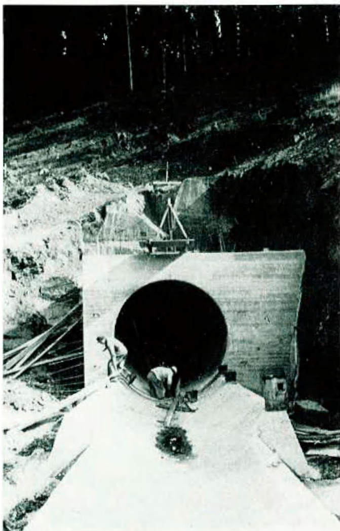
Baustelle bei Beginn der Arbeiten
