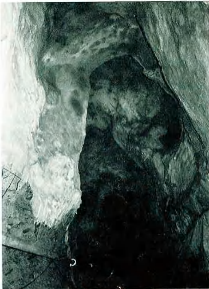
Große Ausbruchzone bei Station 0+685
