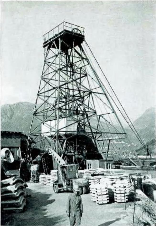
Bild 6: Lüftungsschacht Hospental, Bereitstellen der Fertigelemente für die Schachtauskleidung in der Nähe des Bohr- und Förderturmes
