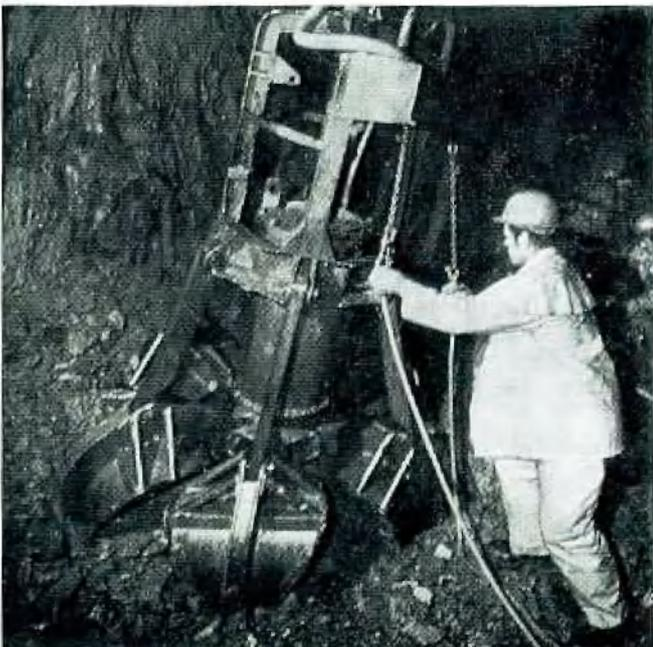
Bild 7: Lüftungsschacht Hospental, Schutterung mit Polyp-Greifer 0,5 m<sup>3</sup>
