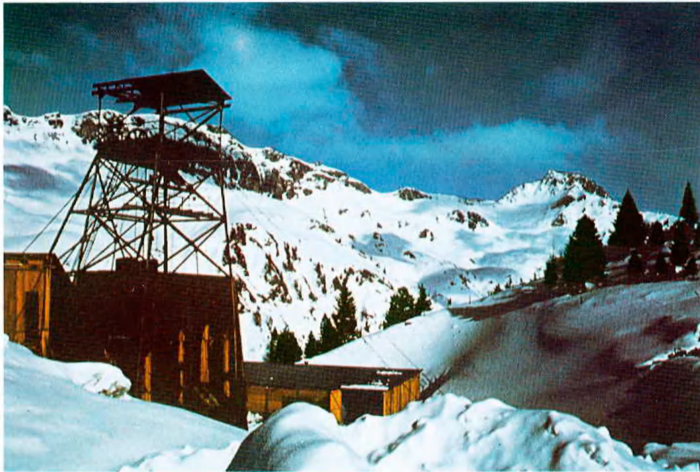
Lüftungsschacht für den Tauern-tunnel Ø 11,30 m, Teufe 600 m Schachtansatzpunkt 2000 m ü. NN 1971/1974 Abteufarbeiten Gebhardt & Koenig GmbH
