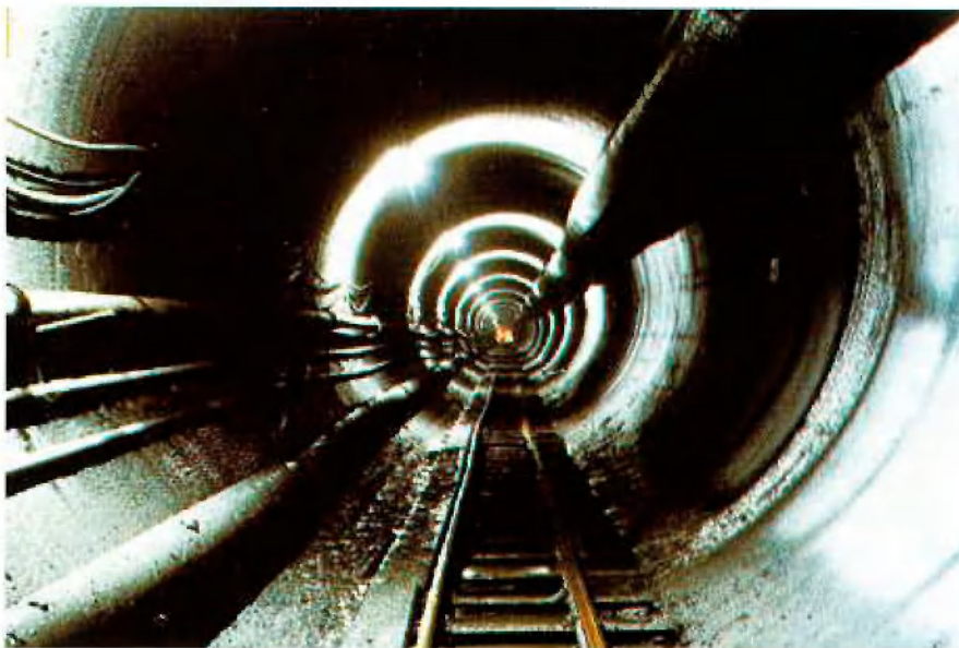
Abb. 11: Gebrohrte Stollenröhre
