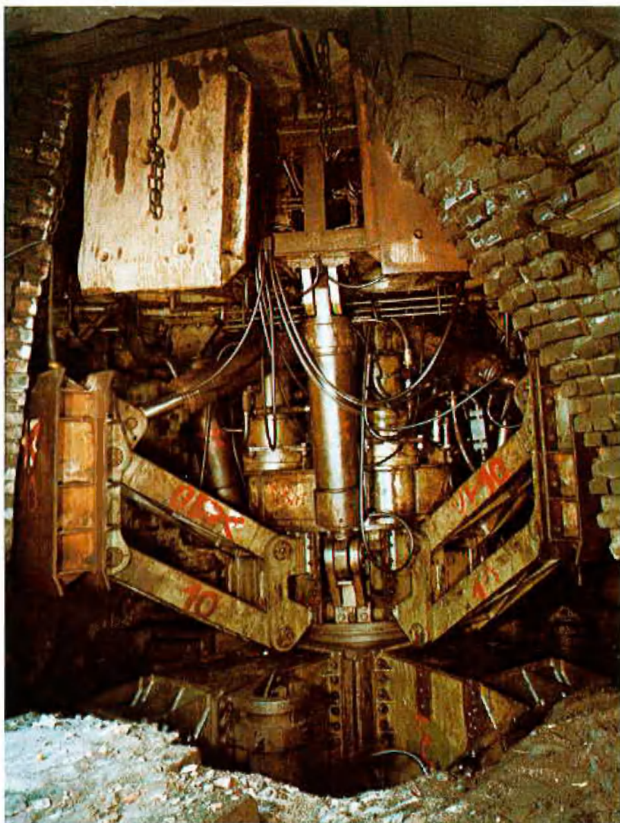
Abb. 1: Montage der Gesenkbohrmaschine auf der Schachtsohle mit Blick aus der Abwetterstrecke
