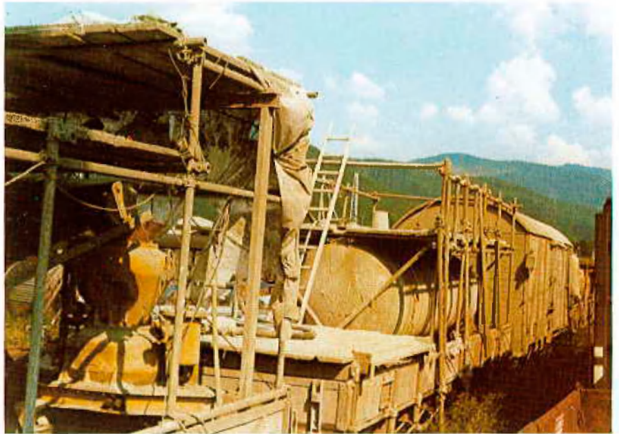
Abb. 4: Bauzug auf dem Abstellgleis
