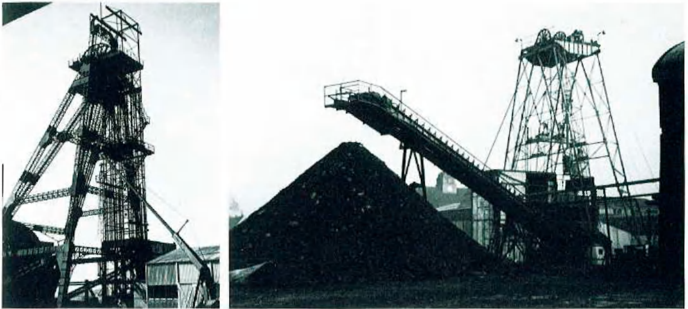
Abb. 2: Das um die Jahrhundertwende erbaute Fördergerüst
