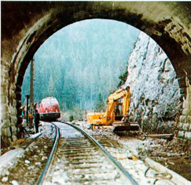
Abb. 2: Einfahrt eines Diesellokes in den Tunnel
