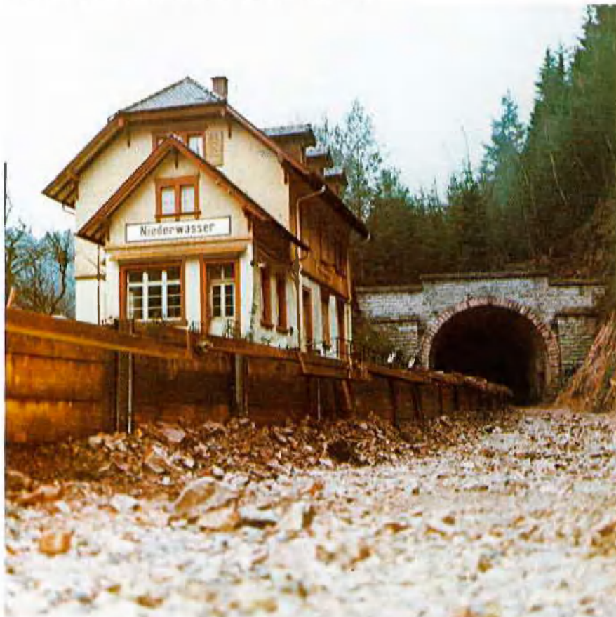
Abb. 7: Abgesenktes Arbeitsgleis mit Kantholz-Bohlenverbau
