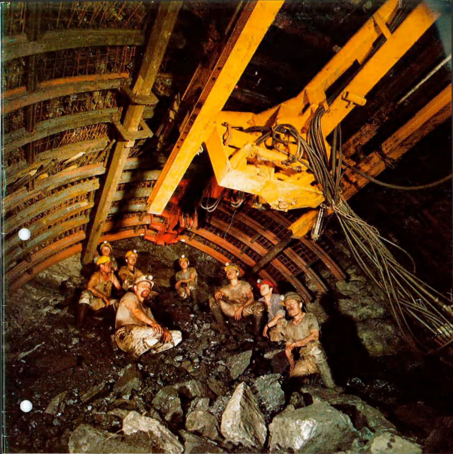
Vortriebsmannschaft vor Ort in der nördlichen Richtstrecke auf der Schachanlage Heinrich Robert.
