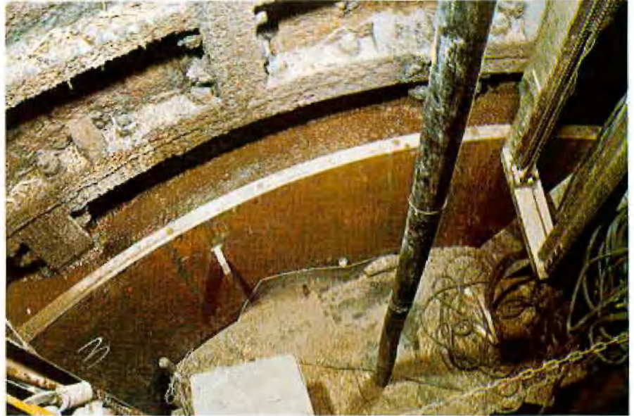
Abb. 4: Der Stahlblechmantel mit gerade eingebrachtem Beton und der alten Tübbingsäule
