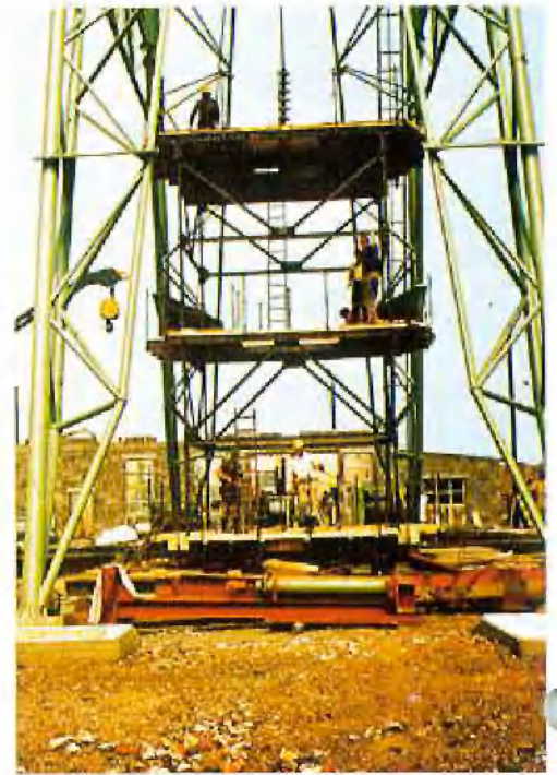
④ Montage der 3etägigen Arbeitsbühne
