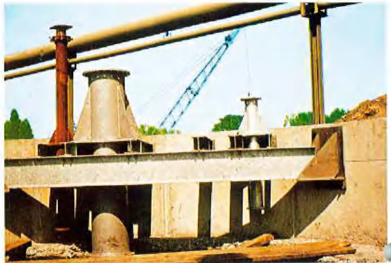
④ Montage der 3etägigen Arbeitsbühne
