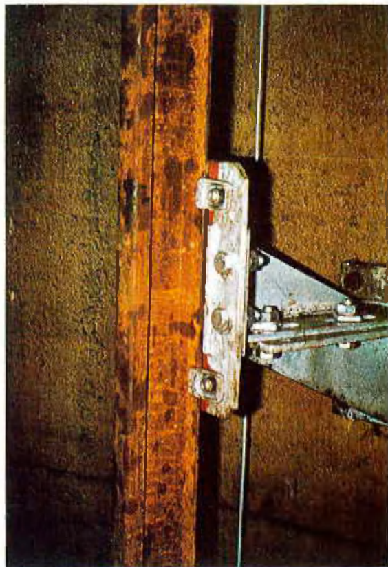
⑨ Schienen- führungsplatte mit Spurschiene und Colusal- anstrich
