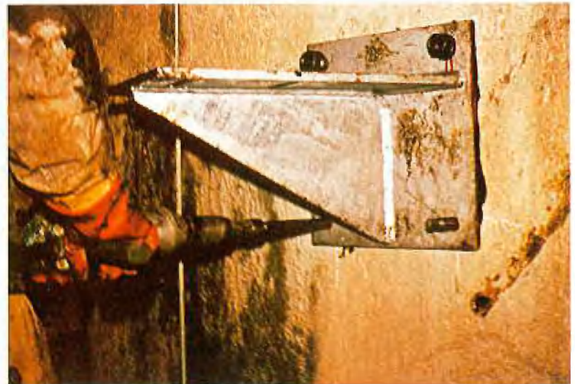
⑧ Befestigung der Unterkonsole am Schachtbeton
