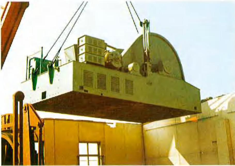
③ Einbau der 40 t-Bühnenwinde
