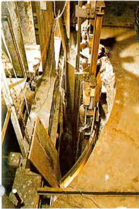
Abb. 3: Durch die Öffnung am Schachtkopf wird ein Stahlblechsegment eingelassen
