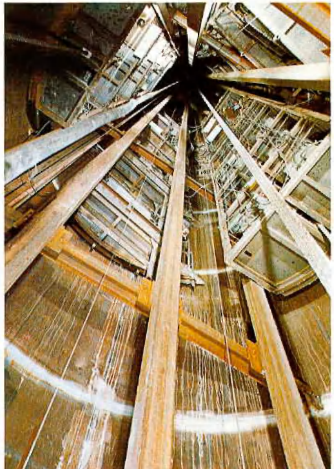
Abb. 5: Blick von unten auf die Vorbausäule und die 4 Arbeitsbühnen
