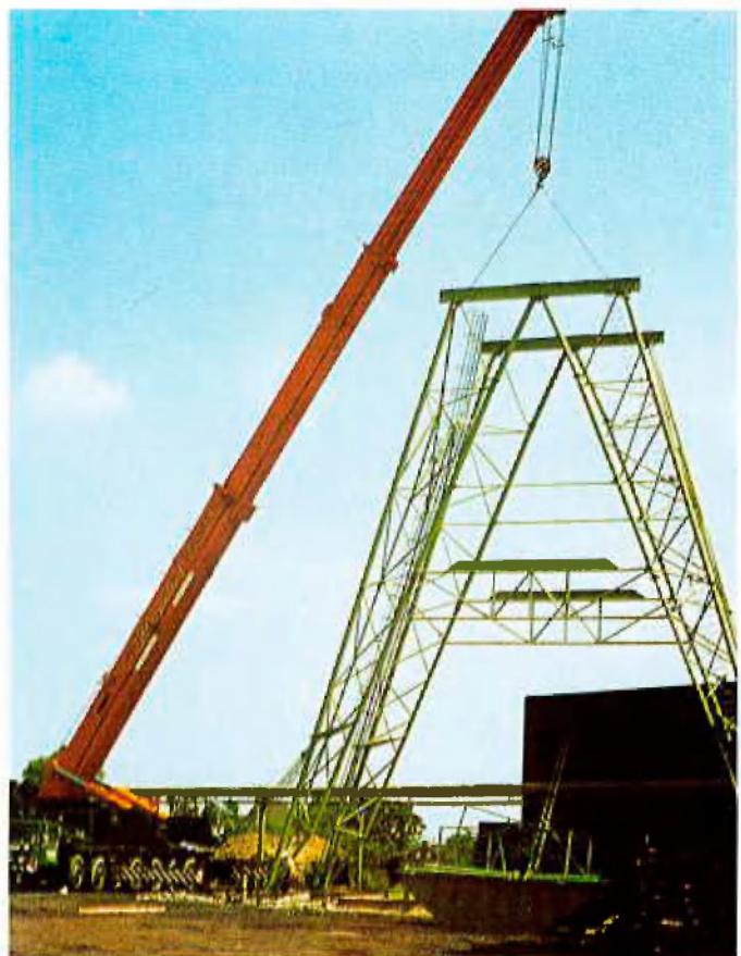
(2) Montage des Fördergerüsts
