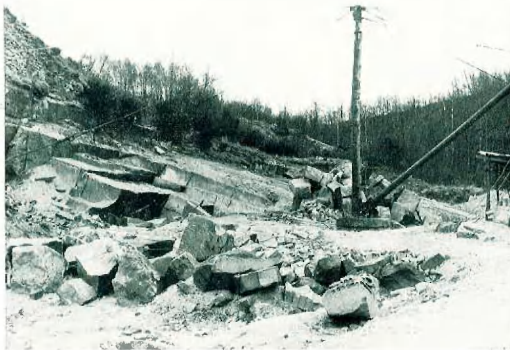
Steinbruch im Bentheimer Sandstein bei Gildehaus, der heute noch in Betrieb ist. Die losgehauenen schweren Blöcke werden mit dem Hebebaum transportiert.
