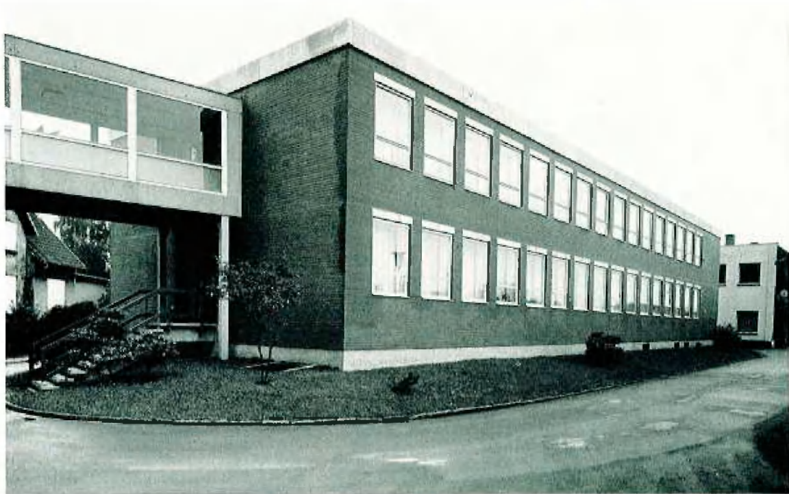
Neues Verwaltungsgebäude in Dortmund-Kurl
