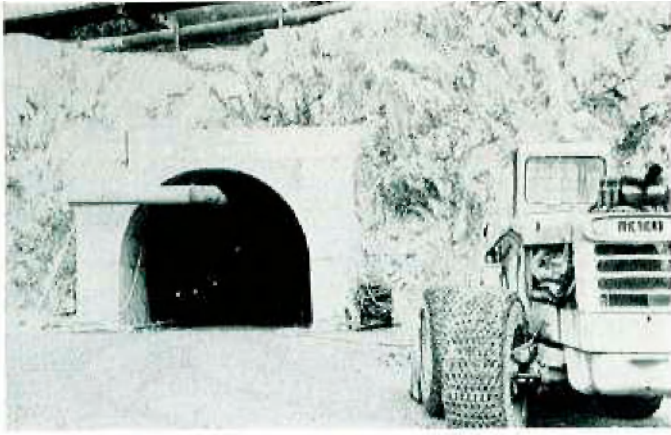
Der fertige Stolleneingang
