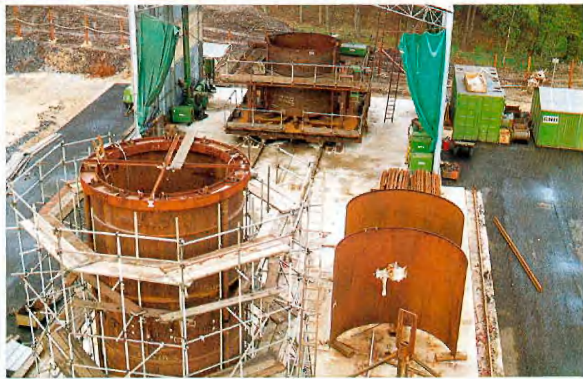
Der Ausbau wurde in Ringen von 3,60 m Höhe auf dem Schachtplatz vorgefertigt
