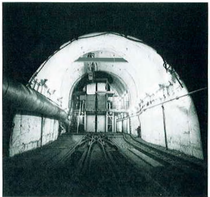
Abb. 11: Nördlicher umgebauter Füllortbereich auf der 4. Sohle
