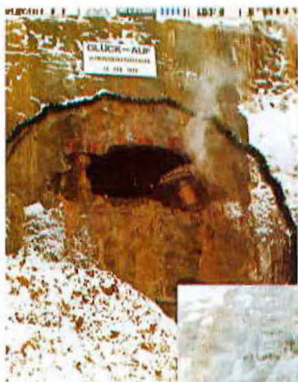
Durchbruch des Westfalia-Schildes mit eingebauter WAV 170 am Stolleneinlauf
