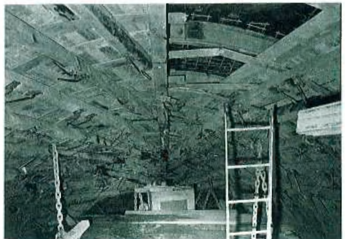
Abb. 12: Herstellung der Verschalung für die spätere Betonhinterfüllung
