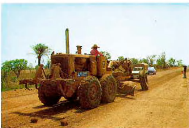
Straßenbau – Großgeräte im Einsatz
