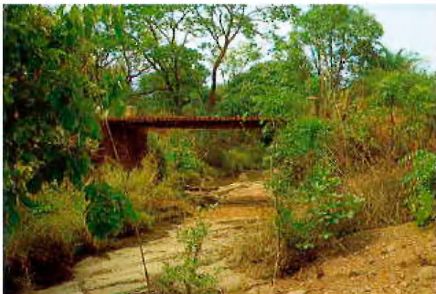
Typische alte Brücke
