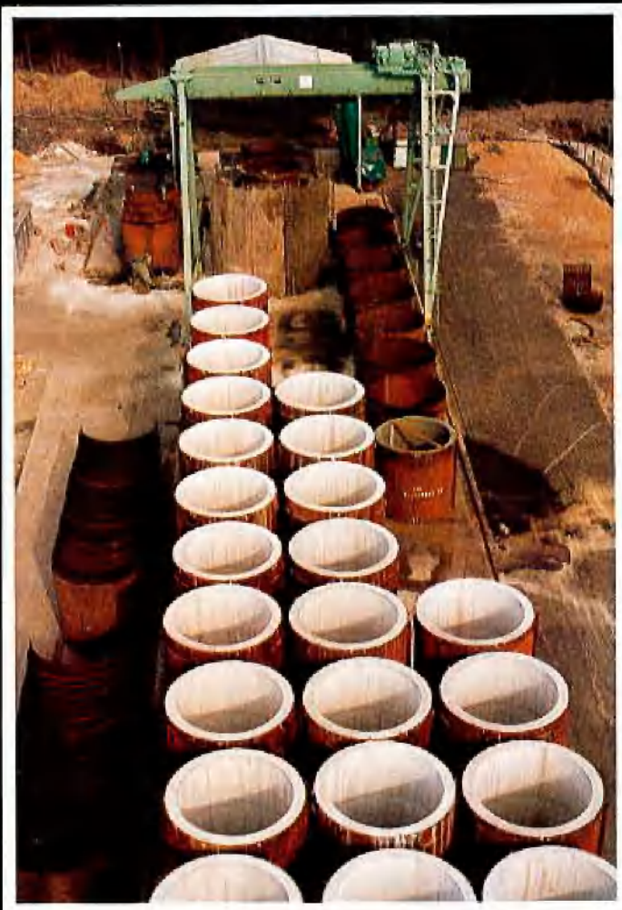
Insgesamt 112 Ausbauringe wurden hergestellt und übertage zwischengelagert
