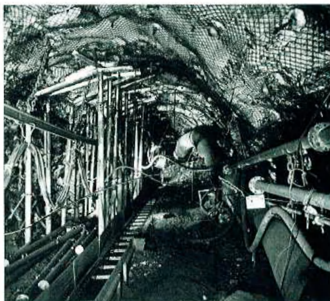
Abb. 7: Geankerte Strecke beim Durchlaufen des Abbaus im Bereich des Überganges Streb/Strecke
