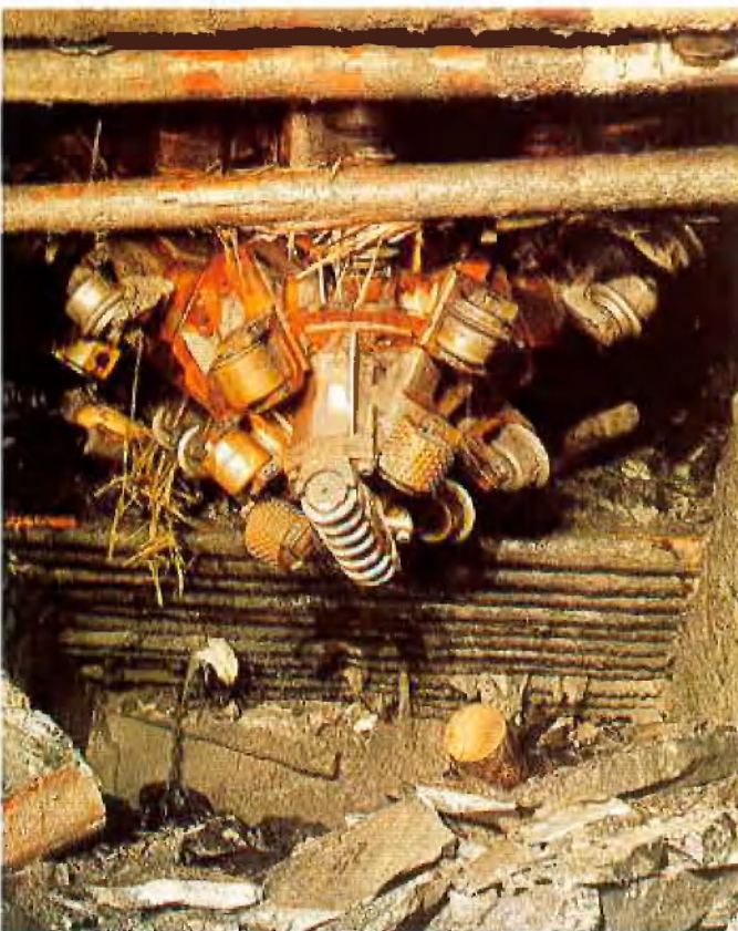
Abb. 4: Durchschlag der Gesenkbohrmaschine im Niveau -1121 m, Flöz 54
