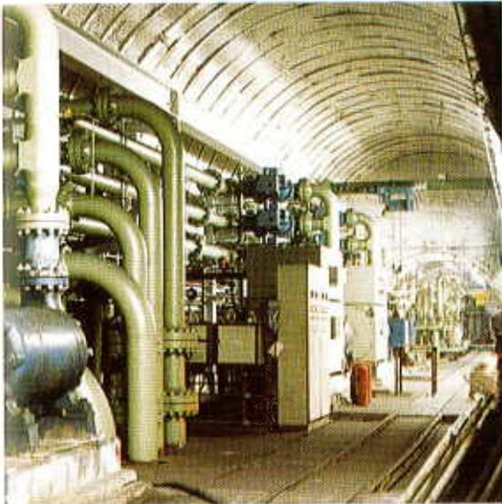
Abb. 6: Vollständig eingerichtete Pumpenkammer für die Druckwassererzeugung
