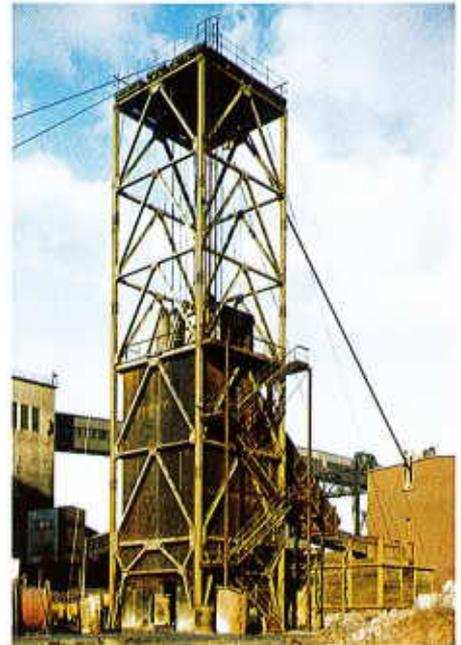
Vor Beginn der Erweiterung mußte der alte Förderturm abgetragen, ein Vorschacht von 9,40 m Tiefe hergestellt (Abb. 3) und der Schacht bis zur  $-780$  m Sohle vollkommen ausgeraubt werden. Darüber hinaus wurden das schadhafte Mauerwerk der Schachtröhre erneuert und die Füllörter sowie die Zugänge zum Schacht bis auf die erforderlichen Wetterdurchlässe außerhalb des Erweiterungsquerschnittes abgemauert.
