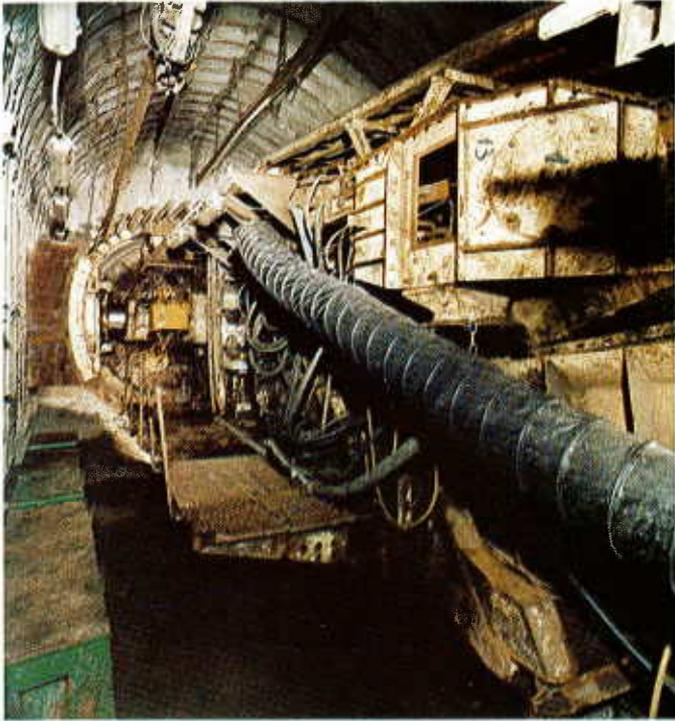
Abb.6: Robbins Vollschnittmaschine in der Montagekammer des 2. Bauabschnittes – im Hintergrund Startröhre –
