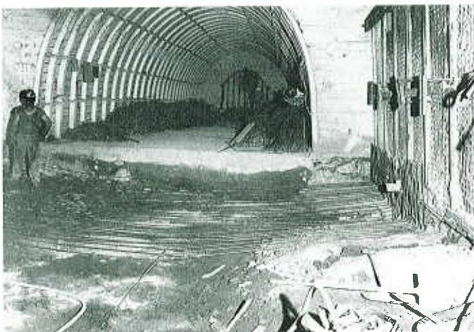
Die erste in Angriff genommene Pumpenkammer (Abb. 5 + 6) und das darauf folgende Rohrkohlenbecken 2 wurden aus dem Vollen hergestellt. Die Auffahrung der übrigen Räumlichkeiten – wie das Klarwasserbecken (Abb. 7), das Rohraufgeberrückführbecken, das Schmutzwasserbecken (Abb. 8), die Aufgabestation (Abb. 9) sowie das Rohrkohlenbecken 1 – erfolgte nach dem Vortreiben von entsprechenden Pilotstollen – teilweise auch im Gegenortbetrieb – stufenweise in 2 Scheiben.
