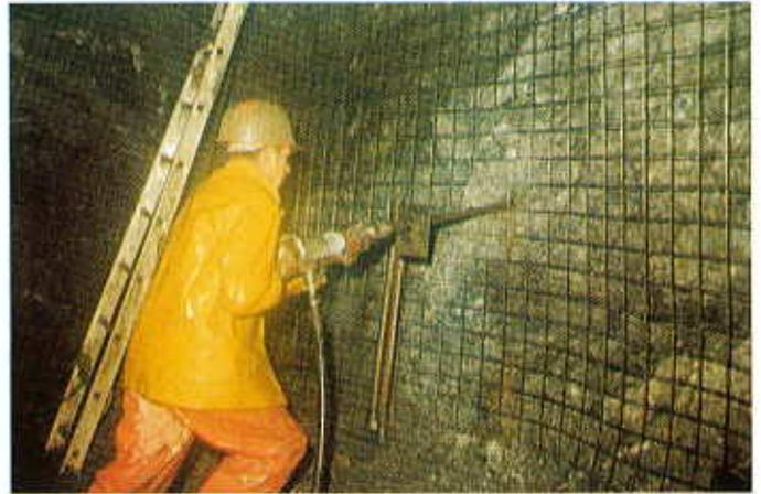
Abb. 5: Setzen eines Ankers
