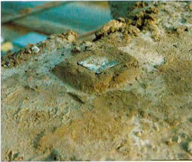
Abb. 10: Einniveillierte Kunststoffplatte als Absetzpunkt für die Fertigteile
