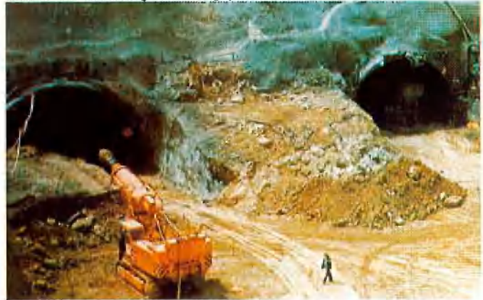
Abb. 6: Pfaffensteiner Tunnel, Regensburg
