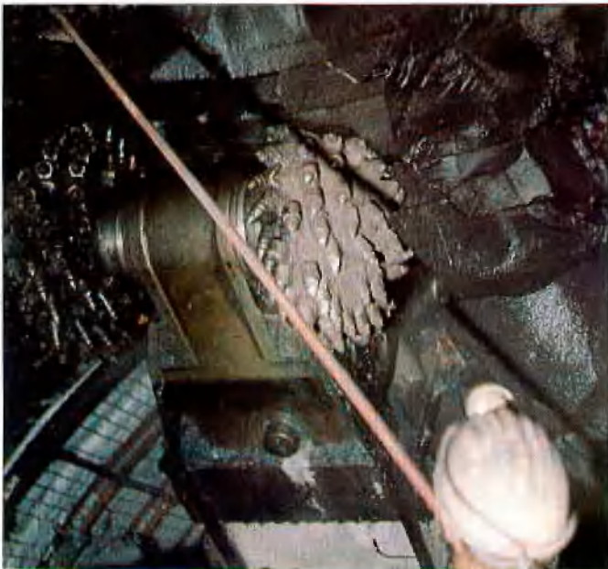
Abb. 6: WAV-200 der Firma Westfalia beim Durchschlag in Flöz Johann, Strecke 705, 4. Bauabschnitt
