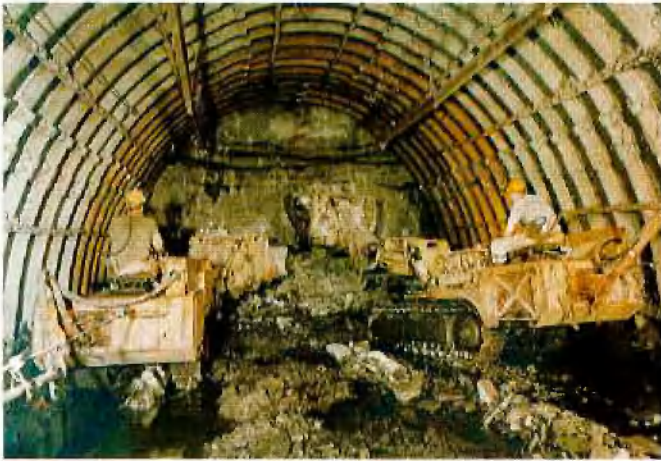
Abb. 1: Elektrohydraulische Deilmann-Haniel Lademaschinen M 412 bei der Wagenbeladung
