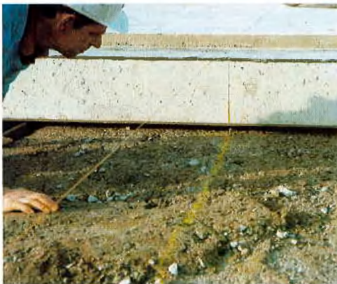
Abb. 12: Ausrichten des Fertigteils an den vorbereiteten Markierungen
