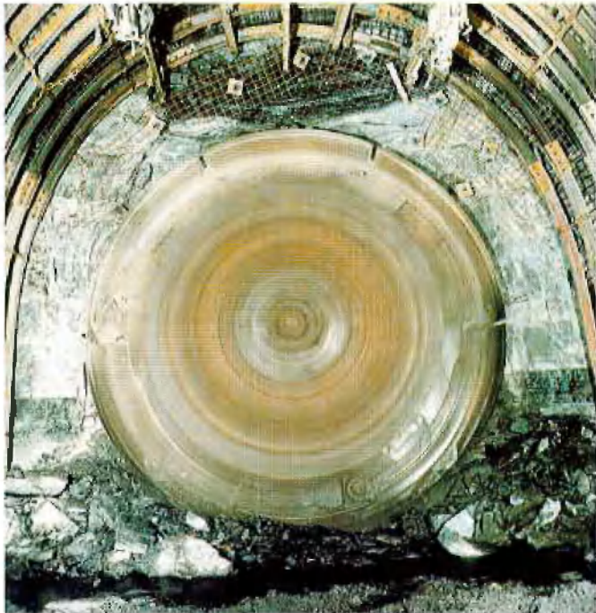
Abb. 2: Durchschlag der Robbins-Vollschnittmaschine Typ 163/136/2 in der Diagonalen zur Materialrichtstrecke
