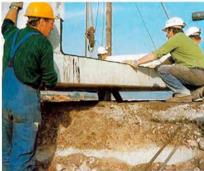
Abb. 11: Absetzen eines Fertigteils
