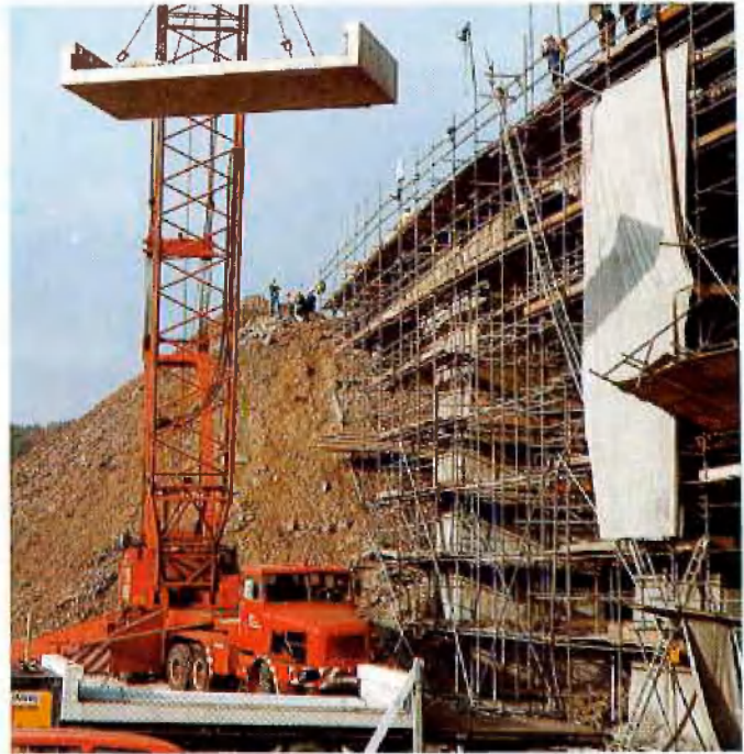
Abb. 8: Einheben eines Fertigteils
