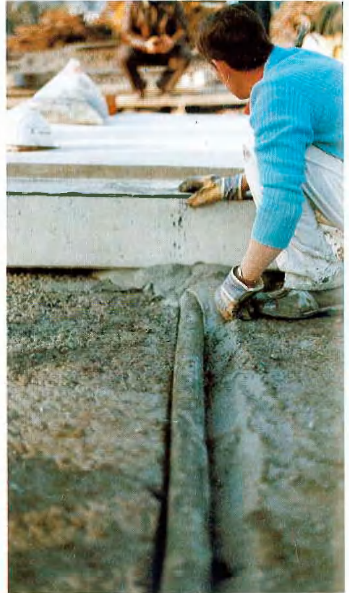
Abb. 13: Die Fertigteile werden nach dem Ausrichten mit Mörtel unterpreßt
