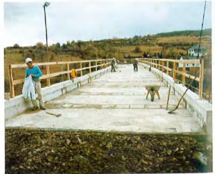
Abb. 14: Für den ersten Brückenabschnitt sind die Teile verlegt und die Fugen geschlossen
