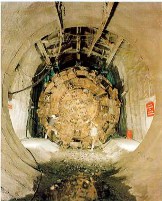
Abb. 1: DEMAG-Vortriebsmaschine TMV-54-58/61H beim Endzusammenbau in der Montagekammer vor der Startröhre
