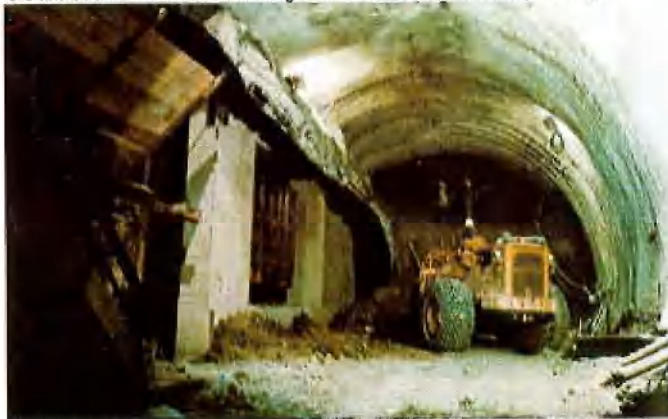
Abb. 3: Stadtbahnbau Bochum: Herstellung der Station „Berliner Platz“ nach einem Sondervorschlag der B und M, Innsbruck (1974/76)
