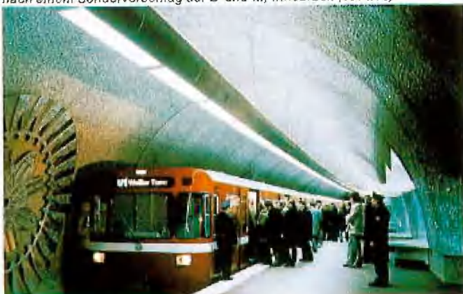
Abb. 4: U-Bahnbau Nürnberg Station Lorenzkirche (1975/76)
