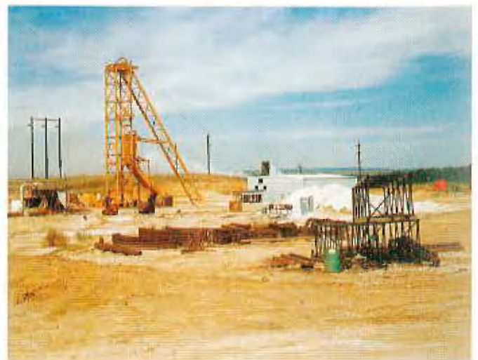
Abb. 3: Abteufgerüst, Weeks Island Mine
