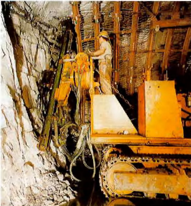
Abb. 3: Deilmann-Haniel Ankerbohrwagen beim Einbringen eines Stahlankers
