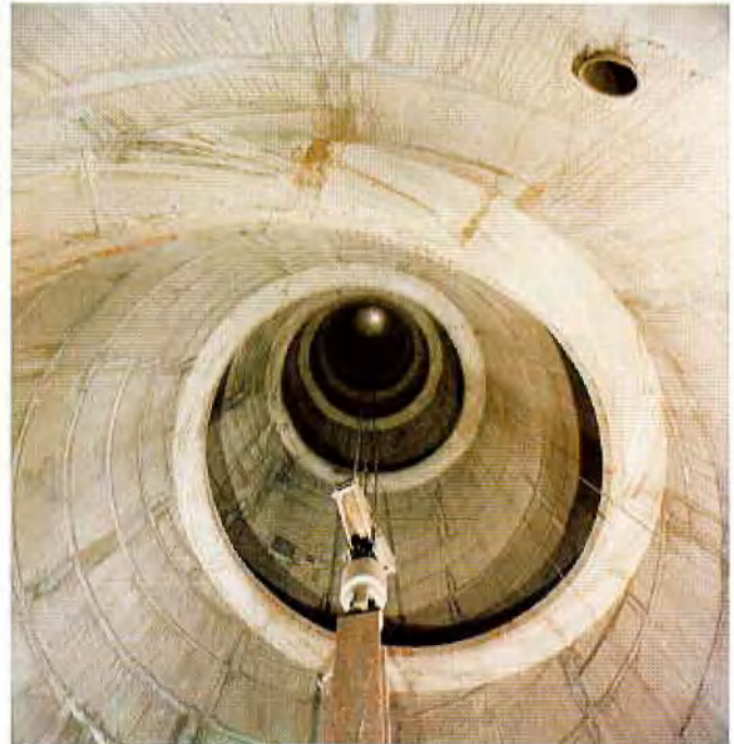
Abb. 3: Blick in den fertiggestellten Bunker von der unteren zur oberen Sohle
