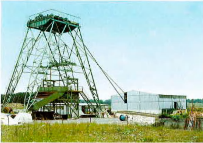
Abb. 8: Tagesteufeinrichtungen für das Vertiefen des Schachtes 8 der Gewerkschaft Auguste Victoria. Fördergerüst Bauweise Deilmann-Haniel
