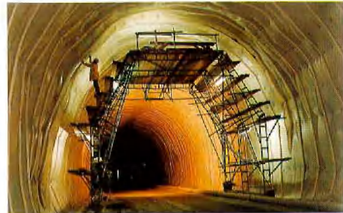
Abb. 8: Pfändertunnel Bregenz, Vorarlberg, in Bau
