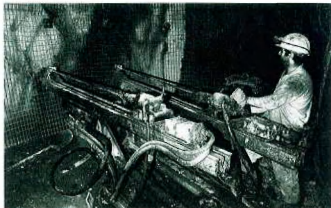
Abb. 4: Bohren der Löcher für die Sprezhülsenanker von der Arbeitsplattform der Gesenkböhrmaschine aus
