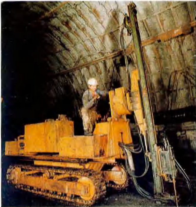
Abb. 4: Herstellen der 6,0 m langen Sohlenankerlöcher mit einem Deilmann-Haniel Ankerbohrwagen
