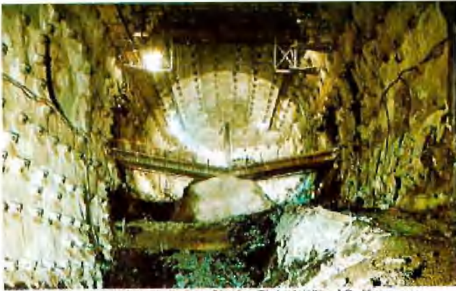
Abb. 1: Kaverne Waldeck II, Preußische Elektrizitäts AG, Hannover Ausführung in deutsch-österreichischer Arbeitsgemeinschaft (1970/74)
