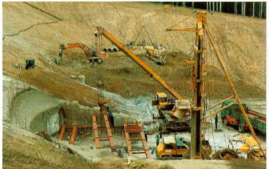
Abb. 13: Einbringen der Bohrpfähle mit Benoto-Anlage
