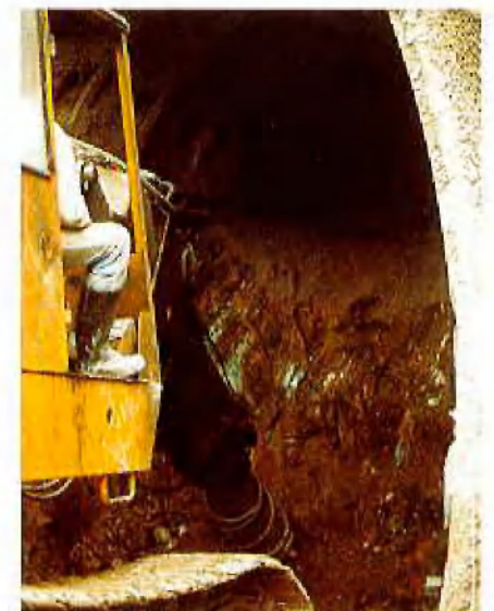
Abb. 7: Fräsen des Ulmenstollens
