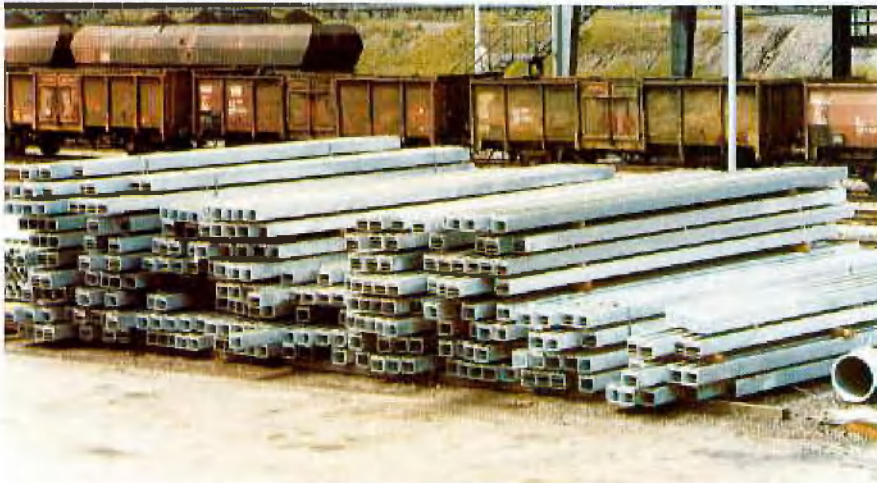
Abb. 2: Stahlsplattens-Lagerung in Einbauabfolge
