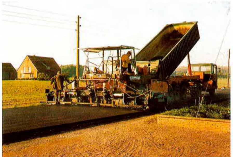
Einbau der Asphaltfeinbeton-Deckschicht
