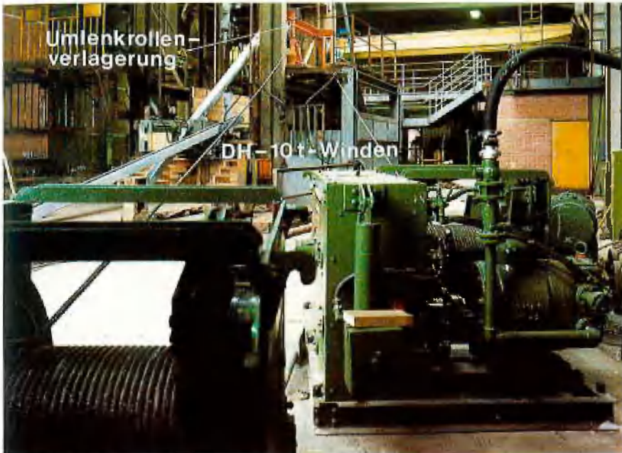
Abb. 4: D-H 10-t-Druckluftwinden und Verlagerung der Zugseilumlenkrollen am Fördergerüst
