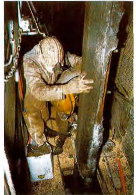
Abb. 9: Zersägen der Holzspurlatte
