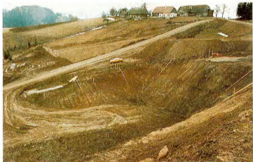
Abb. 9: Phase 1: Aushub der Firste
