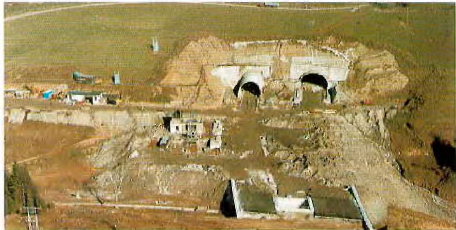
Abb. 2: Portal Großliedtunnel Süd
