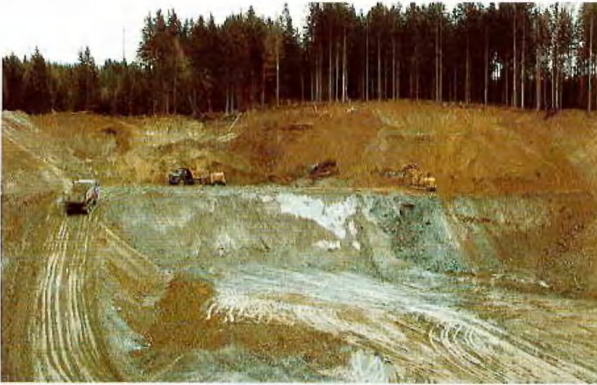
Abb. 4: Voreinschnitt in den mylonitischen Bereichen
