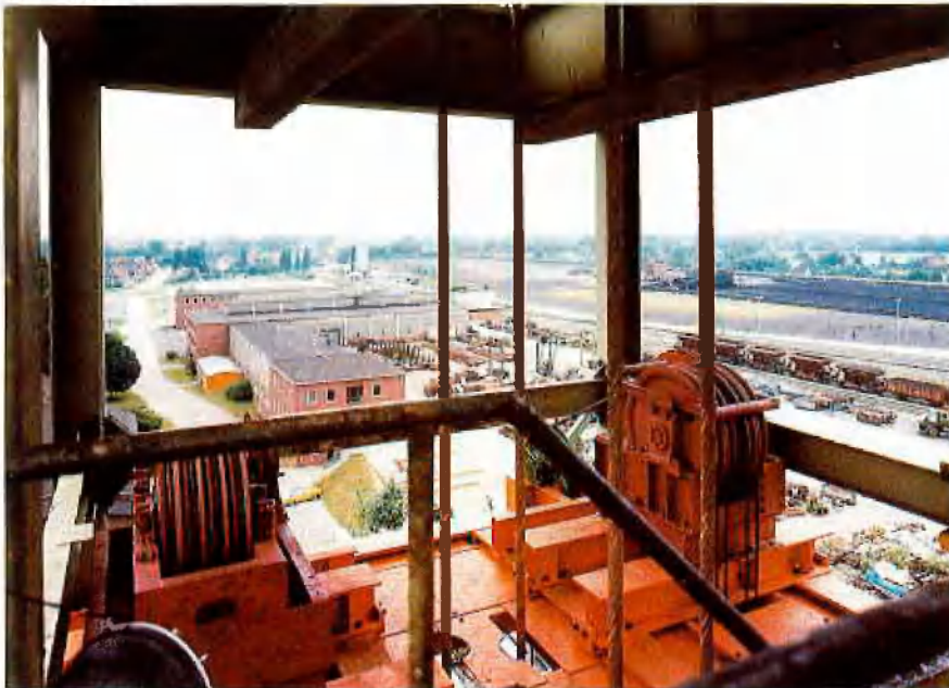
Abb. 5: Verlagerungsbühne für die Rollenböcke der Unterflaschen im Fördergerüst
