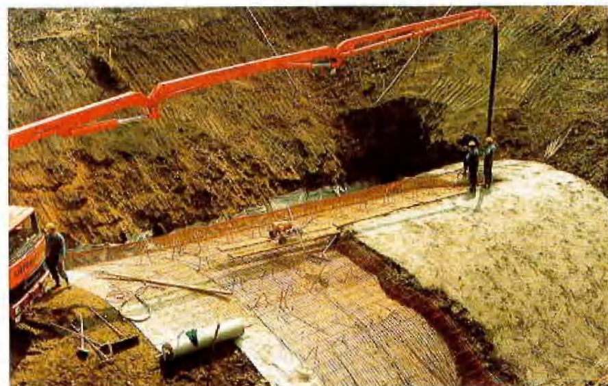
Abb. 11: Phase 3: Bewehren und Betonieren
