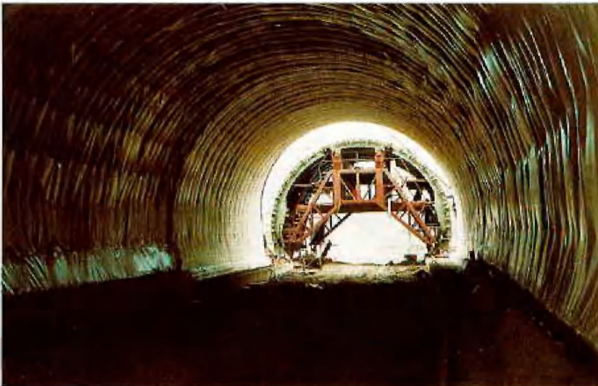
Abb. 5: Eingebaute PVC-Isolierung und Schalwagen für Innenbeton
