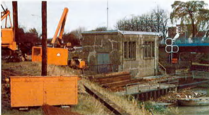
Kanalpumpwerk Hamm-Werries am Hamm-Datteln-Kanal
