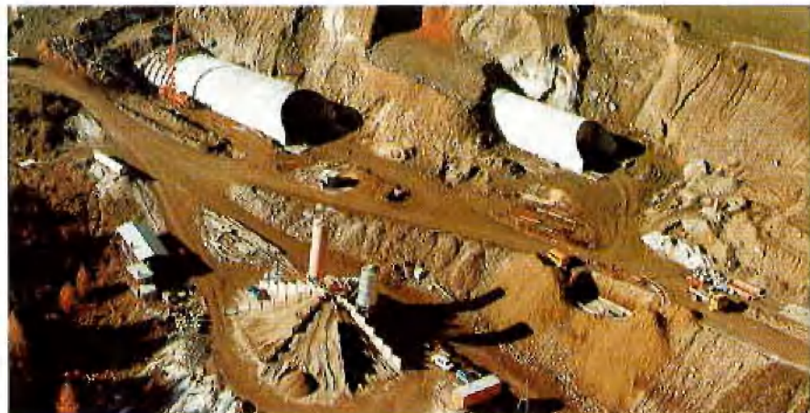
Abb. 3: Portal Großliedtunnel Nord
