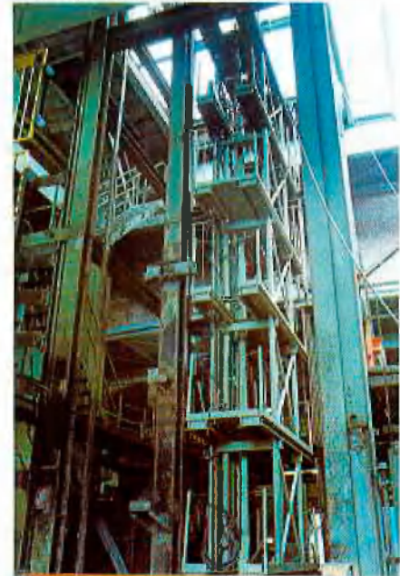
Abb. 7: 5-etagiges Montagegerüst oberhalb des Korbdeckels
