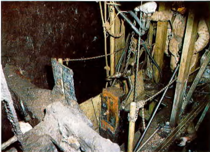
Abb. 8: Anhängen und Herausziehen der alten gelösten Holzspurlatte vom obersten Arbeitsdeck des Korbausatzes aus
