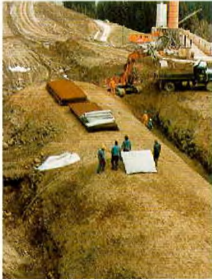
Abb. 10: Phase 2: Aushub und Profilierung
