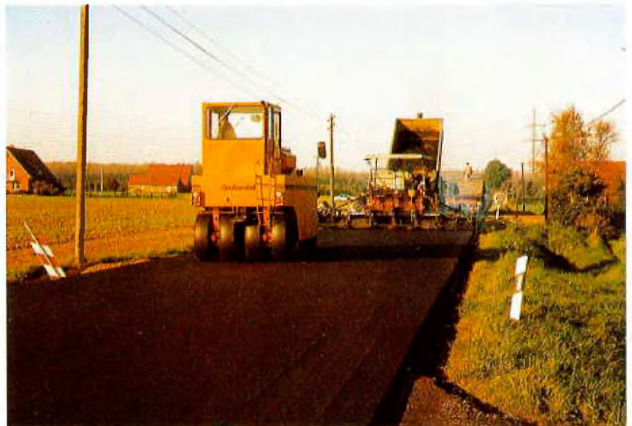
Abwalzen der Deckschicht mit Gummiradwalze
