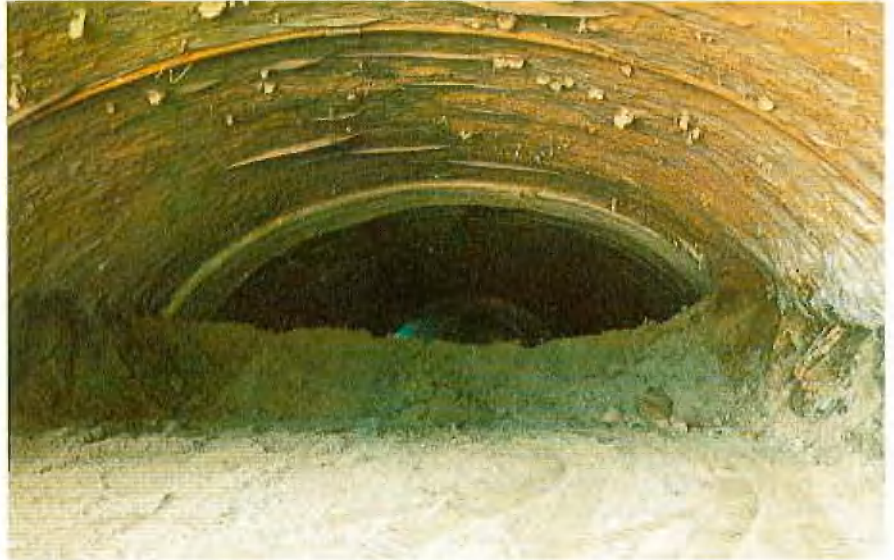
Abb. 12: Deckelunterseite nach dem Auffahren der Kalotte
