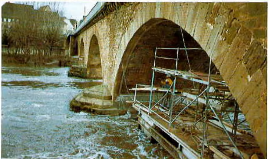
Alte Neckarbrücke Lauffen
