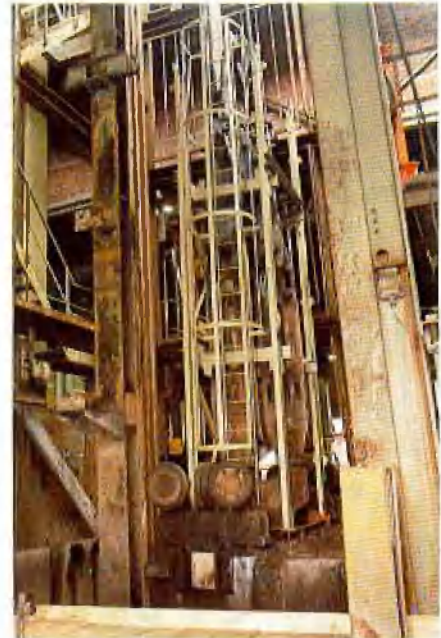
Abb. 6: Unterbau und Befestigung der Montagebühne auf dem Korbdeckel
