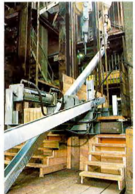
Abb. 12: Hereinziehen der Stahlsperlatten
