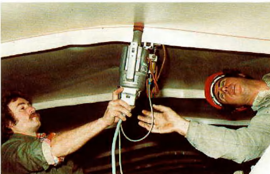
Abb. 6: Schweißen der prüfbaren Doppelnaht
