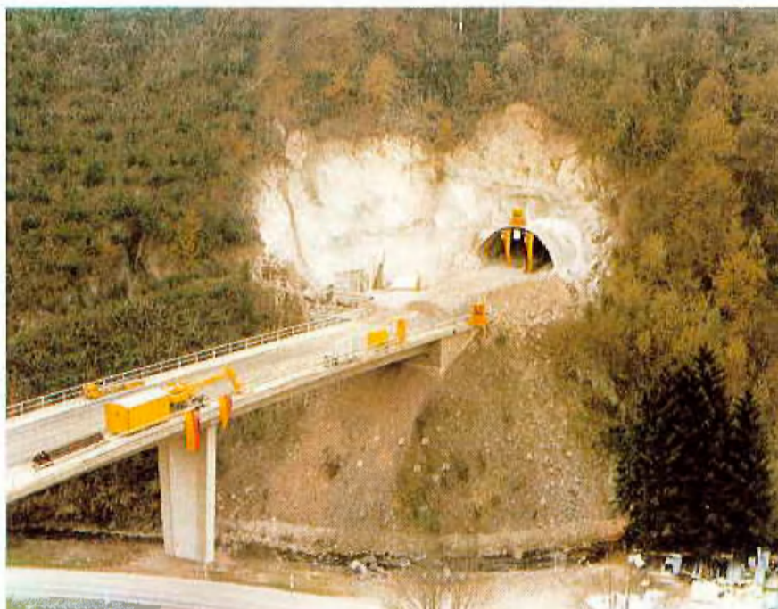
Blick auf die Baustelle
