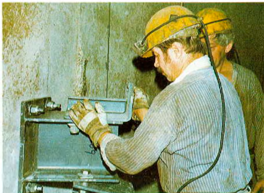
Letzter Handgriff zum Einbau einer Spurlattenkonsole
