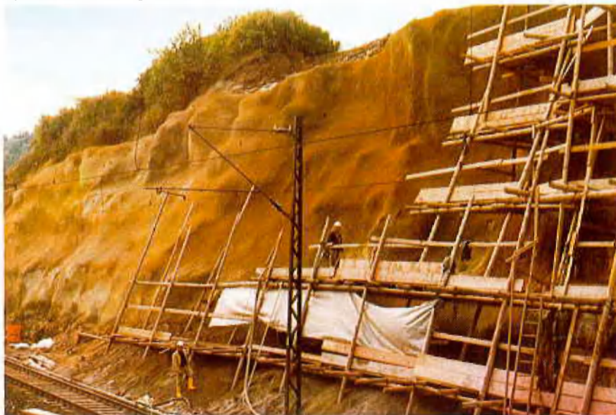
Felssicherung Gundelsheim-Möhren, Schutz- und Arbeitsgerüst, bereits fertiggestellte Spritzbetonsicherung rechts der Bahn
