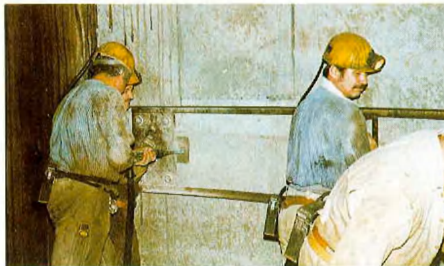
Bohren der Ankerlöcher mit Hilfe einer Schablone
