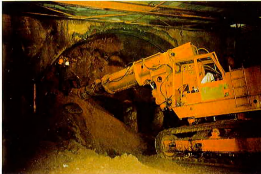
Teilschnittmaschine Demag H 41 kurz nach dem Tunnelanschlag in der Kalotte im Probetunnel Waldau
