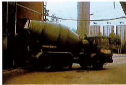
Anlieferung des Fertigbetons
