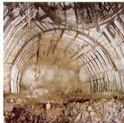
Abb. 8: Blick von Westen auf die fertiggestellte östliche Füllortkonstruktion in Verbindung mit dem endmontierten Sohlenrahmen. Im Hintergrund mit Ankern und bewehrtem Spritzbeton gesicherte Ortsbrust (Zeichnung 6)
