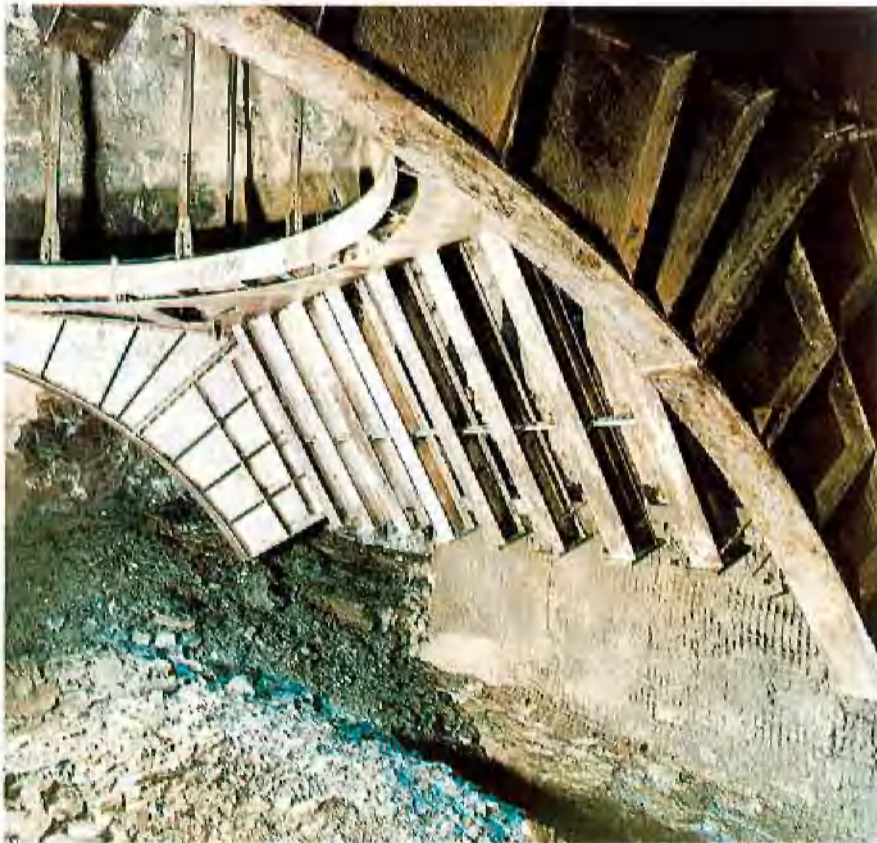
Abb. 3: Südlicher Schachtbereich mit oberen Glockenspiegel- und Stempelsegmenten sowie gesicherter Hohlraum des ehemaligen Flözes Zollverein 7/8 (Zeichnung 3)
