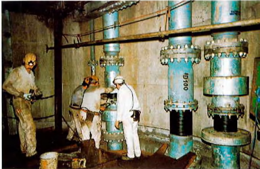
Einbau von „Stopfbüchsenrohren“
