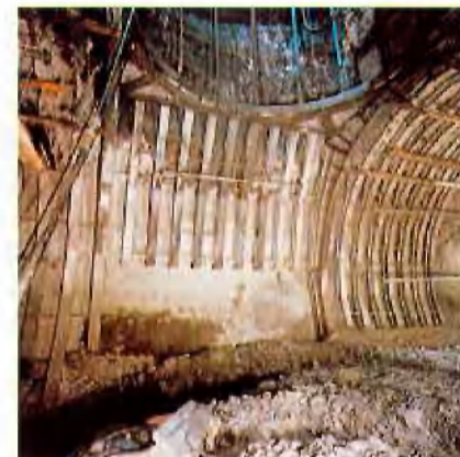
Abb. 9: Blick aus dem gesicherten Schachtsumpf in den oberen Schachtbereich in östlicher Richtung mit der dort aufgehängten gesamten Schachtglocken- und Füllortkonstruktion (Zeichnung 6)
