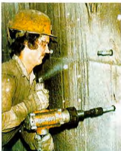
Setzen eines Klebankers
