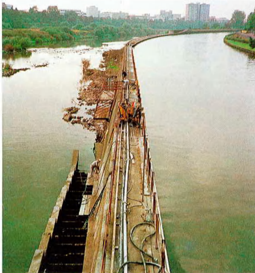
Trennmauer vom Wehr aus, rechts Neckarschiffahrtskanal, links Neckarunterwasser, Fischtreppe, fahrbares Hängegerüst
