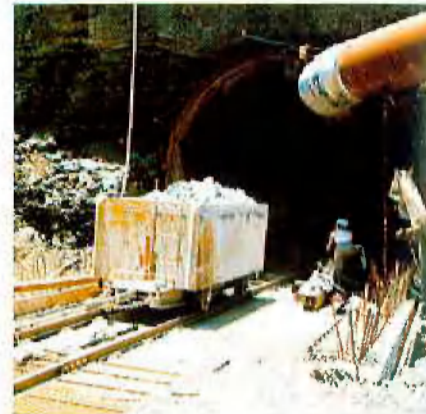
Portal des Schrägschachtes
