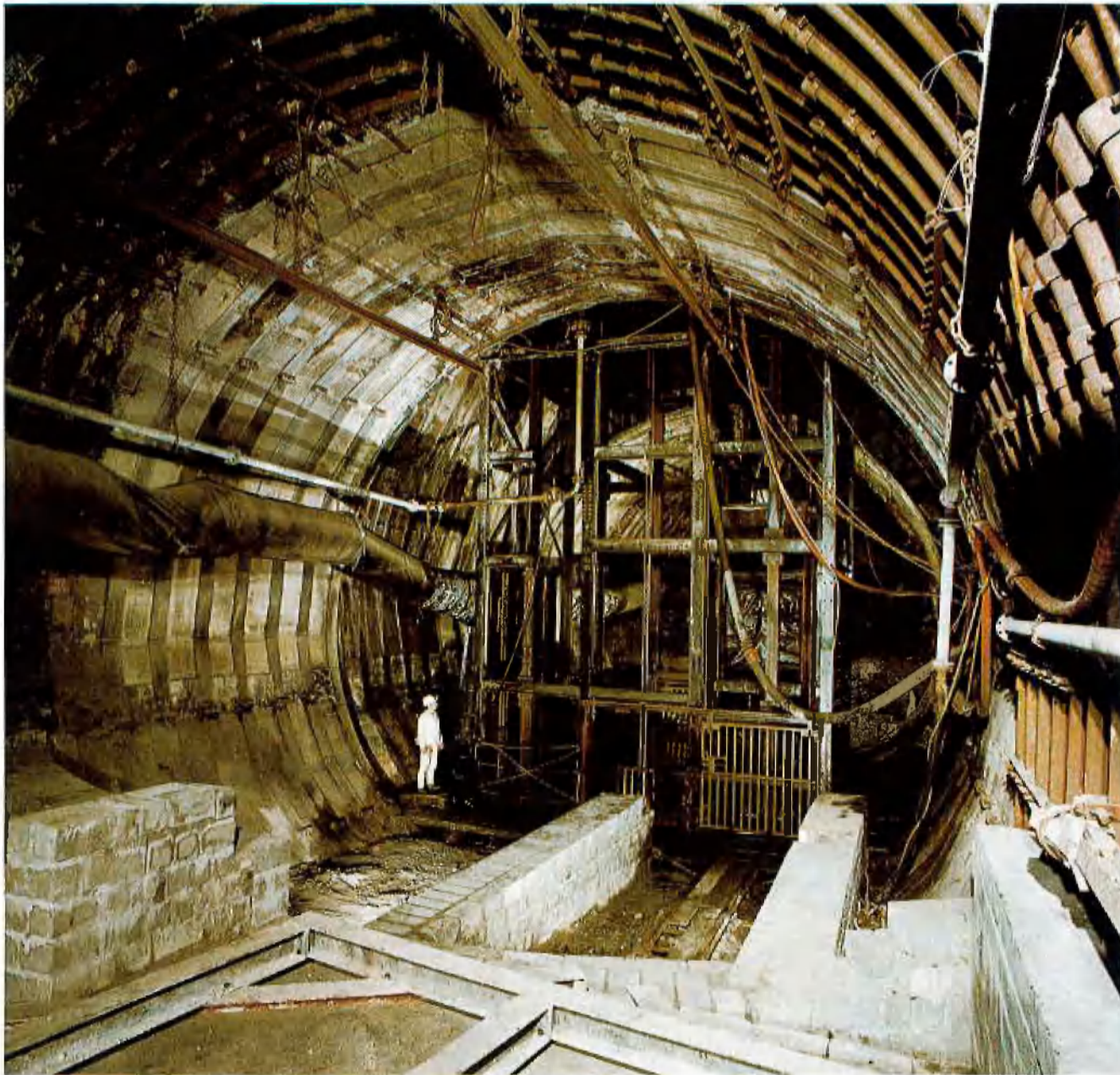
Abb. 10: Blick von Westen in das im Endausbau befindliche Füllort der 7. Sohle mit hinterfüllter Schachtglocke, heruntergelegter Förderung und entstehenden Seilfahrts- und Aufschiebekellern.
