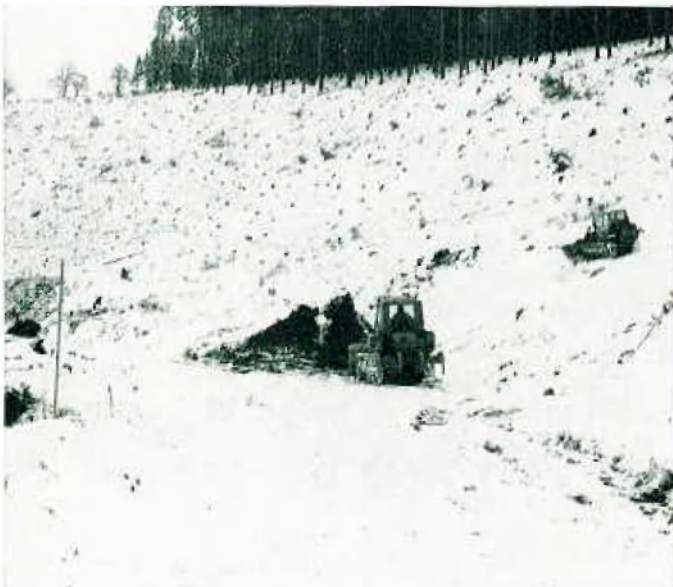
Bild 1: Beginn der Bauarbeiten am Oker-Grane-Stollen im März 1968
