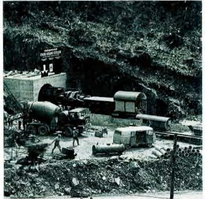
Bild 3: Montage der Tunnelvortriebsmaschine und Aufbau der restlichen Baustelleneinrichtung auf dem Planum vor dem Stollennmund
