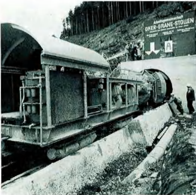
Bild 4: Tunnelvortriebsmaschine beim Einfahren in den Vorstollen
