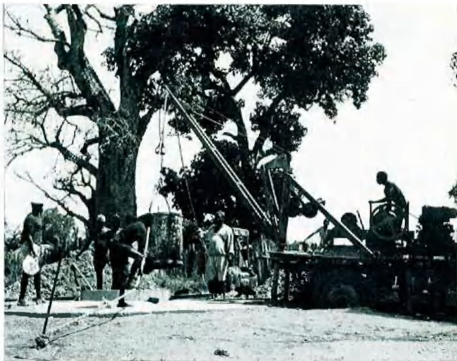
Bau eines Schachtes in Cayamancel/Senegal
