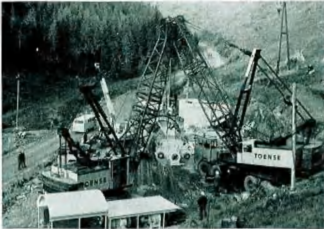
Bild 2: Absetzen des rd. 90 t schweren Maschinenkörpers der Tunnelvortriebsmaschine auf die Montagewanne
