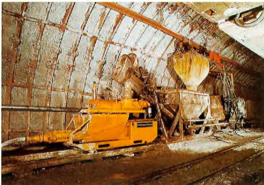
Abb. 8: Putzmeister-Schneckenpumpe „Betojet S8“ mit Bunker bei Baustoffanlieferung in „Big-Bags“ im Querschlag
