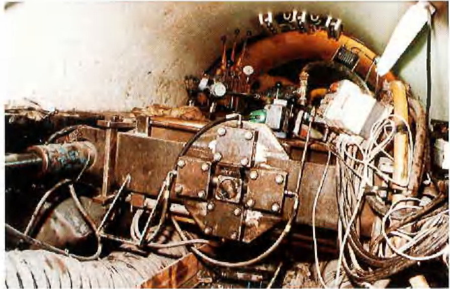
Fernwärmeversorgung Bochum – Steuerstand der Vortriebsmaschine
