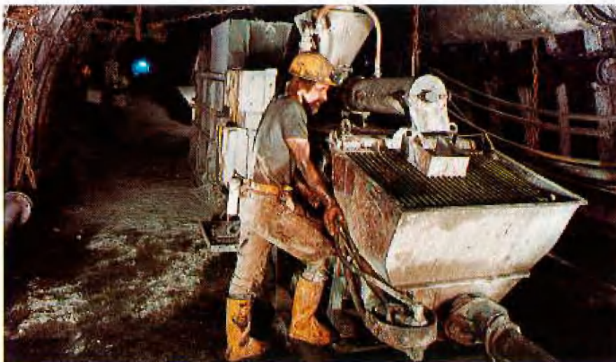
Abb. 5: „Elefantino“ mit Durchlaufmischer und Fluidbunker im Gesteinsberg
