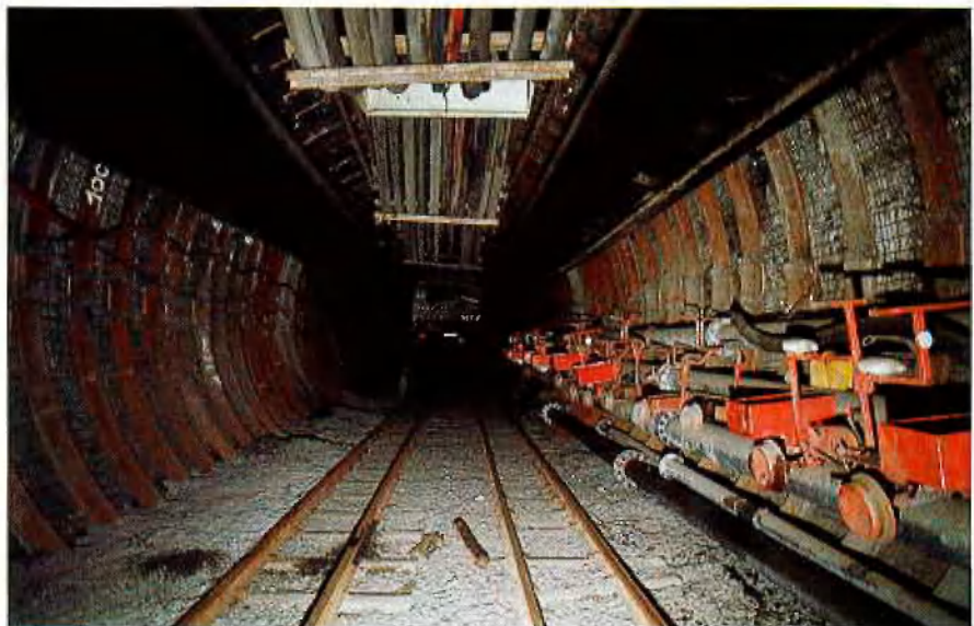
Abb. 8: Aufgefahrene Strecke mit bereitgestellten Flucht-Fahrrädern
