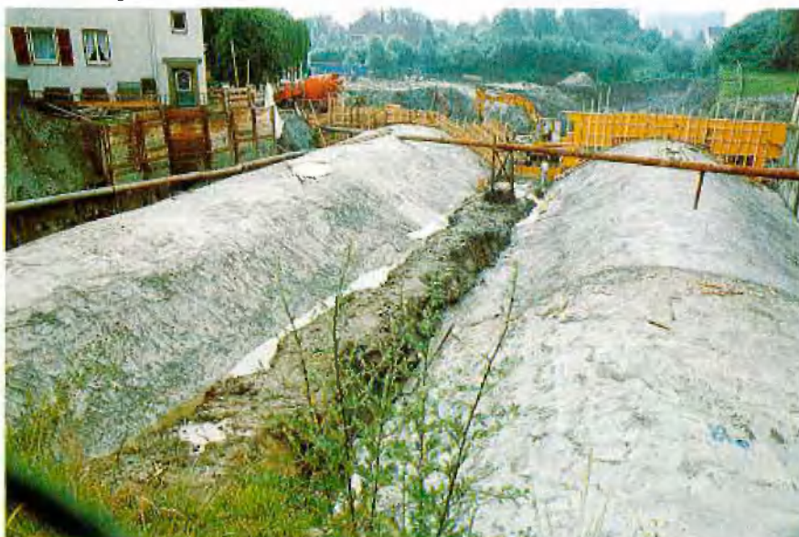
Abb. 5: Fertig betonierter „Kärntner Deckel“
