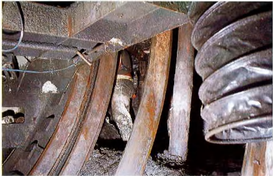
Abb. 4: Stoßseitiger Bypass am Bohrkopf
