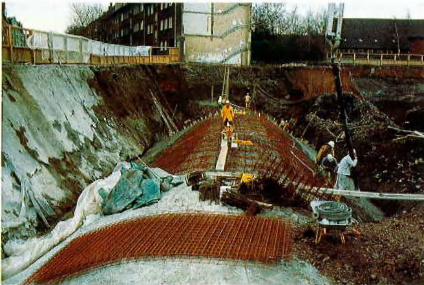
Abb. 4: Bewehrungsarbeiten am „Kärntner Deckel“
