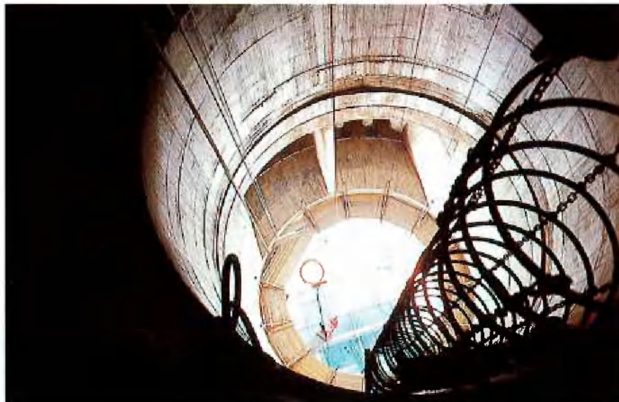
Lohberg 4: Blick gegen die Schachttöpfung mit Wetterkanalabgang
