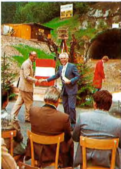
Anschlag des Wolfsbergtunnels
