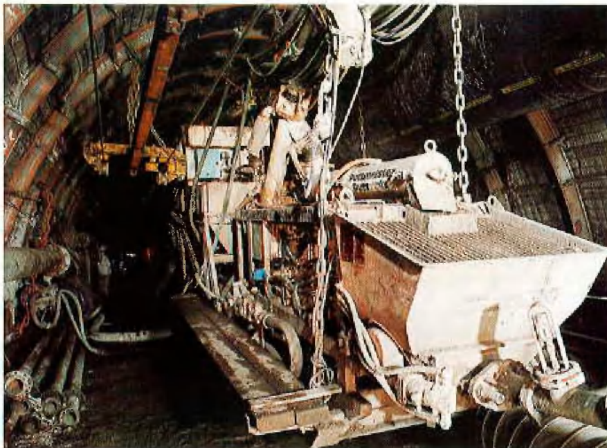
Abb. 6: „Elefantino“ mit Durchlaufmischer und Bunker mit Förderschnecken in einer TSM-Flözstrecke
