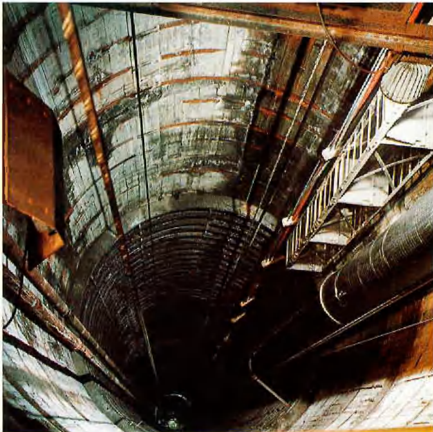
Blick in den Vollbohrschacht mit Förder- und Rückführwasserleitung
