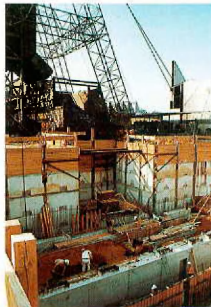
Lüfterbauwerk Schacht Haltern 2
