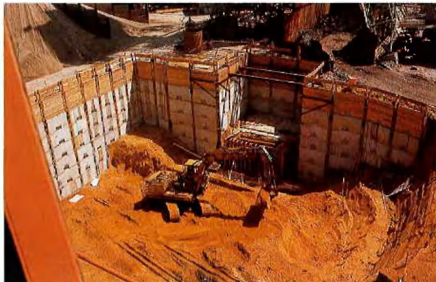
Lüfterbauwerk Haltern 2, an zwei Seiten verbaute Grube, 9 m tief
