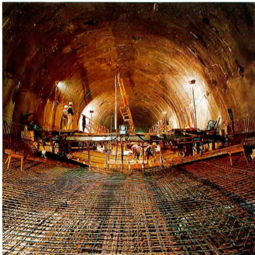
Abb. 14: Sohlbeton mit Sockelschalwagen
