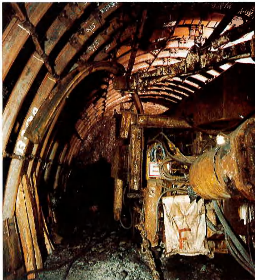
TSM Walsum, Übernahme einer vormontierten Kappe durch DH-Ausbausetzvorrichtung
