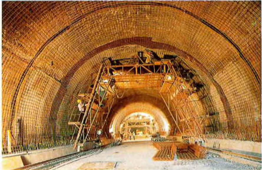
Abb. 12: Bewehrungsarbeiten für Ringbeton
