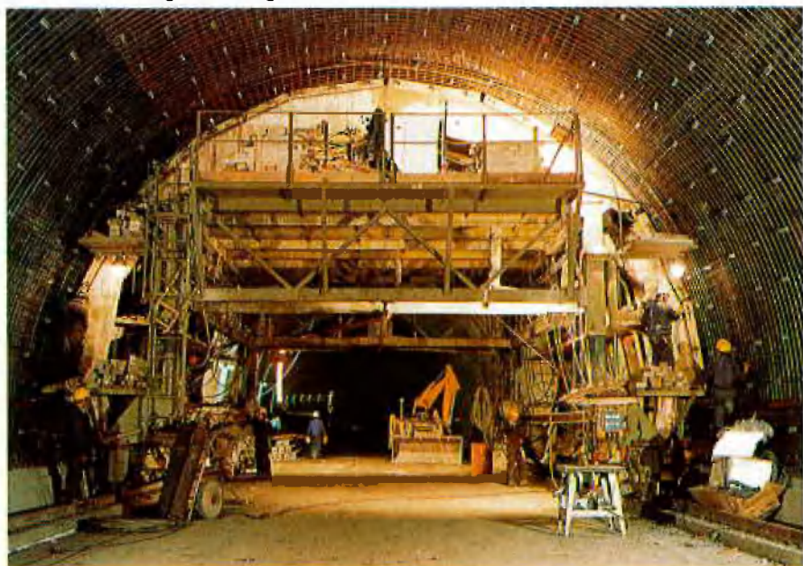
Abb. 13: Schalwagen für Ringbeton
