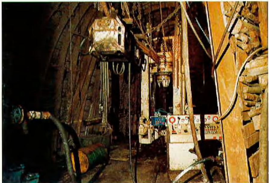
Raise-Bohrmaschine HG 160/15 auf der 700 m-Sohle
