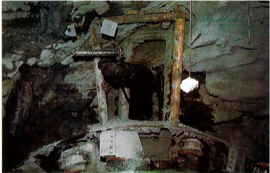
Abb. 3: Pilotstrecke oberhalb des Bohrkopfes
