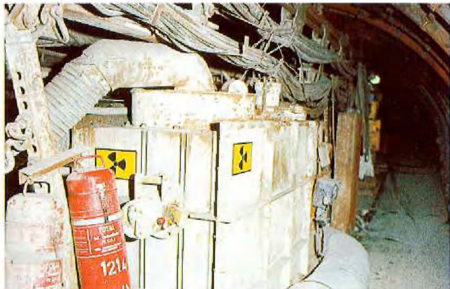
Abb. 5: Bunker für Hinterfüllmaterial
