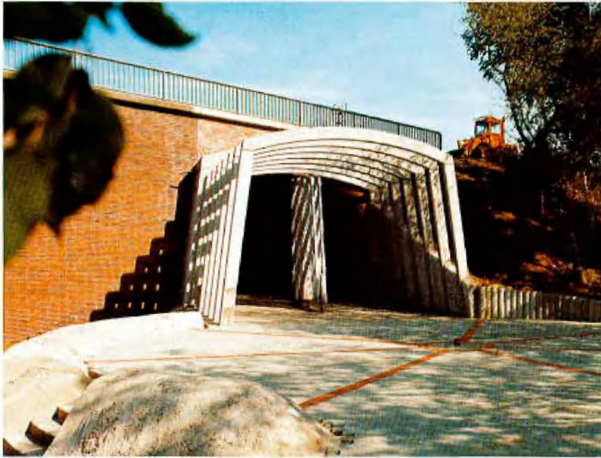
Abb. 3: Zugang Haltestelle Rombergpark
