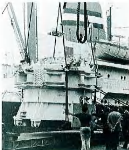
Abb. 1: Entladung des Bohrkopfes
