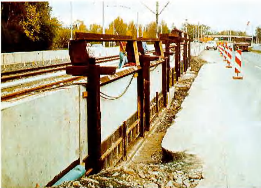
Abb. 10: Aufstellen der Leitwandfertigteile
