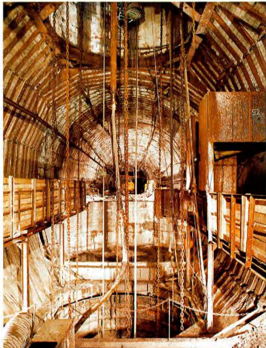
Füllort Sterkrade Schacht 2 in der Ausbauphase
