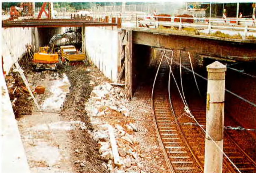
Abb. 6: Neuer und alter Tunnel unter der B 54
