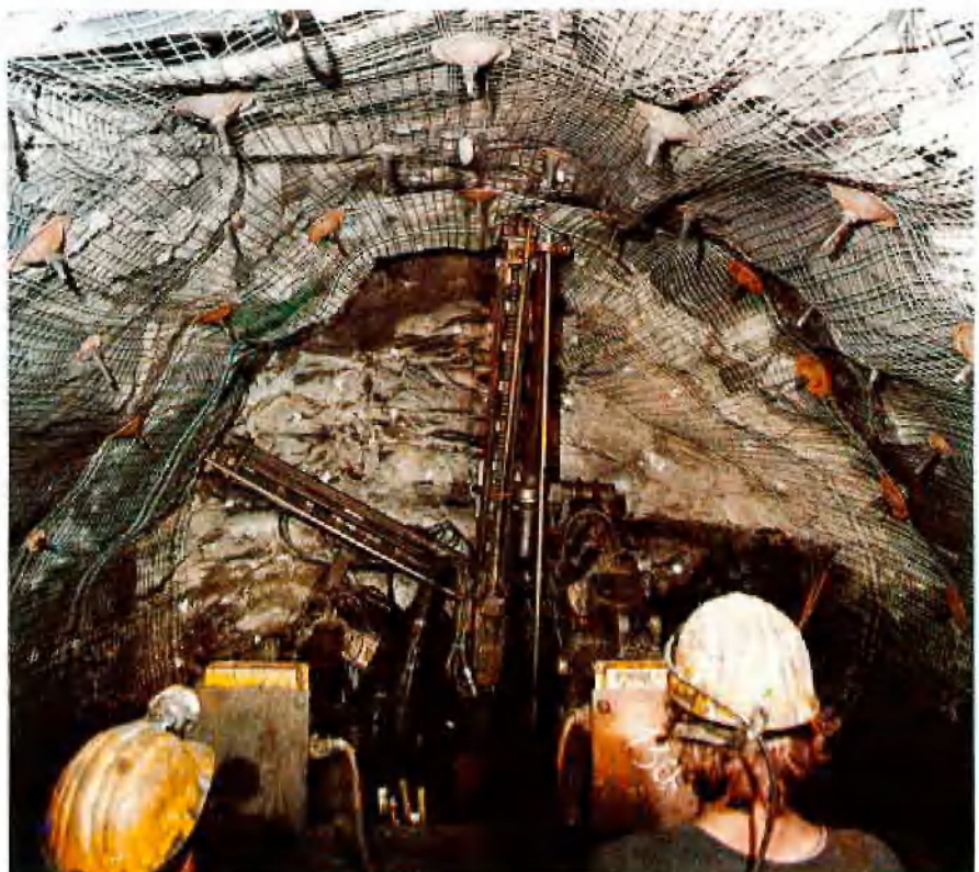
Abb. 3: Bohrwagen in Ankerstellung
