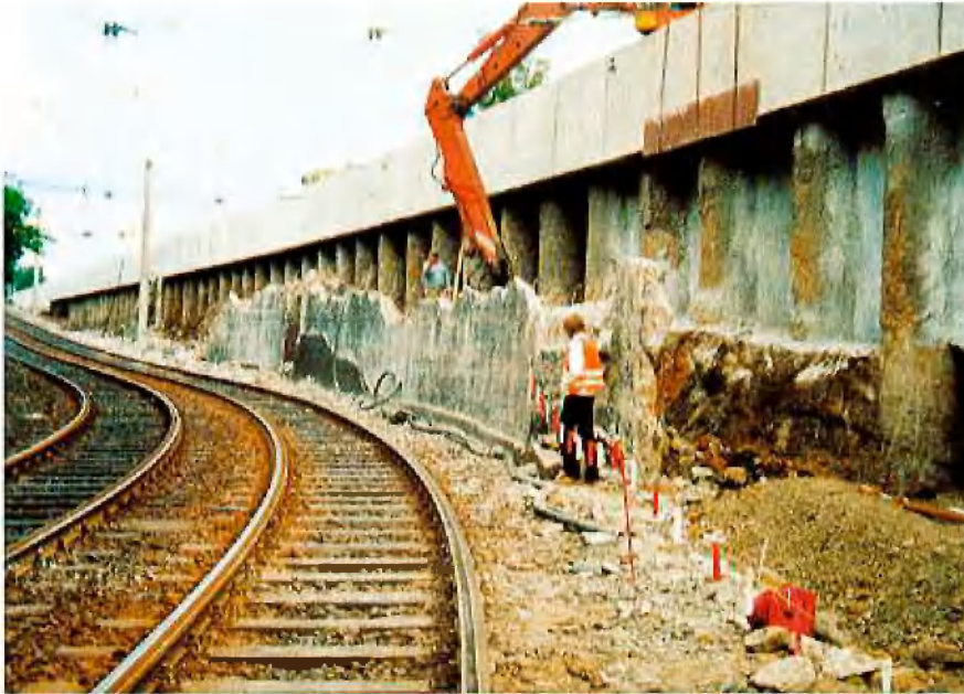
Abb. 9: Freilegen der Nord-Pfahlwand mit aufgesetzter Leitwand
