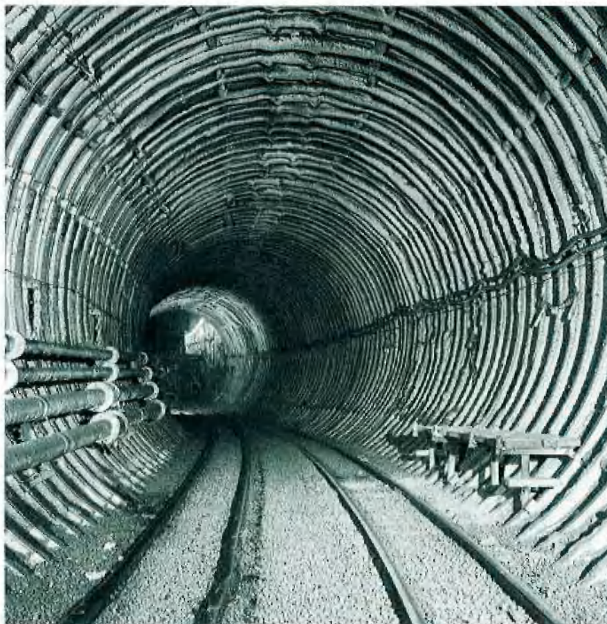
Abb. 10: Gebohrte Strecke im Endzustand, mit Spritzbeton konsolidiert
