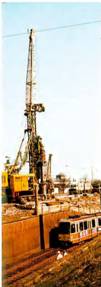
Abb. 8: Bohren der Nord-Pfahlwand von der B 54 aus
