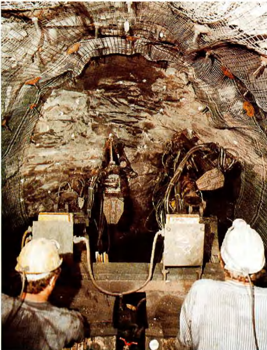
Abb. 5: Bohrwagen in Bohrstellung
