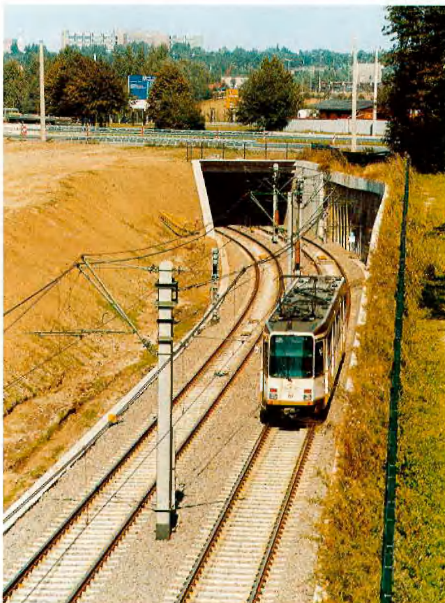
Abb. 7: B 54-Tunnel mit Süd-Pfahlwand
