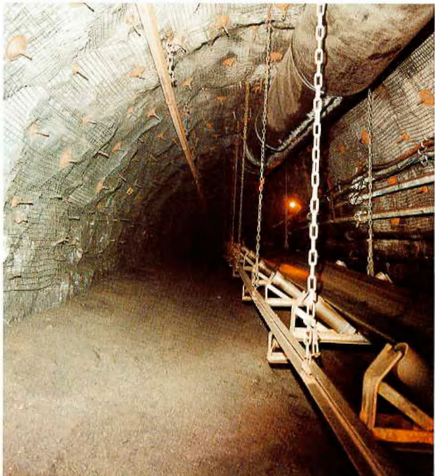
Abb. 1: Ankerstrecke BH 4420 Flöz Geitling 1
