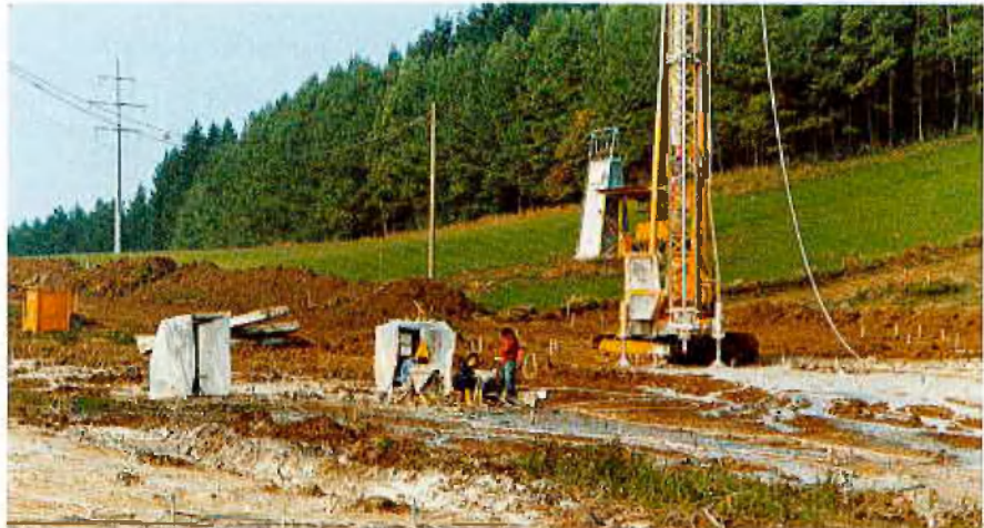
Hohentwieltunnel Ostportal, Verfestigung des Baugrundes durch Injektion
