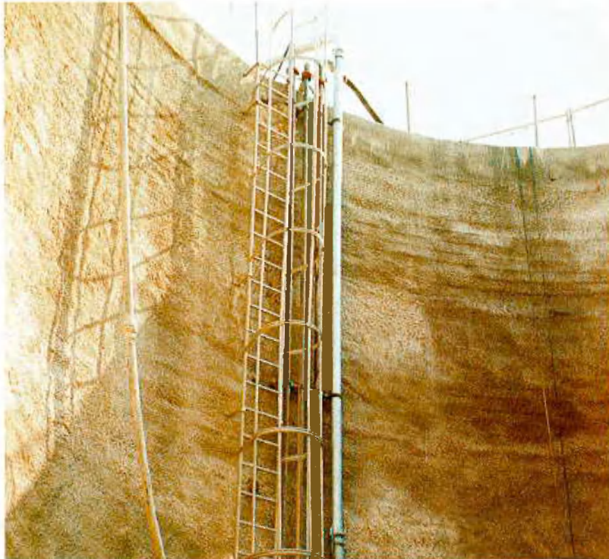
Abb. 1: Zentralschacht in Spritzbetonbauweise
