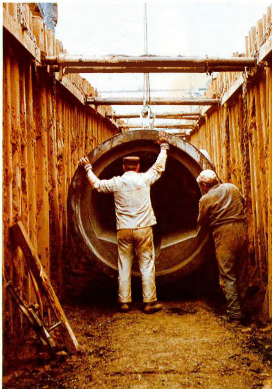
Kläranlage Dormagen-Rheinfeld: Rohrverlegearbeiten
