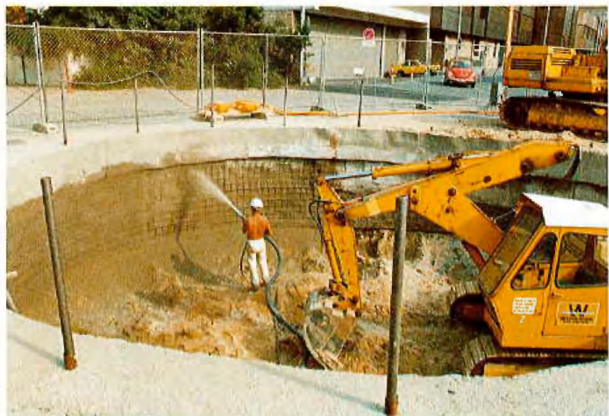
Abb. 4: Zentralschacht: Herstellen der Spritzbetonschale
