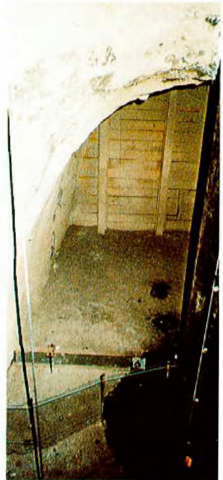
Abb. 12: Kleineres Füllort mit Anker-Spritzbeton-Ausbau
