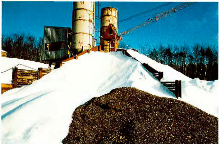
Abb. 7: Betonmischanlage mit Zementsilos und Rundlager für Zuschlagstoffe
