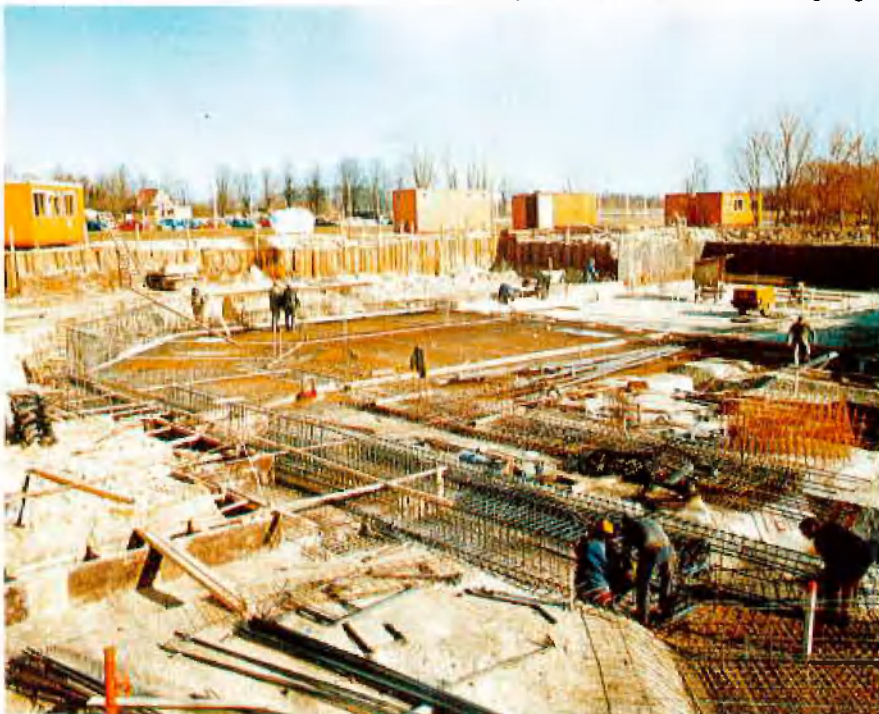
Wohn- und Geschäftshaus Püntendamm: Bewehrungsarbeiten im Bereich der Tiefgarage
