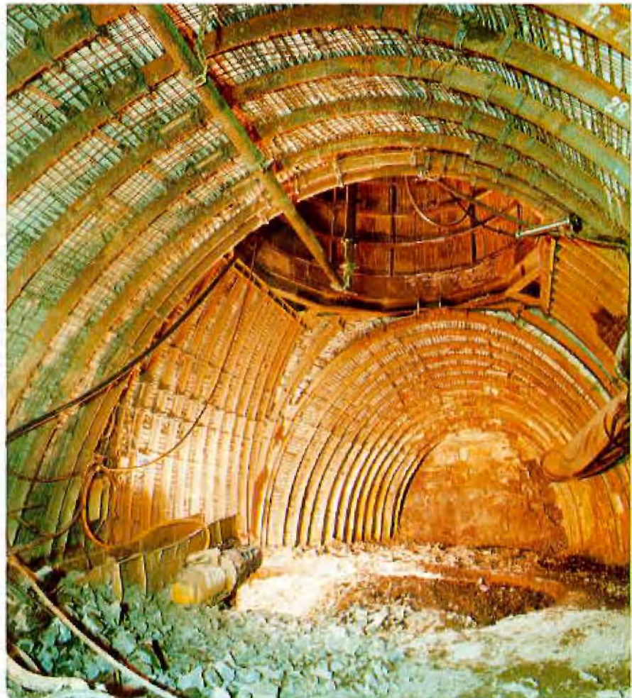
Blindschacht Victoria 1/2 mit den Füllörtern der –1190-m-Sohle
