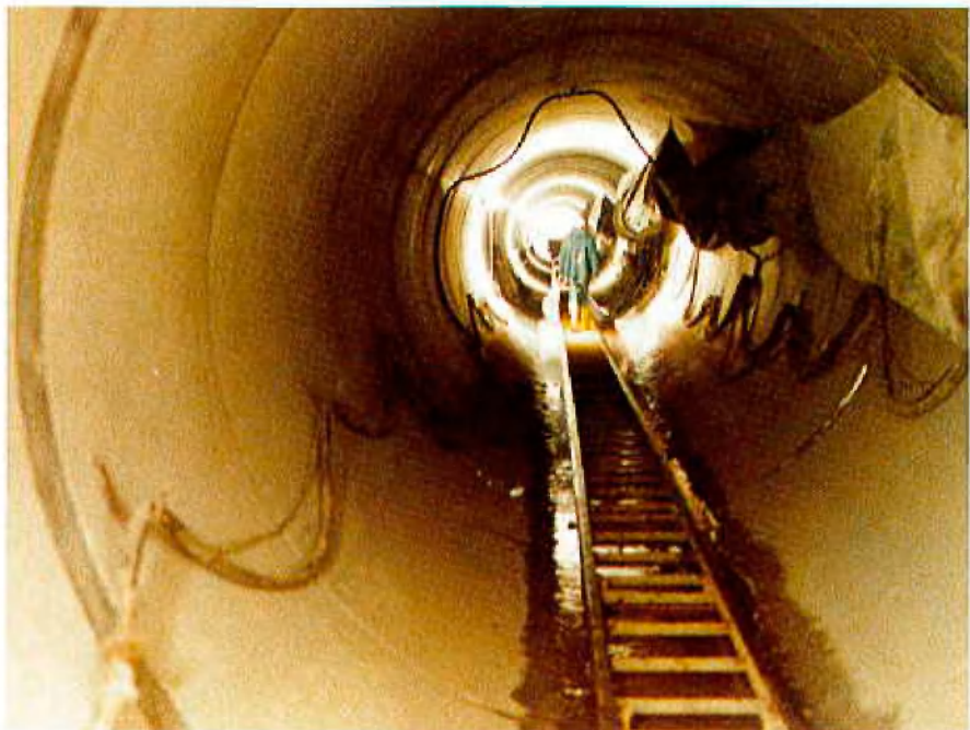
Abb. 8: Blick in den aufgeföhrenen Hauptstrang
