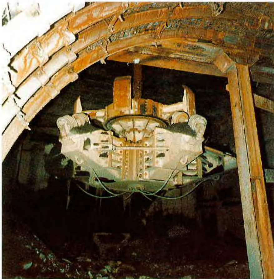
Bergebunker Luisenthal: Raisebohrkopf \varnothing 5,5 m
