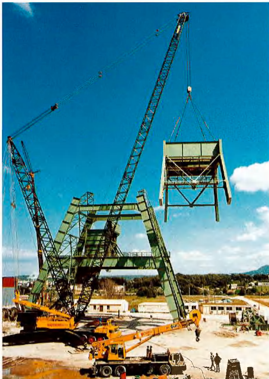
Schacht Y Gardanne: Demontage des Abteufgerüsts
