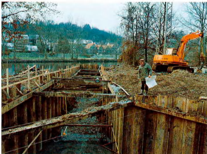
Regenüberlaufbecken Ludwigsburg: Baugrube des Auslaufbauwerks
