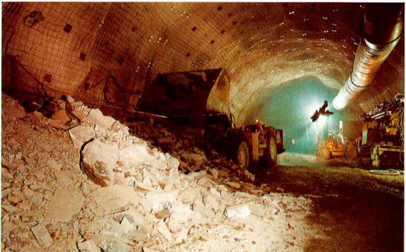
Abb. 11: Fahrlader mit Zwischendeponie für Haufwerk
