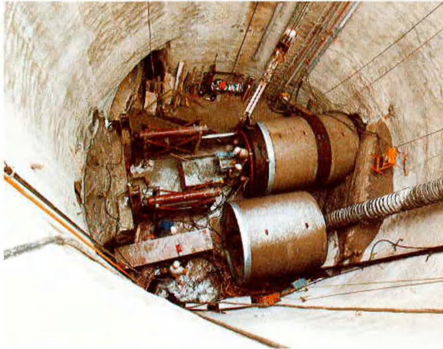
Abb. 10: Blick in den Zentralschacht: Beginn der Vortriebsarbeiten für den Oststrang
