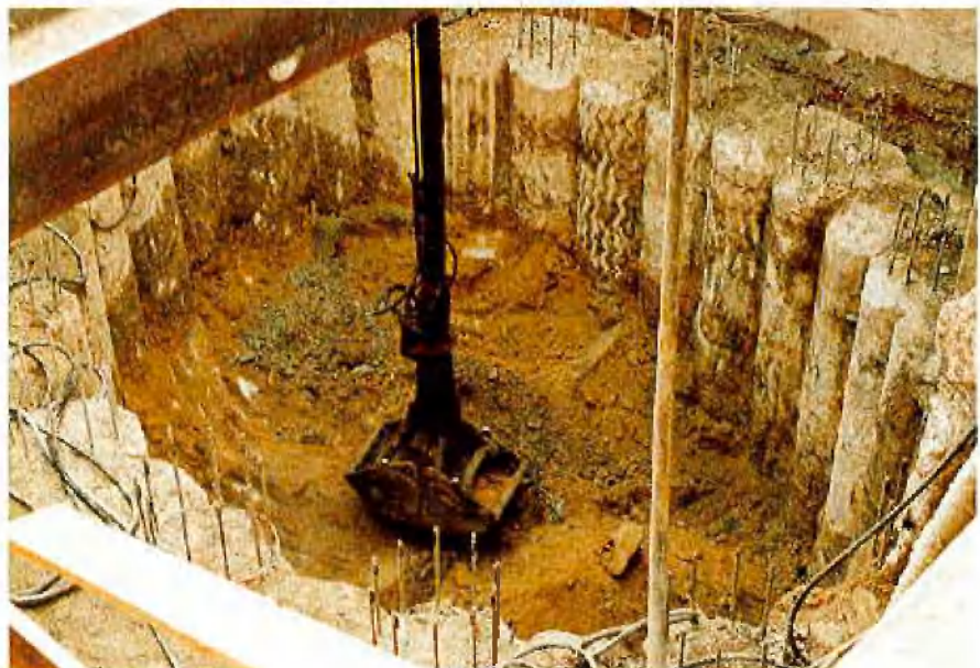
Abb. 5: Hauptschacht: Bohrpfahlwand als Baugrubensicherung
