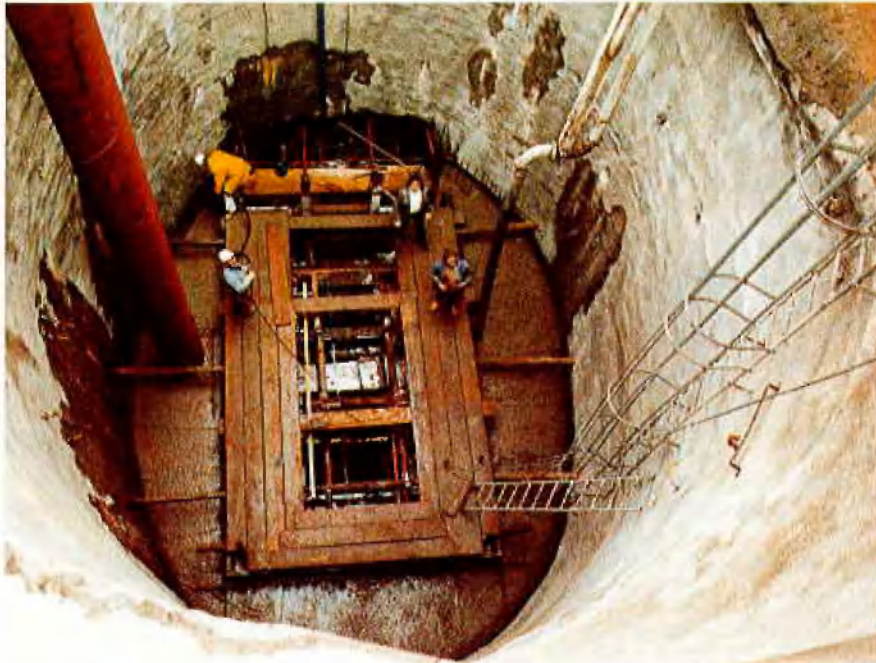
Abb. 6: Ostschacht: Betonarbeiten für den Innenausbau
