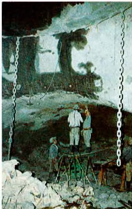
Abb. 10: Vorläufige Sicherung des Teilausbruchs
