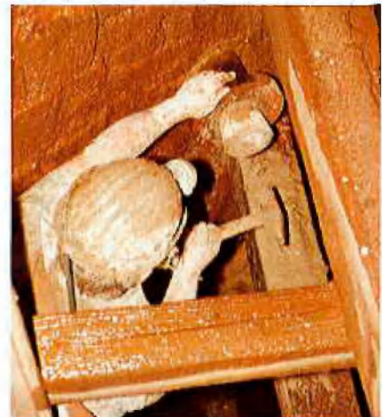
Abb. 3: Verfüllen der Bohrlöcher
