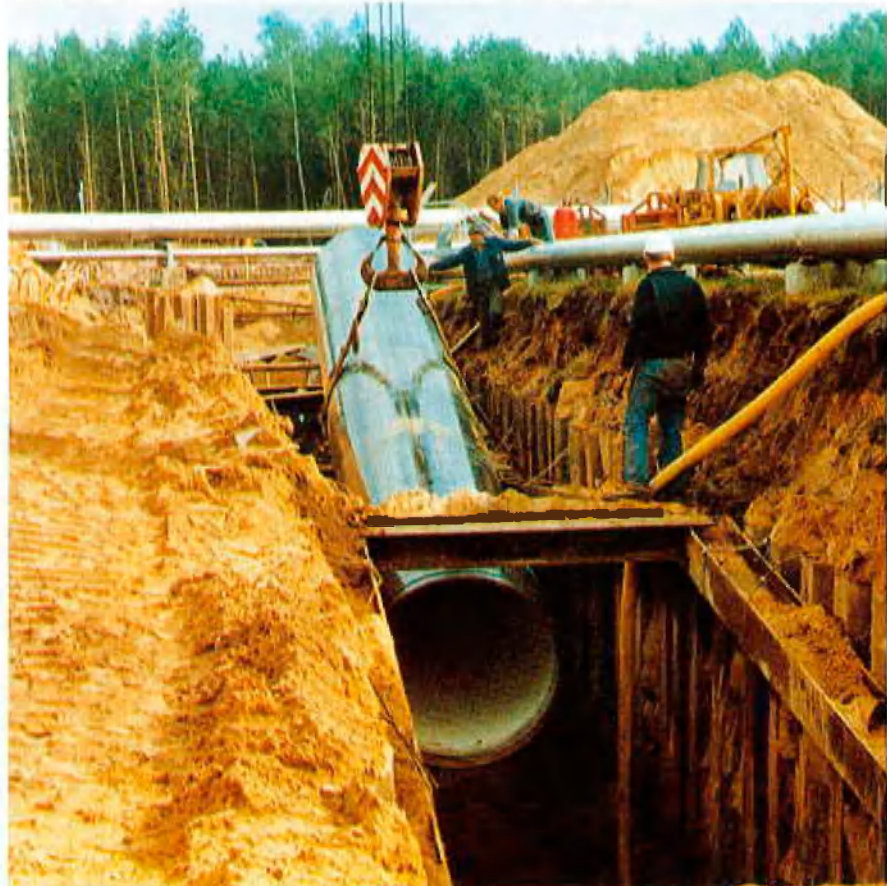
Rückgabekanal Kernkraftwerk Emsland: Verbauter Rohrgraben
