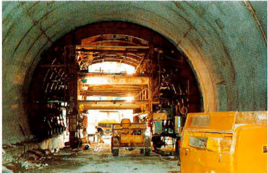
Wolfsbergtunnel: Innenausbau am Nordportal
