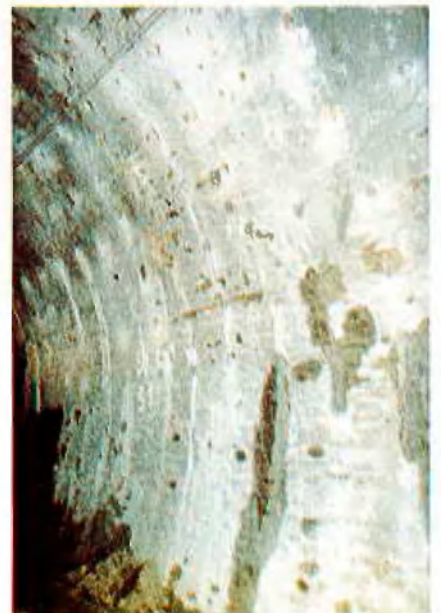
Abb. 3: Tunnelleibung nach der Injektion
