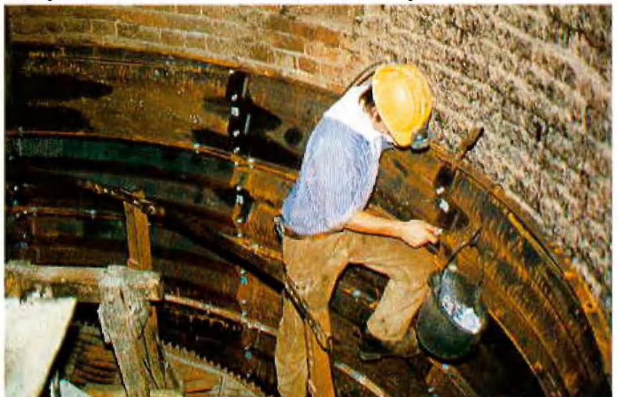
Montage der Liner-Plates für die äußere verlorene Schalung
