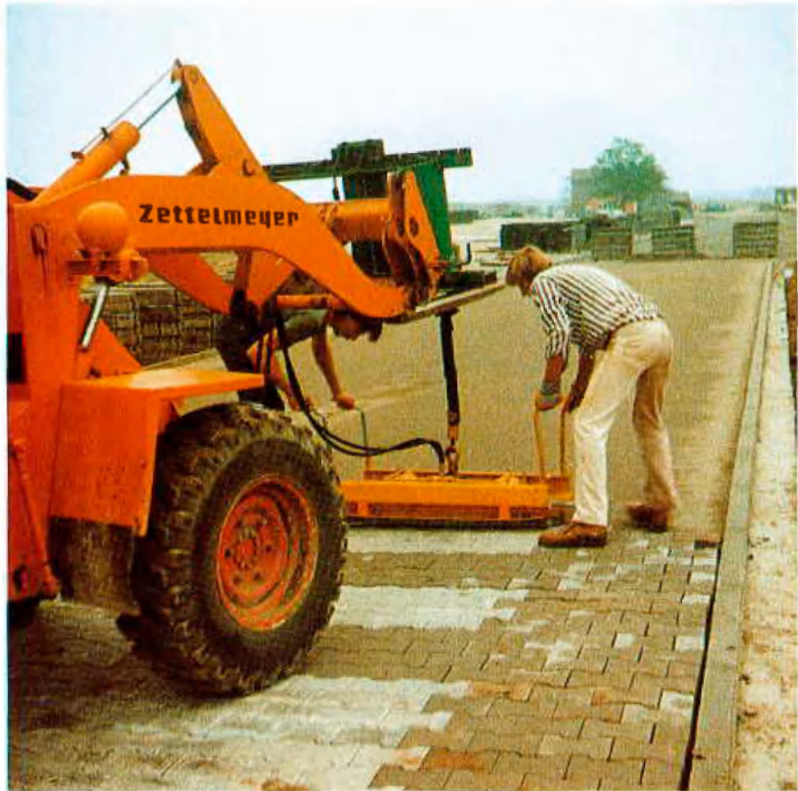
Gemeinschaftszollamt: Verlegung des Verbundpflasters mit der Verlegezange
