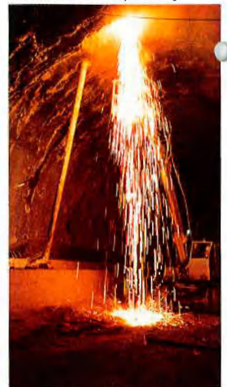
Hohentwieltunnel: Nachprofilierung
