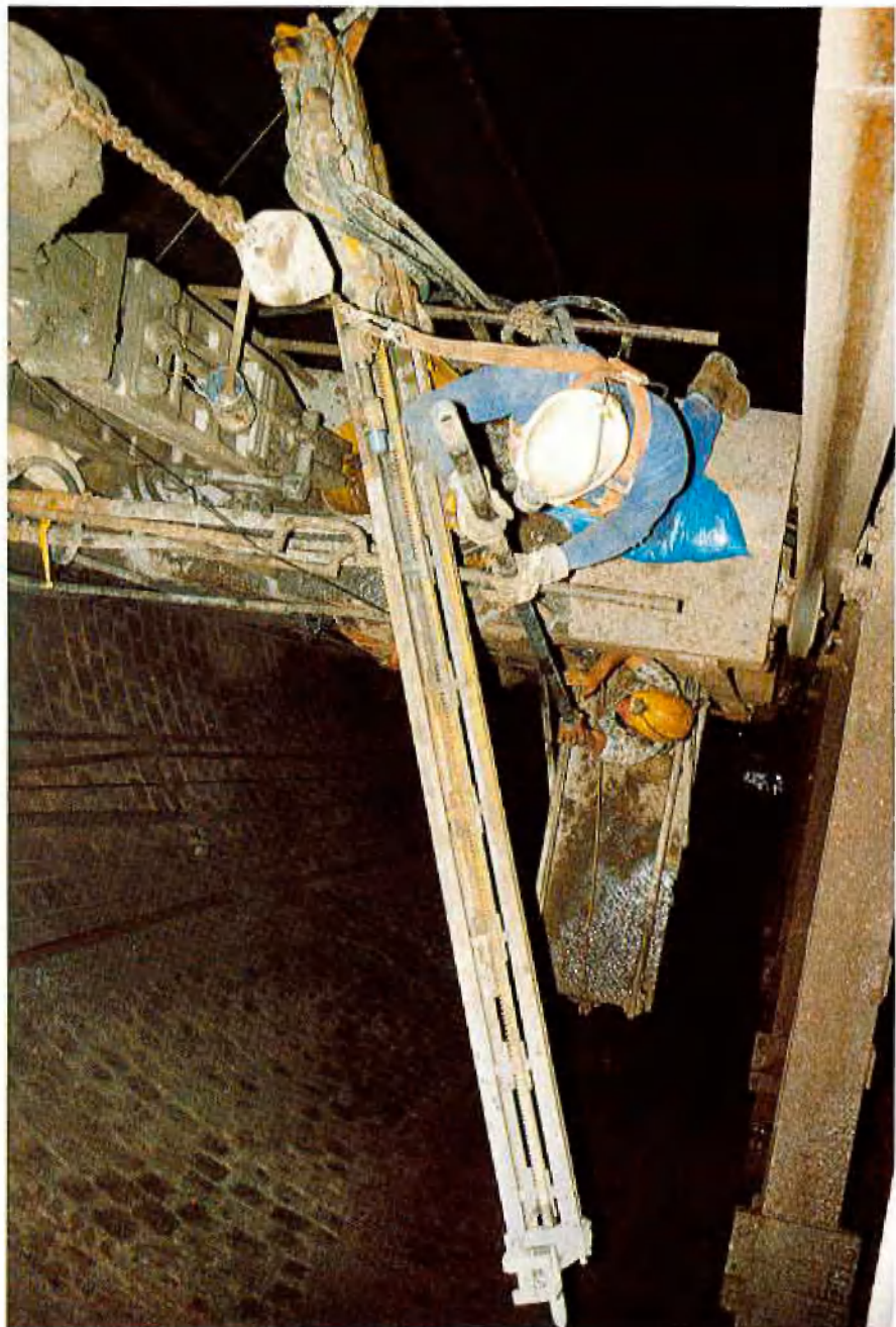
Abb. 4: Gestängewechsel auf engem Raum
