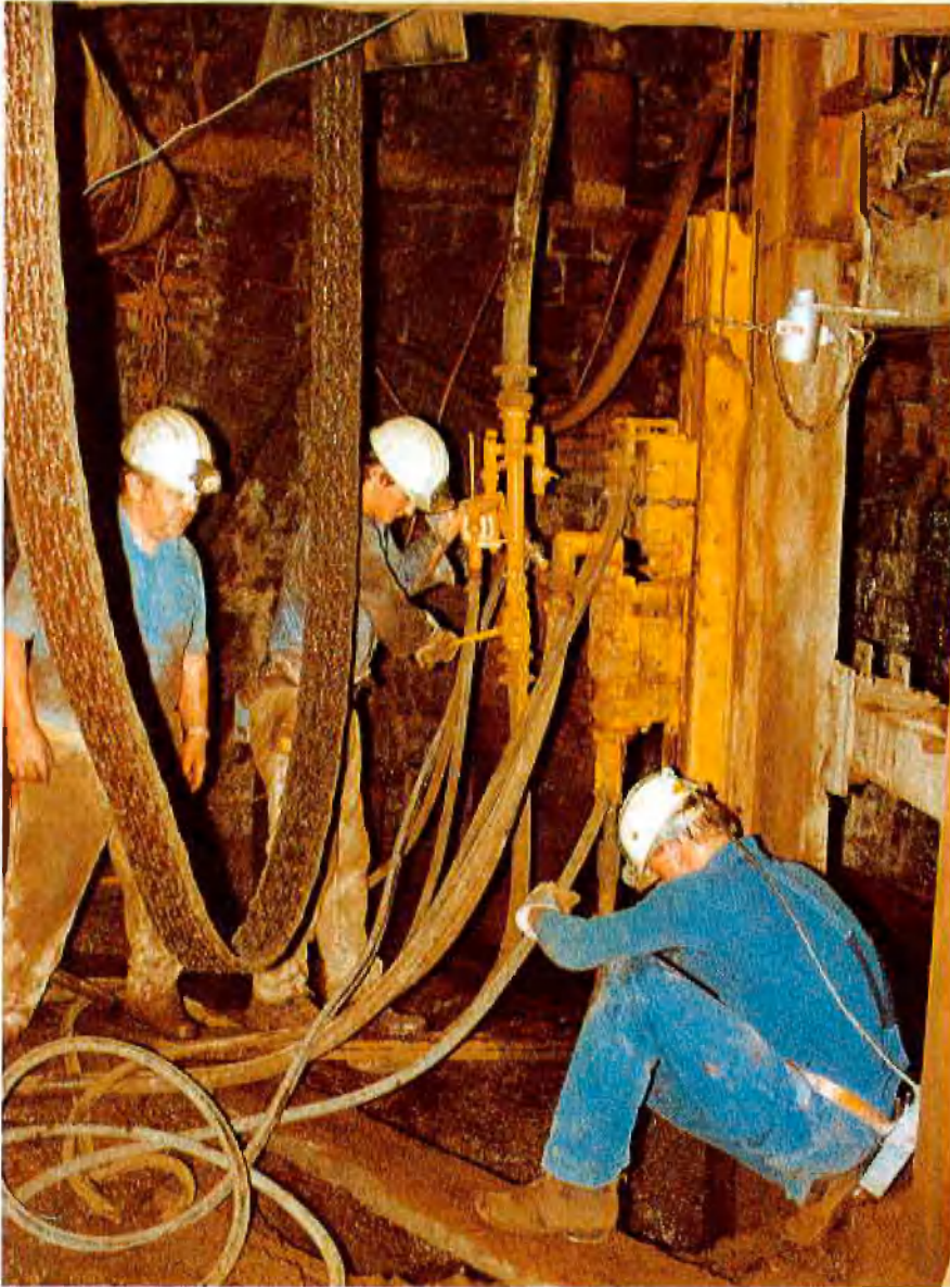
Abb. 5: Bohrarbeiten auf der Schachtsohle
