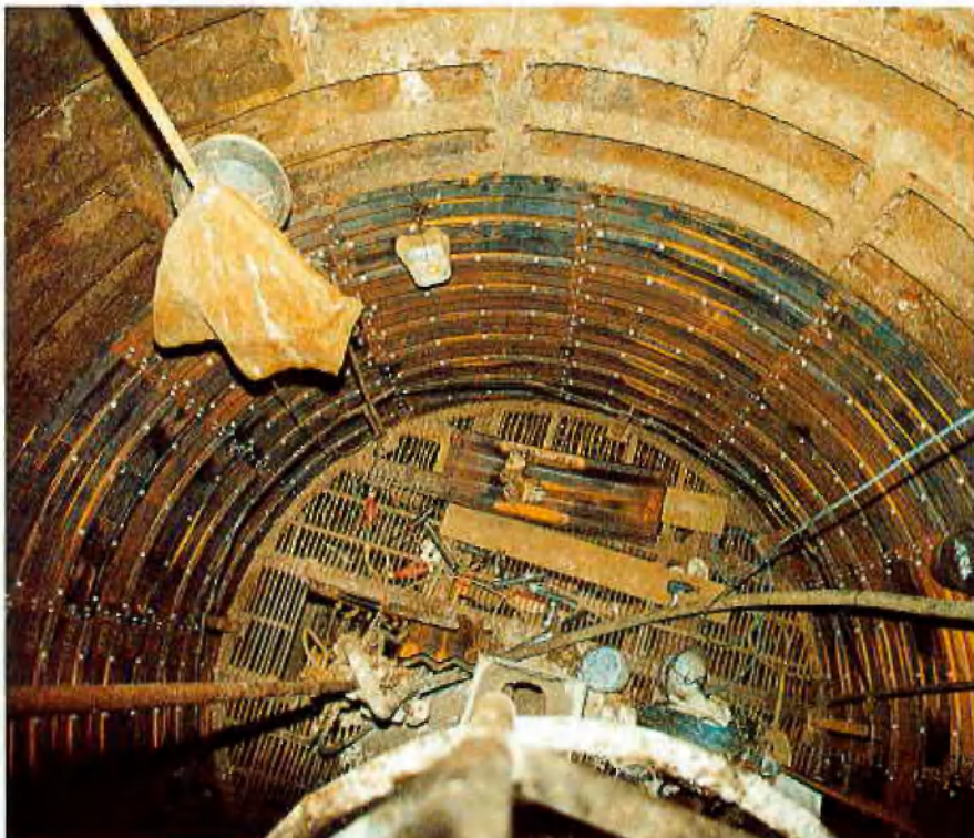
Blick in den Schacht: Tübbingsäule, Liner-Plates und Arbeitsbühne
