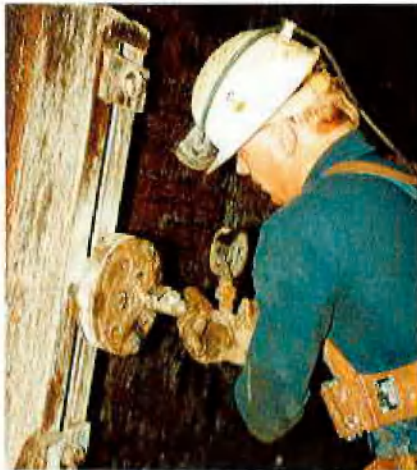
Abb. 2: Abdrücken der Standrohre
