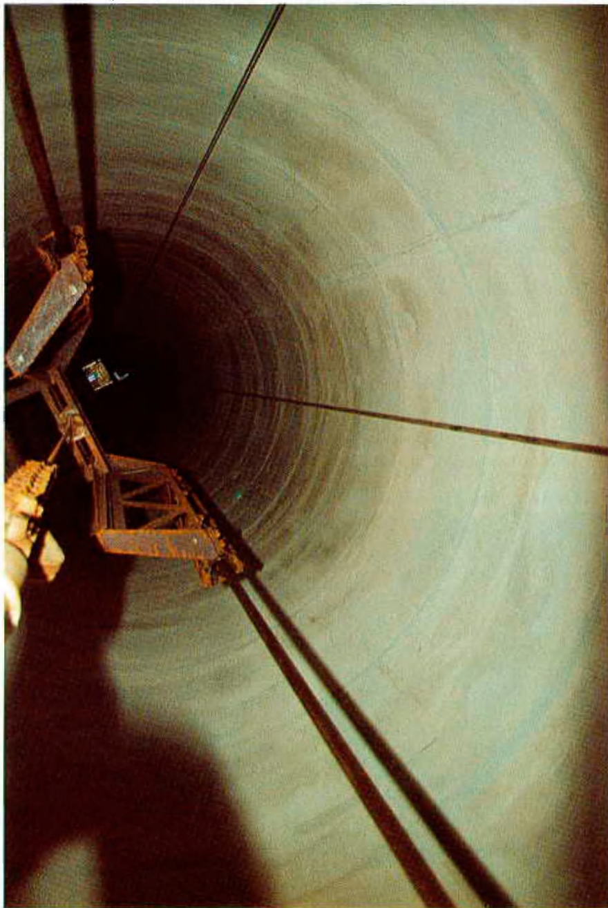
Blick in die fertige Vorbausäule
