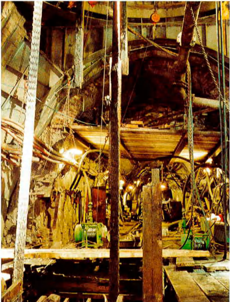
Abb. 7: Schachtglocke nach dem Rauben des Schachtstuhls
