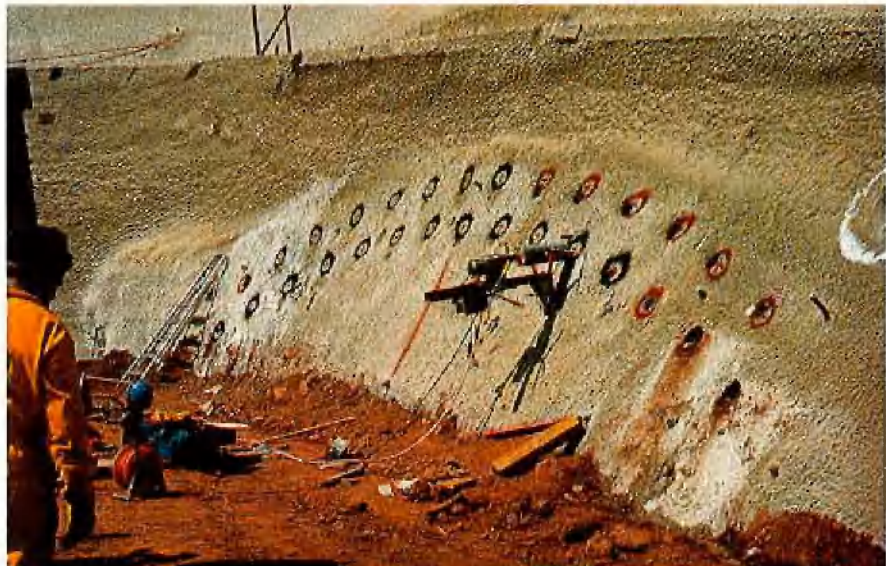
Abb. 4: Herstellen des Bohrlochansatzpunktes mit einem Kernbohrgerät
