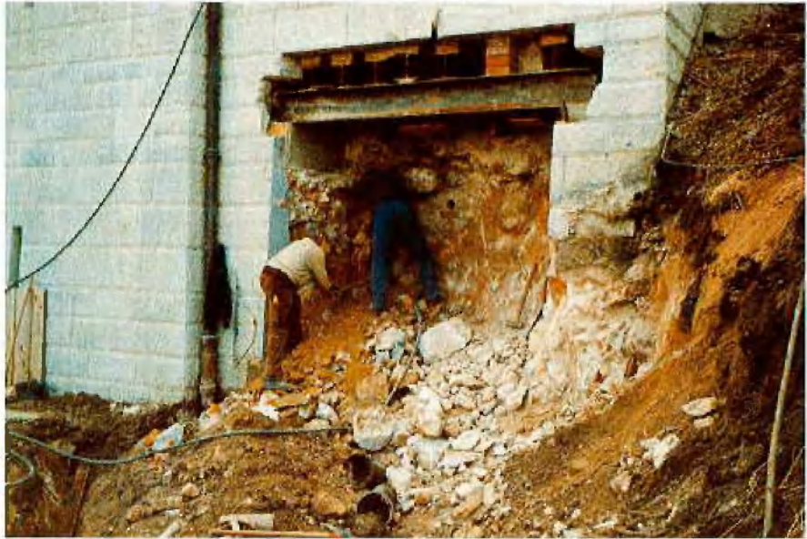
Abb. 4: Ausbruch für das Stolleneingangstor
