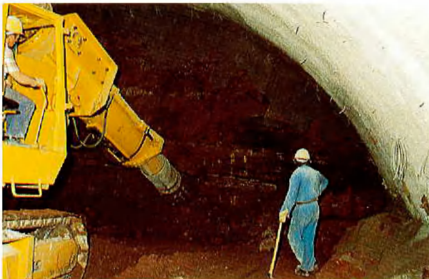
Abb. 7: Ausbruch mit einer Teilschnittmaschine DEMAG H 41
