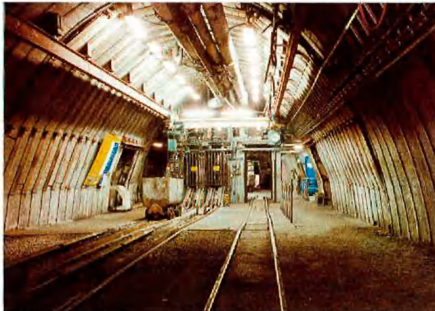
Abb. 10: Neues Füllort – Aufschiebeseite
