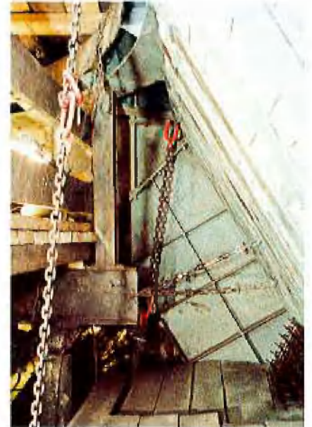
Abb. 4: Abfangen des alten Schachtstuhls
