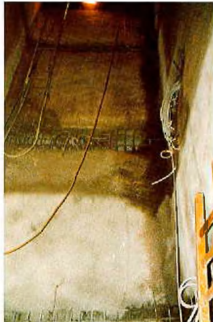
Abb. 5: Treppenschacht vor Treppeneinbau
