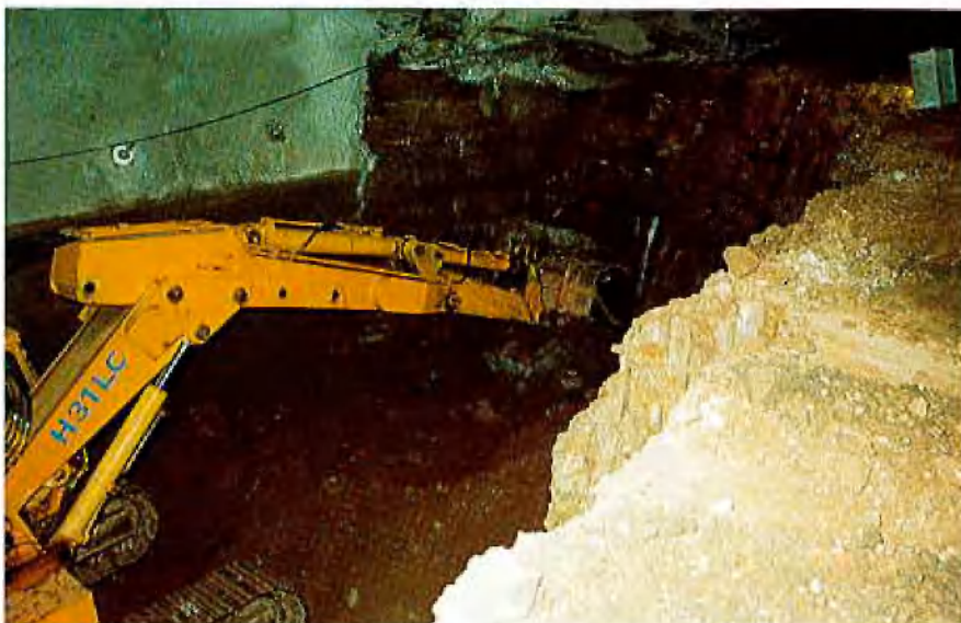
Abb. 8: Strossenabbau mit Hydraulikbagger
