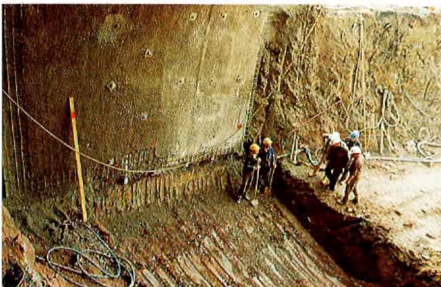
Abb. 9: Aushub des Sohlgewölbes im Haupttunnel
