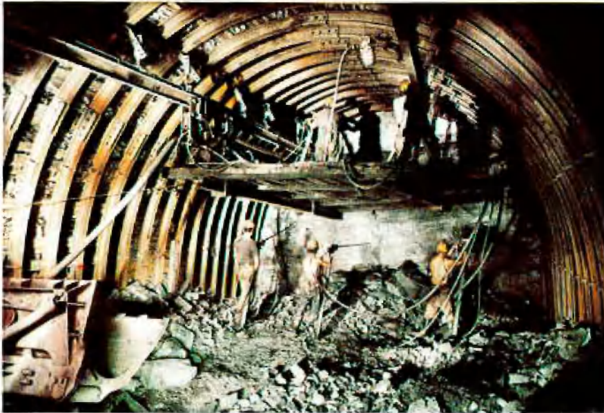
Abb. 6: Verfahrbare heb- und senkbare Arbeitsbühne
