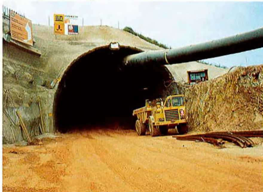
Abb. 1: Südportal Krämerkuppeltunnel – links oben die Leitplanken der BAB 7
