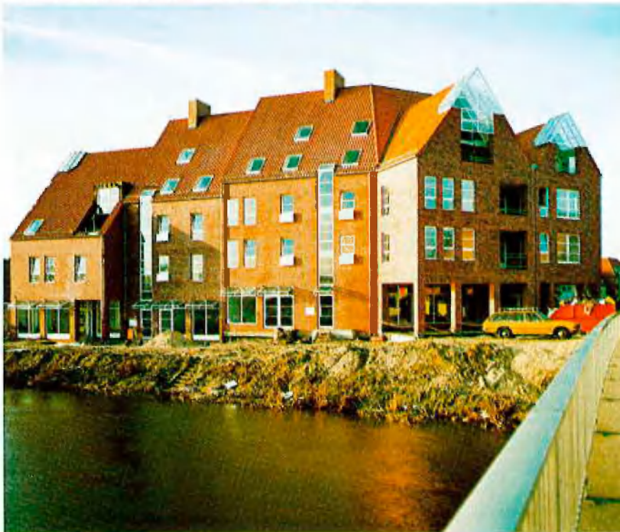
Wohn- und Geschäftshaus Püntendamm in Nordhorn
