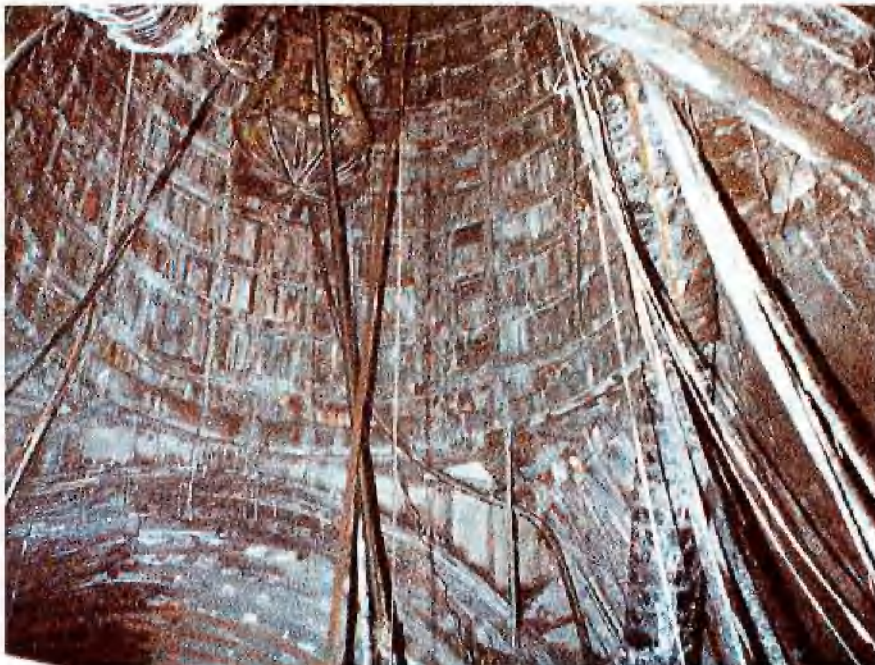
Tieferteufen Schacht Heinrich, Füllort -1120-m-Sohle
