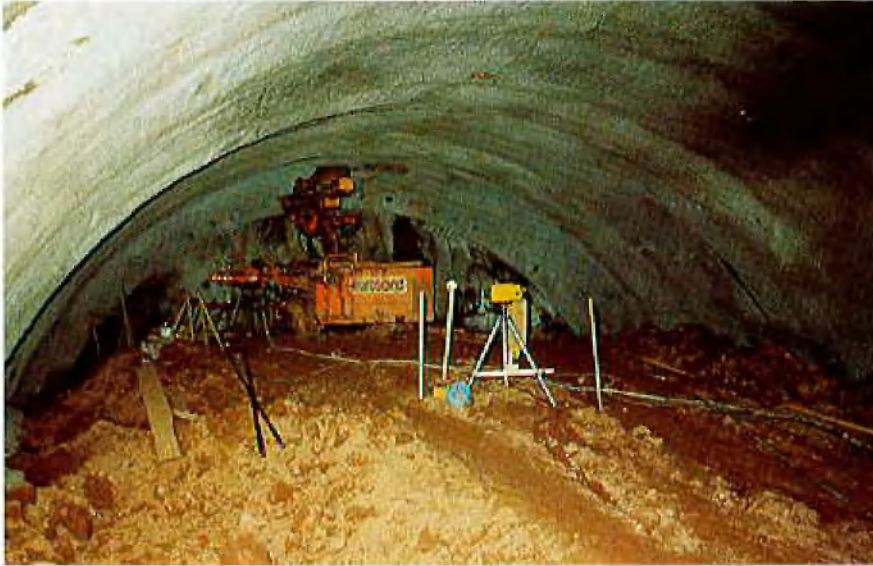
Abb. 5: Rohrschirmherstellung aus der Kalotte heraus
