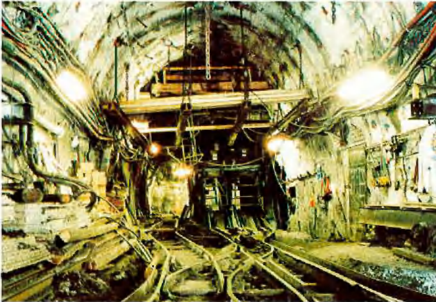
Abb. 5: Altes Füllort während der Umbauphase – Ablaufseite
