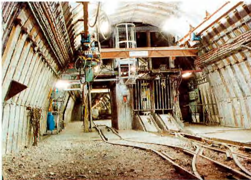
Abb. 9: Neues Füllort – Ablaufseite
