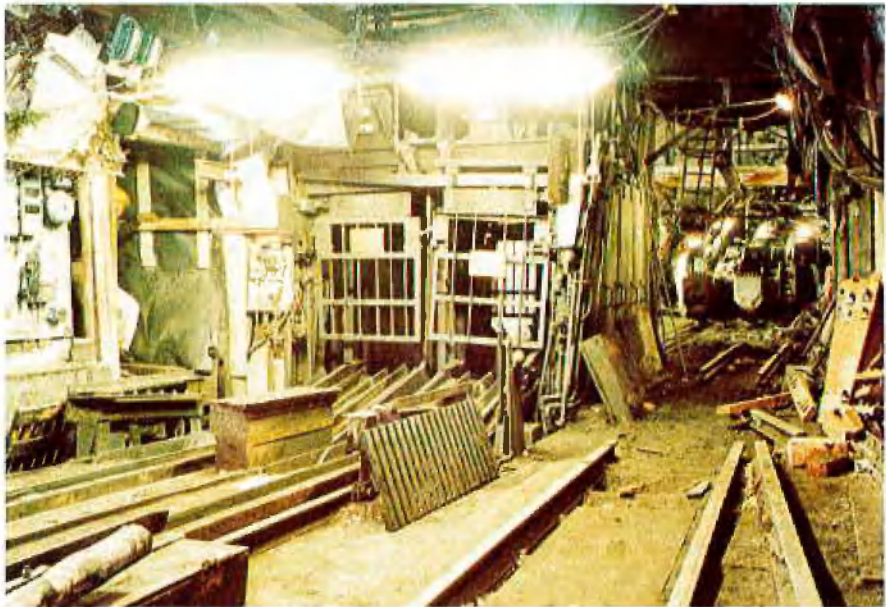
Abb. 6: Altes Füllort während der Umbauphase – Aufschiebeseite
