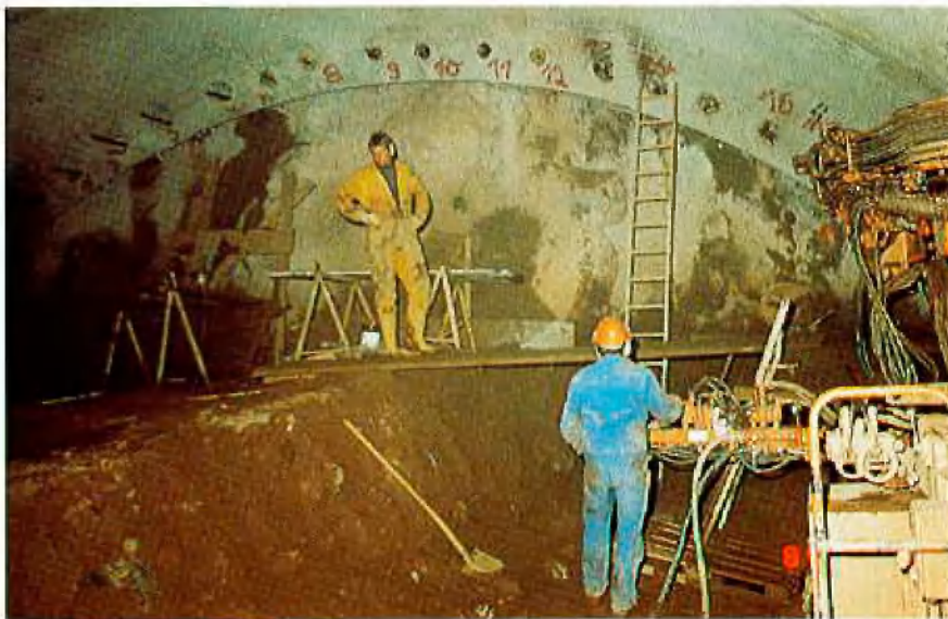
Abb. 6: Bohrlochansatzpunkte für Rohrschirm
