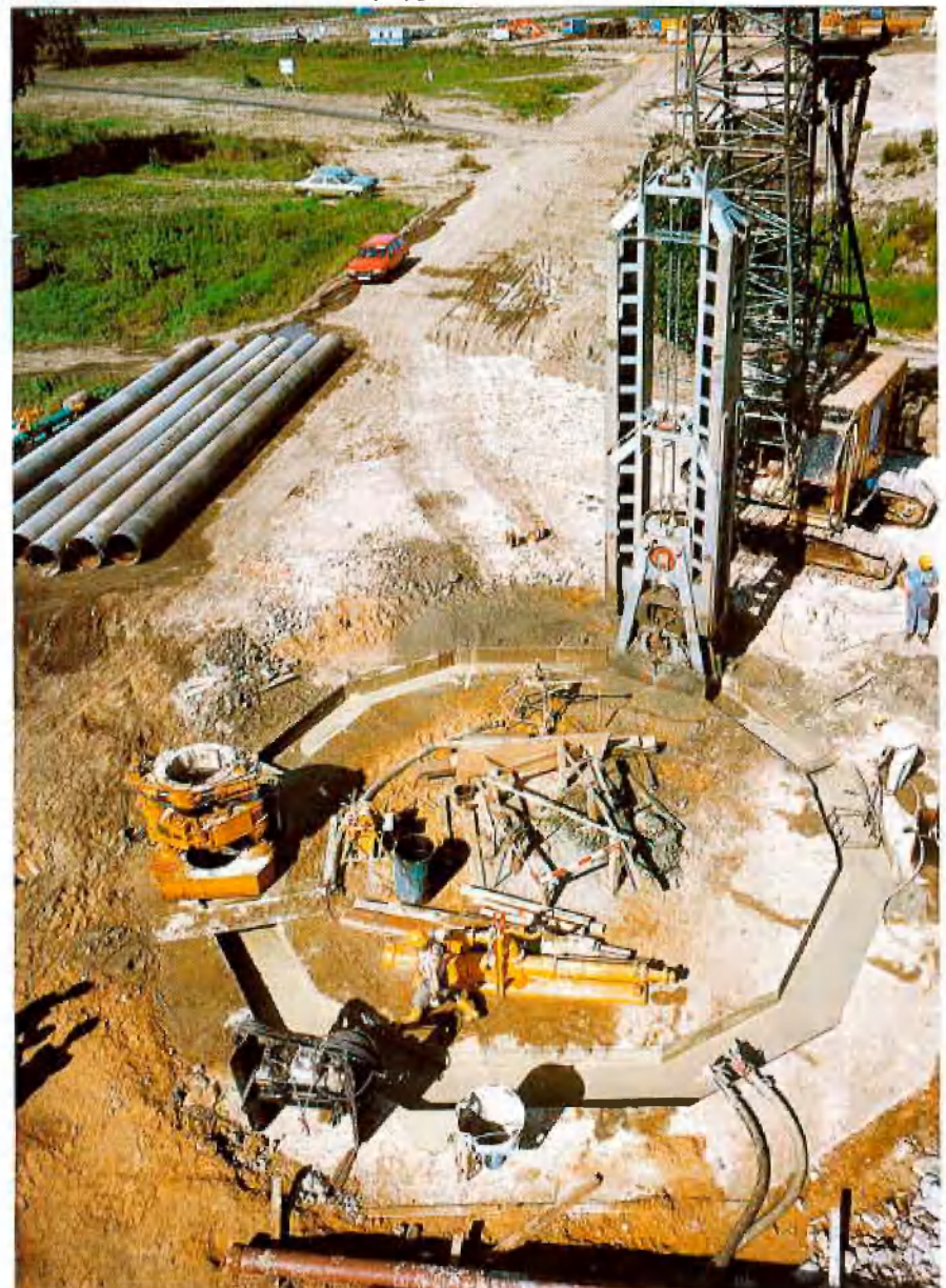
Abb. 2: Herstellen des Schlitzwandpolygons für den Schacht Dradenau
