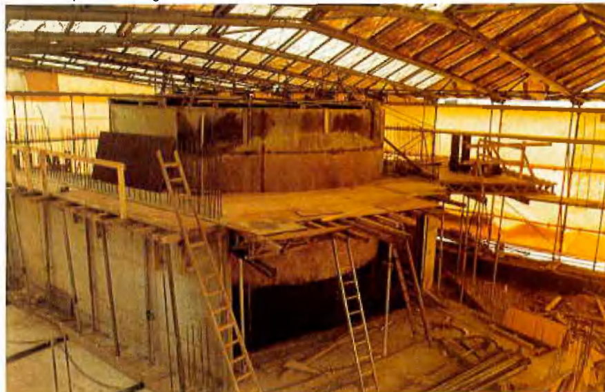
Schachtkopferneuerung im Schutz einer Winterbauhalle
