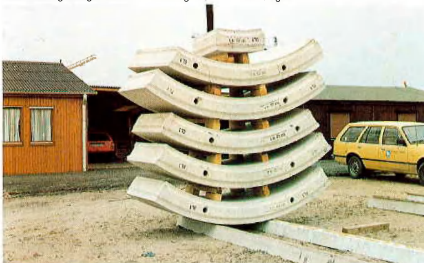
Abb. 5: Vorgefertigte Stahlbetontübbings eines Ausbauringes
