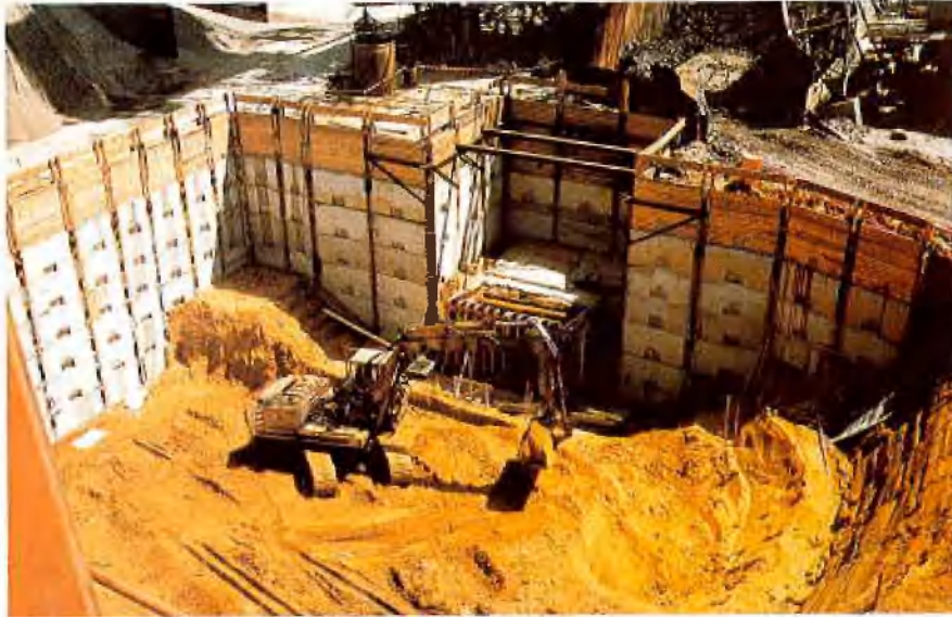
Baugrube Lüfter Haltern 2
