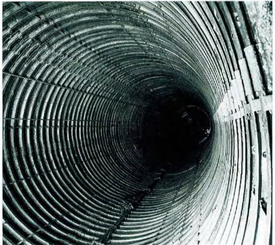
Fertiger Bohrschacht
