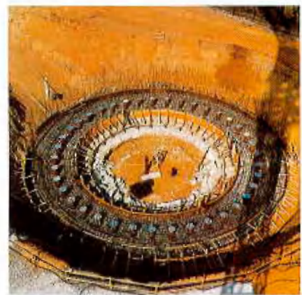
Gefrierbohrlochansätze Haltern 2
