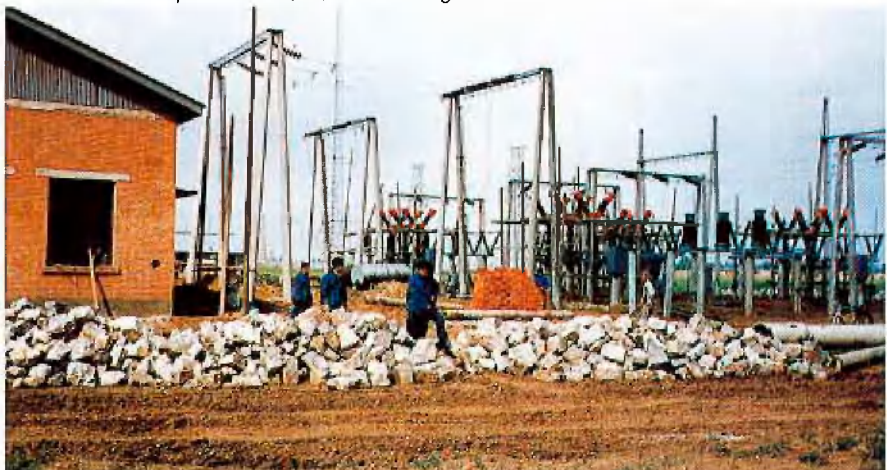
Auf dem Schachtplatz wird die Trafostation gebaut
