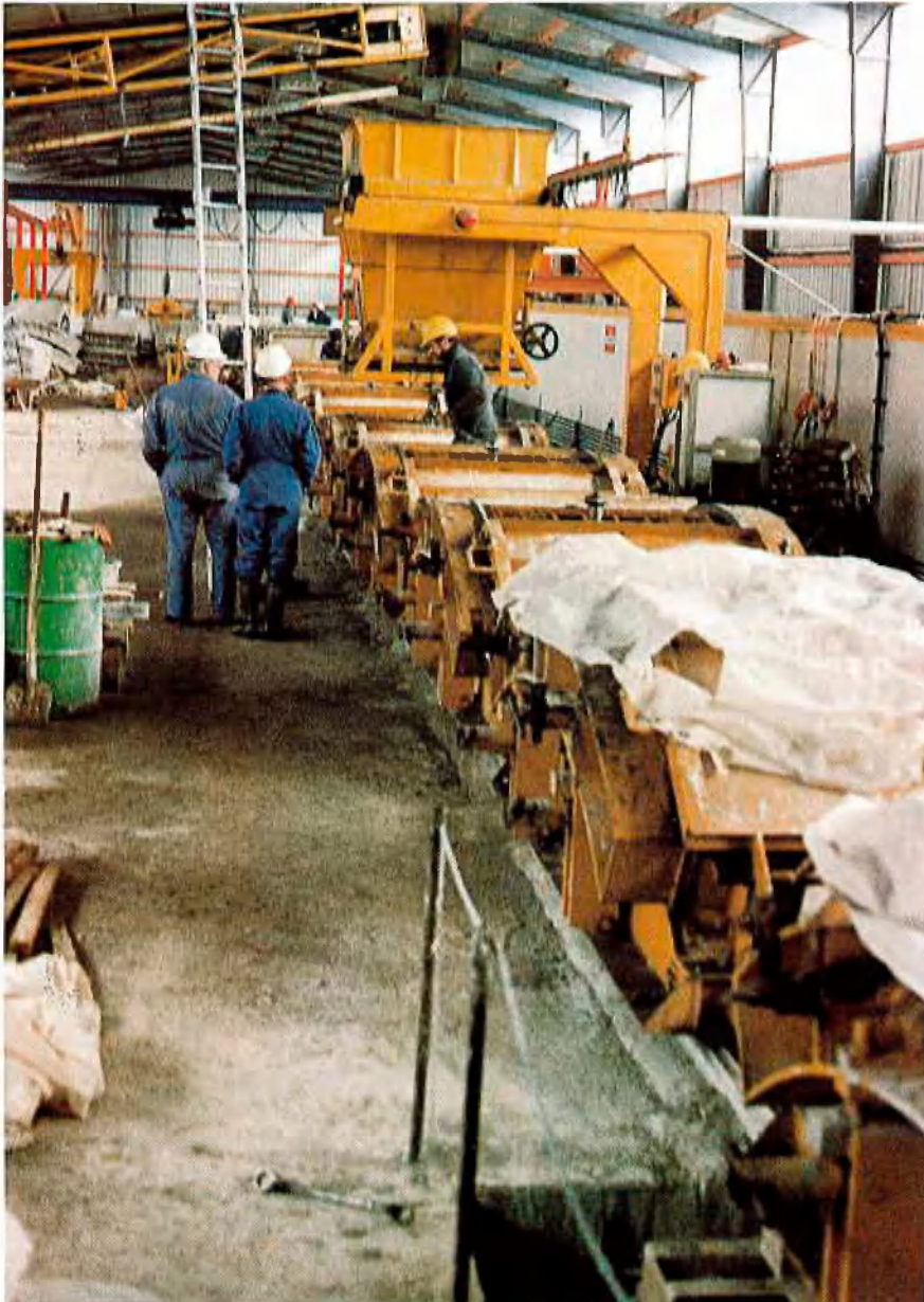
Abb. 4: Tübbingfertigung in der Feldfabrik auf dem Baugelände
