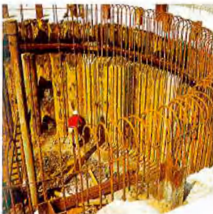
Bohrpfahlwand Haltern 1
