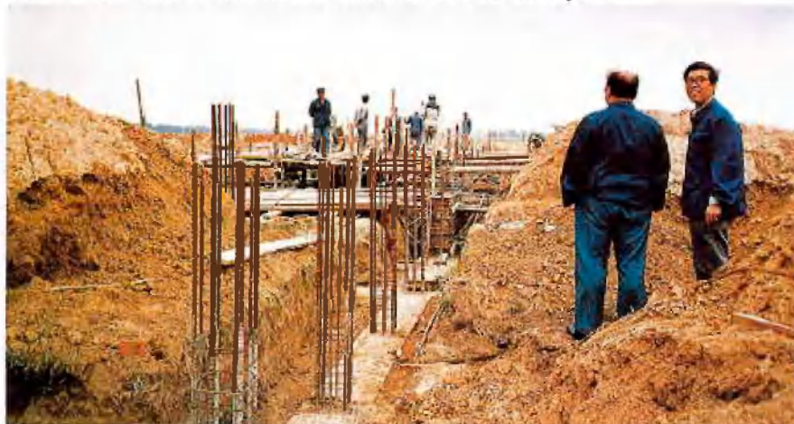
Der Bau der Hotelunterkunft für das deutsche Personal hat begonnen
