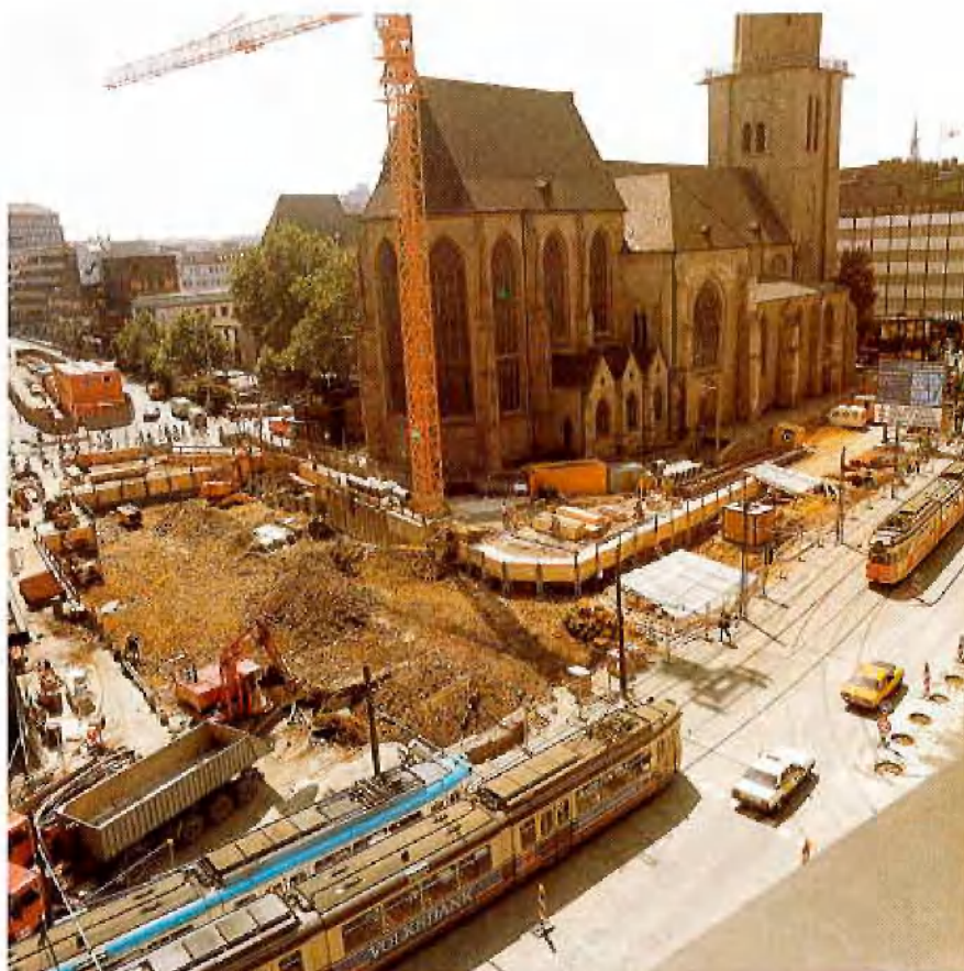
Stadtbahn Dortmund, Baulos K 3, Reinoldikirche
