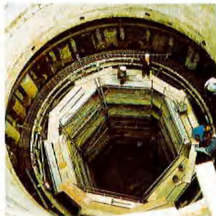
Vorschachtauskleidung Haltern 1
