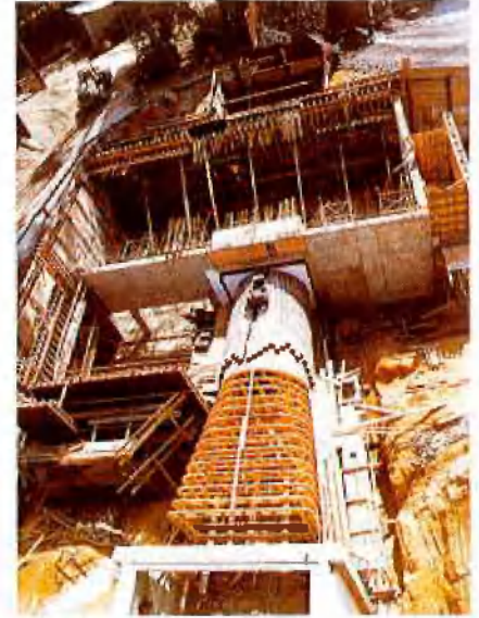
Lüfter im Bauzustand
