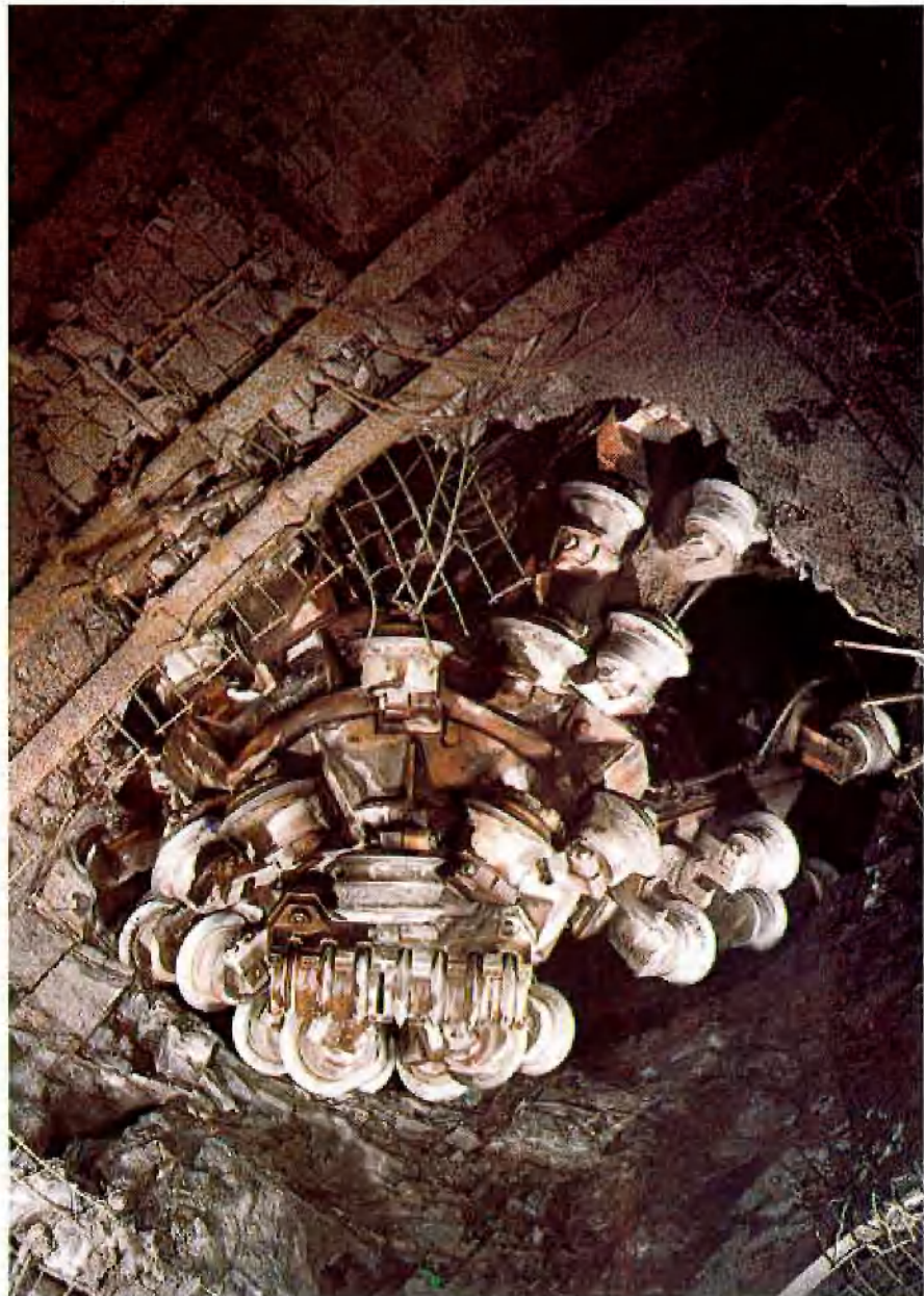
Durchschlag der Schachtbohrmaschine
