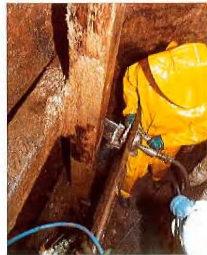
Abb. 3: Rauben von Spurlatten und Einstrichen
