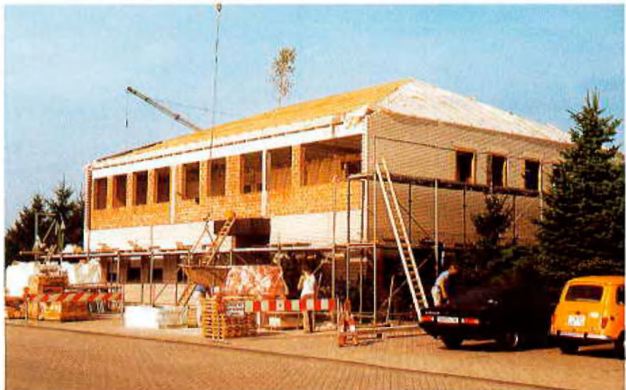
Erweiterung des Verwaltungsgebäudes Timmer-Bau
