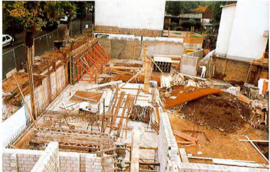
Geschäfts- und Wohnhausbau in Wetter
