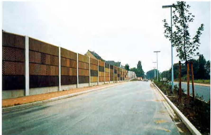
Lärmschutzwand Westtangente Hattingen
