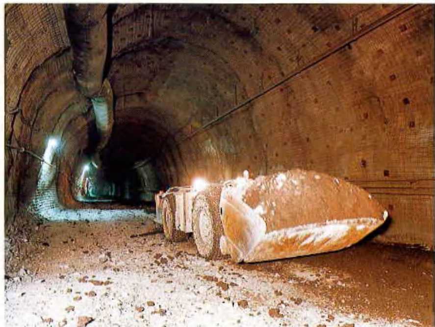
Füllort Haltern 1 in Anker-Spritzbetonbauweise
