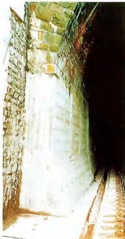
Widerlagererneuerung Tunnel Herchen
