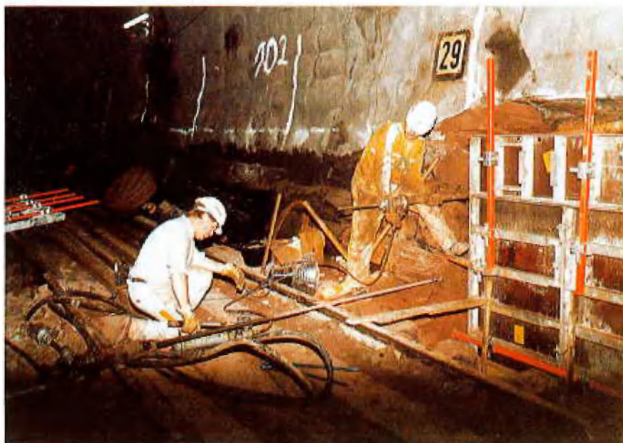
Abb. 5: Spannen der Schalungsanker
