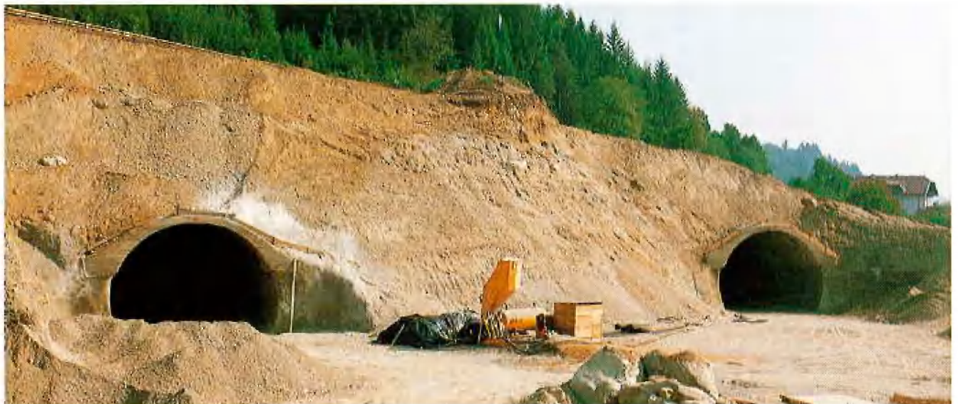
Westportal Oswaldibergtunnel – „Kärntner Deckelbauweise“
