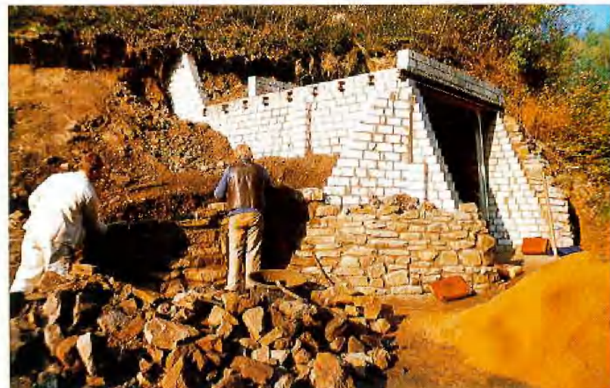
Bau eines Stolleneingangs im Muttental
