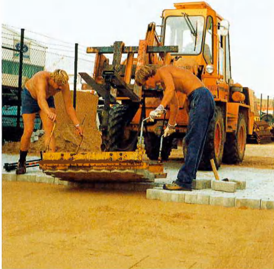
Platzbefestigung, Verlegung von Verbundpflaster
