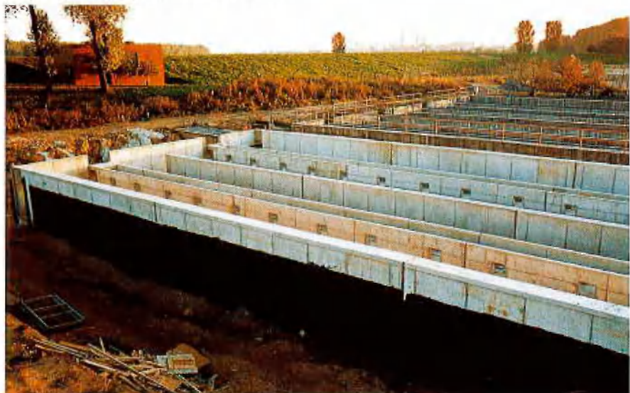
Kläranlage Dormagen, Belebungsbecken
