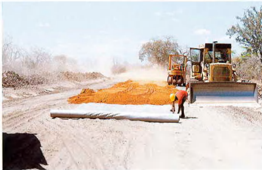
Einbau von Glasfibernatten
