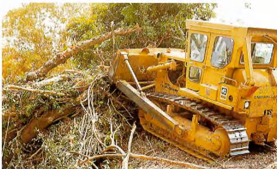
„bushclearing“ – Buschrodung, Vorbereitung für den Bau der Straße
