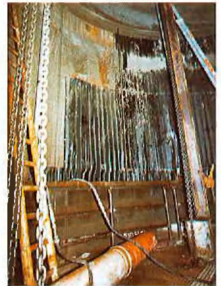
Abb. 8: Bohrstoß mit Wasserableitung auf der Betonierbühne
