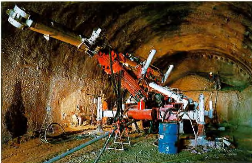
Oswaldibergtunnel: Herstellung der „Jetpfähle“ in der Kalotte
