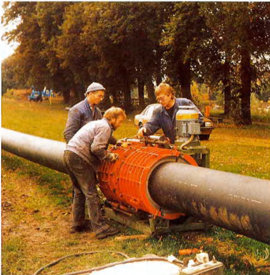
Schmutzwasserhauptsammler Nordhorn: Stumpfschweißverfahren an HDPE-Rohren
