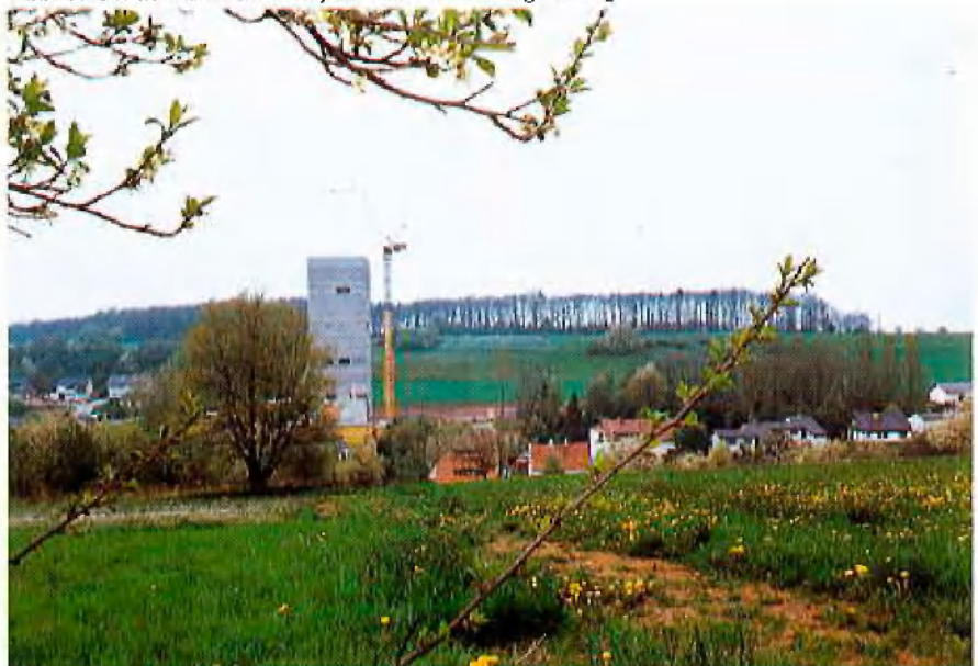
Abb. 9: Schachturm im Frühjahr nach der Fertigstellung
