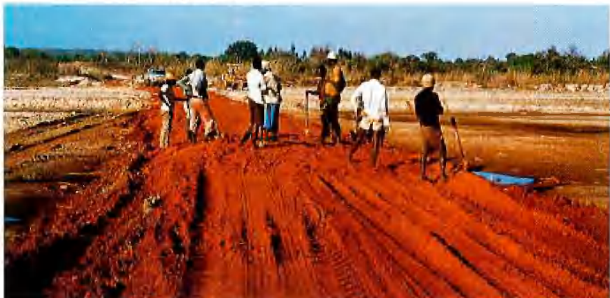
Straßenunterbau in sumpfigem Gelände
