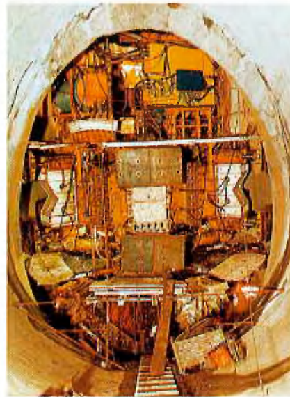
Abb. 7: Montierte Schachtbohrmaschine vor dem Bohreinsatz
