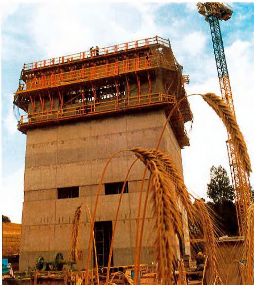
Abb. 1: Schachtturm während des Baus
