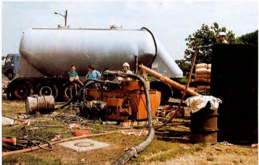
Stollenverfüllung in Essen
