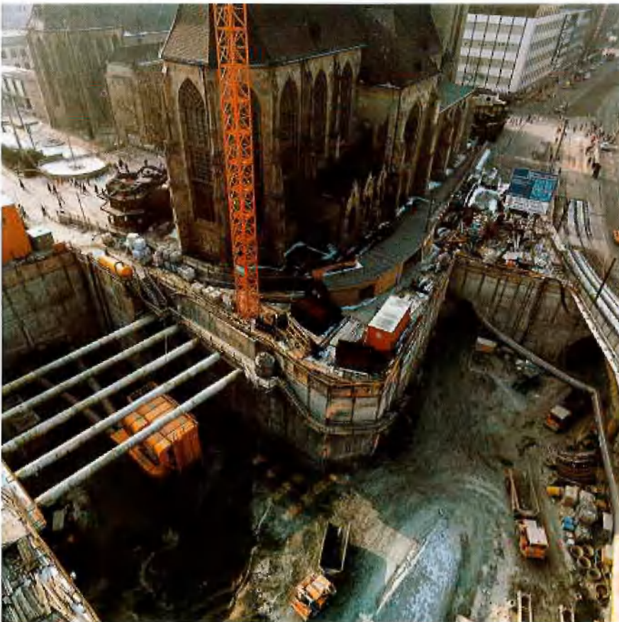
Durchschlag zum Bahnhof Kampstraße Baugrube Kreuzungsbahnhof Reinoldikirche mit zentraler Vortriebsentwicklung
