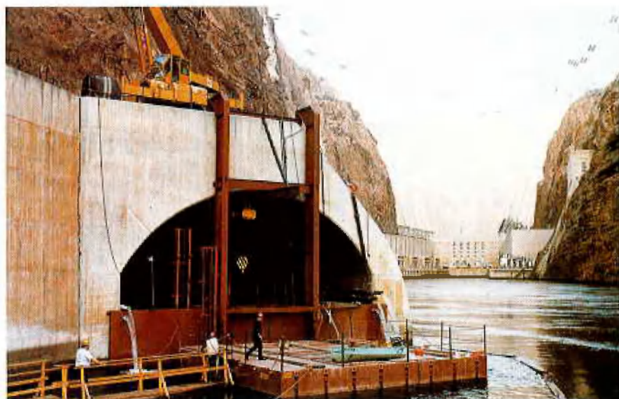
Reparaturarbeiten am Hoover-Damm
