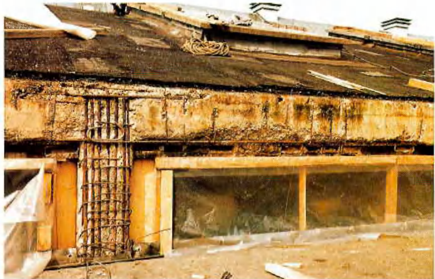
Sanierung einer Kraftfahrzeughalle – Stahlbetonstützen im oberen Dachbereich
