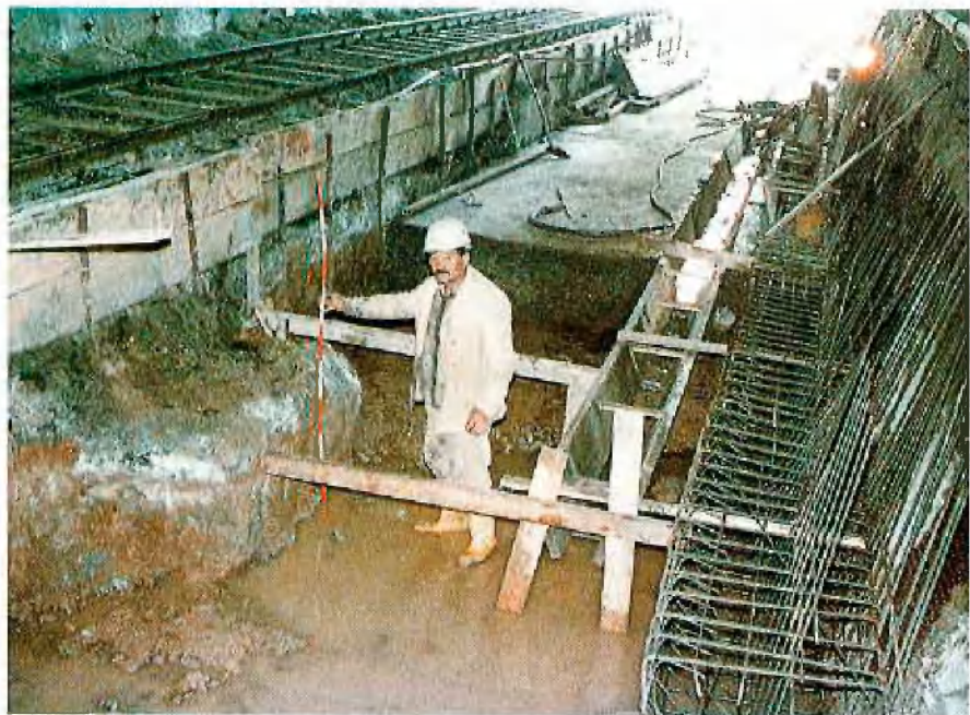
Abb. 5: Halbs seitige Herstellung der Gewölbefundamente und Sohlplatte
