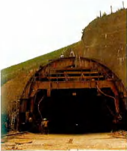
Aufstellung des Schalwagens am Portal Steinberg-Süd
