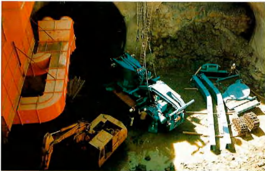
Stadtbahn Dortmund, Brüggmannplatz – Montage der WAV 178 im Nordschacht
