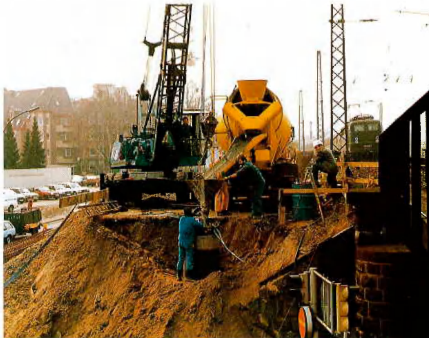
Stützwände Gielenstraße Neuss – Herstellung eines Bohrpfahles
