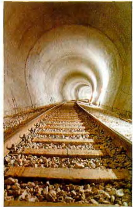
Abb. 11: Die fertiggestellte Tunnelröhre
