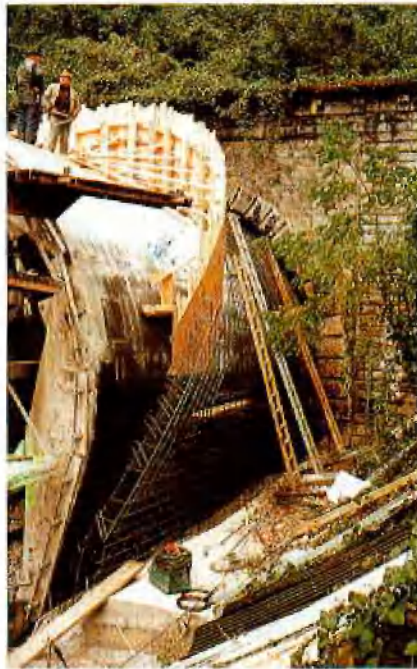
Abb. 10: Schalung für den Portalkragen
