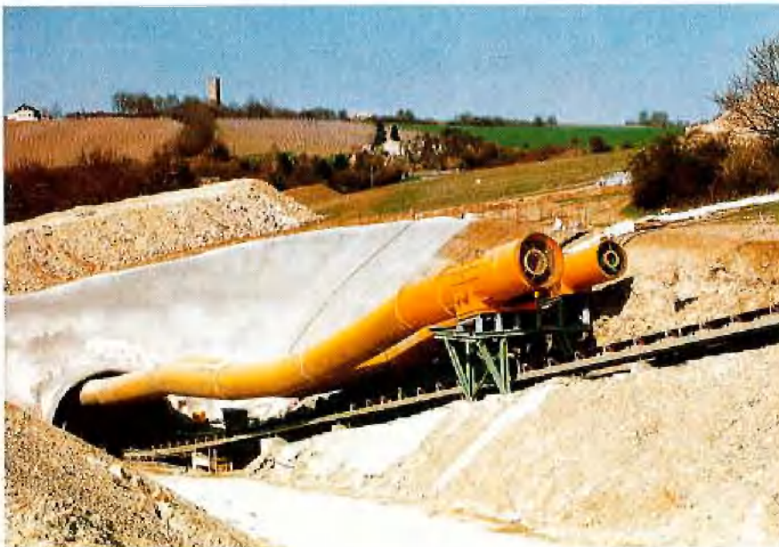
Bandstrecke mit Portal zum Fensterstollen
