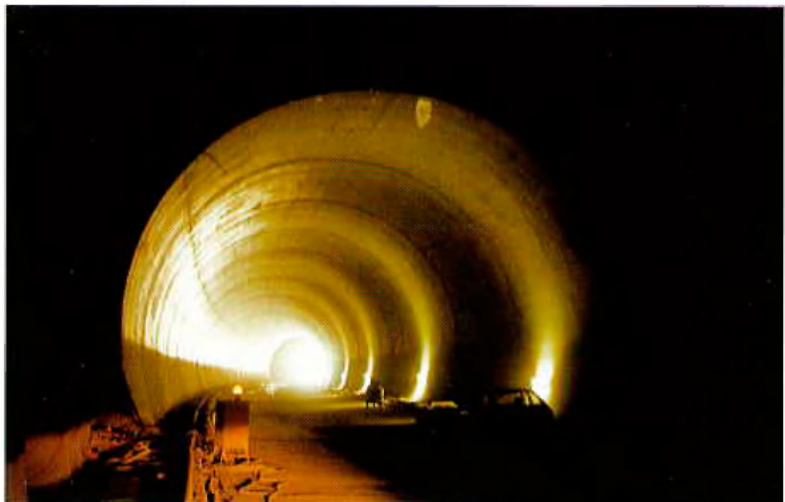
Fertig betonierte Innenschale im Steinberg-Tunnel
