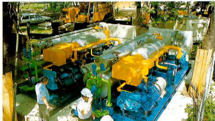
U-Bahn Wien, Montage der Gefrierstation
