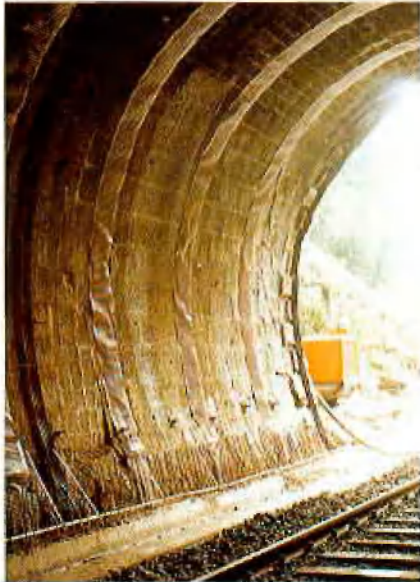
Abb. 6: Noppenfolienstreifen zur Entwässerung zwischen alter und neuer Tunnelauskleidung
