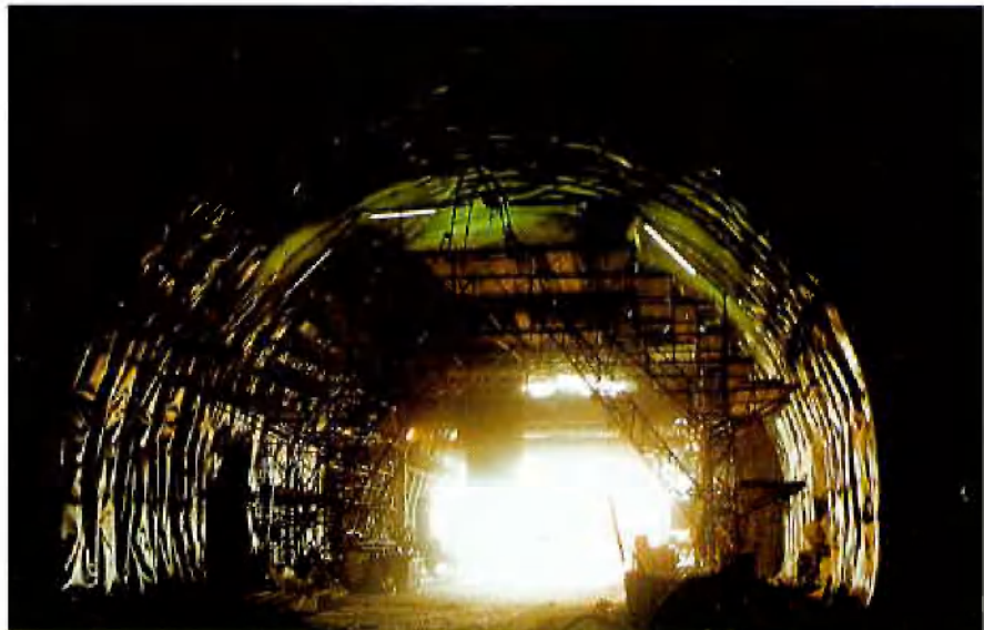
Einbringen der Carbofol-Folie als Tunnelisolierung
