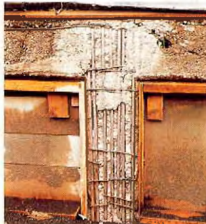
Abb. 4: Zu dichte Armierung
