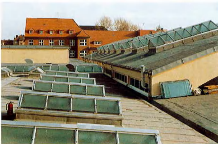
Abb. 9: Dachaufbau mit Schutzanstrich
