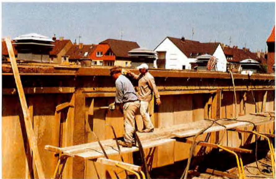
Abb. 7: Auftragen des Spritzbetons im alten Profil
