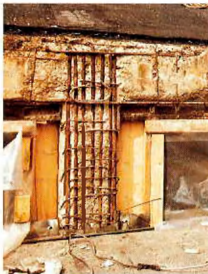
Abb. 1: Tiefgreifende Betonschäden
