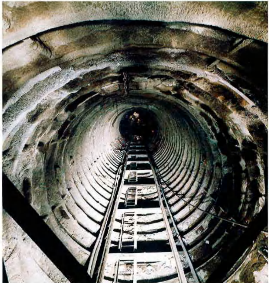
Schrägbunker Emil Mayrisch
