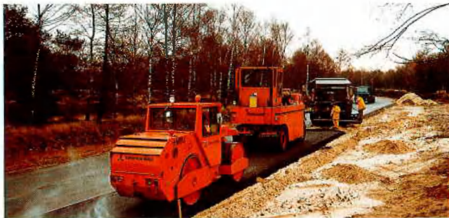
Straßenbau im Munitionsdepot Itterbeck
