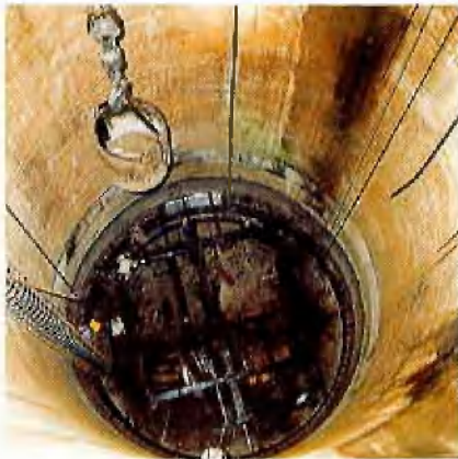
Fertiges Schachtkopfbauwerk mit beiden Wetterkanalabgängen Montage der schwebenden Arbeitsbühne
