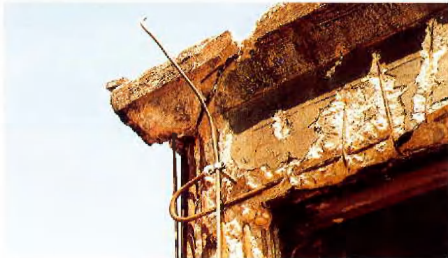
Abb. 4: Zu dichte Armierung
