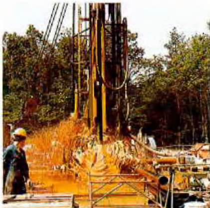
Schachtvorbohrung Tannenberg 6
