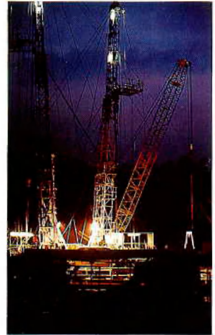
Herstellen der Gefrierbohrlöcher
