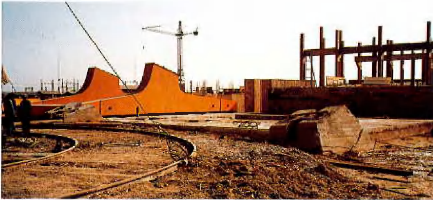
Schachtplatz Dong Huan Tuo 2
