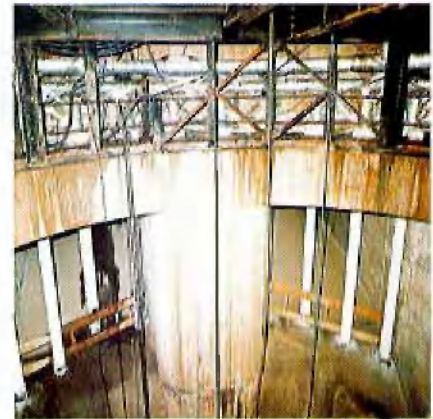
Aufsetzen der Seilscheibenbühne in ca. 45 m Höhe Gefrierkeller
