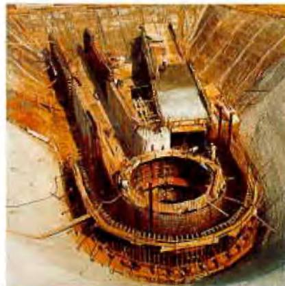
Schachtkopf und Wetterkanäle
