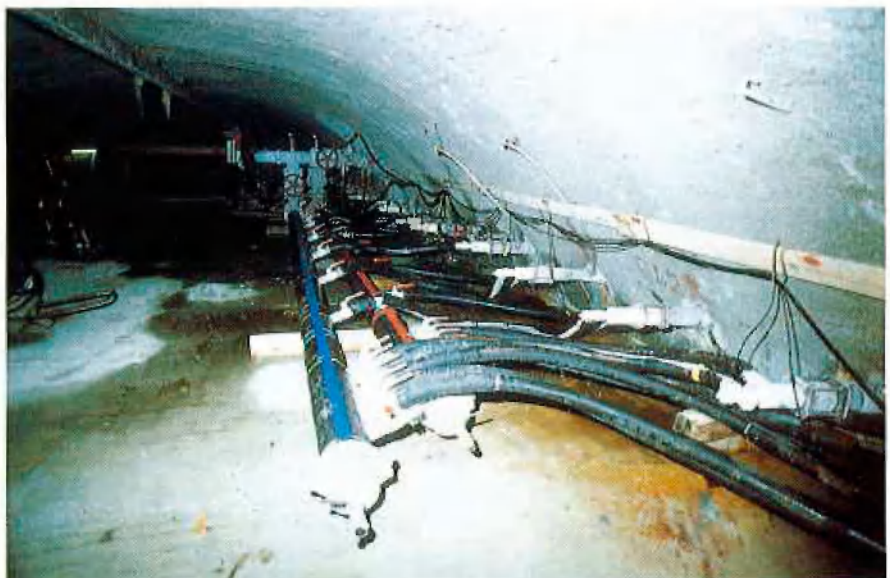
Abb. 10: Vereisungsquerschlag
