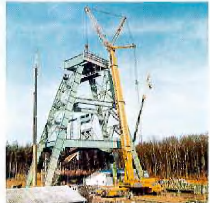
Aufsetzen der Seilscheibenbühne in ca. 45 m Höhe Gefrierkeller
