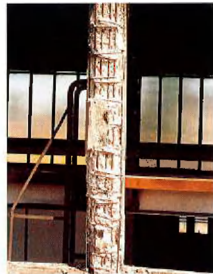
Abb. 2: Weitere Betonschäden
