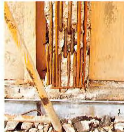
Abb. 5: Flächen nach dem Sandstrahlen
