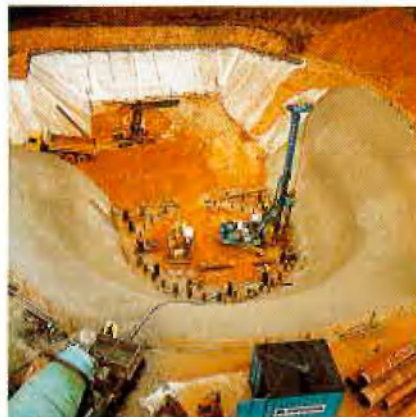
Offene ca. 10 m tiefe Baugrube
