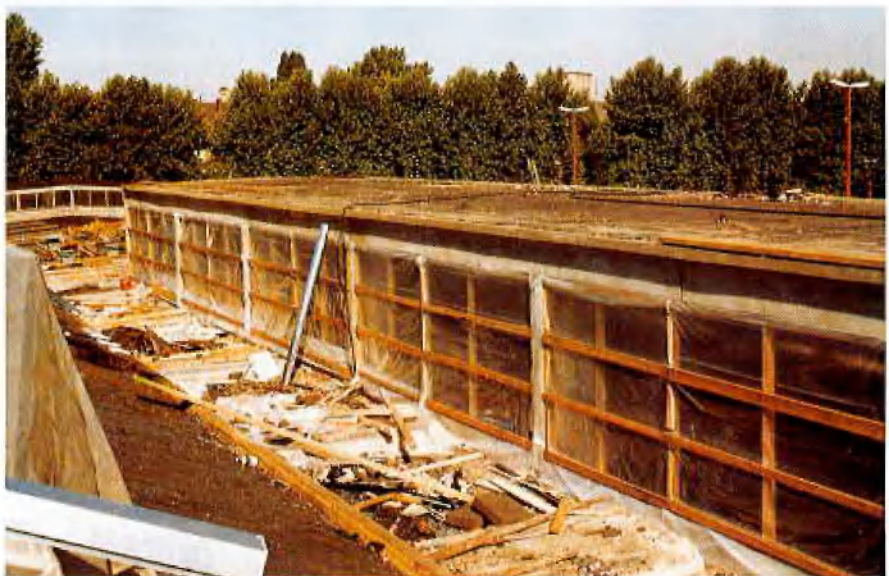
Abb. 8: Im Rohbau fertiger Hallenteil
