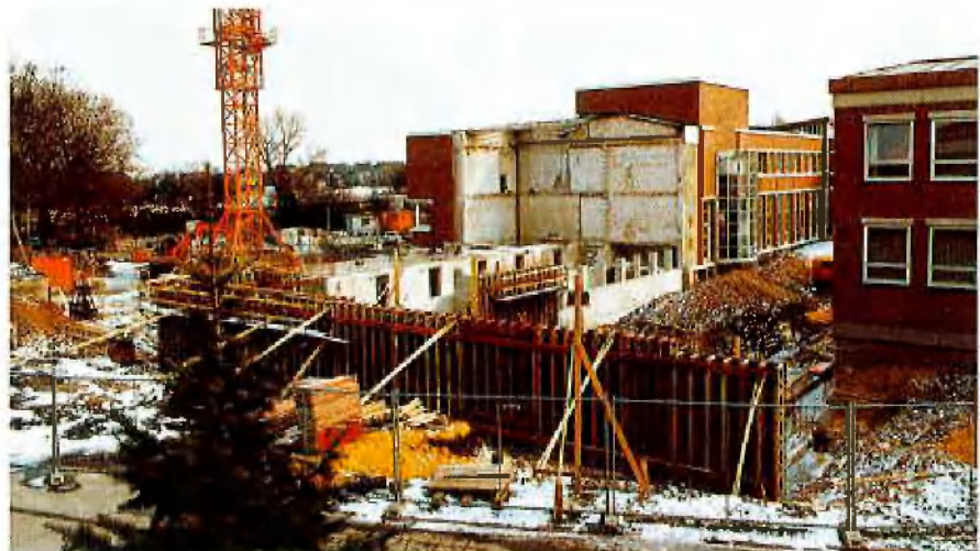
Rohbauarbeiten am Verwaltungsgebäude Deilmann-Haniel
