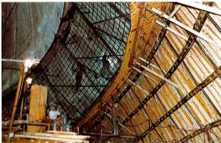
Betonierarbeiten am Belüftungsschlitz des Hoover-Damms
