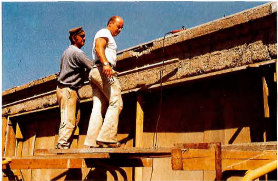
Abb. 6: Erstellen der Kantenschalung
