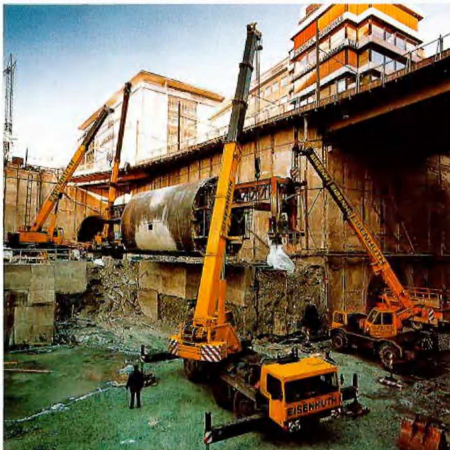
Stadtbahn Dortmund – Umsetzen des Fullround-Schalwagens
