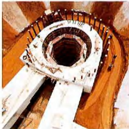
Fertiges Schachtkopfbauwerk mit beiden Wetterkanalabgängen Montage der schwebenden Arbeitsbühne
