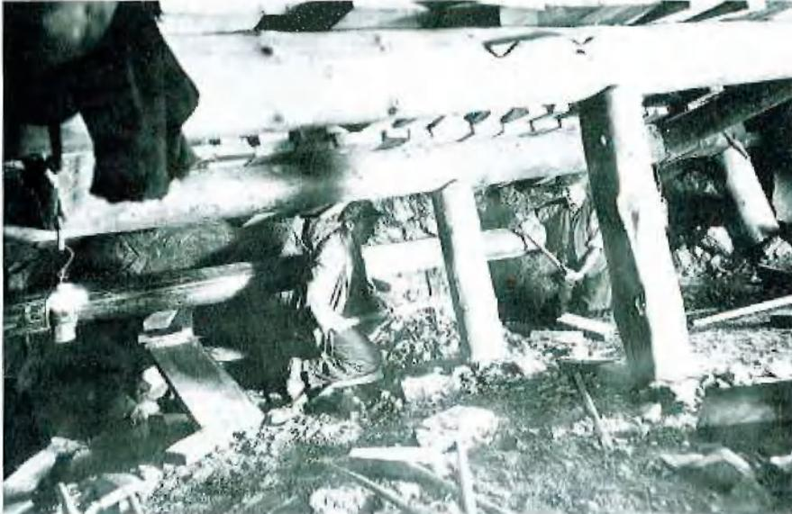
Abb. 8: Ausweiten des Gebirges für die Rückenabdichtung des Gewölbes - Kurzenbergtunnel 1934
