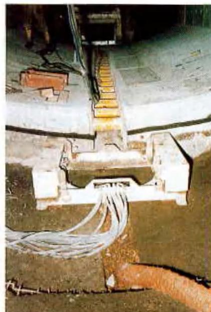
Abb. 9: Hydraulikbock
