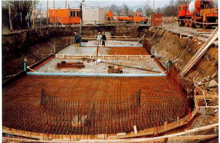
Betonieren der Sohle des Oxidationsgrabens
