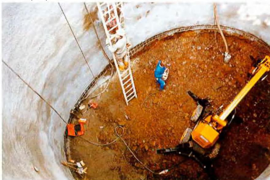
schnur Supercord 100 mit 2,7 kp/m<sup>3</sup> verwendet, mußten aber wegen der immer härter werdenden Felsformation auf Sprengpatronen Amongelit 2 mit 3,1 kp/m<sup>3</sup> übergehen.
