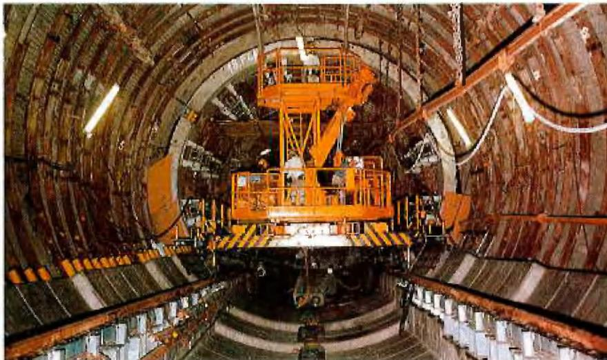
Abb. 6: Einbaugerät für die Stoß- und Firstpaneele
