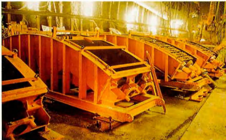
Abb. 3: Paneelschalungen für unterschiedliche Ringdurchmesser
