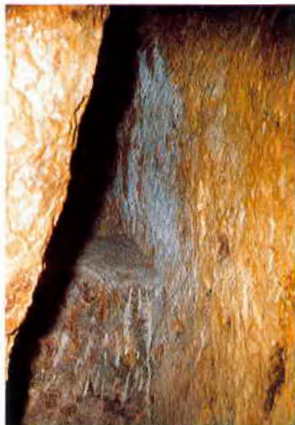
Abb. 5: Querschlägiges Suchort in Schlägel- und Eisenarbeit
