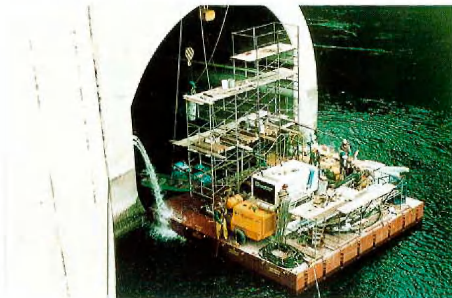
Abb. 14: Bau des Schottes am Auslaufbauwerk
