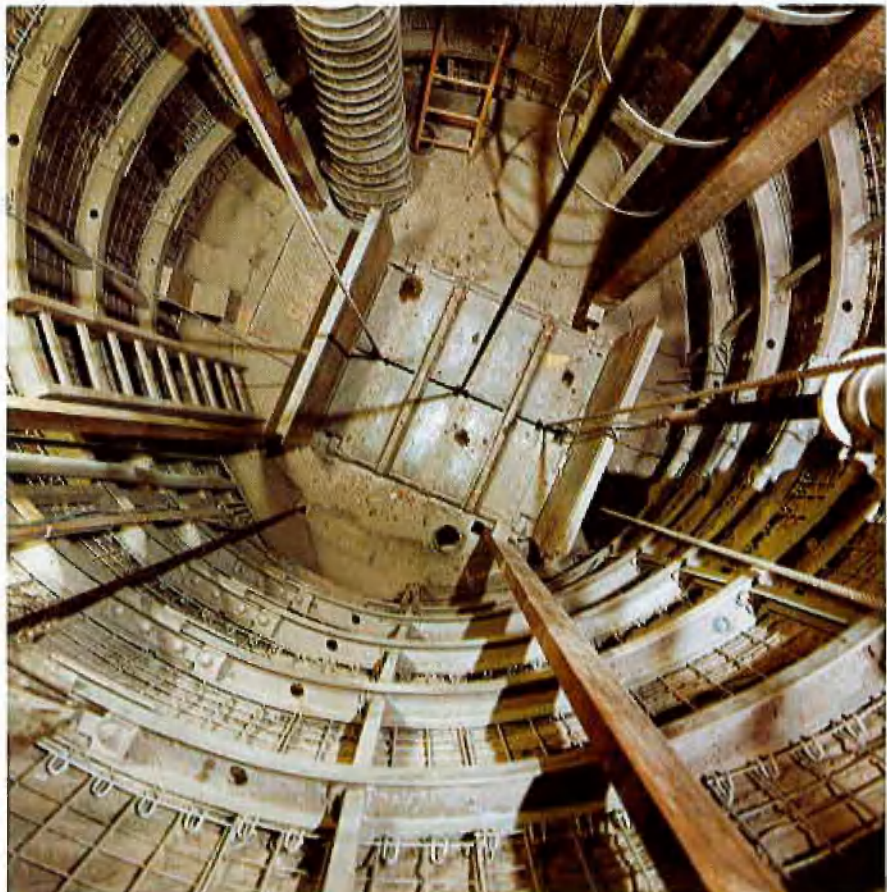
Demontage des Bohrkopfes Abgehängte Schachtabdeckung
