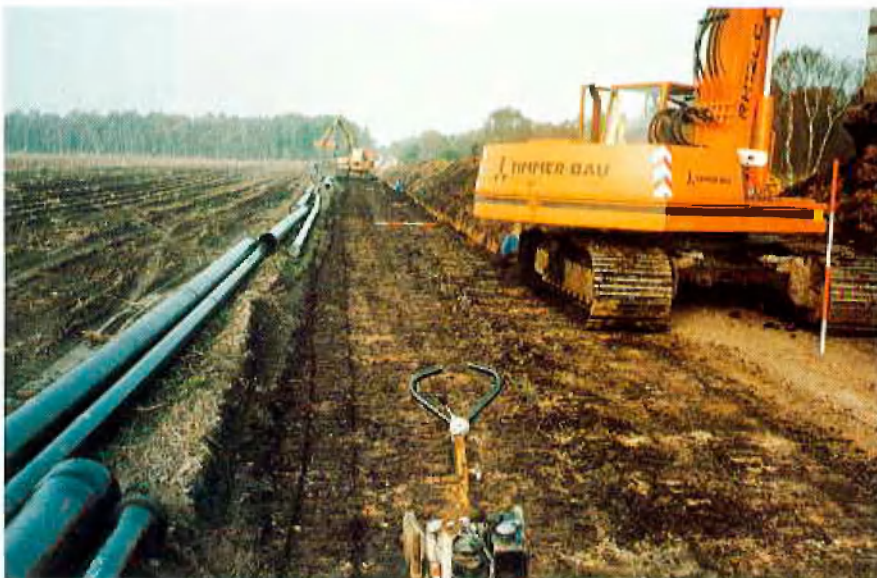
10"-Pipeline für die Wasserversenkung im Erdölfeld Scheerhorn
