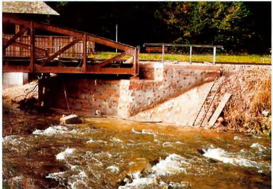
Sanierung einer Überführung über die Schiltach
