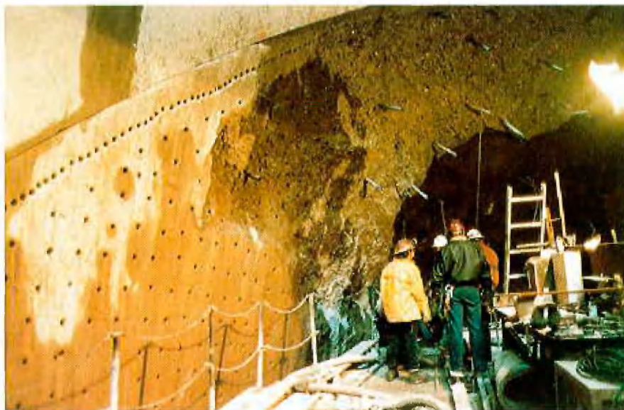
Abb. 13: Bohren der Spreng- und Entlastungslöcher
