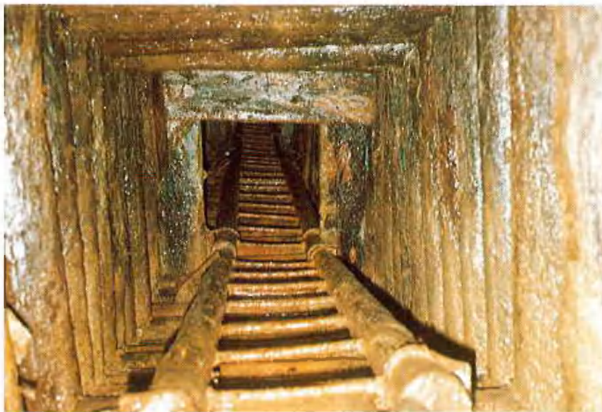
Abb. 7: Fahrrolle oberhalb Kappeler Stollen, Blick nach oben
