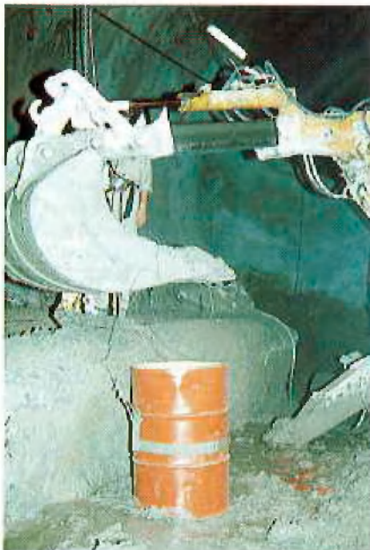
Abb. 4: Abfüllen von Hg-Material der Klasse C in Fässer
