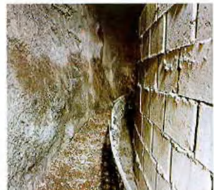
Doppelschaliger Bunkerausbau
