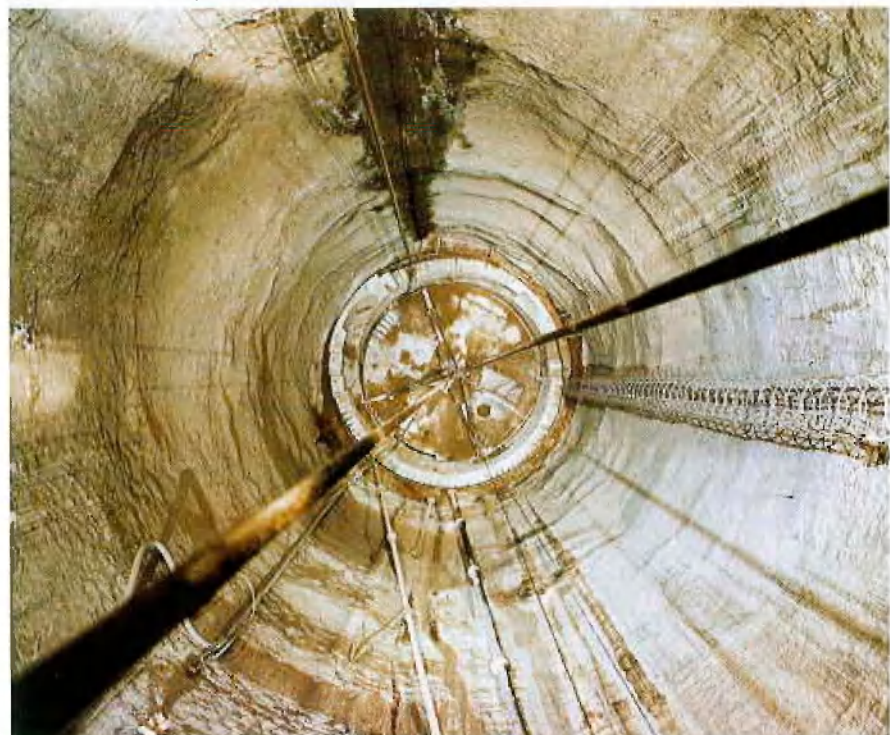
Bunker in der Teufphase
