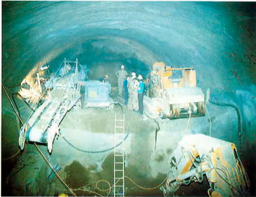
Abb. 3: Geräteinsatz im Stationsröhrenvortrieb
