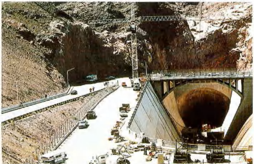
Abb. 5: Einlaufbecken auf der Nevada-Seite mit Turmdrehkran
