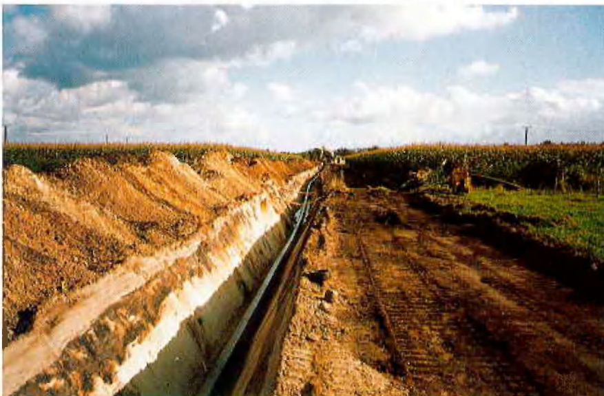
10"-Pipeline für die Wasserversenkung im Erdölfeld Scheerhorn
