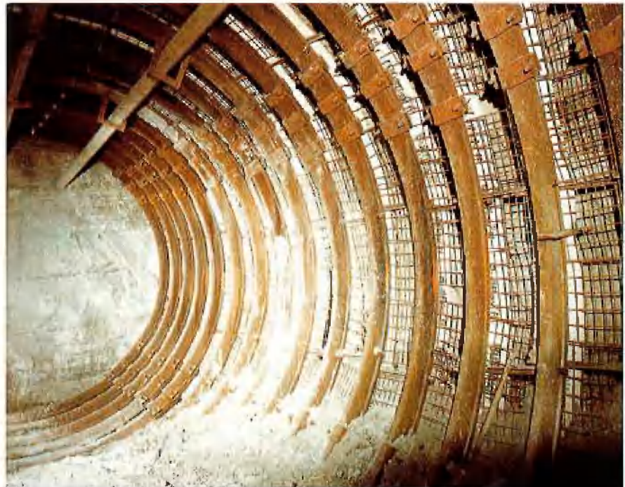
Bullflex-Ausbau auf der Grube Marie Louise in Frankreich
