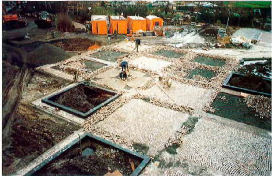
Außenanlagen Deilmann-Haniel, Gestaltung des Vorplatzes
