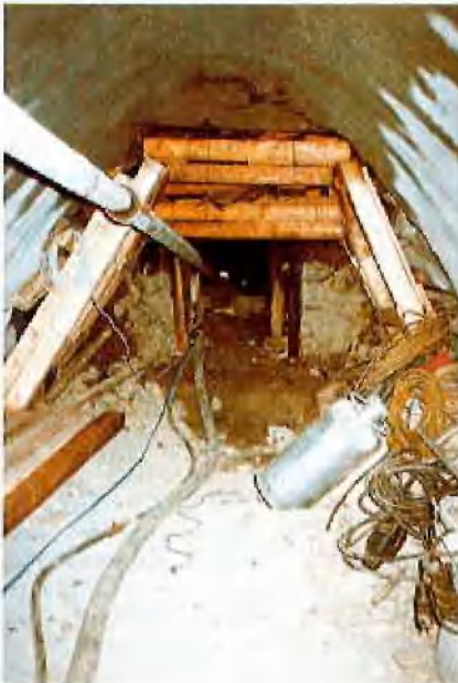
Verfüllung eines Wehrmachtsstollens
