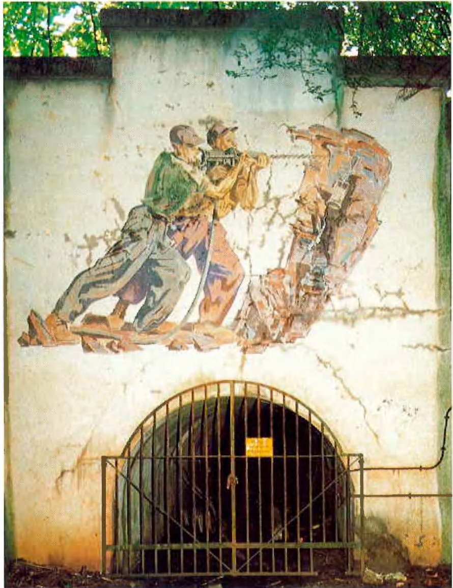
Abb. 11: Stollenmundloch des Eisenbahnstollens in St. Georgen
