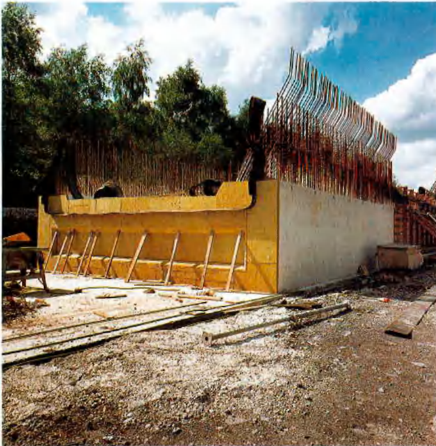
Abb. 3: Blockfugenausbildung im Bereich der Sohlplatte
