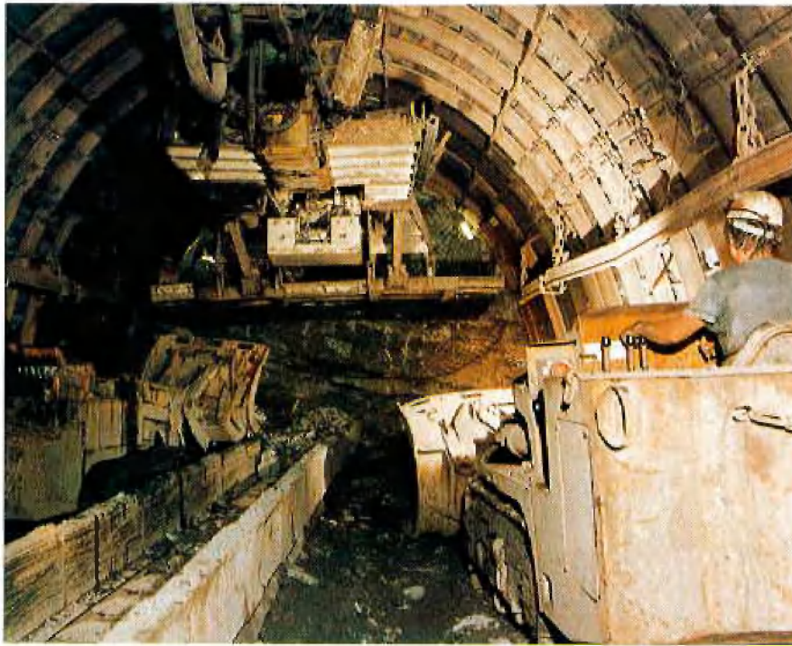
Abb. 6: Arbeitsbühne und Ausbauhilfe vor Ort
