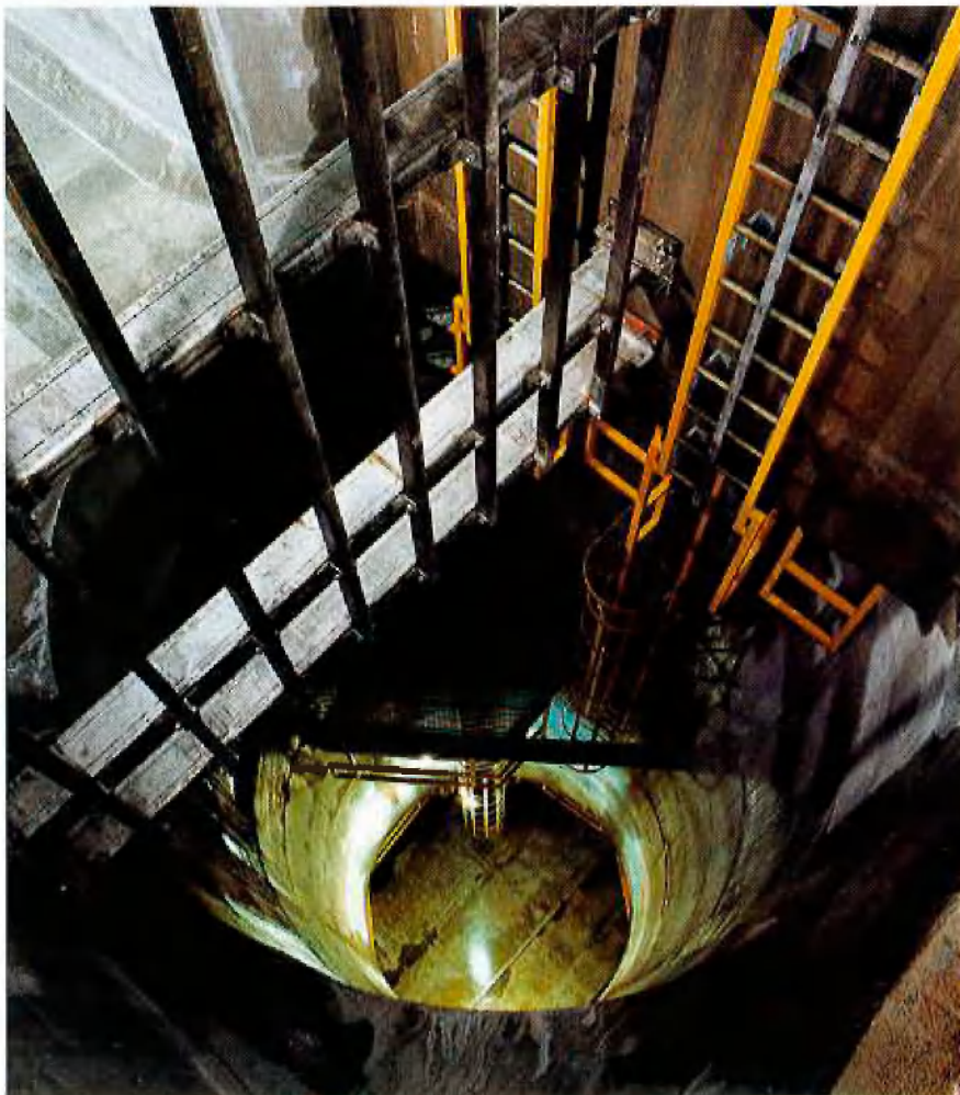
Blick in einen fertiggestellten Abwasserschacht in Milwaukee
