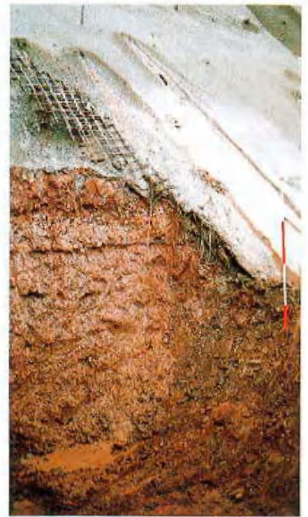
Abb. 6: Anschnitt der Violettten Grenzzone im Bereich des Tunnelanschlags
