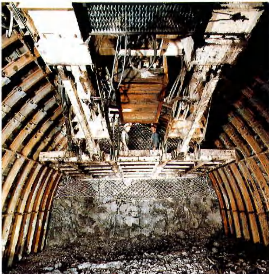
Abb. 2: Die neue Arbeitsbühne wird über eine hydraulische Abstützung stabilisiert
