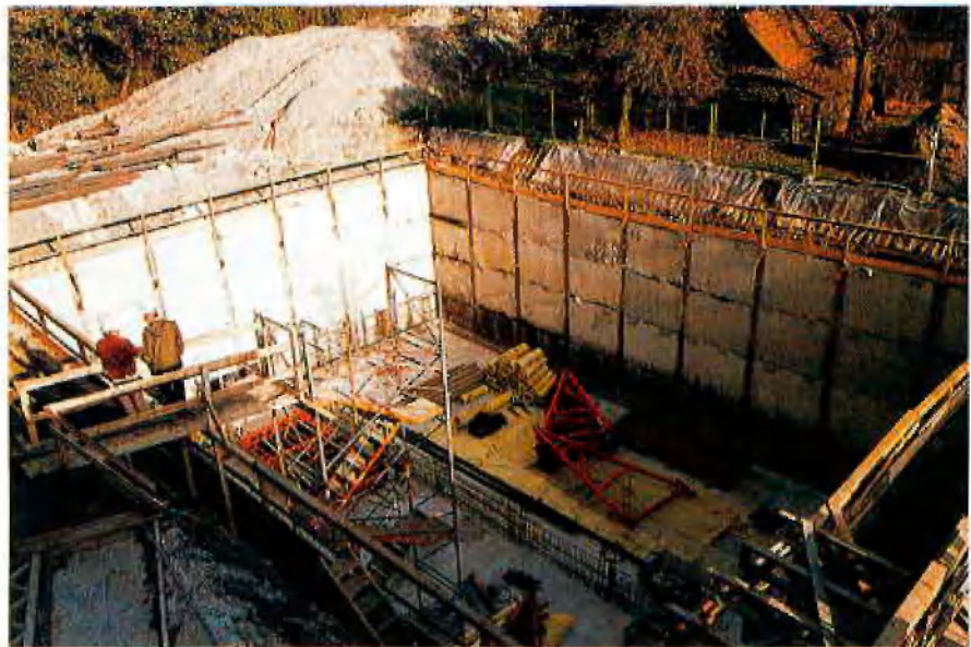
Rückhaltebecken Rünthe Laborgebäude der VEW
