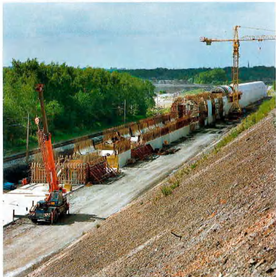
Abb. 6: Taktfertigung der einzelnen Betonierabschnitte
