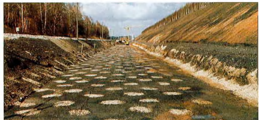
Abb. 2: Raster der Kiesstopfpfähle
