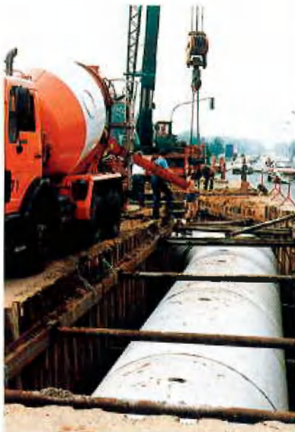
Tiefbau im Raum Neuss
