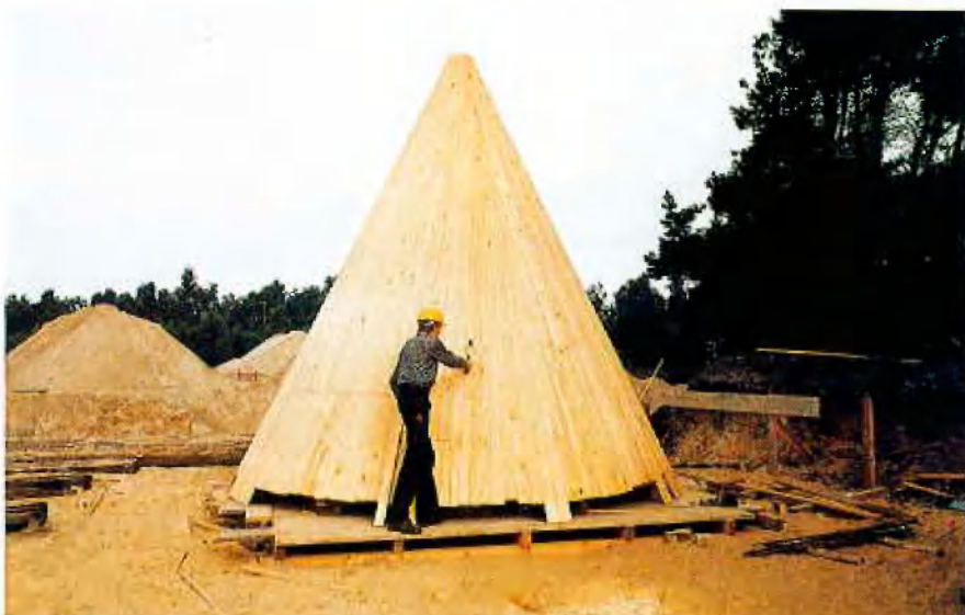
Zentraldeponie Wilsum, Schalung des Tropfkörpers
