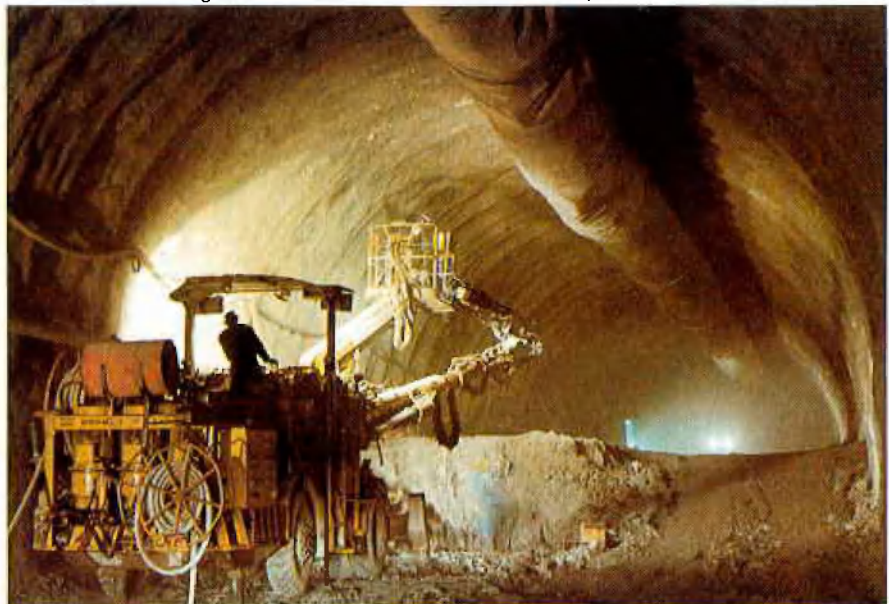
Abb. 4: Oswaldibergtunnel: Strossenvortrieb mit der Rampe zur Kalotte
