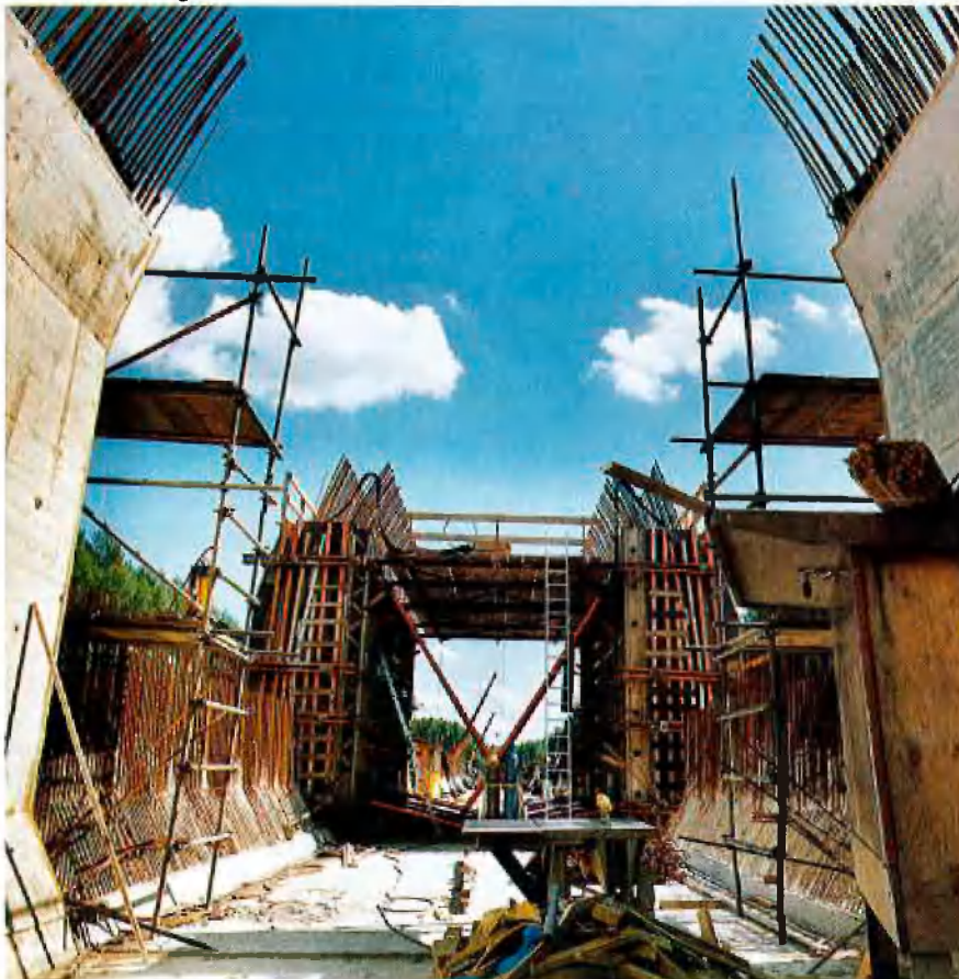
Abb. 4: Schalung der Ulmen
