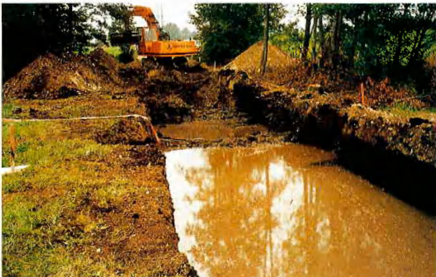
Bohrplatz Grambach – Auskofferung der Zufahrt
