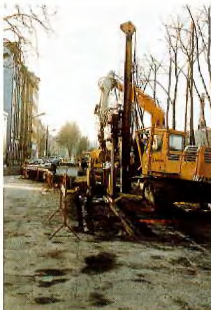
Kanalbau in Düsseldorf
