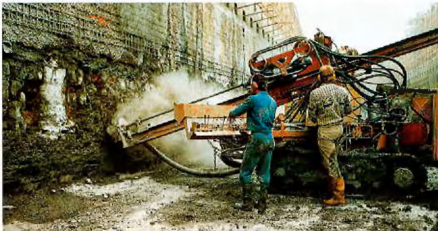
Raupenbohrwagen Krupp DH 80 bei Bohrarbeiten für die SN-Anker im Baulos 72
