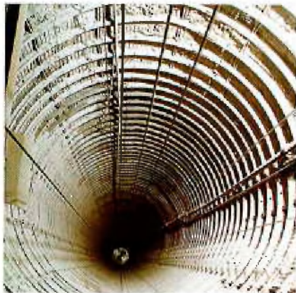
Blindschacht Monopol mit Ringausbau und Vollhinterfüllung
