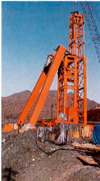
Montage des Fördergerüsts
