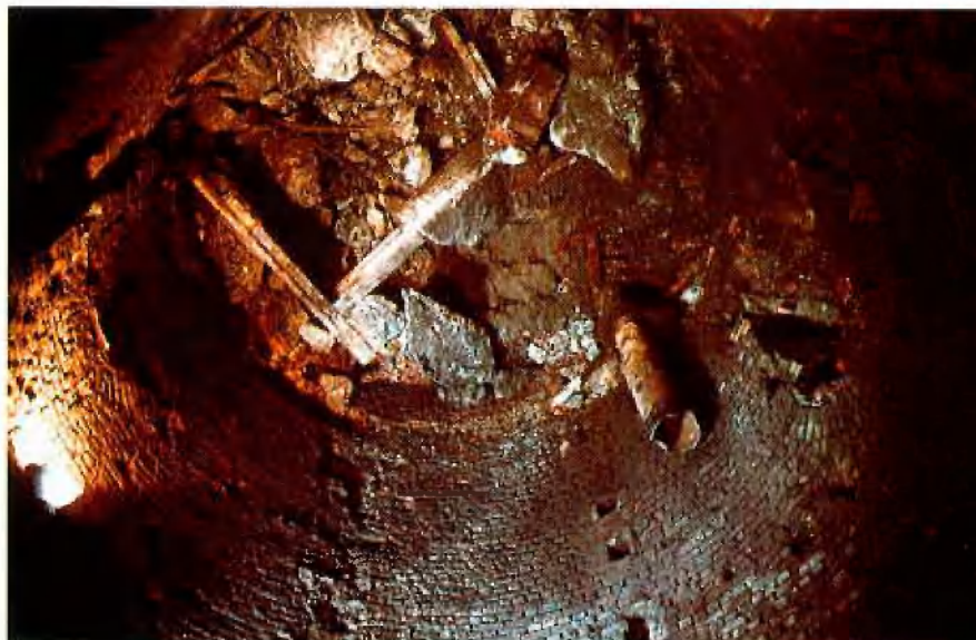
Blick in den Schachtkopf
