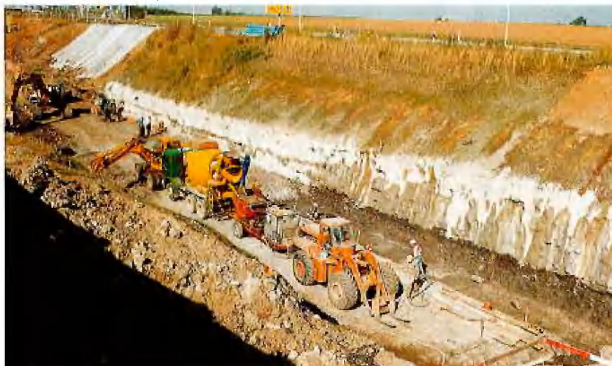
Mobile Naßspritzanlage im Baulos 64
