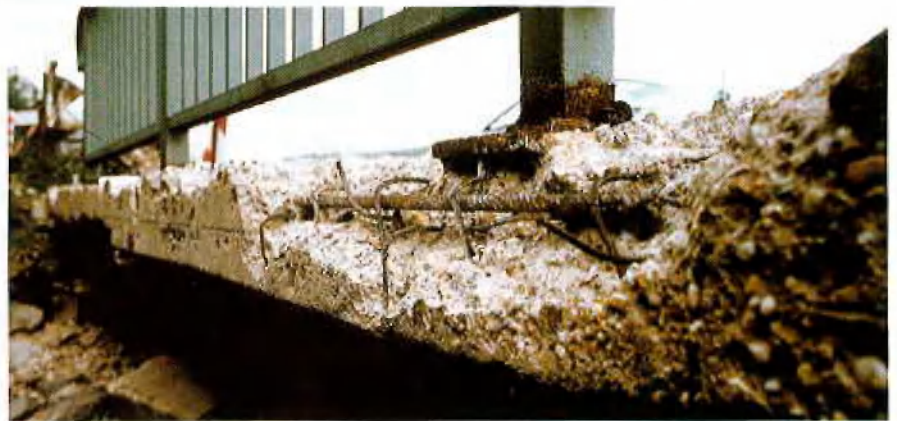
Stützwand nach der Instandsetzung
