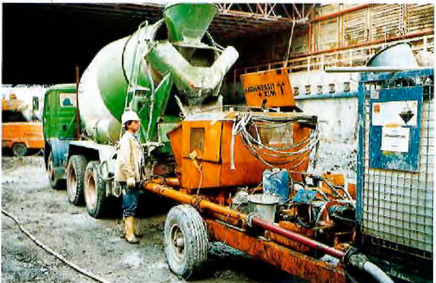
Senkrechte Baugrubenwand mit Spritzbetonsicherung und Drainleitungen Mobile Naßspritzpumpe bei Fahrmischerbeschickung direkt in der Baugrube
