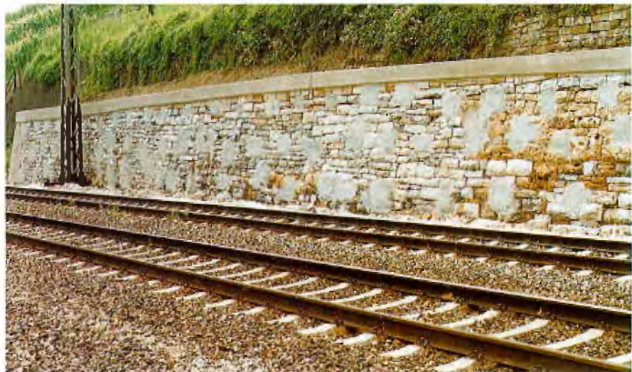
Sanierte Stützmauer
