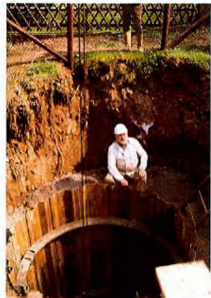
Schachtsituation über Tage vor Beginn der eigentlichen Sanierungsarbeiten
