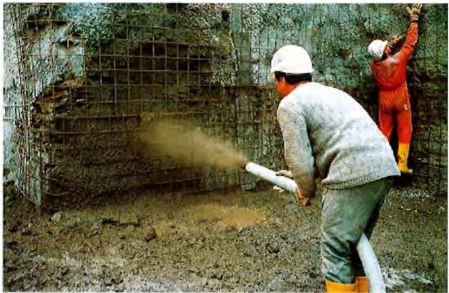
Spritzbetonauftrag im Naßspritzverfahren
