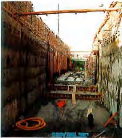
Baugrube im Baulos 72
