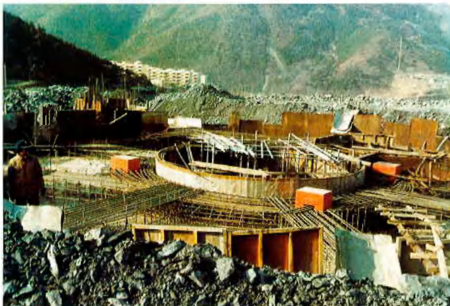
Schachtplatz Bau des Vorschachtes auf der Talsohle
