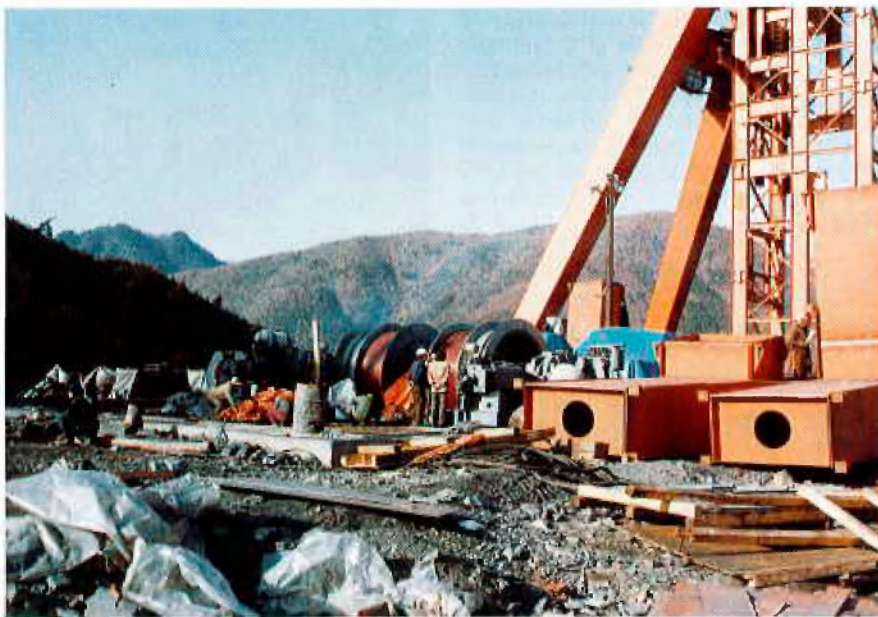
Schachtplatz Bau des Vorschachtes auf der Talsohle
