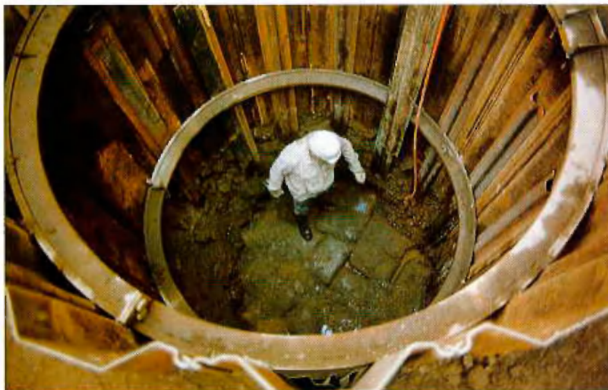
Die Betonverfüllung ist beendet
