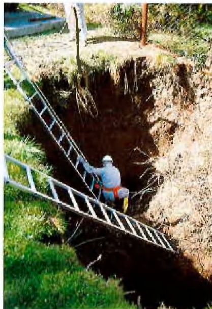
Der Tagesbruch zu Baubeginn – erste vorsichtige Inspektion
