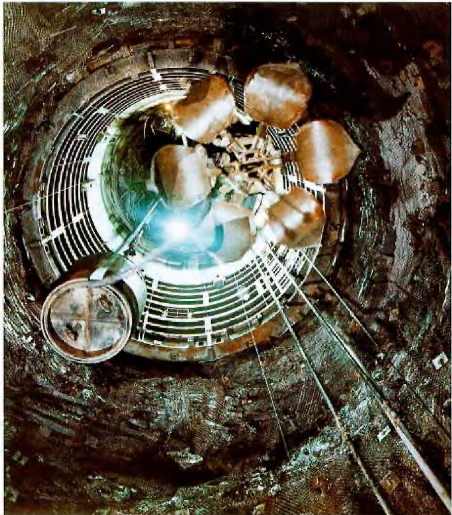
Teufarbeiten im Schacht Westerholt 1
