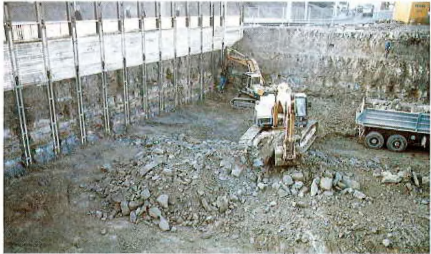
Offene Baugrube für den Straßentunnel 236n
