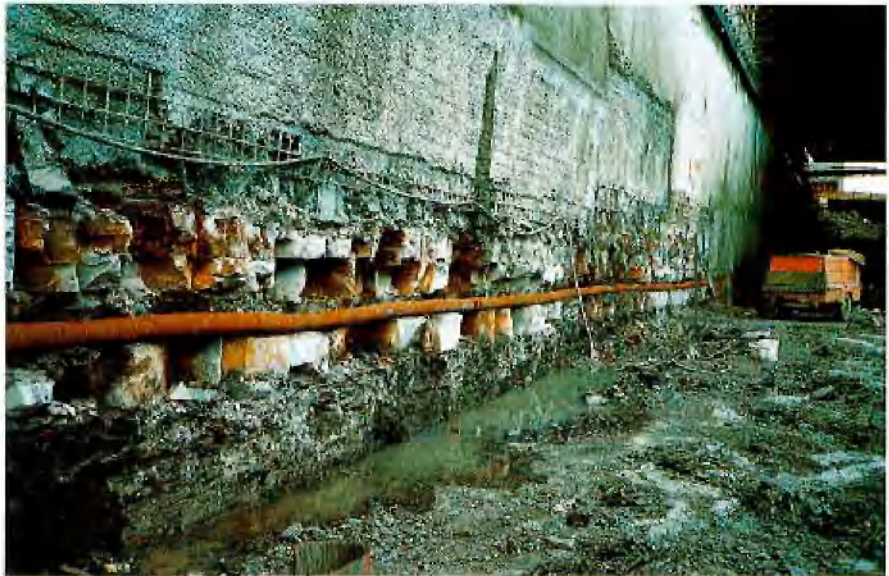
Senkrechte Baugrubenwand mit Spritzbetonsicherung und Drainleitungen Mobile Naßspritzpumpe bei Fahrmischerbeschickung direkt in der Baugrube
