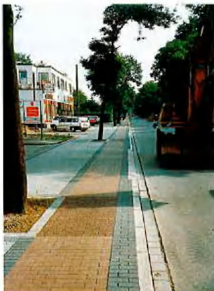
Straßenbauarbeiten in Recklinghausen
