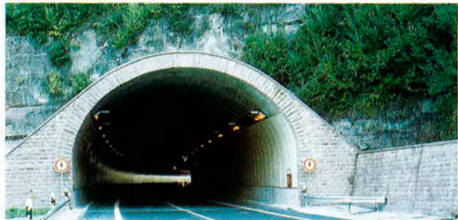
Westportal des Hirschhorntunnels
