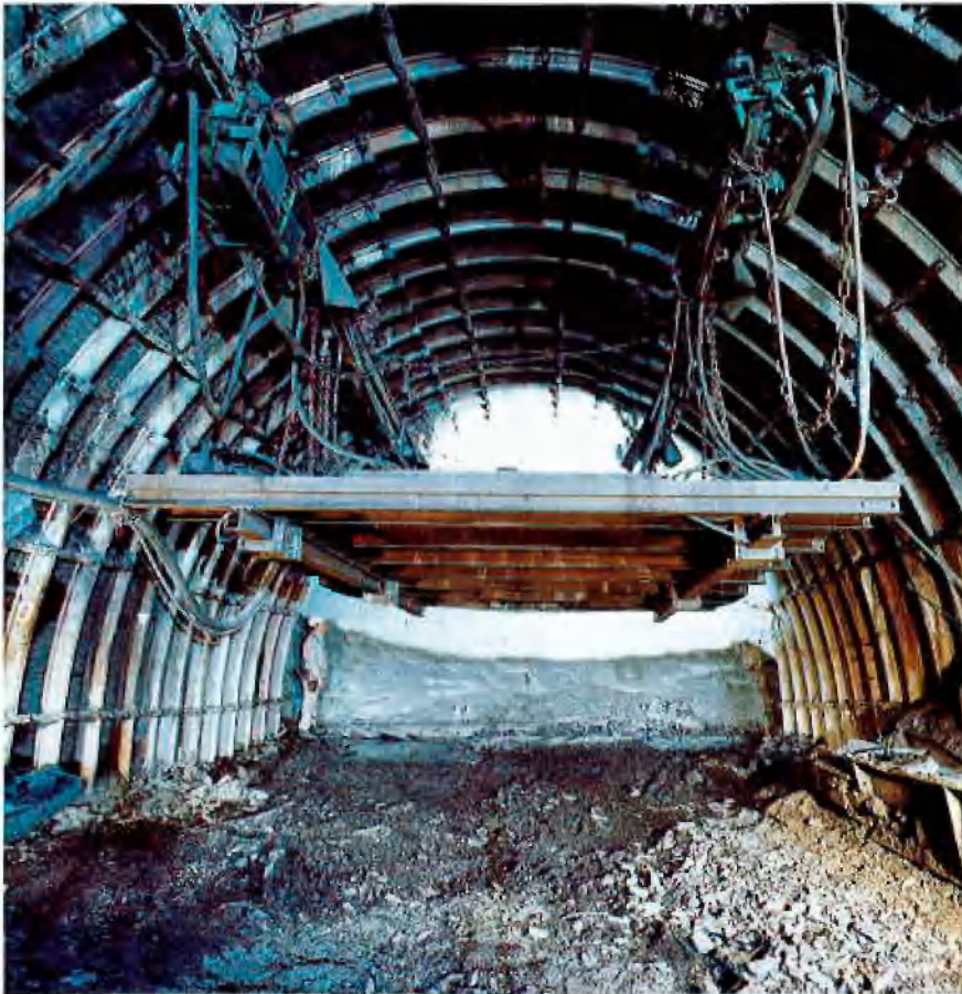
Abb. 4: Blick in einen fertigen Streckenabschnitt, Ortsbrust und Stöße konsolidiert Abb. 5: Ortsbrustabschlußsicherung in Anker-Spritzbeton-Ausbau
