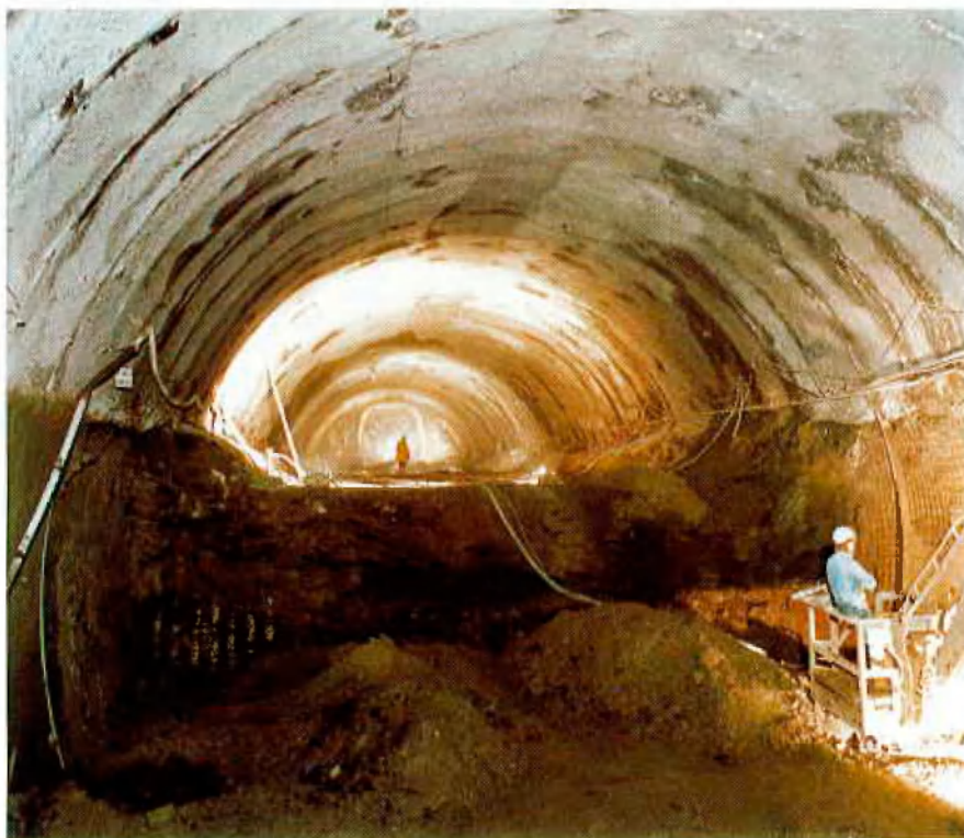
Kalottenvortrieb in Dortmund Stadtbahn Bochum: Einbau der federnden Masseplatten
