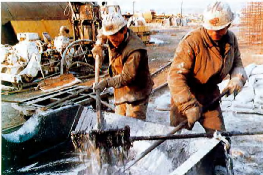
Sandasphalt wird gemischt ..... .... und erhitzt zur Abförderung im Kübel gefüllt
