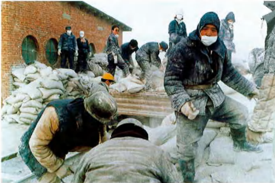
Steinmehl wird in den Bitumenmischkessel gefüllt
