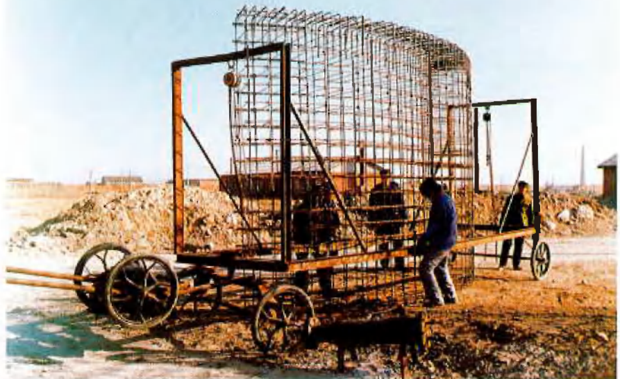
Ein vormontierter Bewehrungskorb auf dem Weg zum Schacht Betonarbeiten im Schacht
