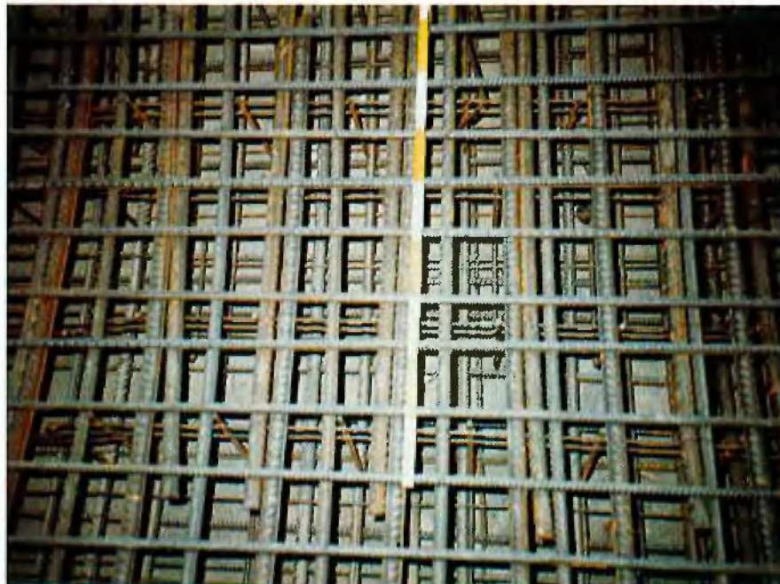
Abb. 7: Bewehrung des Gewölbes
