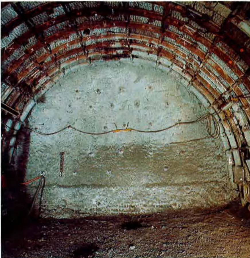
Abb. 4: Blick in einen fertigen Streckenabschnitt, Ortsbrust und Stöße konsolidiert Abb. 5: Ortsbrustabschlußsicherung in Anker-Spritzbeton-Ausbau
