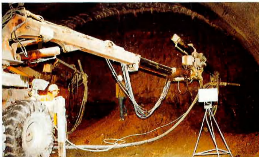
Abb. 3: Vortrieb im Deckelbereich
