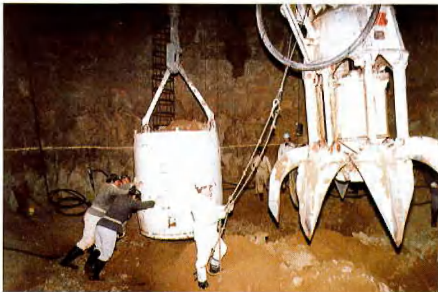
Das Teufen hat begonnen
