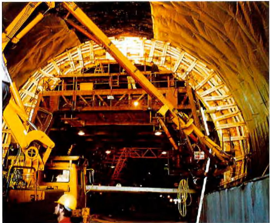
Abb. 9: Stirnschalung bei Profilsprung
