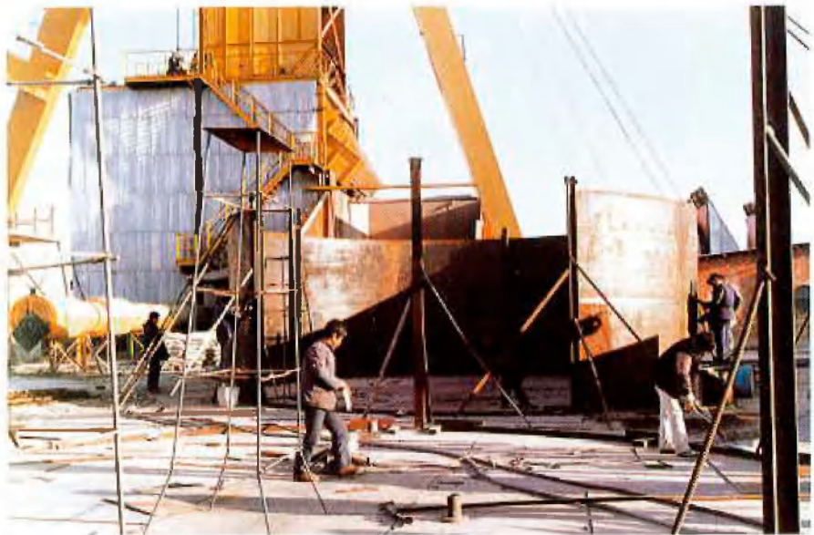
Die Stahlblechschüsse werden zum Einbau vorbereitet
