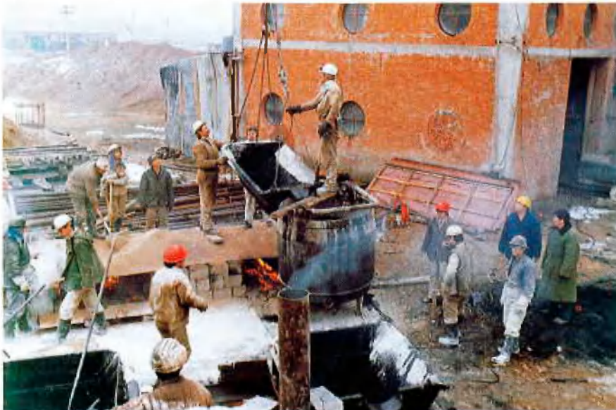
Sandasphalt wird gemischt ..... .... und erhitzt zur Abförderung im Kübel gefüllt
