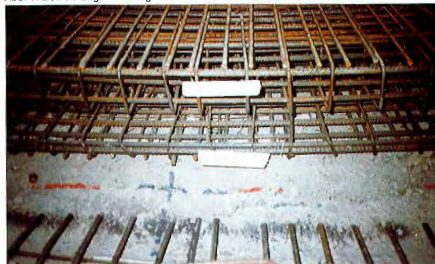
Abb. 5: Bewehrung des Sohlgewölbes
