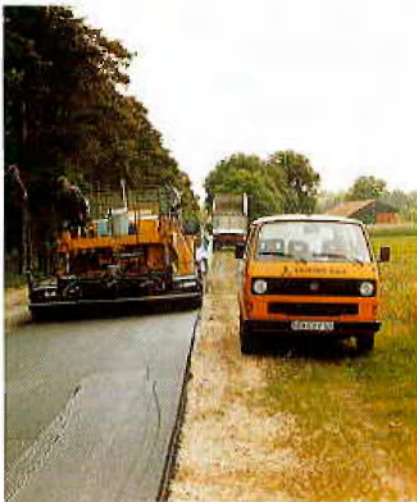
Wirtschaftsweg in Ochtrup – Asphaltfeinbetondecke
