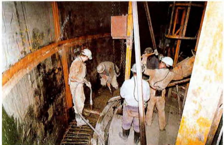
Ein vormontierter Bewehrungskorb auf dem Weg zum Schacht Betonarbeiten im Schacht
