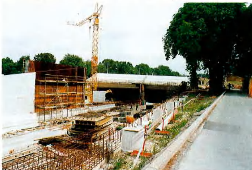
Nordportal der Hellweg-Unterquerung der B 236 n in Dortmund
