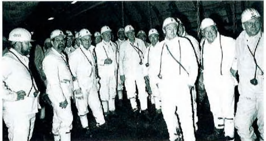
Abb. 1: Beim Durchschlag des Füllortes 11. Sohle mit dem Gesteinsberg
