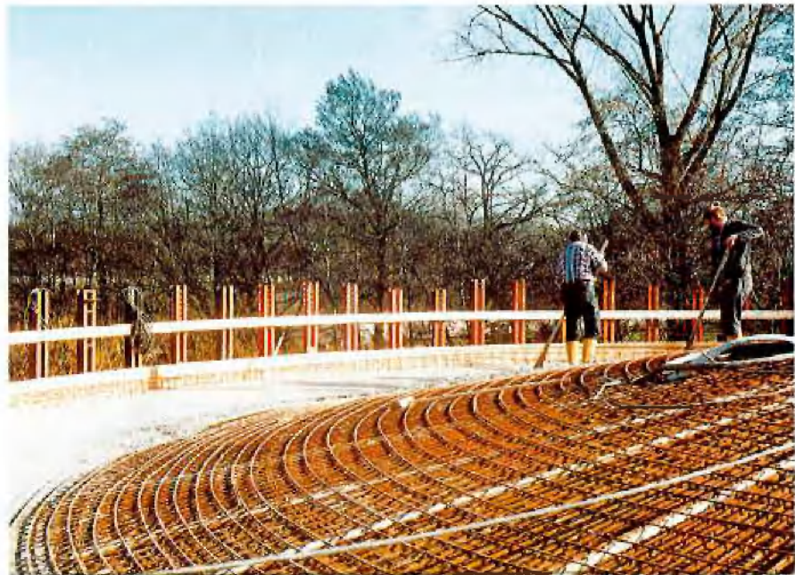
Bewehrung der Tropfkörperdecke im Klärwerk Hochdahl Regenüberlaufbecken Steinbach
