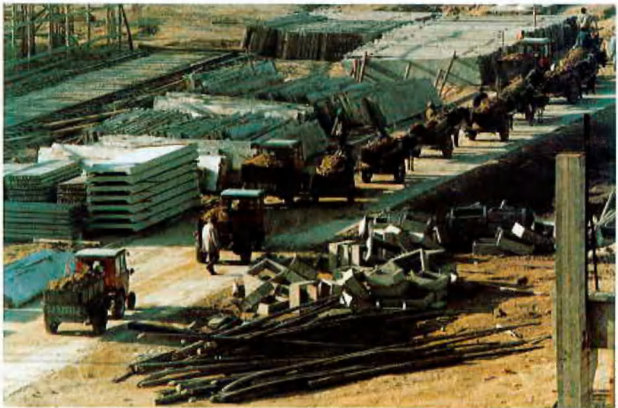
Antransport von Erdreich zur Aufschüttung eines Hallenbodens
