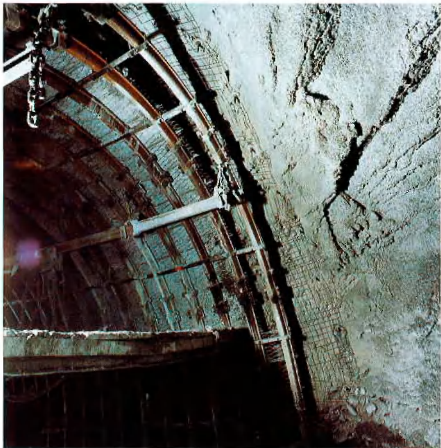
Abb. 2: Bis zur letzten Ankerreihe herangezogener Bogenausbau Abb. 3: Streckenausbau mit nachgeankerten 5-m-Ankern
