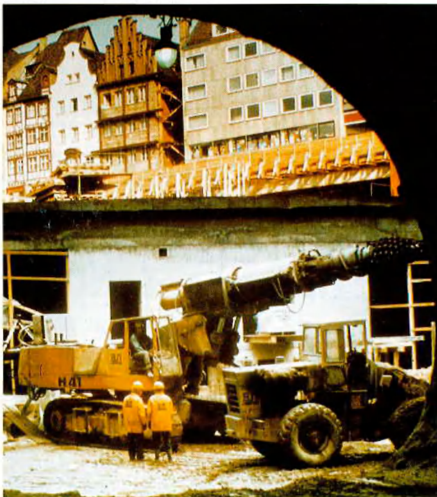
Bau der Station Berliner Platz in Bochum
