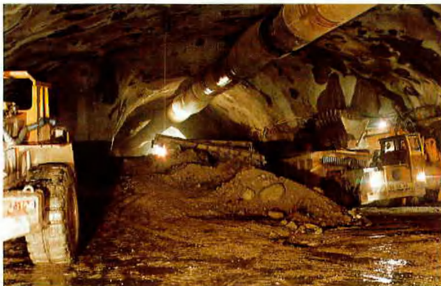
Vortriebsarbeiten im Karawankentunnel
