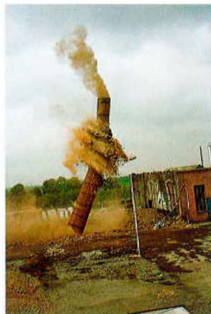
Alu-Werke Unna - Abbruch eines Schornsteins
