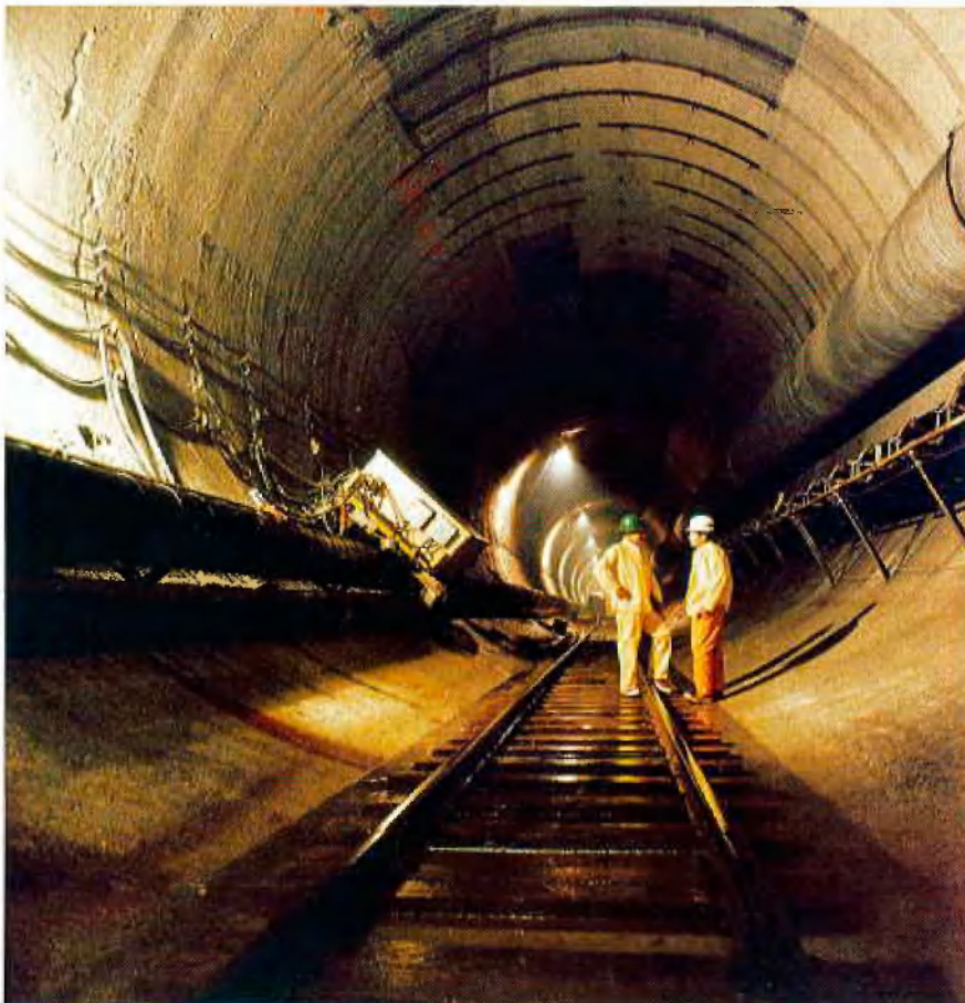
Vortriebsarbeiten in Milwaukee mit der 9,95-m-Vollschnittmaschine
