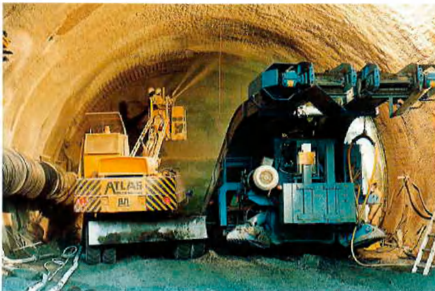
Vortrieb einer zweigleisigen Röhre mit TSM im Schutz des vorläufigen Ausbaus Auftragen einer Spritzbetonschicht zur vorläufigen Sicherung
