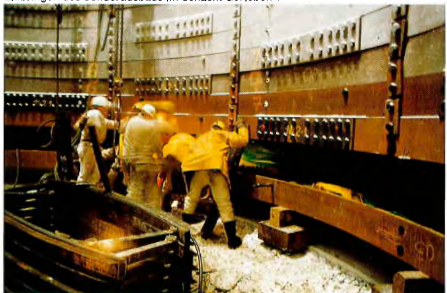
Einbringen des Sonderausbaus im Schacht Gorleben 1
