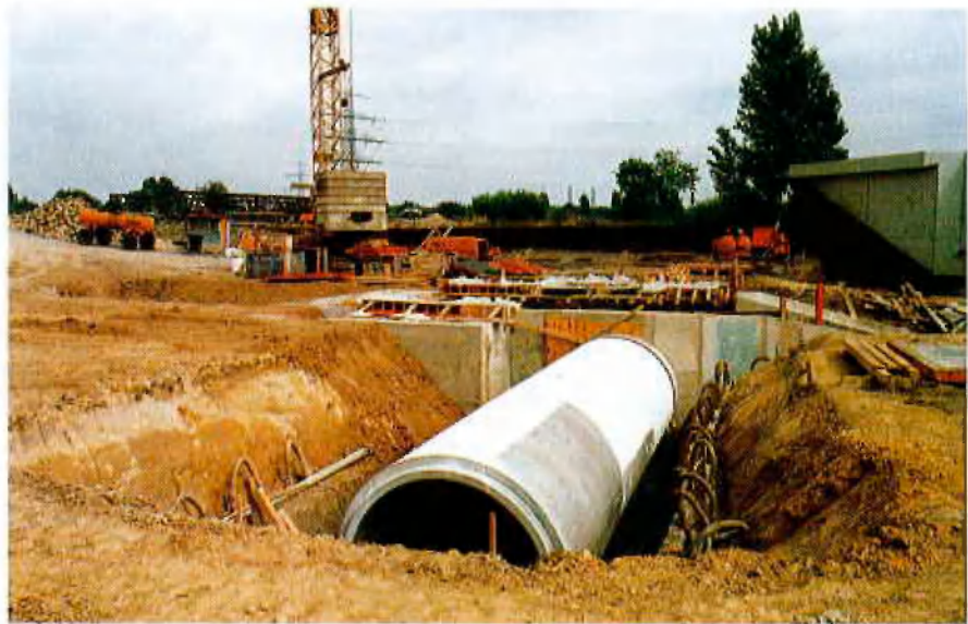
Einlaufbauwerk für den Körnebach in Dortmund-Scharnhorst Talbrücke Büschergrund - Abkleben mit Folie
