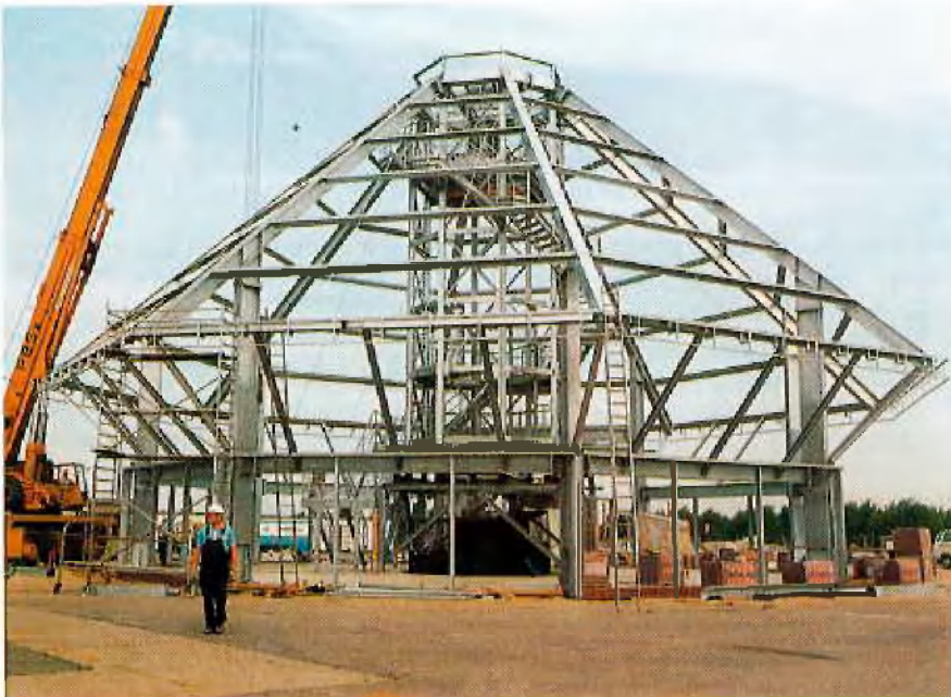
Stahlkonstruktion des Wettereintrittsgebäudes Fertigstellung des Gebäudes
