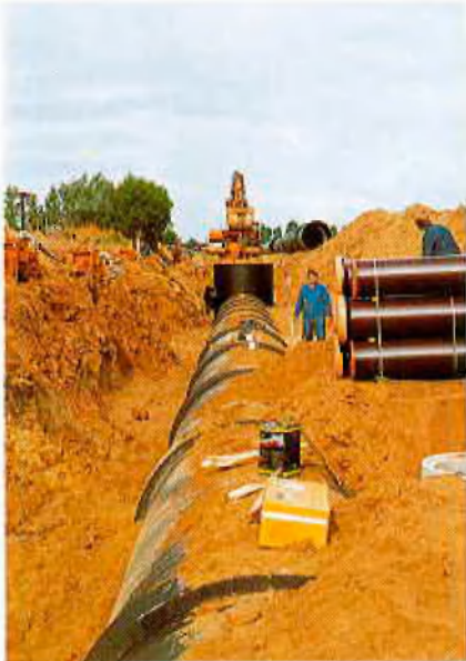
Rohrverlegung in Emmerich
