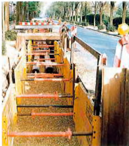
Verlegung der Fernwärmeleitung
