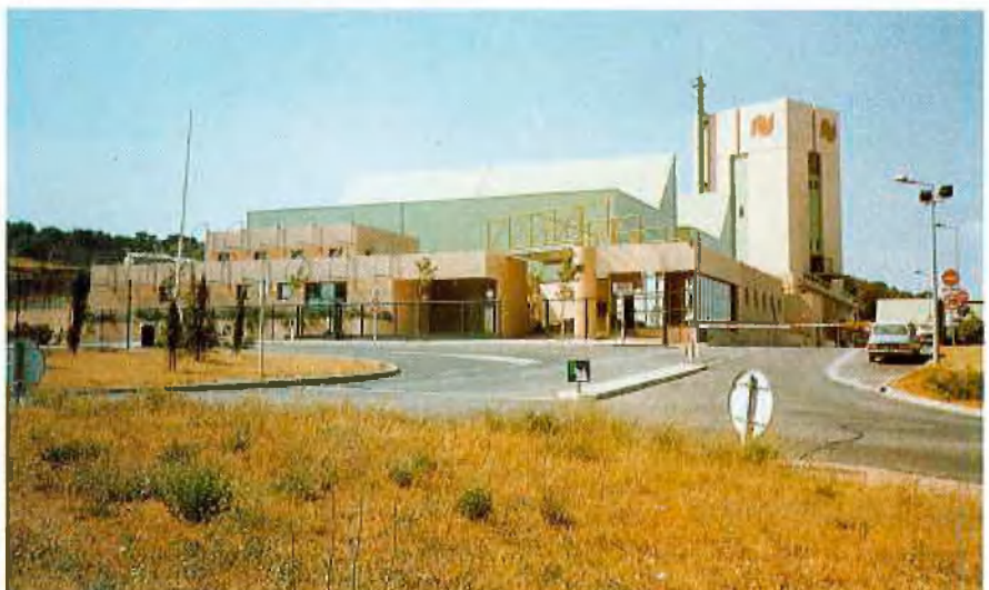
Modernes Grubengebäude am Schacht Gardanne
