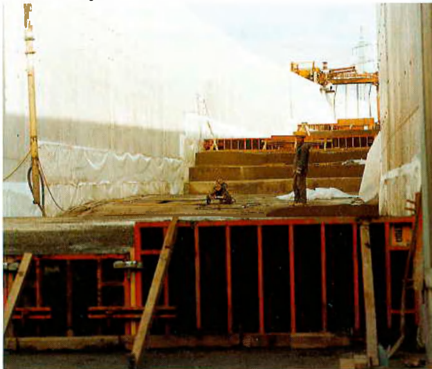
Schalung für das gleichzeitige Betonieren der Trogwände Auffüllen des Troges
