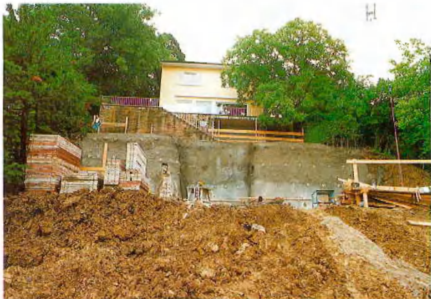
Bodenvernagelung zur Böschungssicherung Bodenvernagelung zur Baugrubensicherung
