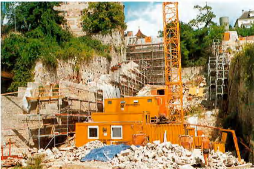
Schiedgraben während der Sanierungsarbeiten
