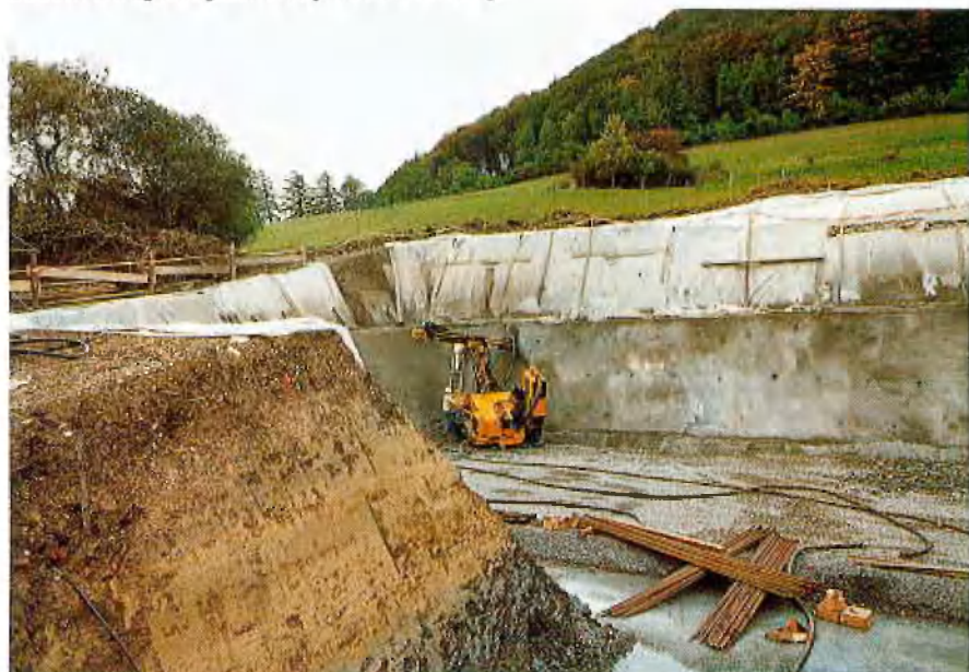
Bodenvernagelung zur Böschungssicherung Bodenvernagelung zur Baugrubensicherung
