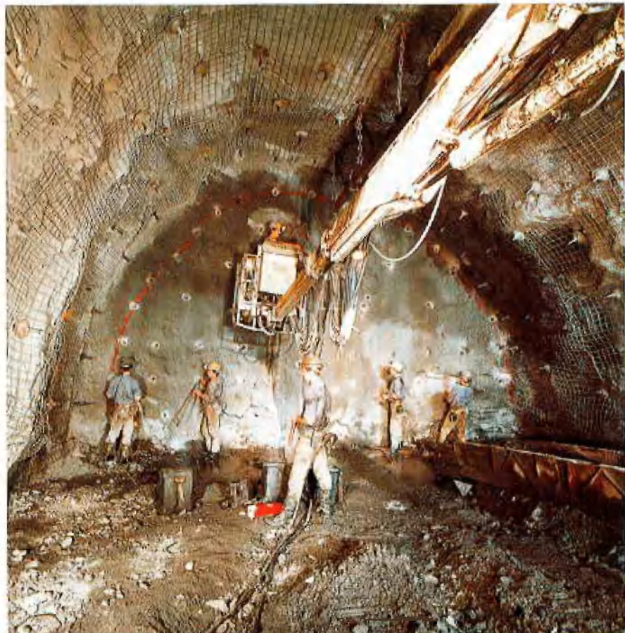
Abb. 2: Besetzen der Bohrlöcher
