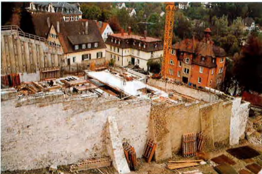
Fertig sanierte Grabenmauer mit Tiefgaragenneubau
