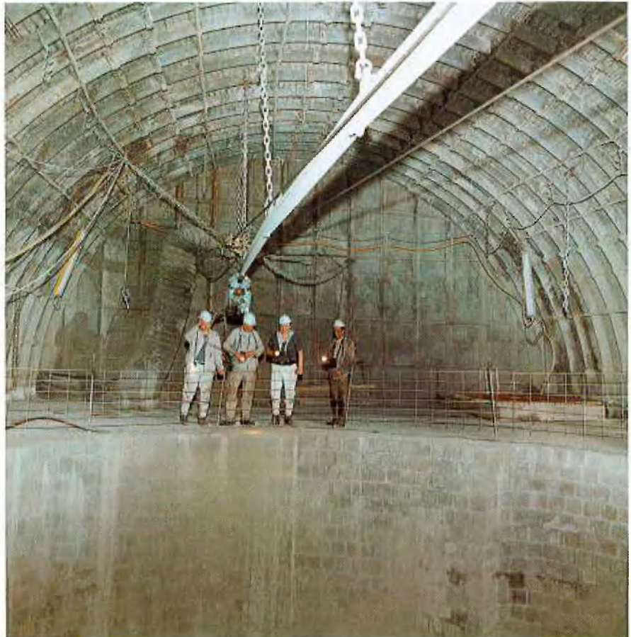
Rohkohlenbunker General Blumenthal-Halter 1/2 Streckenausbau auf Polsum
