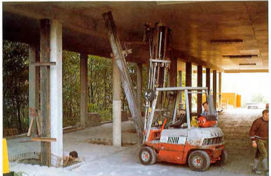
Einsetzen der Fertigteilstütze
