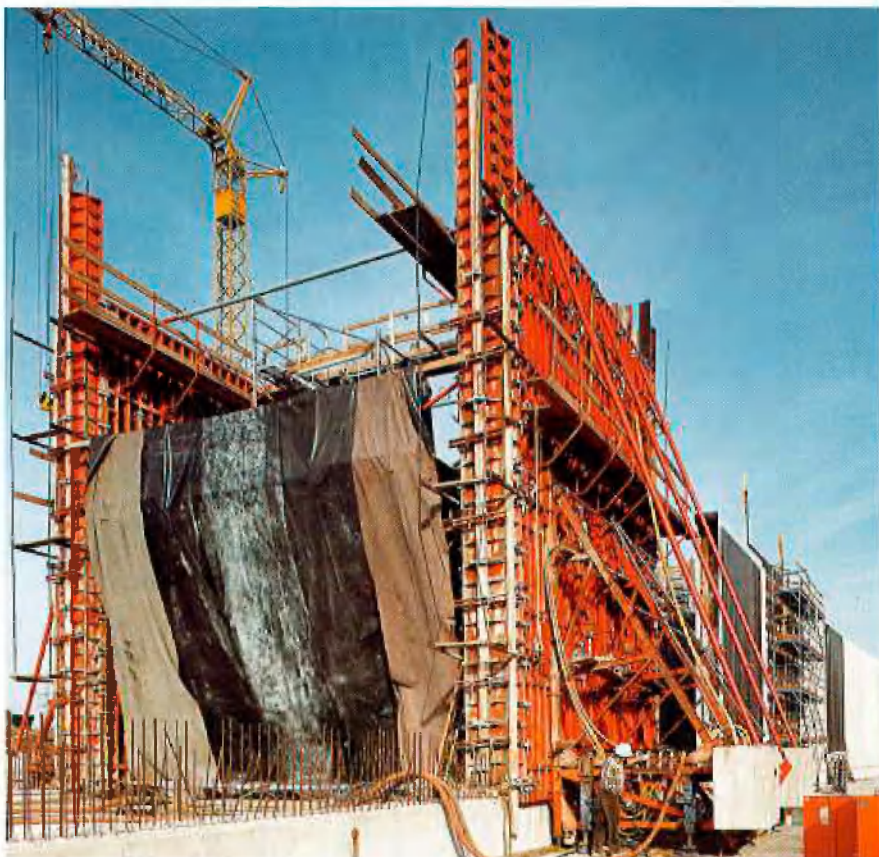
Schalung für das gleichzeitige Betonieren der Trogwände Auffüllen des Troges
