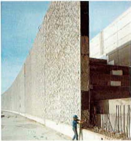
Strukturierte Trog-Außenwand
