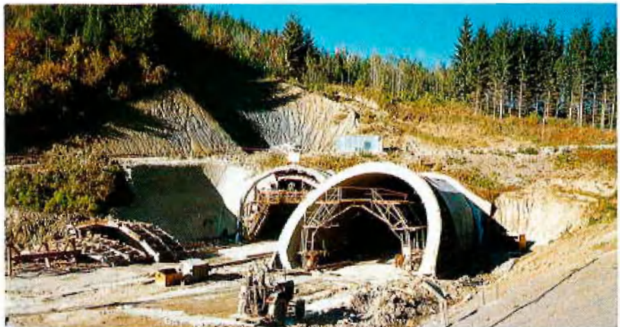
Südportal des Haberbergtunnels
