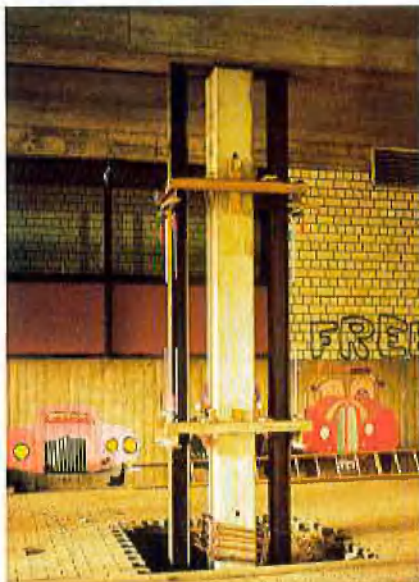
Fertigteilstütze mit Notstützen
