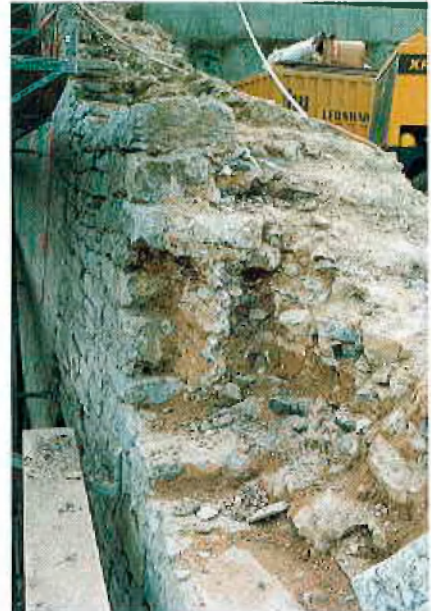
Abgebrochene Mauerwerkskronen
