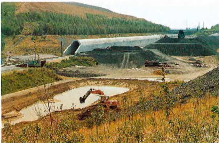
Die drei Phasen „Anschütten, Übererden und Bekrauten“
