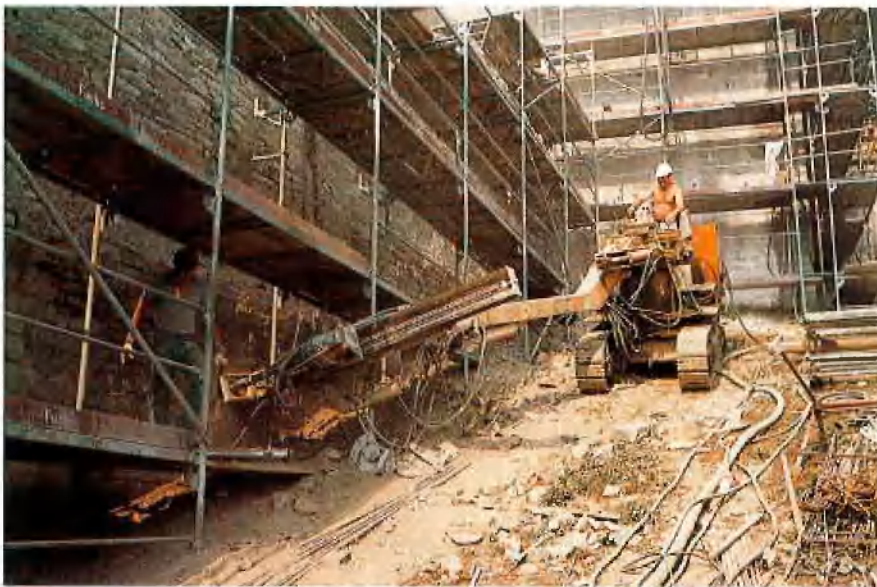
Bohrwagen zur Herstellung der Bohrungen für die Bodennägel
