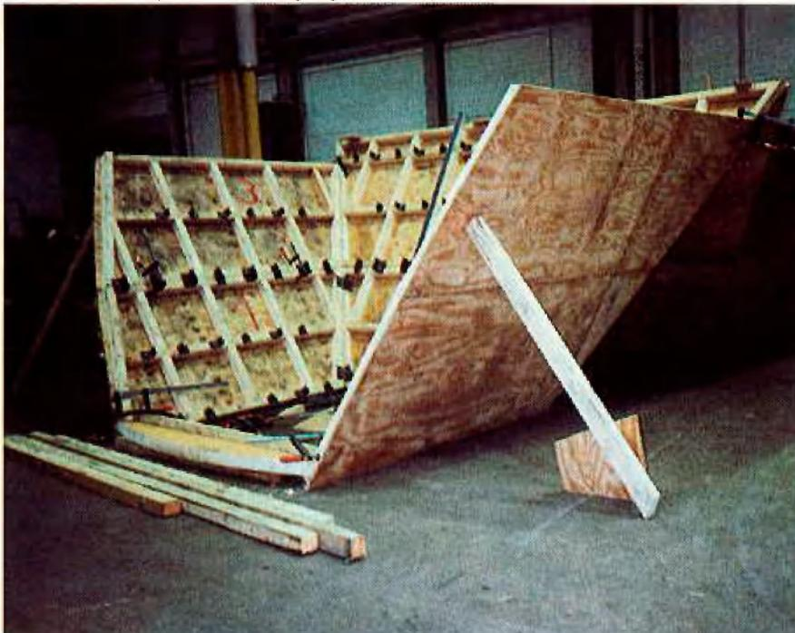
Abb. 7: Vormontage der Schalung für den Bunkerauslauf
