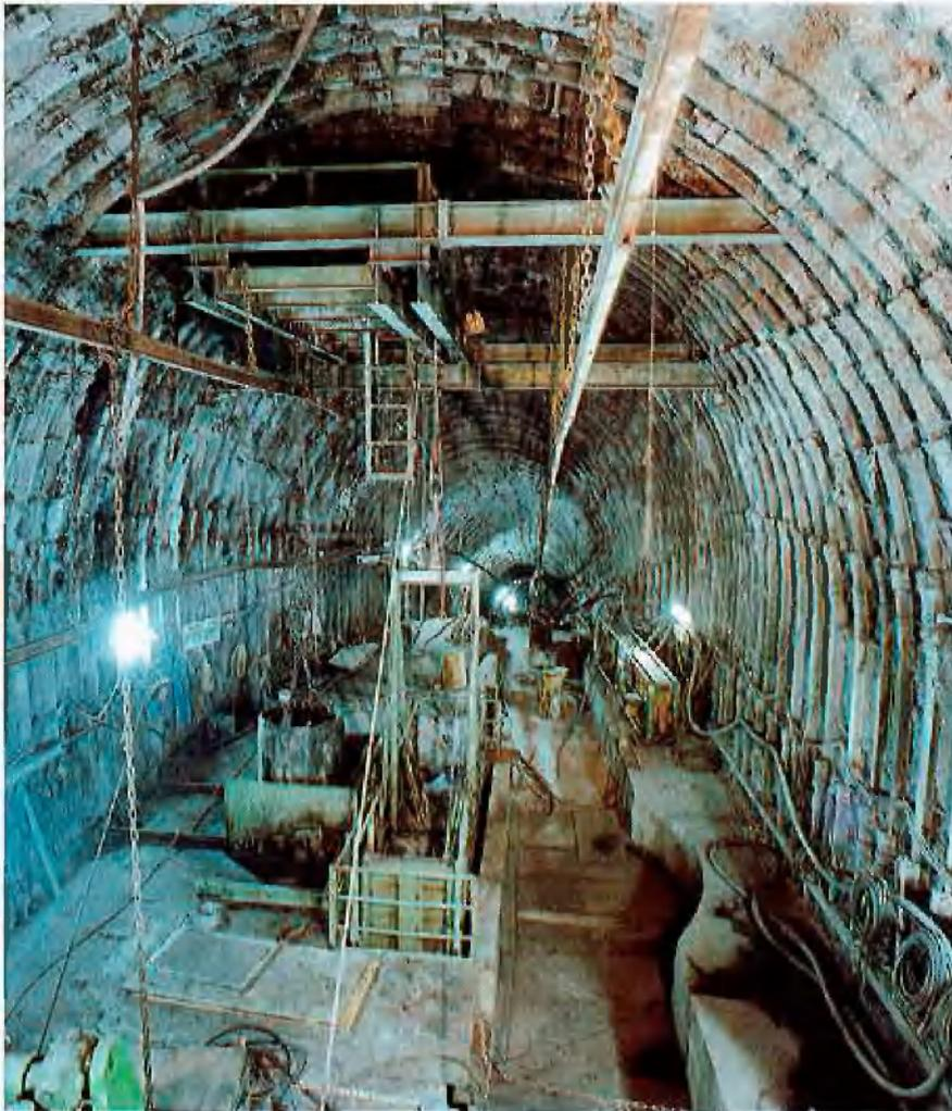
Abb. 5: Bunkerkopf nach Beendigung der Teufarbeiten
