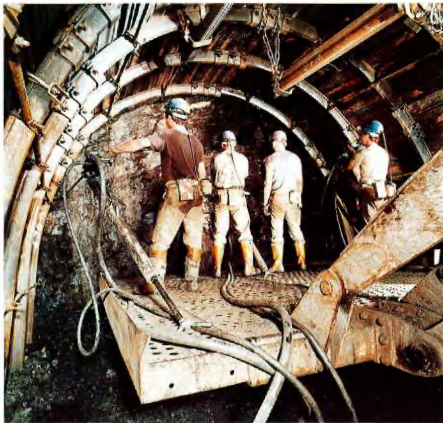
Abb. 11: Bohrarbeit im Flözberg
