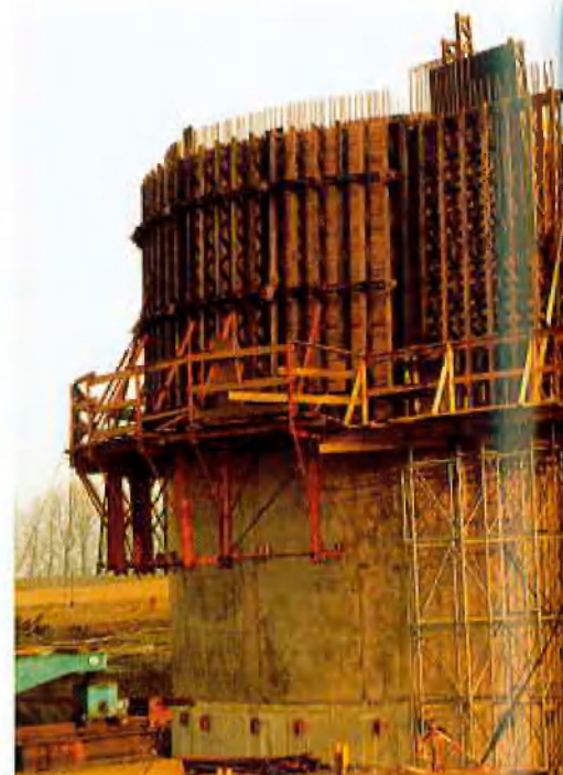
Abb. 3: Senkschachtmontage
