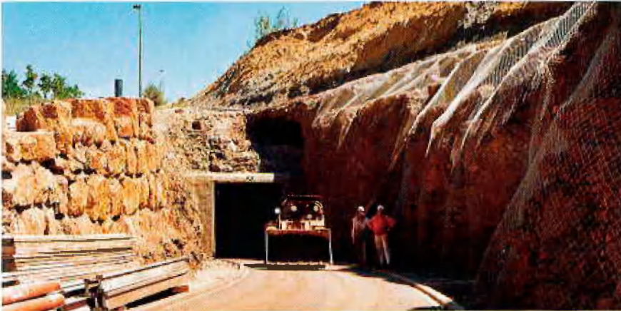
Abb. 3: Rampe mit Portal
