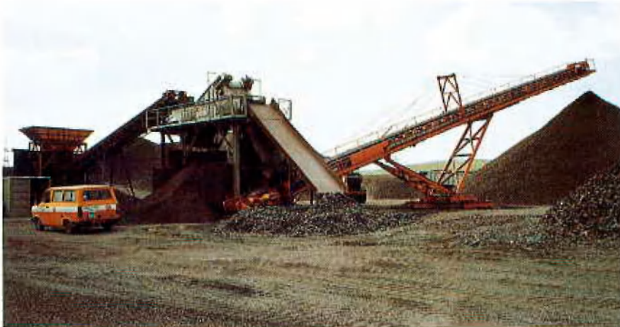
Siebanlage zur Aufbereitung des Polstermaterials
