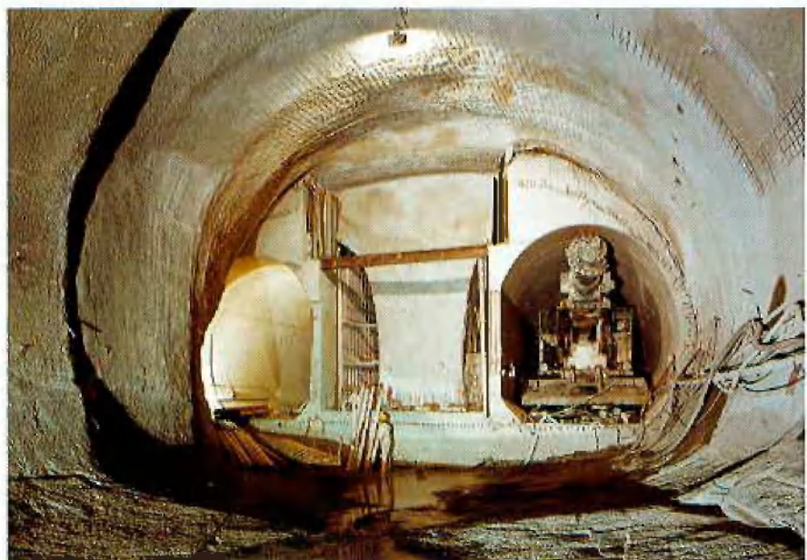
Erweiterung der Einzelröhren auf 130 m 2 Querschnitt
