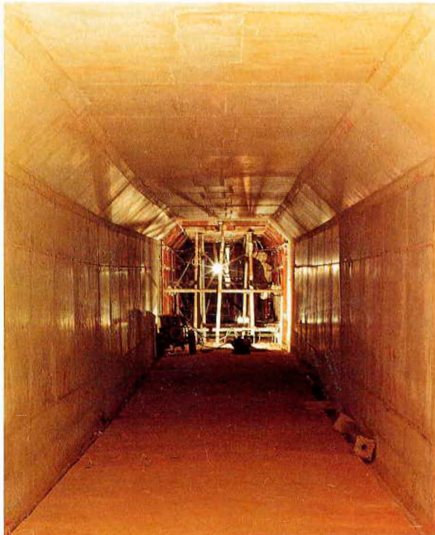
Abb. 5: Umsetzschalung im Sickerwassertunnel
