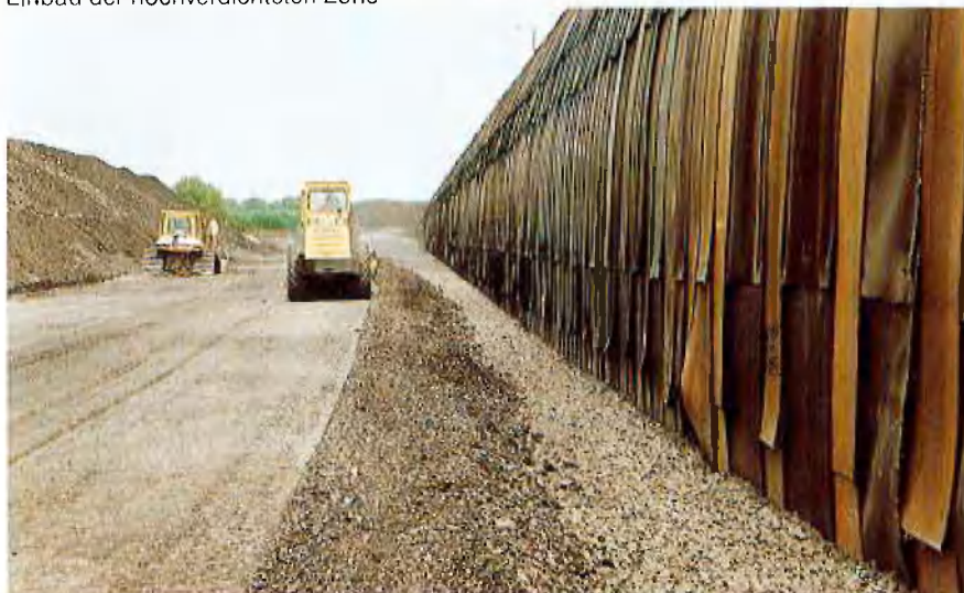
Tunnel in der Einschüttphase
