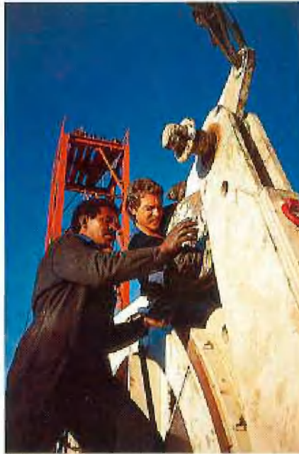
Montage der Fördermaschine
