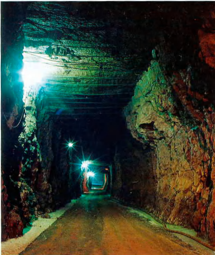
Abb. 4: Firstsicherung
