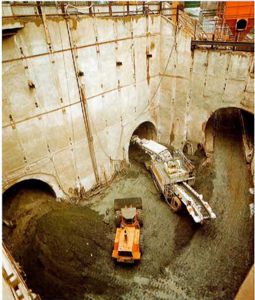
Gegenvortrieb von der Möllerbrücke aus
