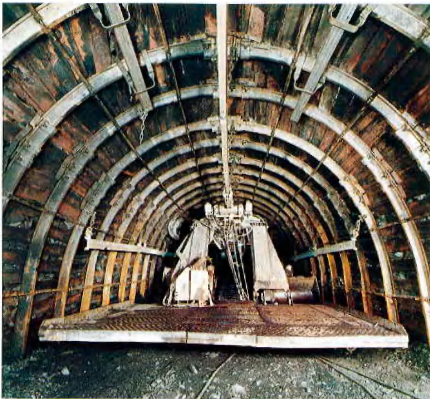
Abb. 3: Hydraulische Arbeitsbühne DH 5011-AB im Flözberg
