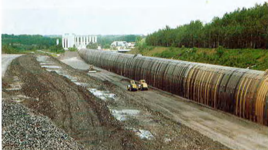
Einbau der hochverdichteten Zone
