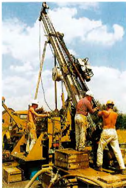
Mobile Bohranlage auf einem LKW
