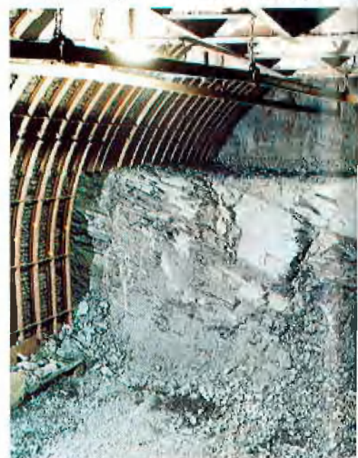
Auffahren der Phase II
