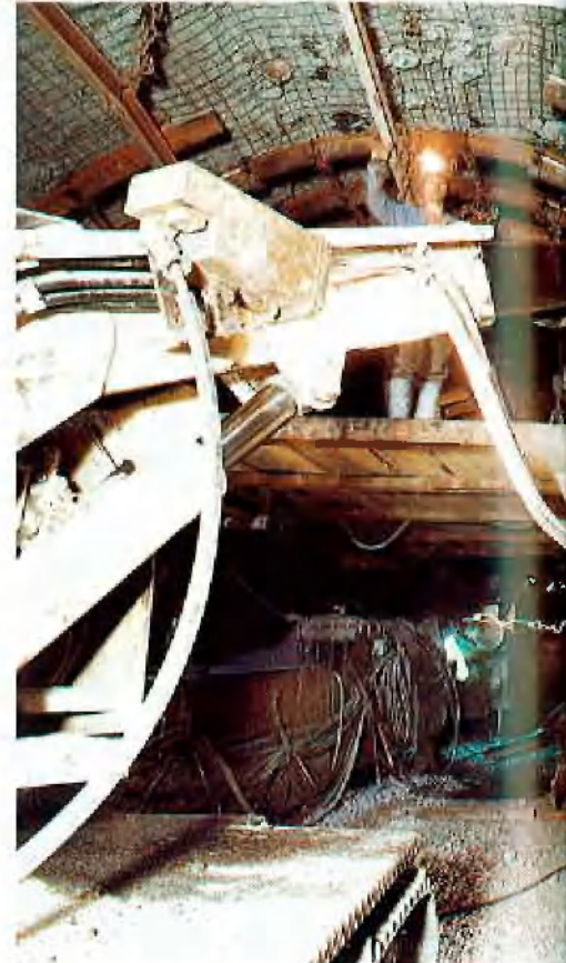
Einrichten des Seitenkappensegmentes
