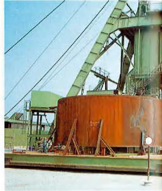
Verbinden der Halbschalen am Schacht
