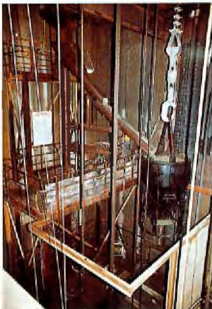
Füllen des Betonkübels
