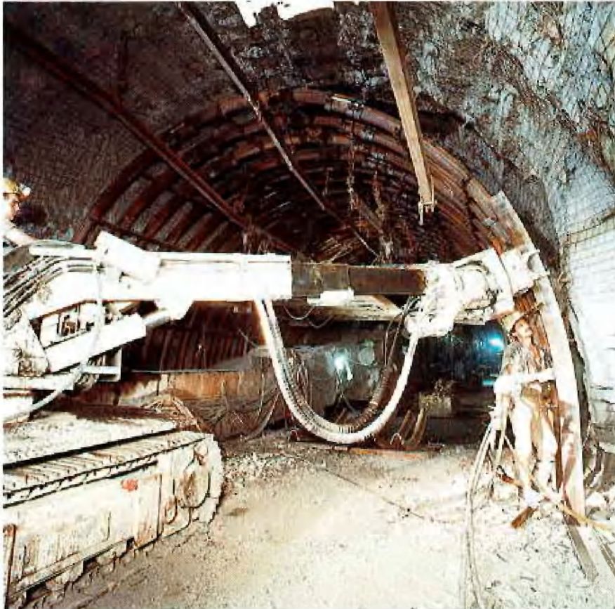
DH-Ausbaumanipulator beim Stellen eines Stempels
