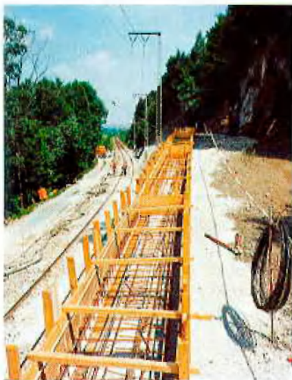
Herstellung der Wandabschlußriegel
