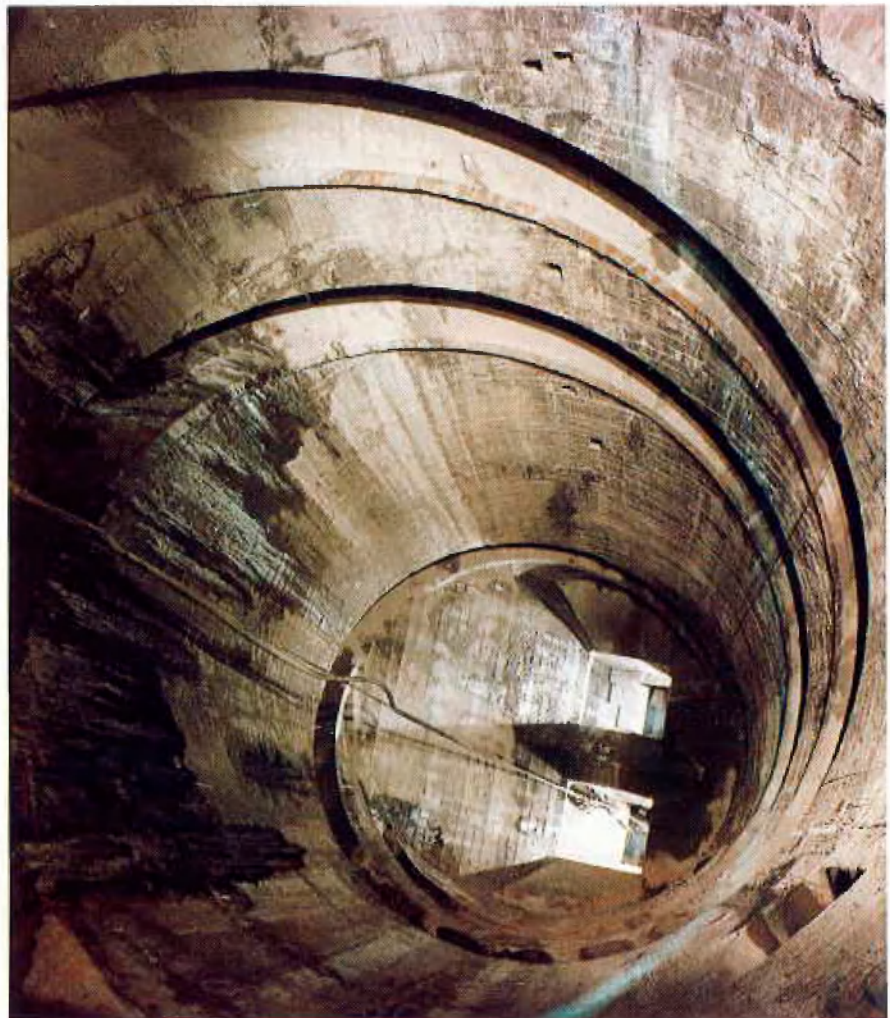
Abb. 2: Bunker nach der Fertigstellung
