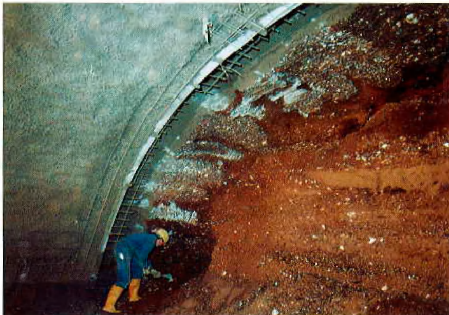
Angeschnittene Jetpfähle an der Ortsbrust
