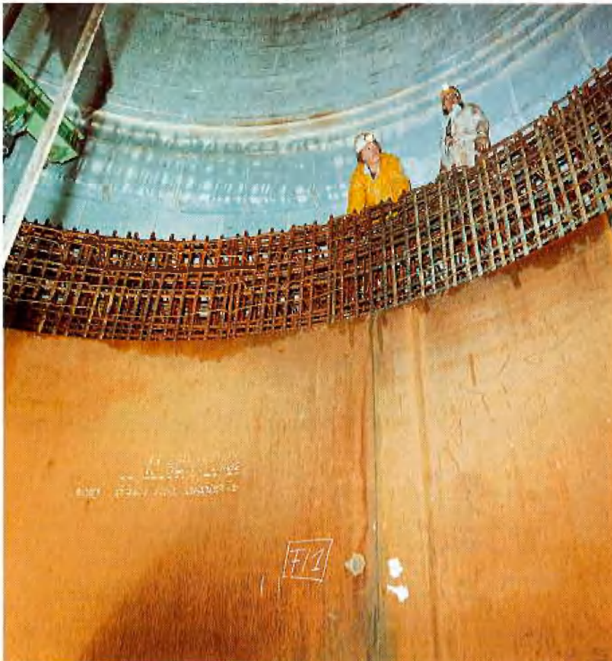
Der Stahlinnenmantel dient auch als Betonierschalung
