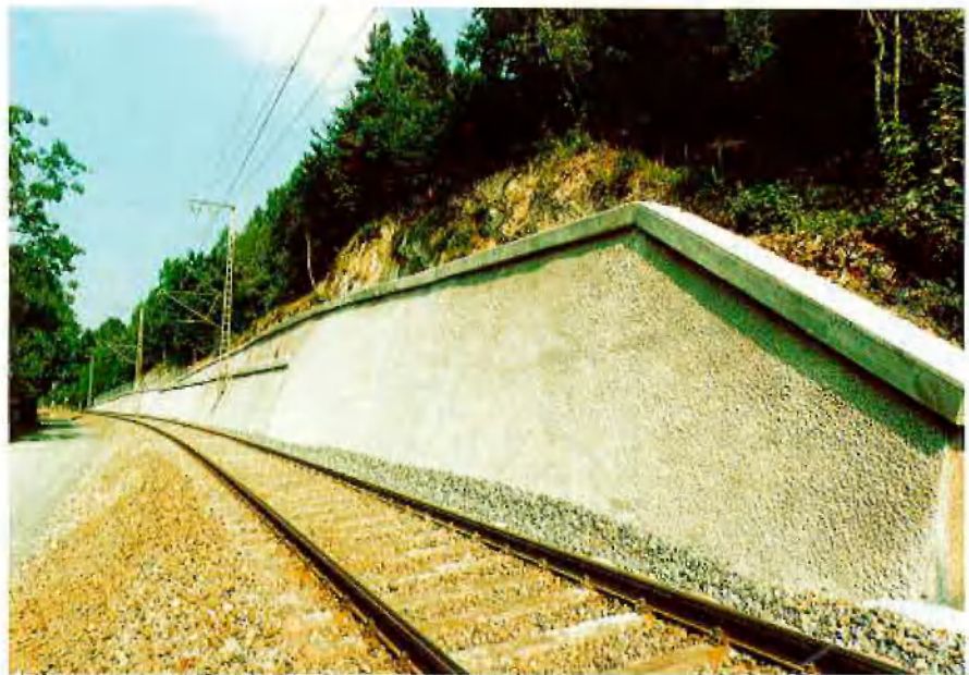
Stützwand nach der Sanierung
