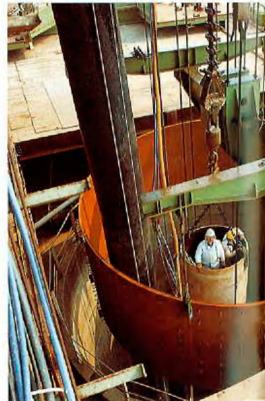
Transport der Stahlringe im Schacht
