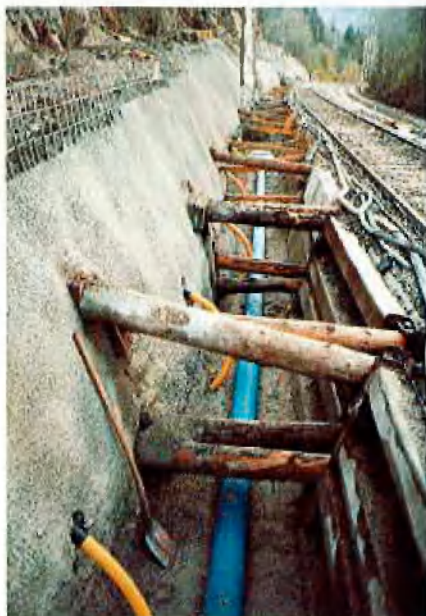
Rohrgraben mit Entwässerungsleitung
