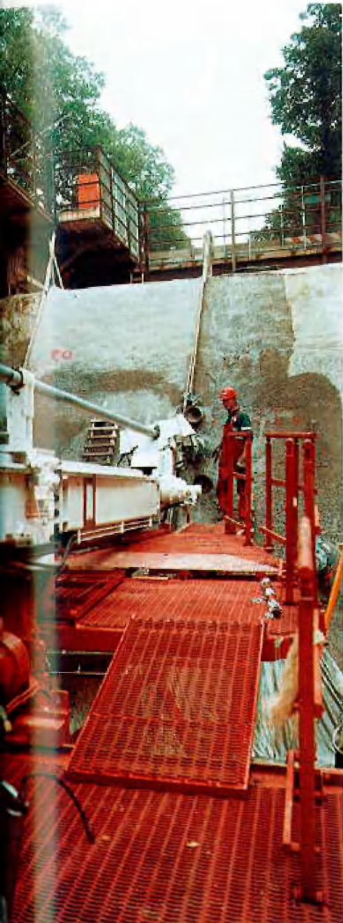
des zweiten Tunnelabschnitts
