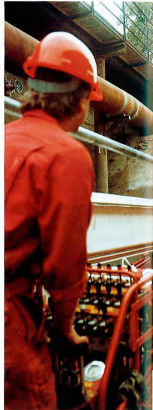
Bohrversuche der Rodio-Anlage am südlichen Por
