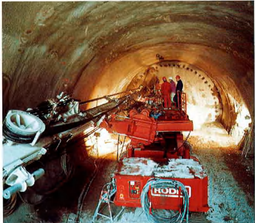
Setzen der Jetpfähle
