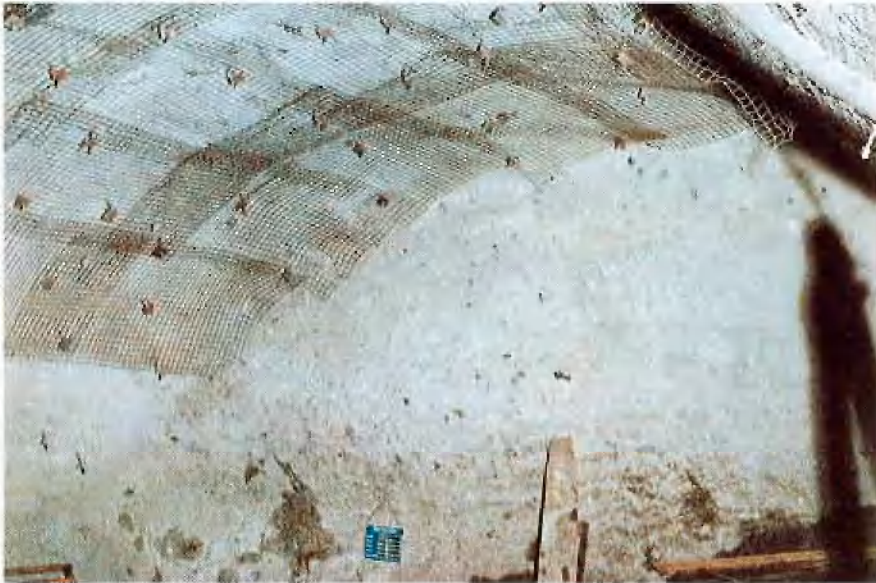
Anker-Spritzbeton-Ausbau
