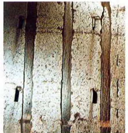
Abb. 11: Detail des neuen Verschleißbelages
