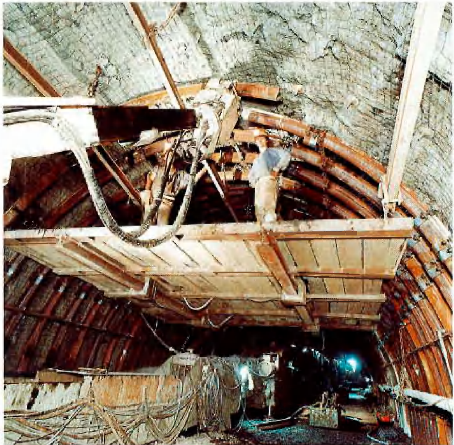
Einrichten des Mittelkappensegmentes
