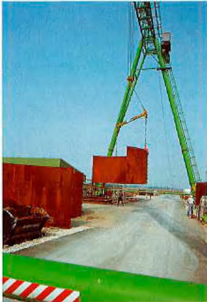
Ausbau - Halbschale am Kran
