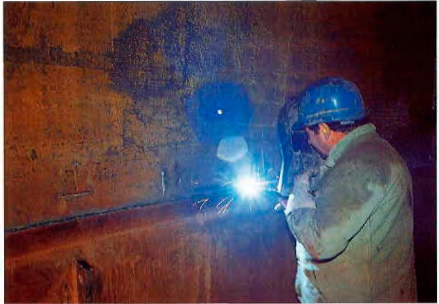
Verschweißen der Horizontnähte
