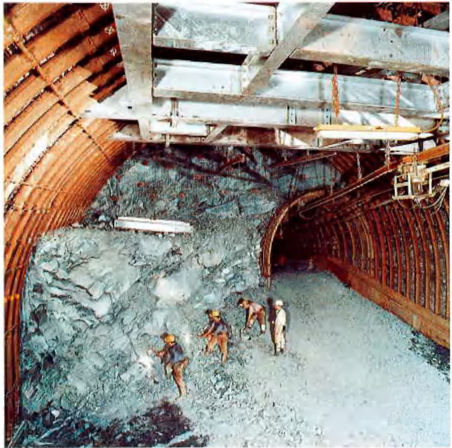
Auffahren der Phase III
