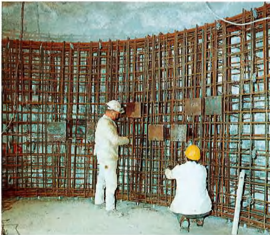
Einbau der Bewehrung
