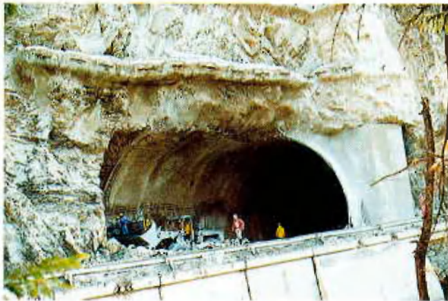
Tunnel Hochf nstermünz
