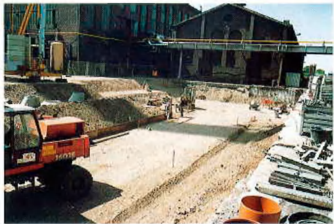
Schaltheus für die Schachtanlage Hugo
