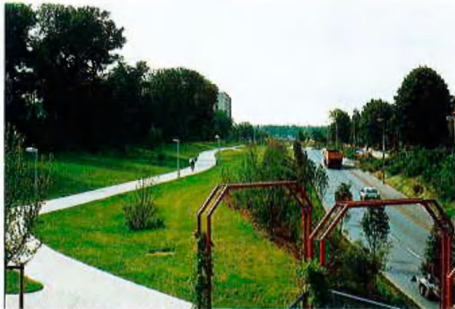
Neugestaltete Oberfläche Tunnel B236n
