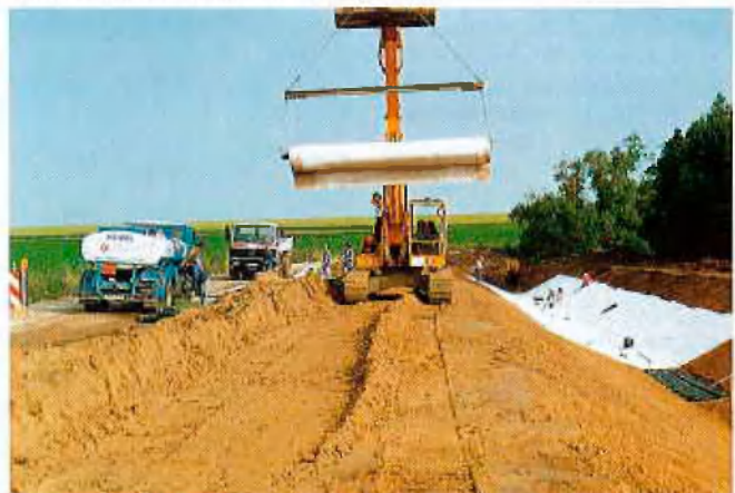
Rückbau des Floßgrabens
