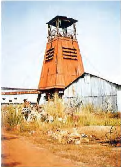
Abteufgerüst russischer Bauart
