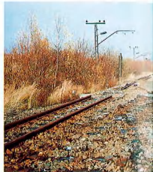
Rückbau der Erzbahntrasse
