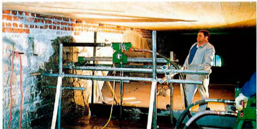
Spannankerbohrung
