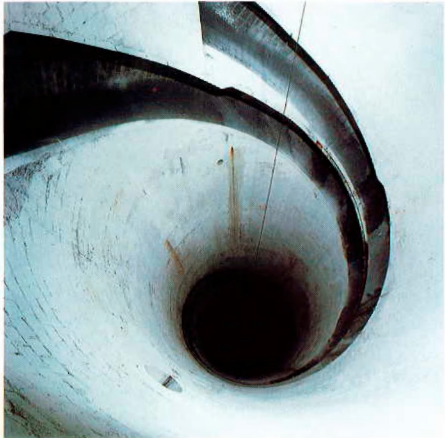
Fertiger Bunker mit zwei Einläuten
