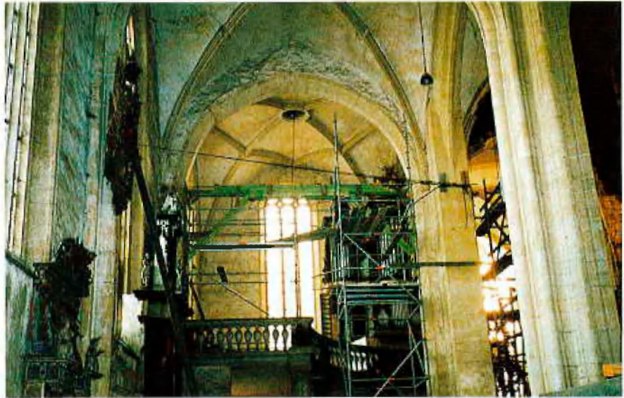
Sicherungsarbeiten im Kirchenschiff
