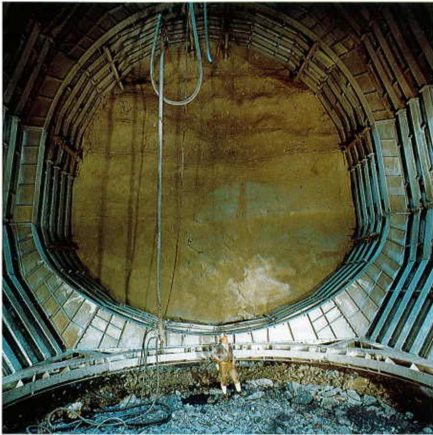
Stahlausbau im Füllort Schacht Radbod 6
