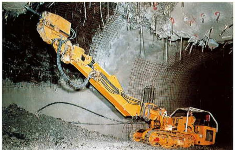
Lader mit Ripperarm bei der Streckensanierung
