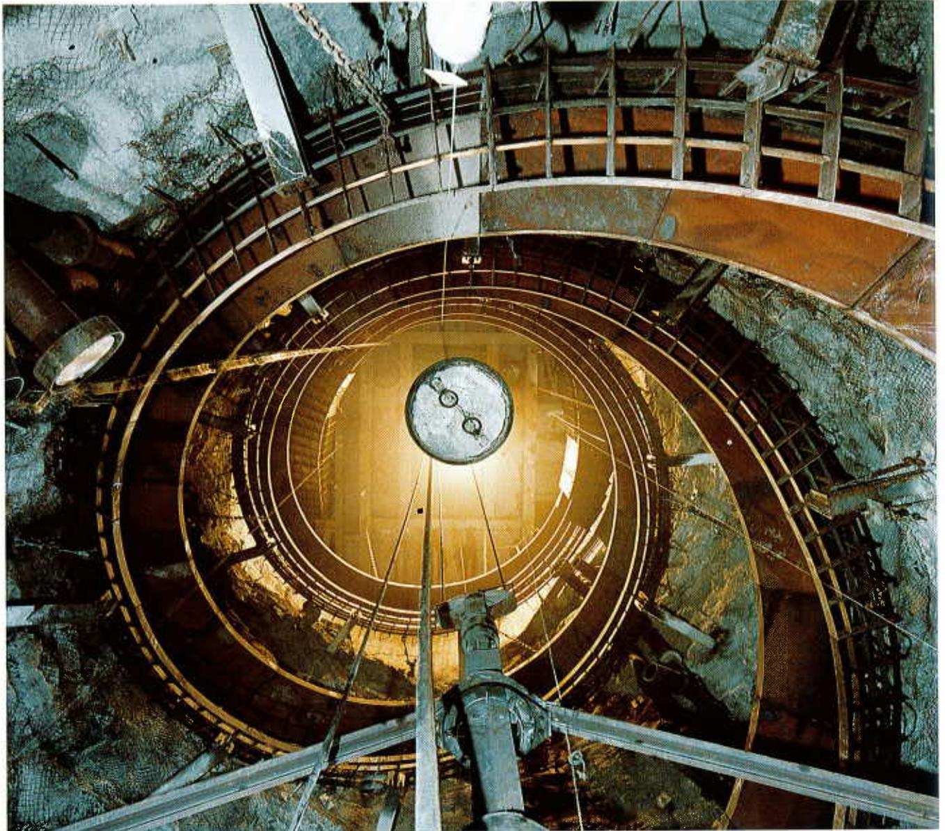
Teufen eines Bunkers – mitgeführte Stahlwendel im vorläufigen Ausbau
