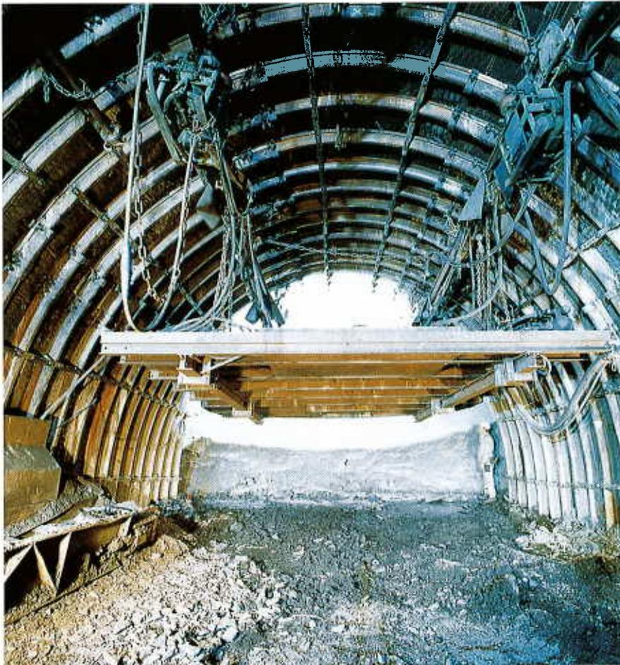
Bohr- und Arbeitsbühne in einem Sprengvortrieb
