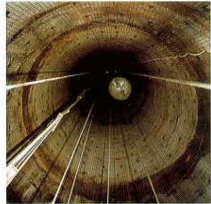
Bohrschacht mit vorläufigem Anker-Maschendraht-Ausbau
