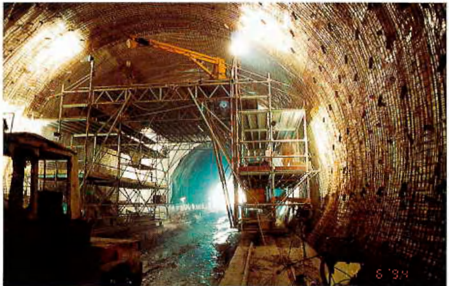
Einbau der Bewehrung
