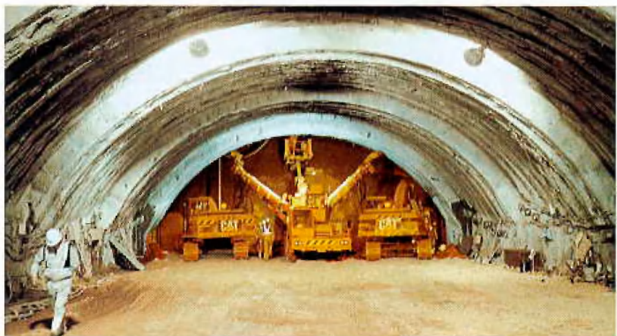
Auffahrung der Kalotte mit Ankerbohrwagen, Schräg- und Ladebagger
