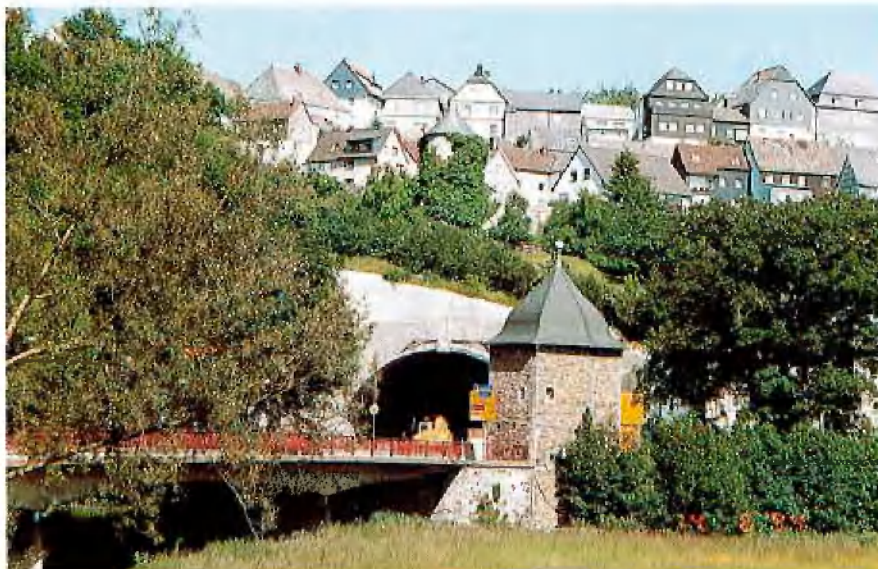
Tunnel unter der Altstadt
