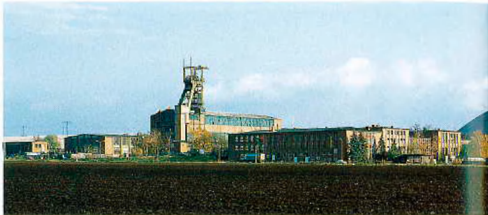
Tagesanlagen des Schachtes Niederröblingen
