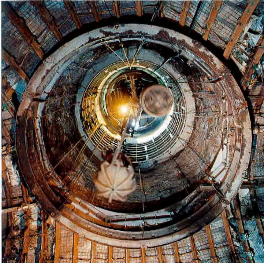
Schalung und Ausbau
