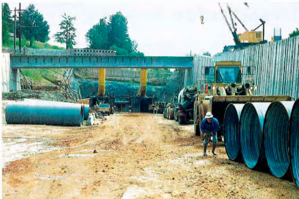
Straßenbahntunnel in Portland - Westportal
