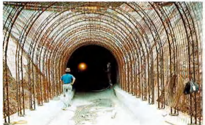
Brettfalltunnel - Fluchtstollen in offener Bauweise
