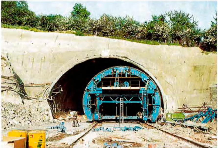
Schalwagen im aufgeweiteten Tunnelportal
