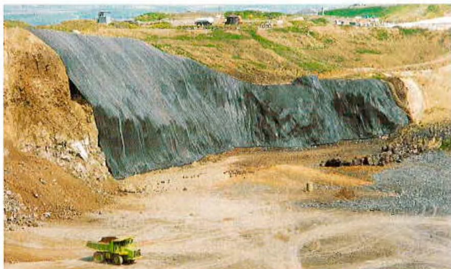
Fertiggestellte Böschungssicherung Lavasporn
