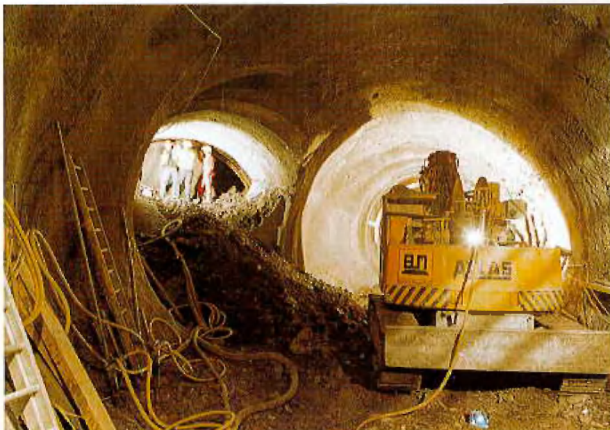
Ausbrucharbeiten mit dem Bagger
