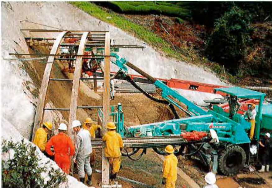
Sicherungsmaßnahmen am Tunneleingang
