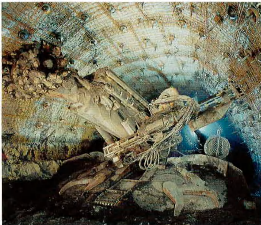
AM 85 mit Ankerbohr- und Setzeinrichtung
