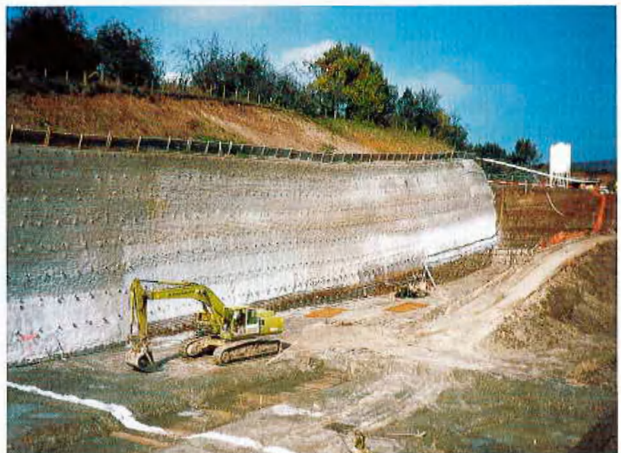
Mit Erdnägeln rückverankerte Wand
