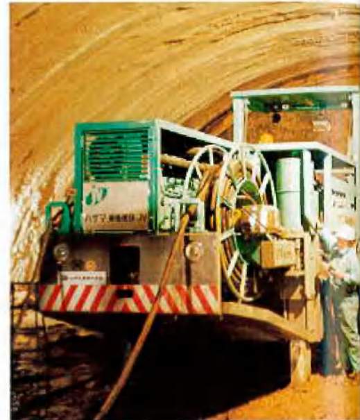
Bohren der 6 m langen Ankerlöcher im Stoß
