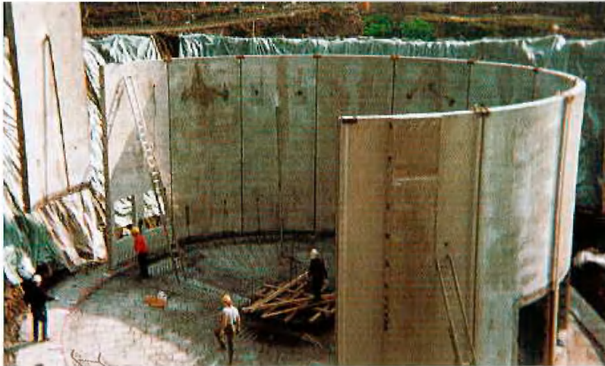
Einbau der Spannbetonelemente
