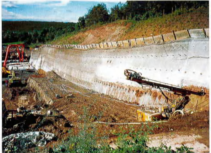
Bohrgerät mit 7,5 m langer Lafette
