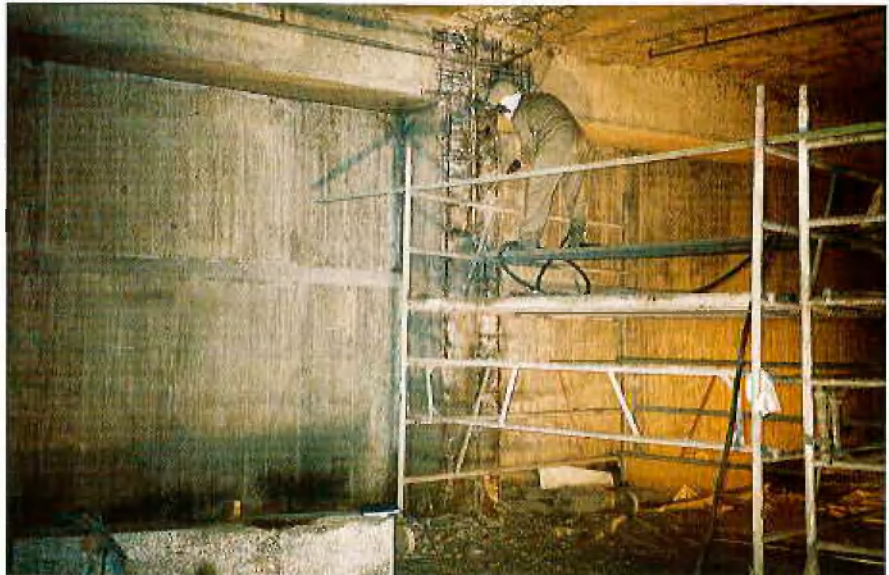
Sanierung einer Stütze
