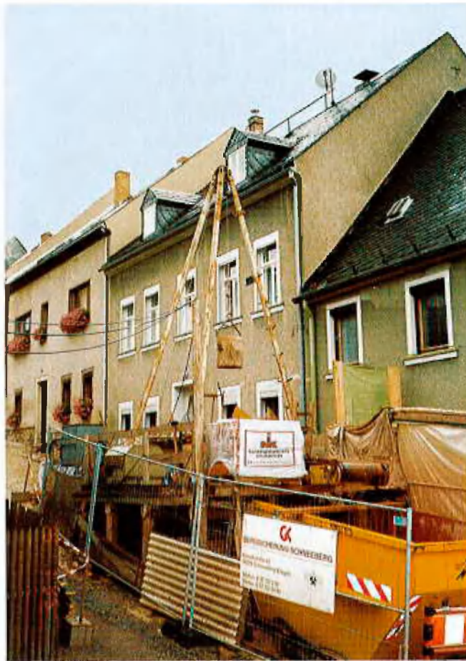
Gebäudesicherung in Schneeberg
