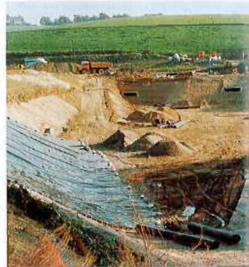
Folienverlegung auf dem Schutzvlies
