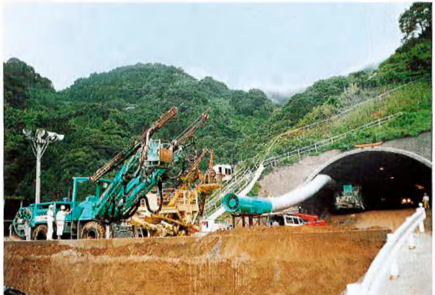
Wartung des Bohrwagens vor dem Tunnel
