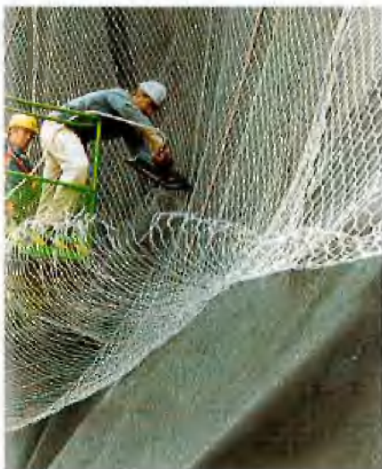
Takkern der Bahnenstöße
