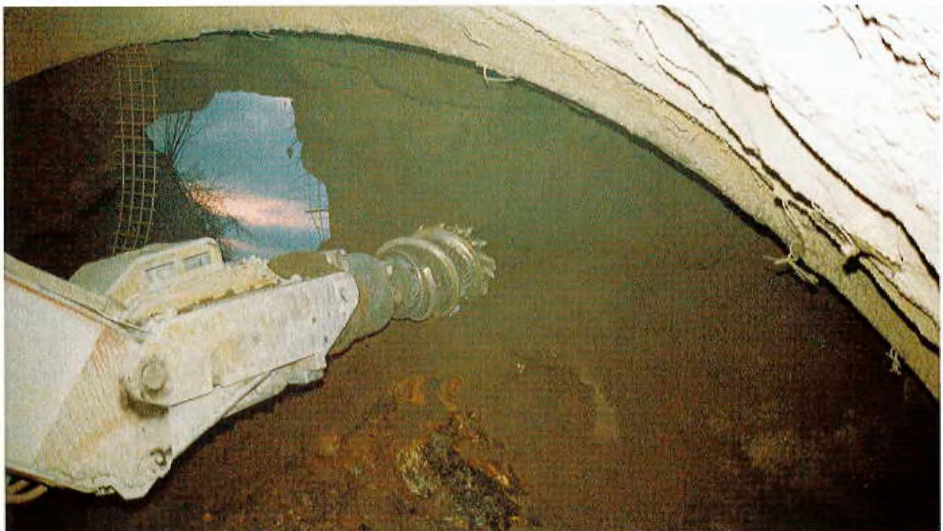
Durchschlag Terndorfer Tunnel
