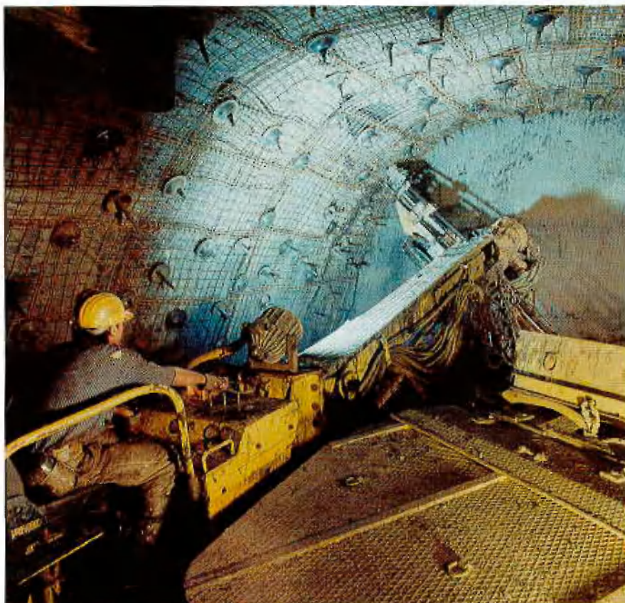
Auf der AM 85 montierte Ankerbohr- und Setzeinrichtung
