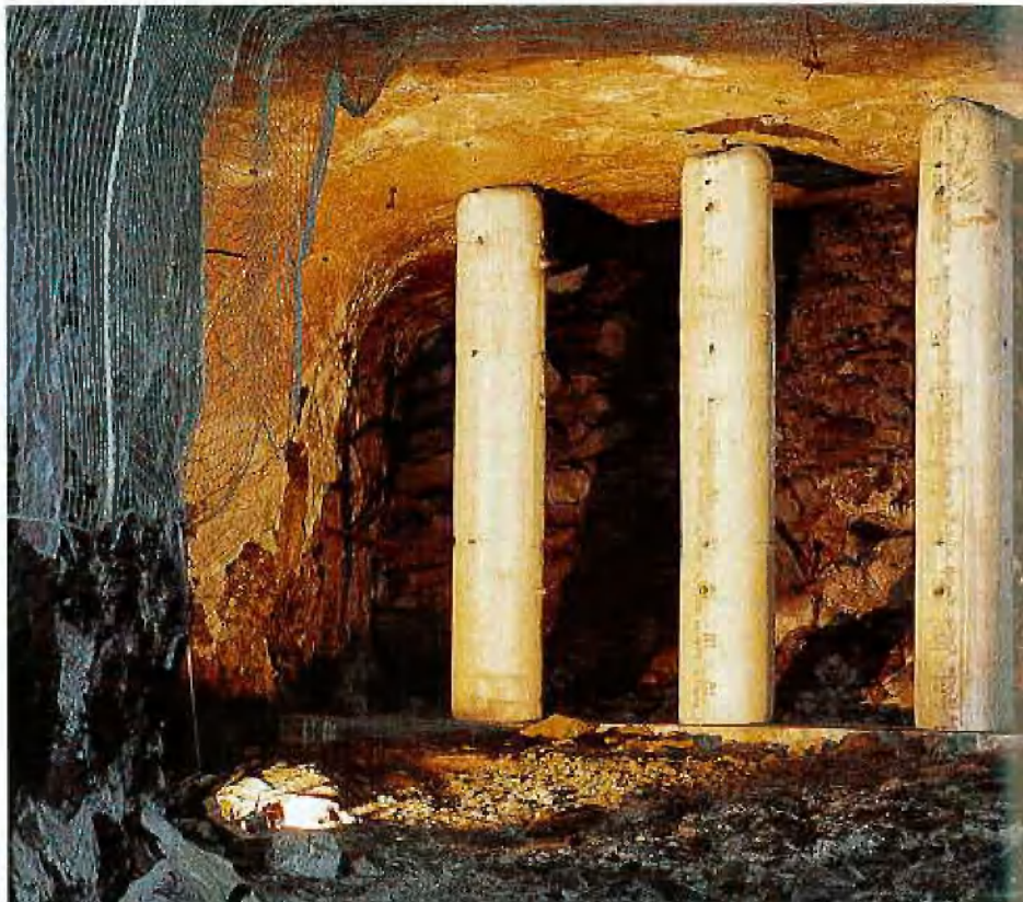
Sicherung der Bruchkante in einem Fahrstollen
