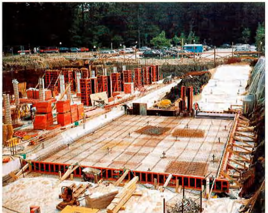
Bewehrung der Stahlbetonbodenplatte des Innenhofes im Untergeschoß
