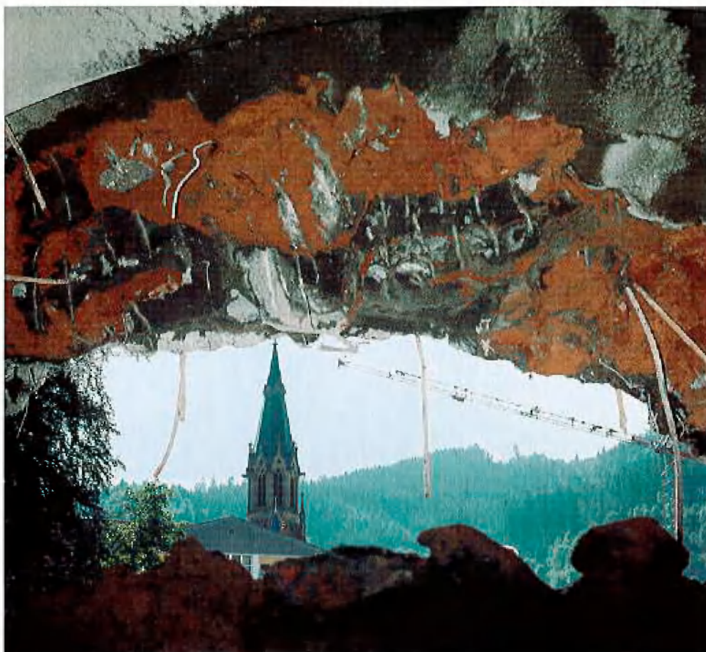
Durchschlag des Entlastungstunnels Wildbad
