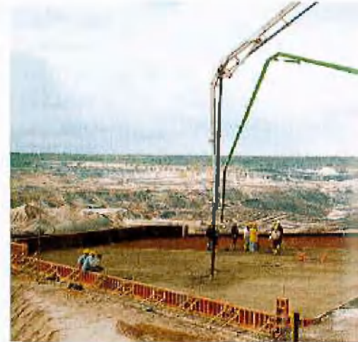
Überdecken der Bewehrungsbänder
