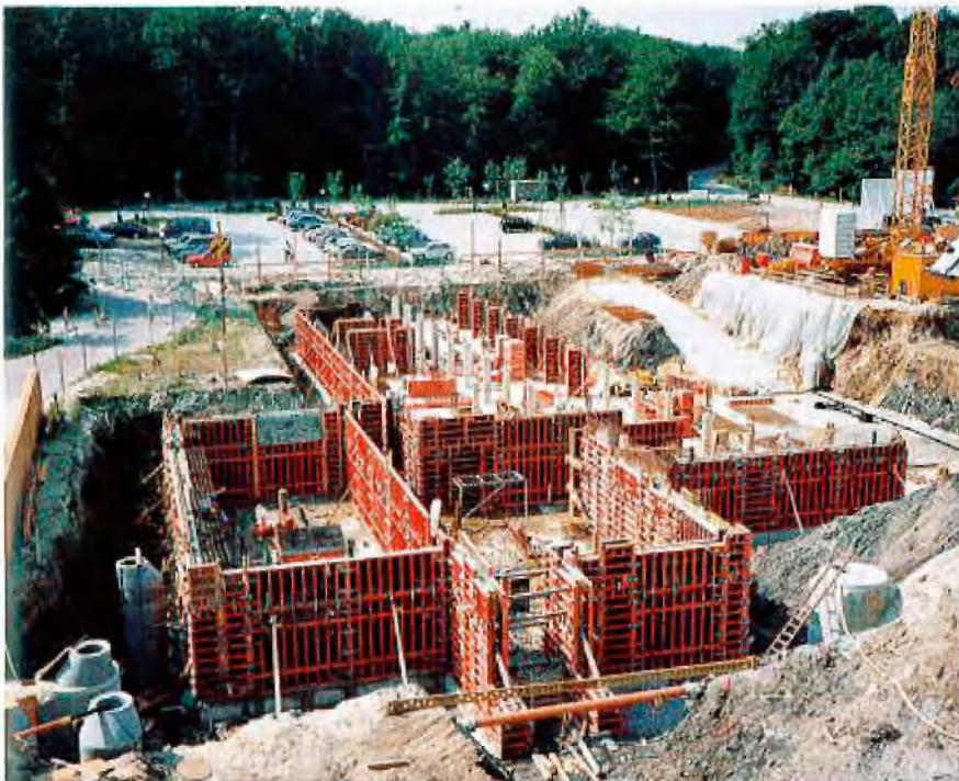
Wand- und Säulenschalung
