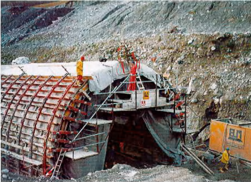
Letzter Regelblock der Offenen Bauweise
