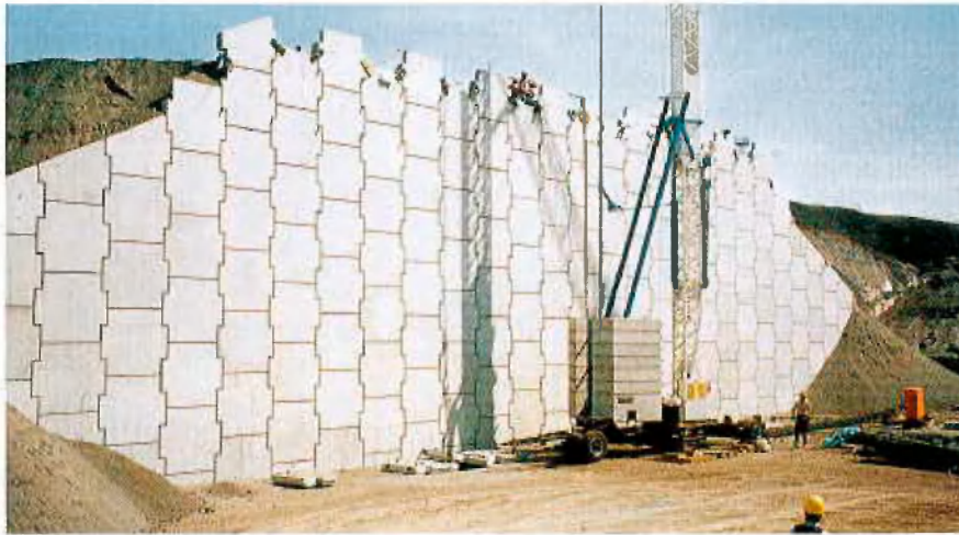
Abtreppungen an den Wandseiten
