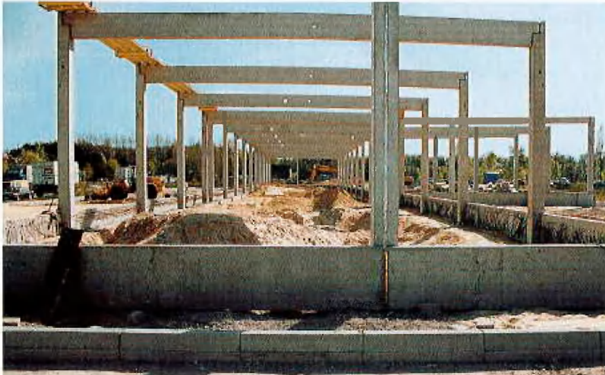
Stahlbeton-Fertigteilkonstruktion Zustellbasis Stelle
