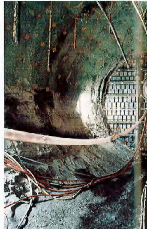
Schalung des Vordammes 1
