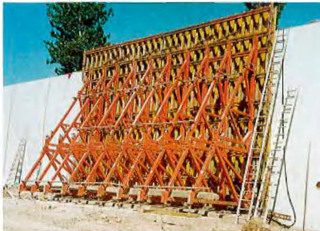
Stützwand-Schalung für die Anbindung der Neuen Messe Leipzig
