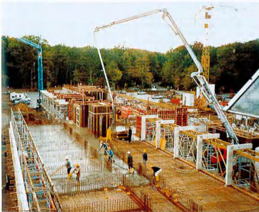
Betonieren der 1. Obergeschoßdecke, rechts Fertigteilstützen für die Balkonplatten
