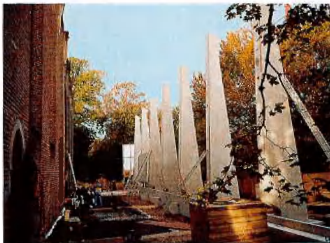
Außenwand-Stützen für die Klosterkapelle Frenswegen
