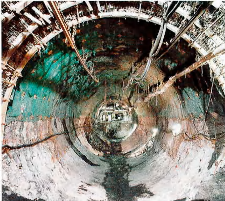
Ausbruch für den Wasserdamm
