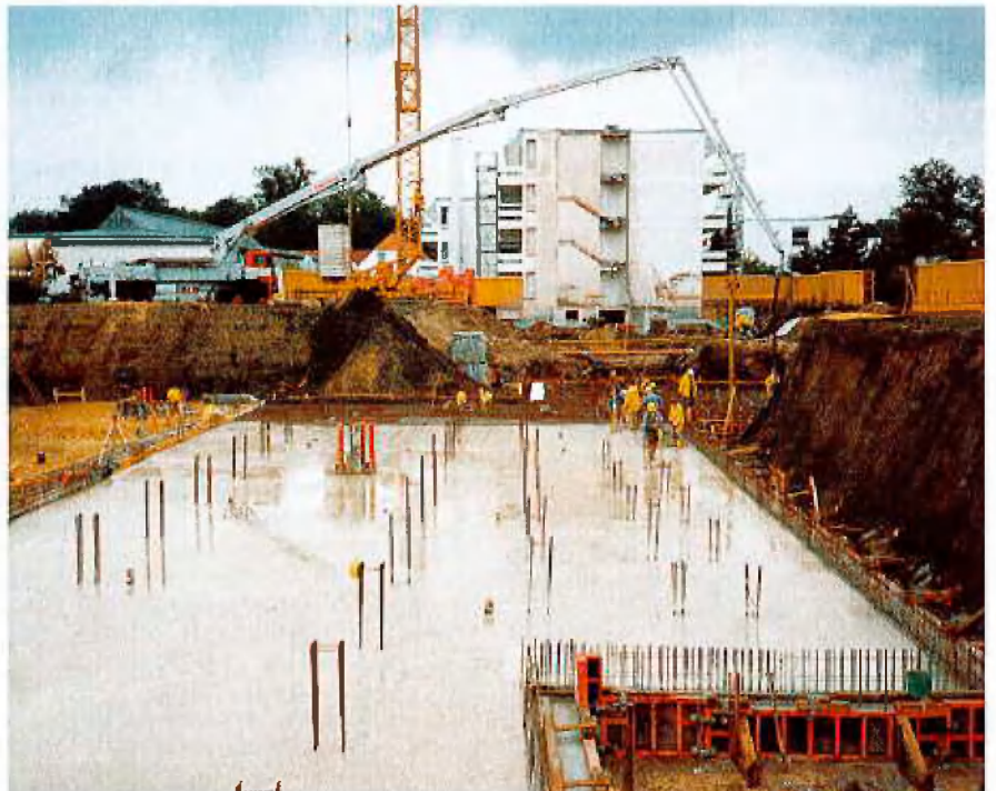
Betonieren des ersten Teilabschnitts der Stahlbetonsohle
