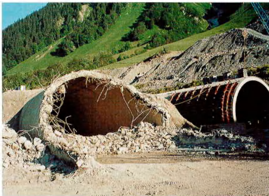
Abtrag des Portalbauwerks des alten Passürtunnels
