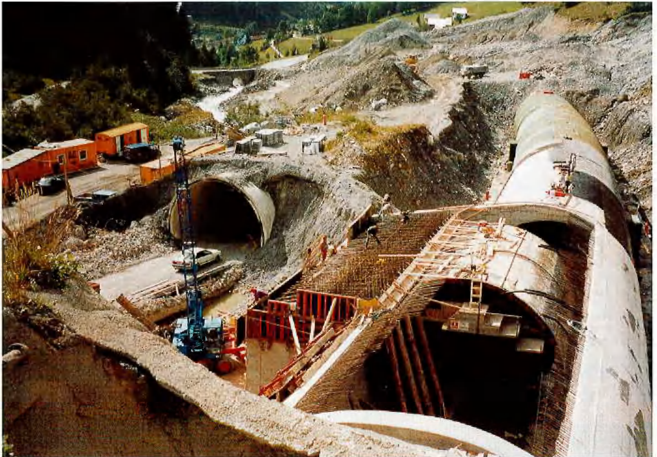
Offene Bauweise: Abstellnische mit integriertem Abzweigbauwerk
