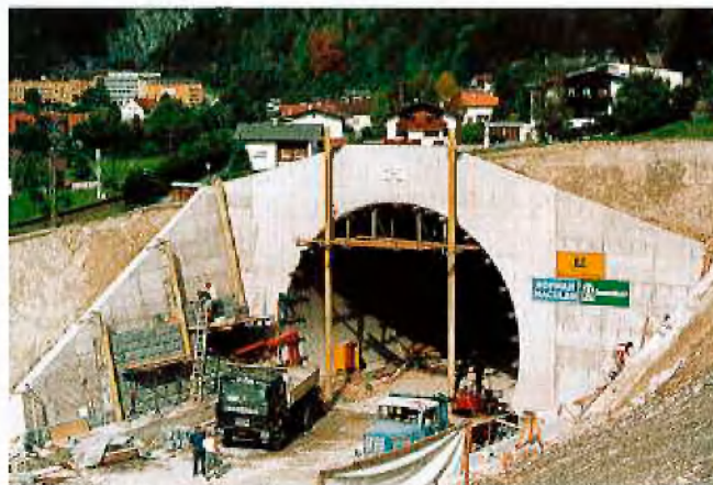
Granitsteinverkleidung am Westportal des Zammertunnels
