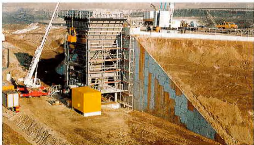
Truck Hopper in der Bauendphase
