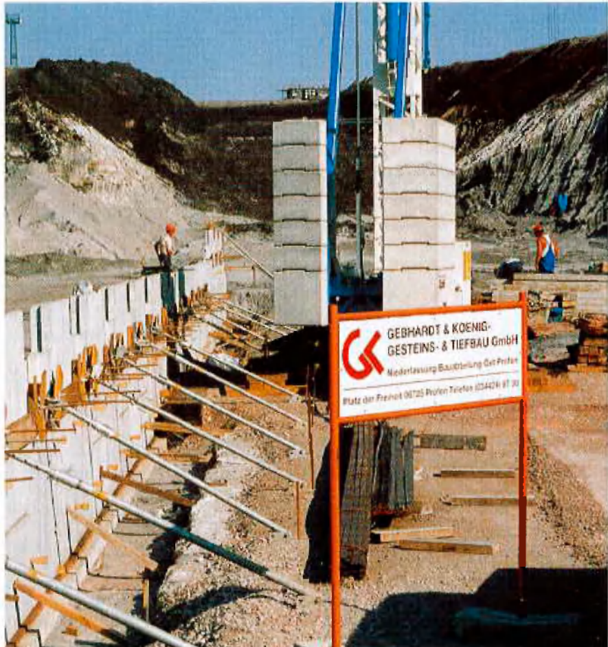
Aufstellen der ersten beiden Plattenreihen mit Stahlstützen
