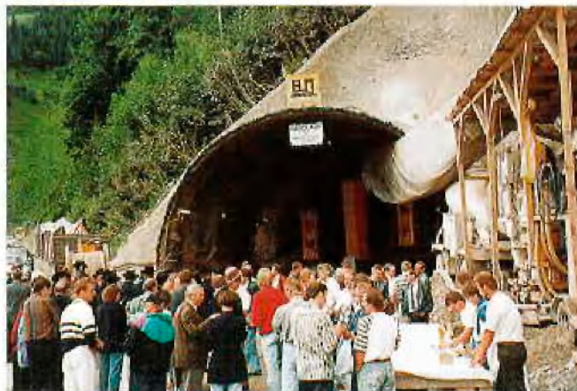
Anschlag des Südportals Stutzobeltunnel
