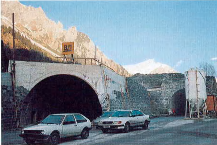
Natursteinmauerwerk zwischen altem und neuem Portal
