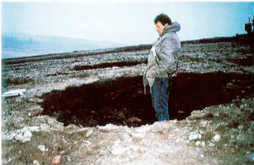
An den Verdichtungspunkten zeigen Senkungstrichter die Effektivität des Verfahrens
