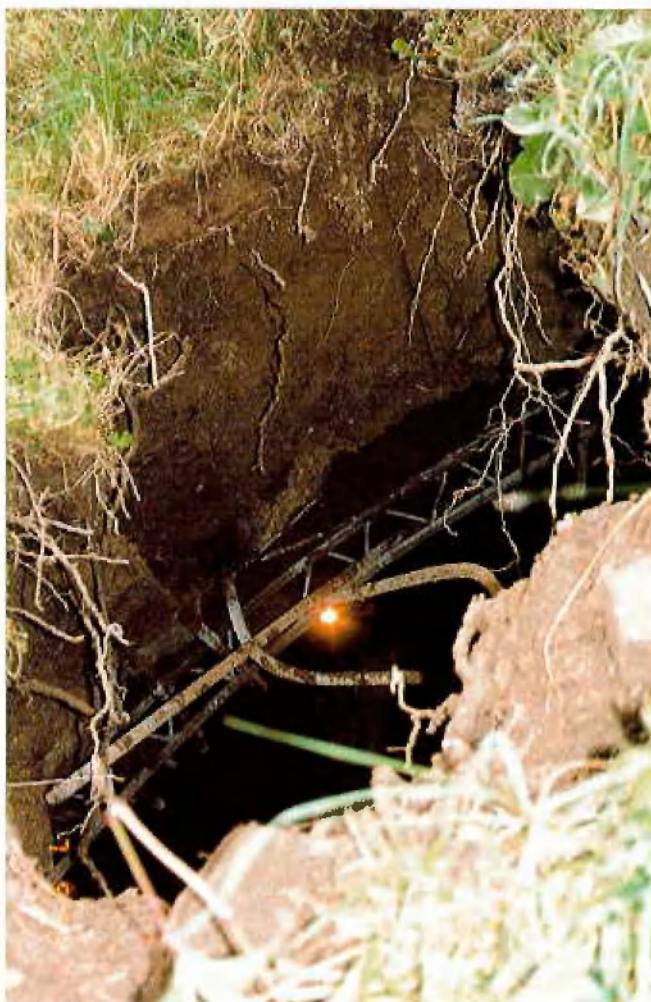
Durchschlag am Ostportal des Ardetzenbergtunnels
