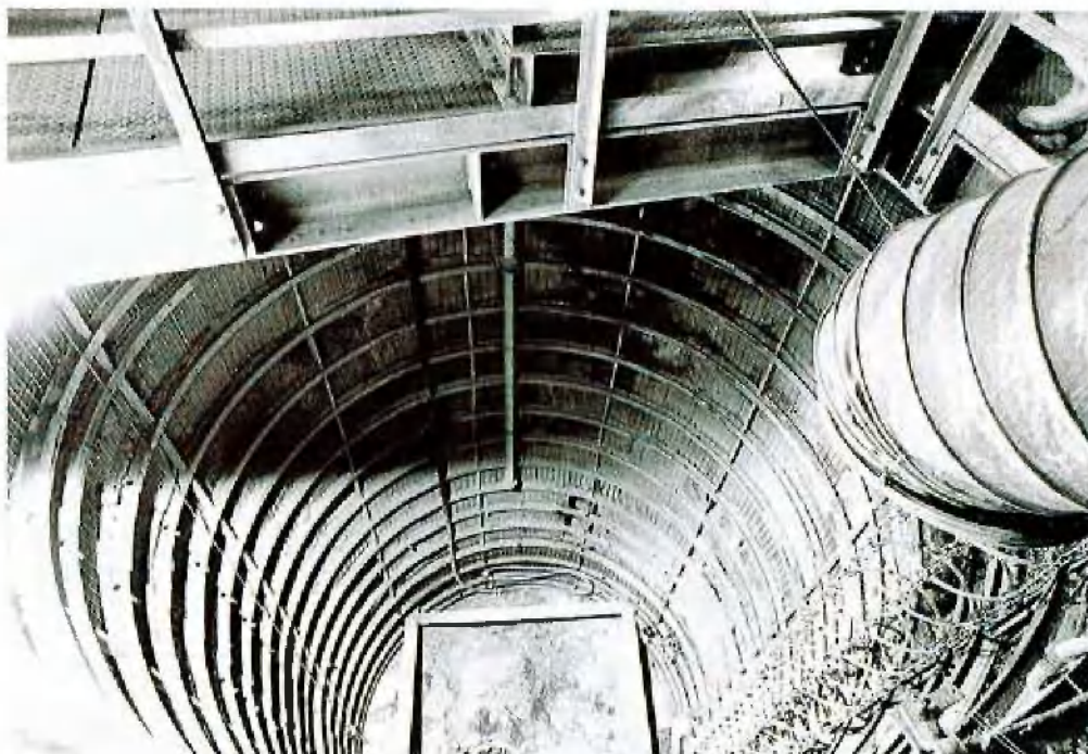
Blindschacht Haus Aden
