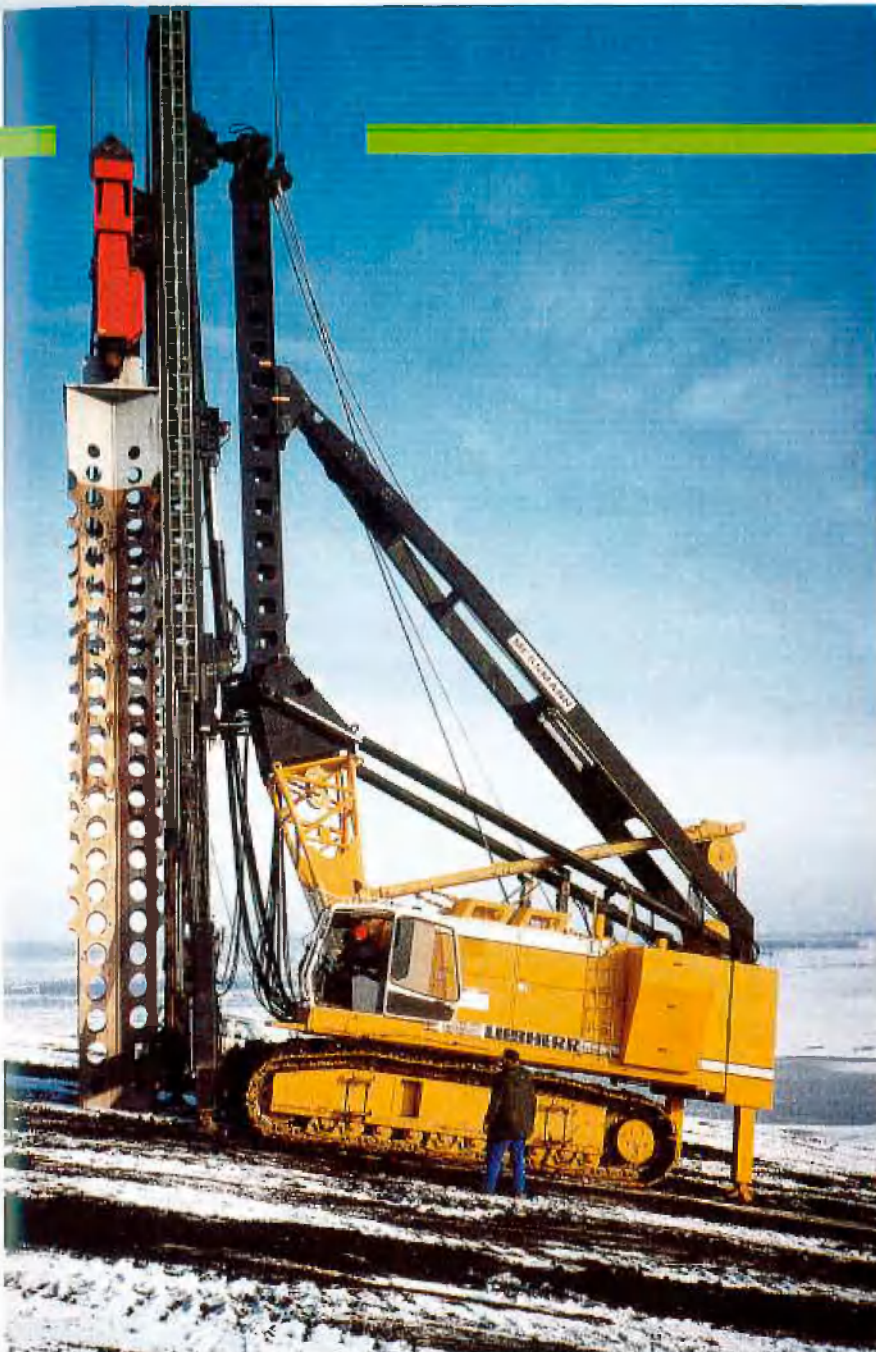
Trägergerät Liebherr HS 882 HD mit 28 m hohem Führungsmast, Vibrator und MCR-Bohle
