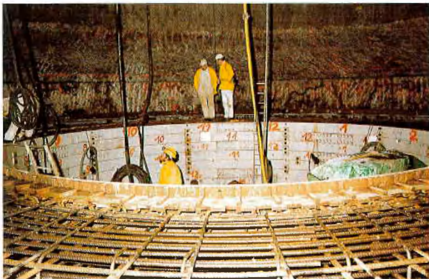
Einbau des Fundamentes für den Innenausbau
