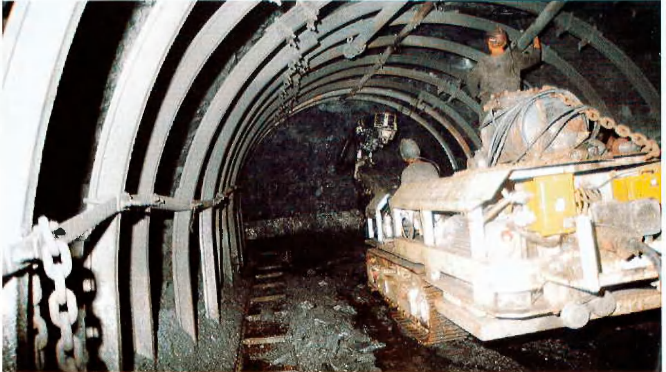
DH- Bohrwagen BFR 1 mit zusätzlich angeketteter Steuereinheit für eine Abwasserpumpe
