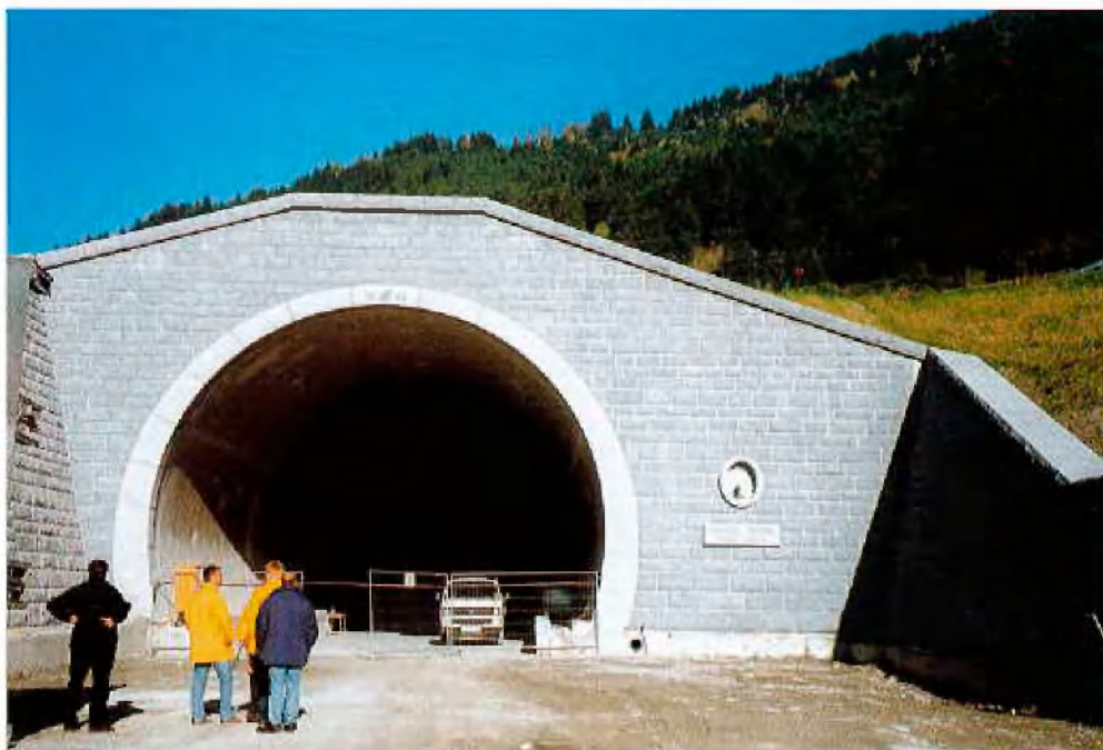
Westportal des Zammer Tunnels
