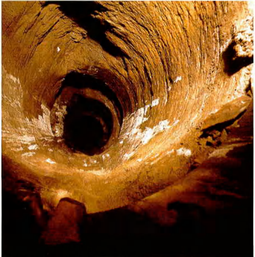
Blick in das Vorbohrloch
