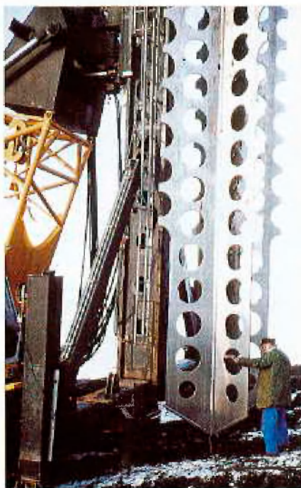
MRC-Bohle nach dem Umbau
