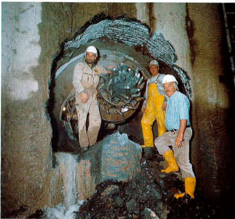
Durchschlag des unter Druckluft betriebenen Rohrvortriebs in Wuppertal
