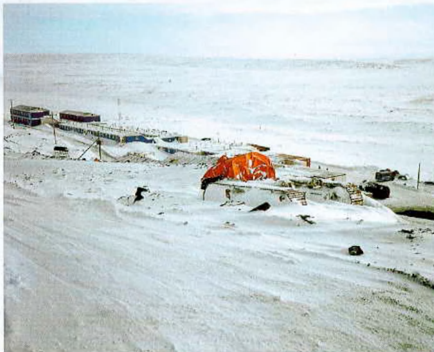
Einrichten einer Baustelle in der Arktis
