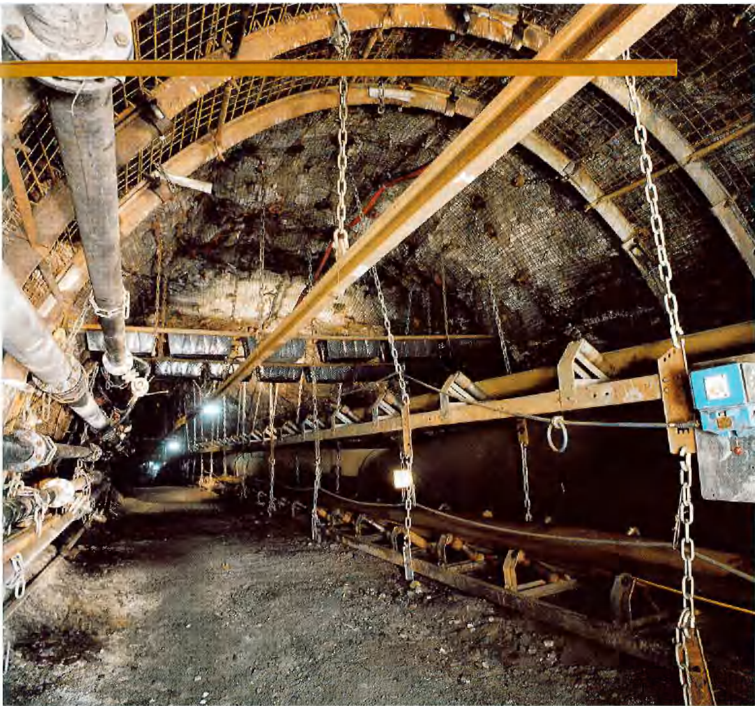
Übergang zur Ankerstrecke mit Leerbauen
