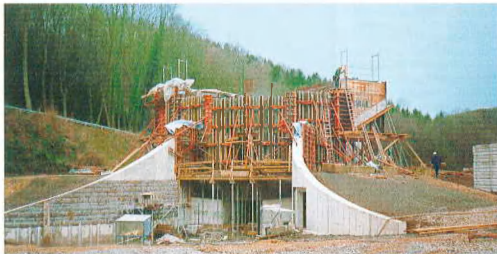
Hochwasserrückhaltebecken in Heiligenhaus
