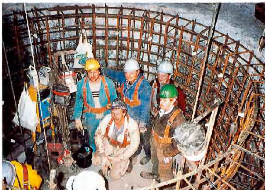
Bauphase 1 - Mannschaft vor Ort
