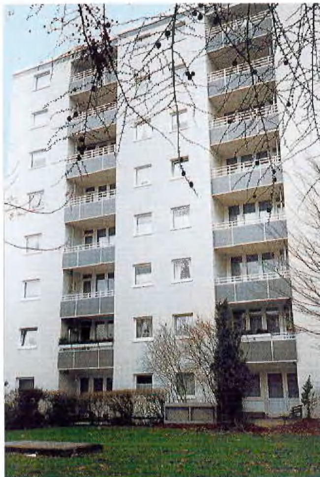
Sanierte Hochhaus-Balkone in Unna
