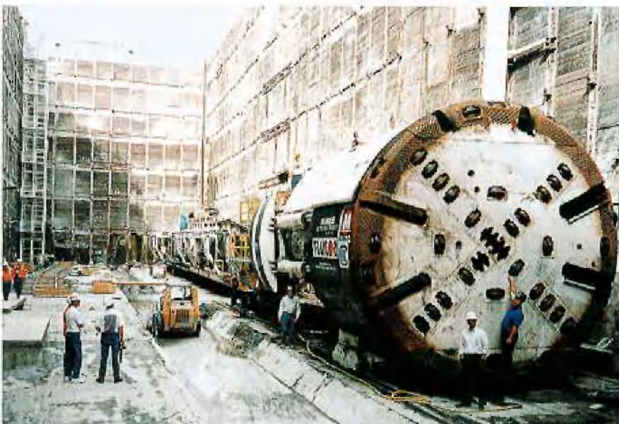
Tunnelbaustelle in Los Angeles
