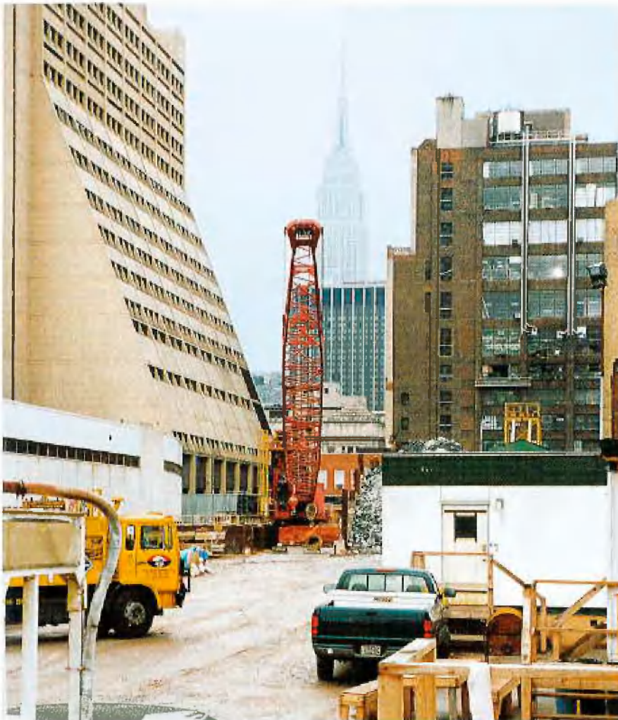
Schachtbaustelle in New York City
