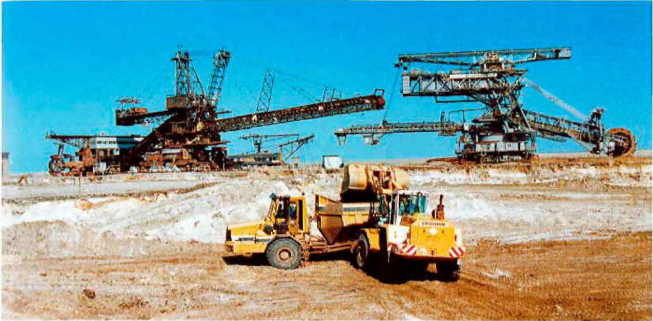
Erdarbeiten für Ferropolis
