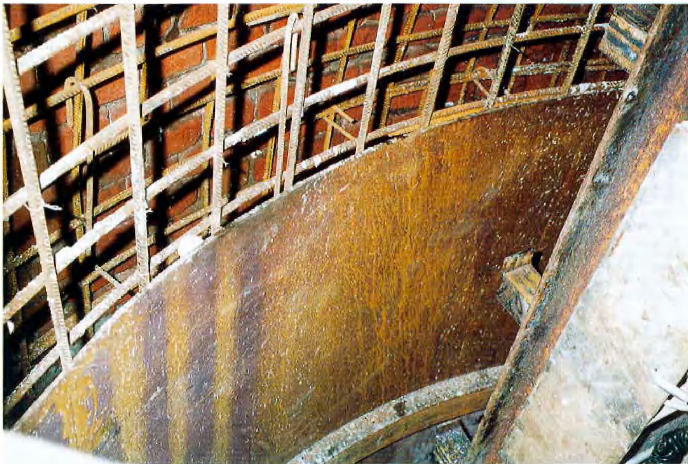
Stahlblechmantel und Bewehrung im Bereich des alten Fundaments
