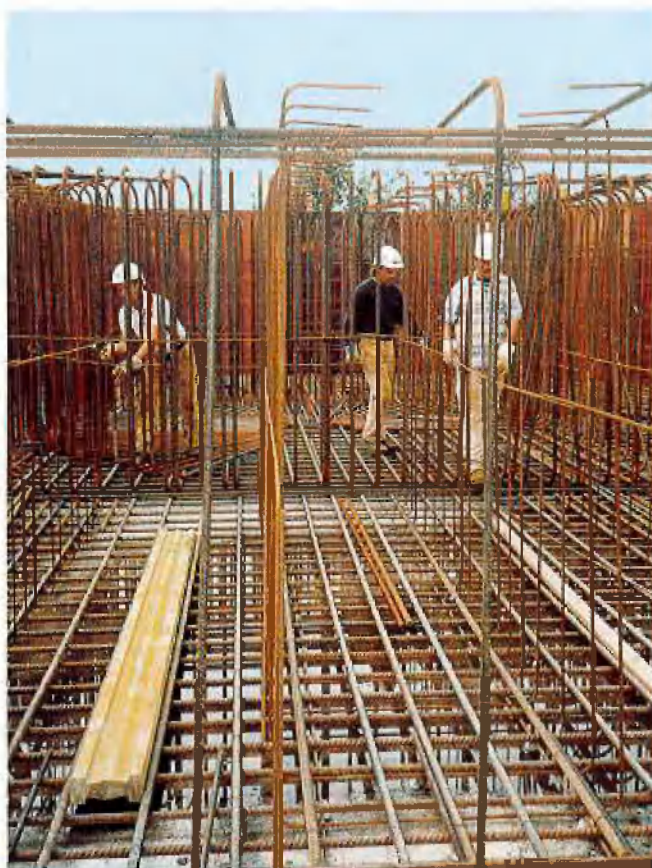
Fundamentarbeiten für die Windkraftanlage auf der Halde Hoppenbruch
