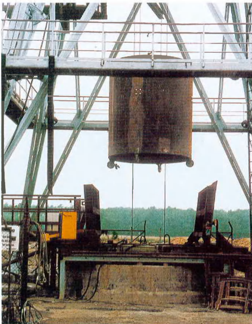
Einhängen eines Rohrschusses
