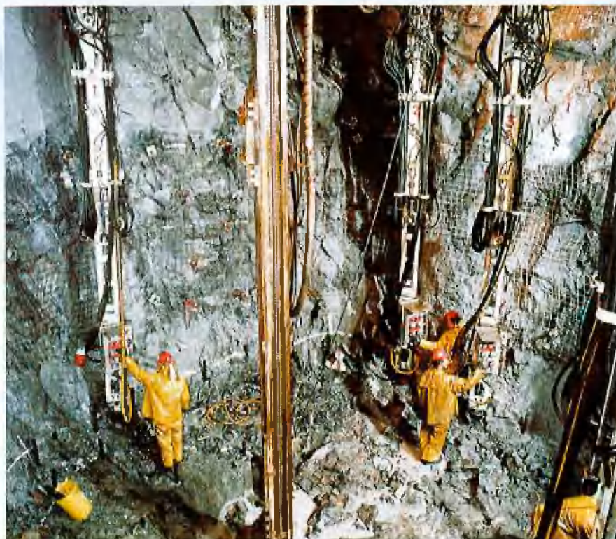
Bohren der Sprenglöcher
