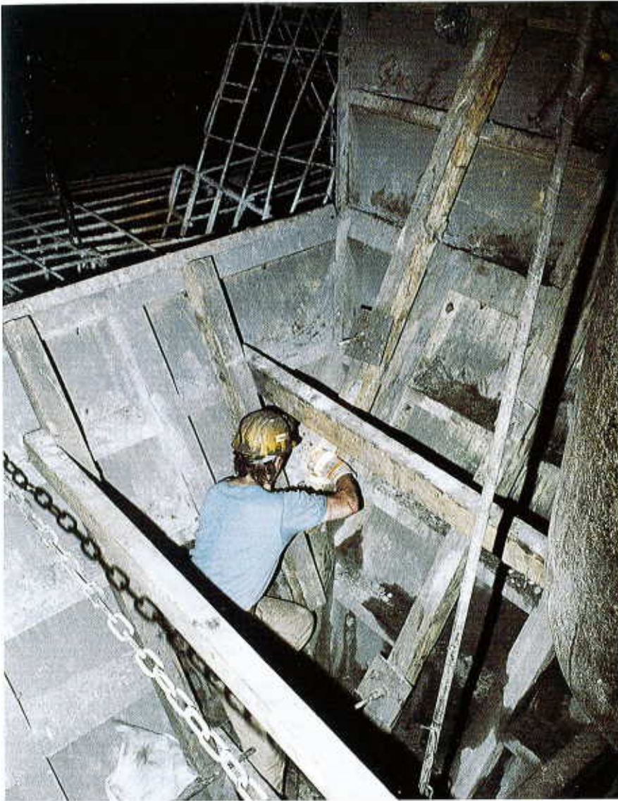
Abdichten der Bunkerauslaufschalung
