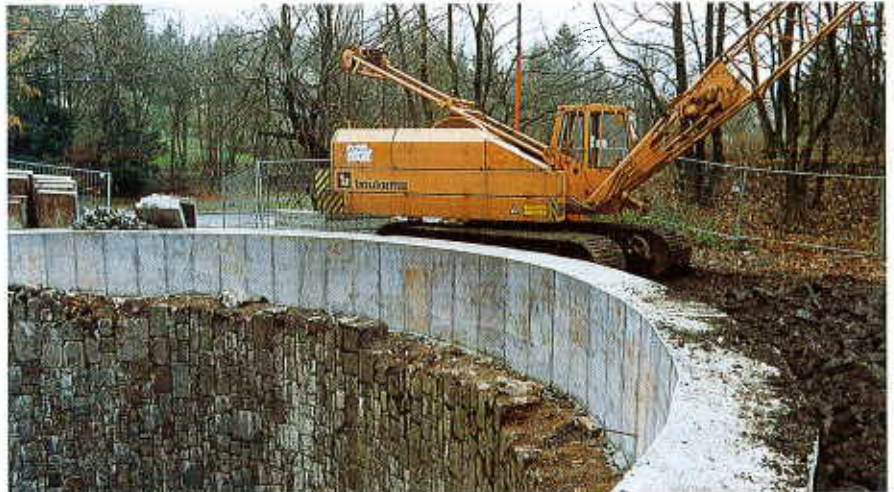
Ringbalken als Kopfsicherung
