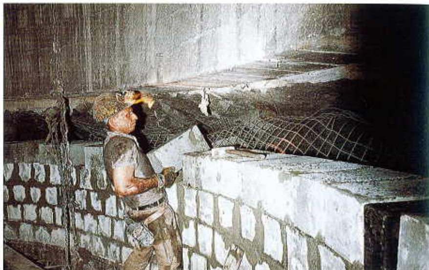
Mauern mit den 40 kg schweren Betonformsteinen
