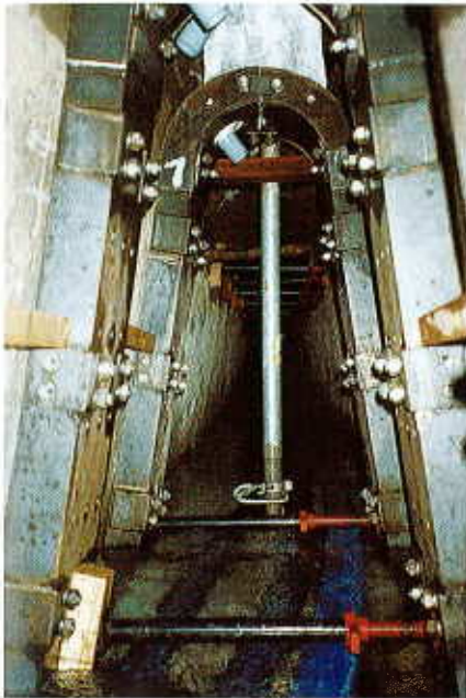
Schalungen vor Befüllen der Schläuche
