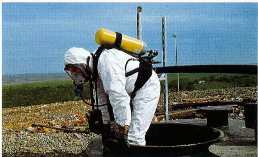
Kontrolle der Sickerwasserleitungen und Schächte
