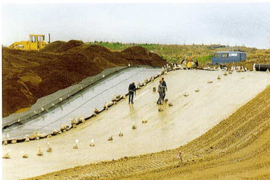
Deponiebau – Basisabdichtung
