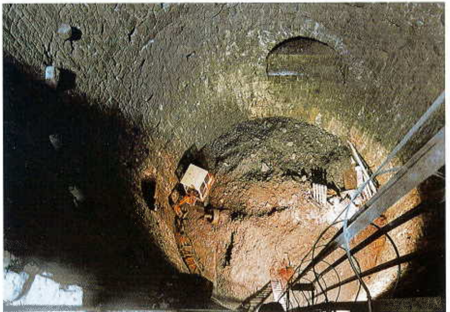
Blick auf die Sohle der Radstube Wasserzulauf
