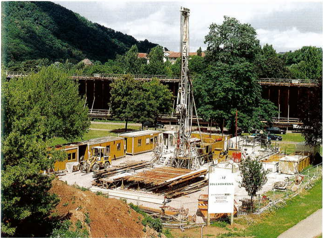
Bohranlage vor der Saline
