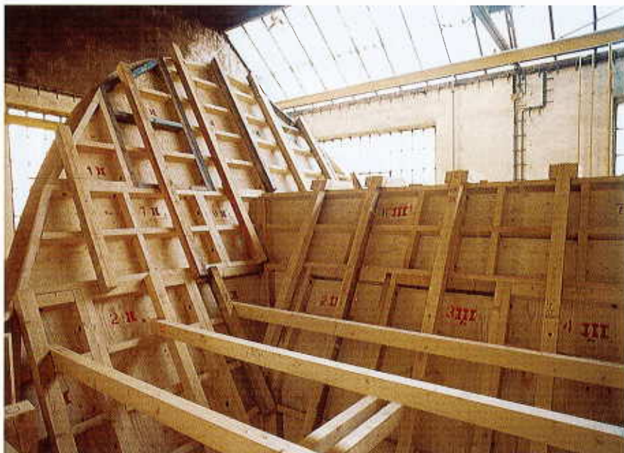
Bunkerauslaufschalung – Reiter und große Schräge
