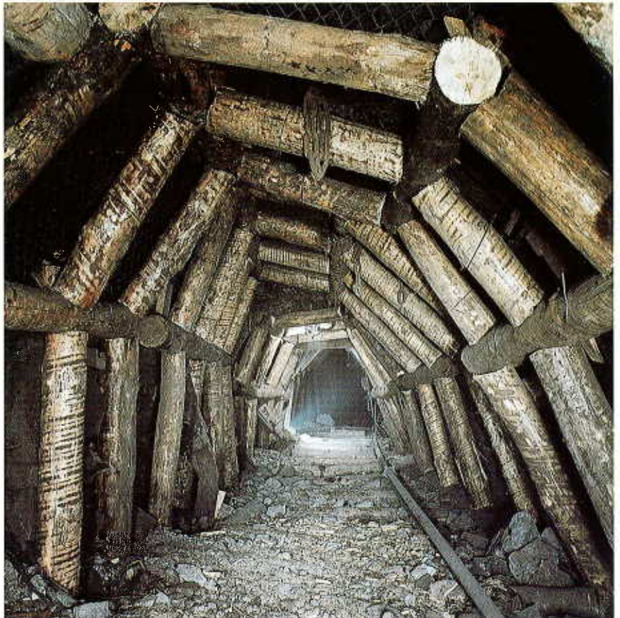
Polygon-Holzausbau in der Kopfstrecke Chriemhilt
