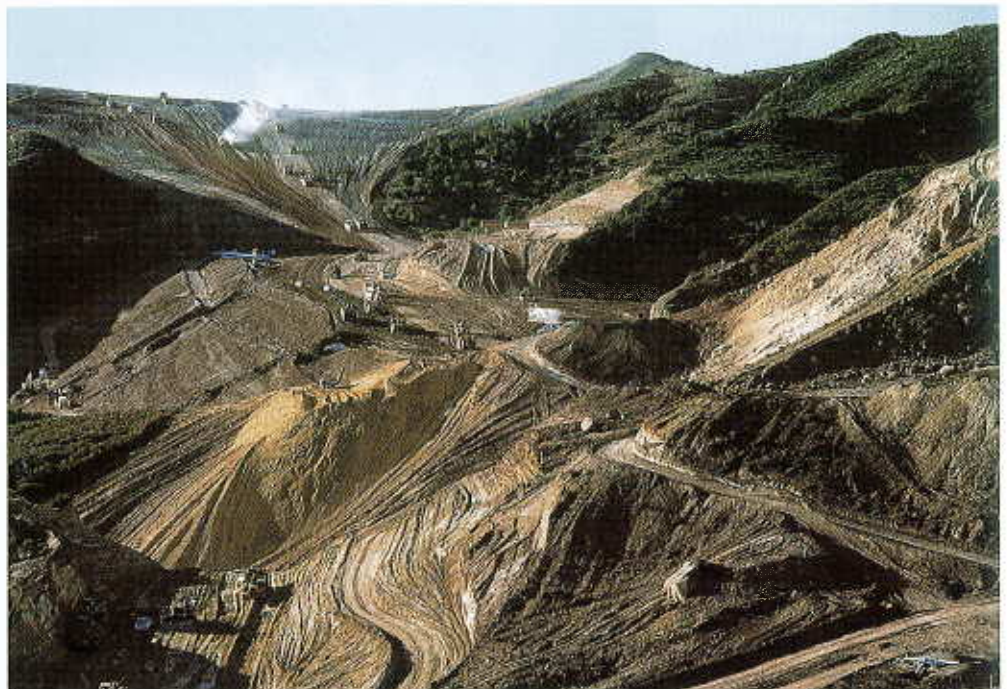
Autobahnbau im Orange County, Kalifornien
