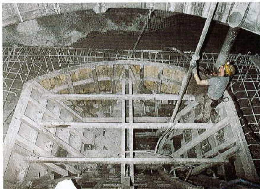
Betonieren des Bunkerauslaufs
