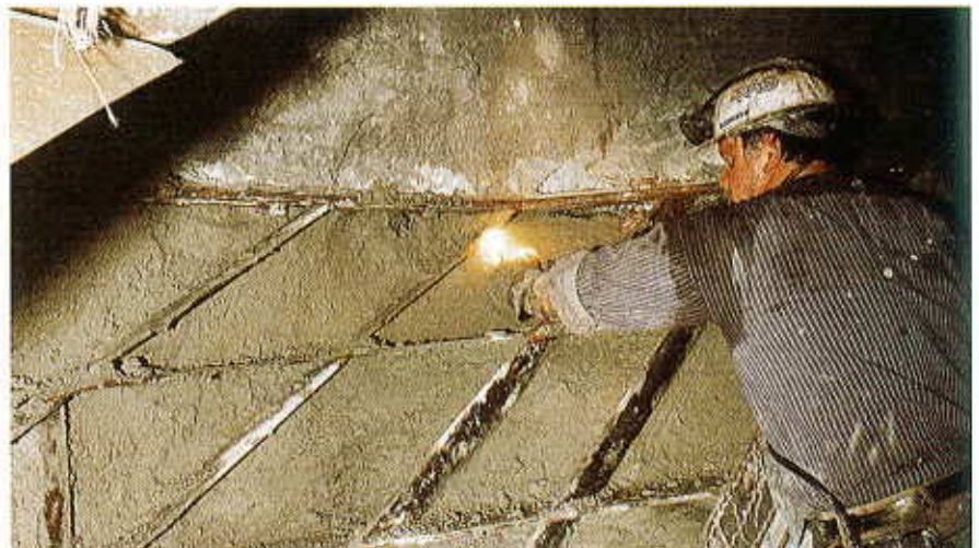
Verputzen/Abdichten der Wendelelemente
