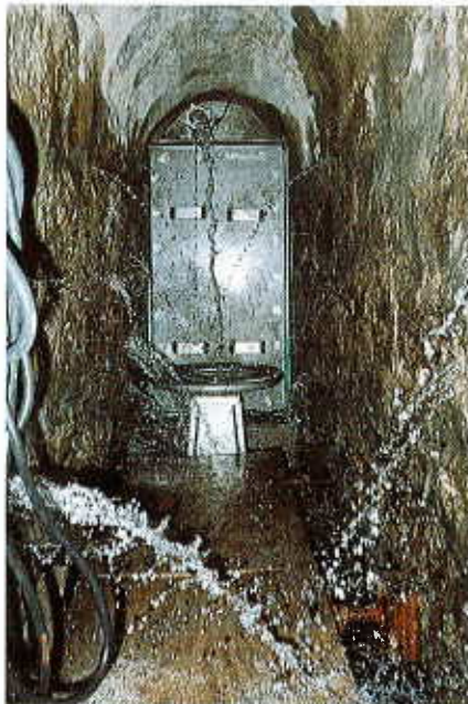
Stauerwand mit Revisionstür
