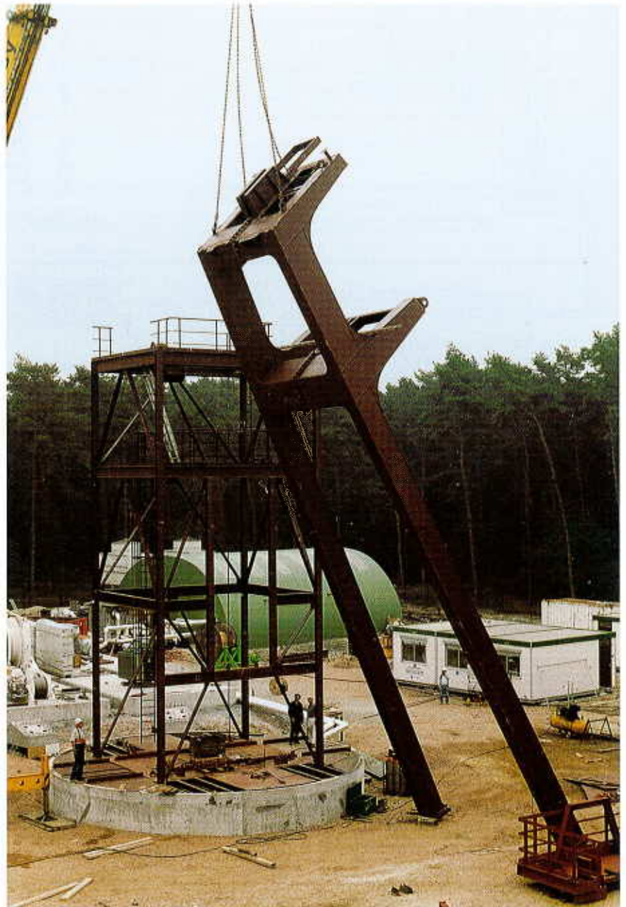
Montage des Teuf- und Fördergerüsts
