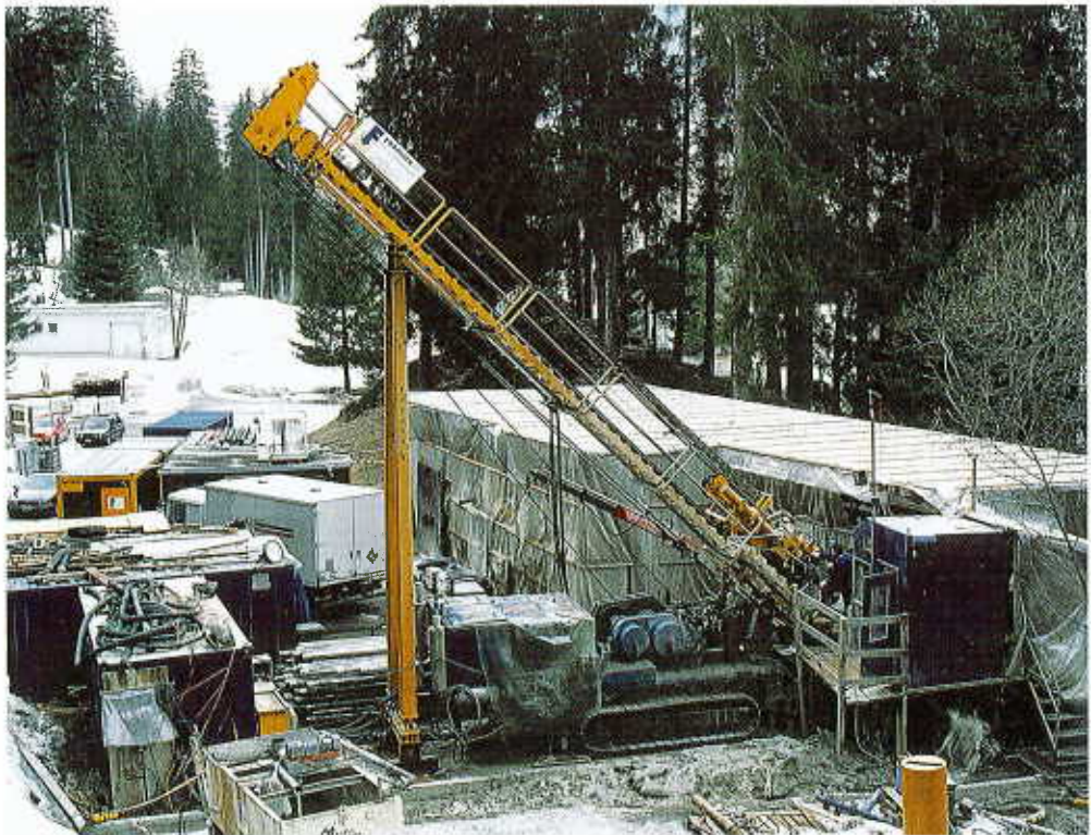
Sondierbohrung für den Gotthard-Basistunnel
