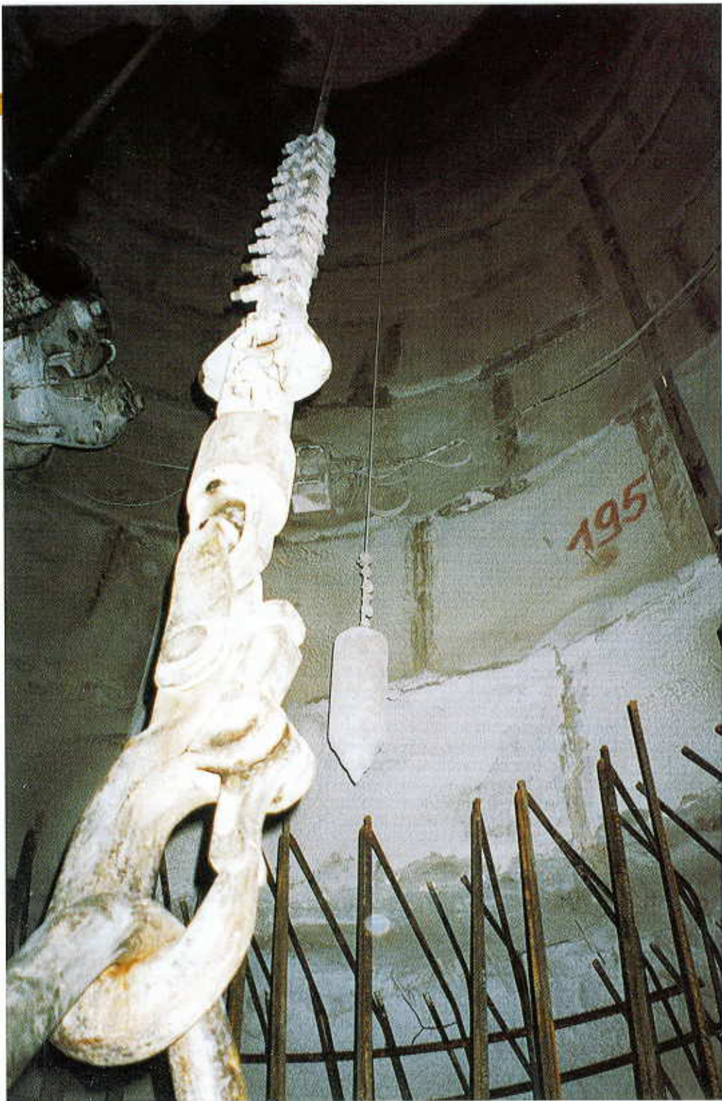
Spritzbeton als nachgiebiges Ausbausystem
