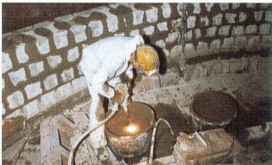
Anmischen des Mauermörtels
