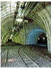
Streckenabzweig auf dem Bergwerk Lohberg/Osterfeld
