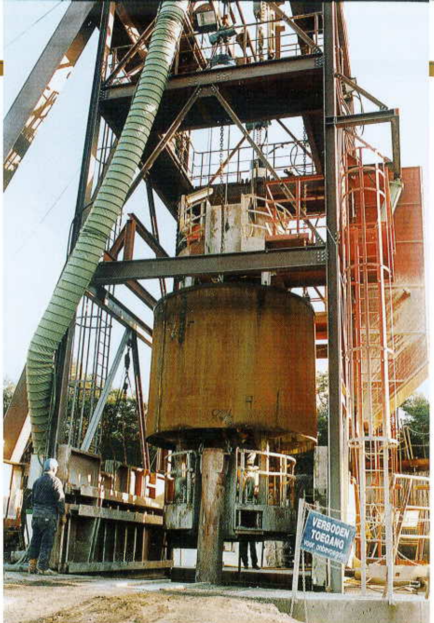
Auf der Arbeitsbühne abgelegter Rohrschuß
