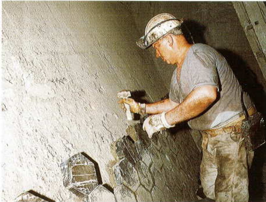
Einbringen des Verschleißschutzes im Bunkerauslauf
