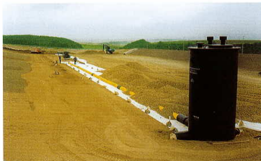
Deponiebau – Sickerwassererfassung
