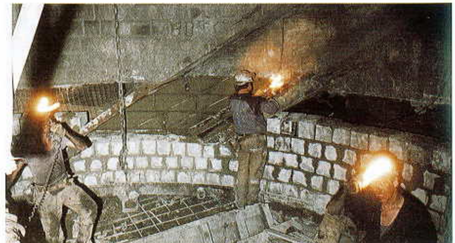
Herstellen des letzten Mauerabsatzes
