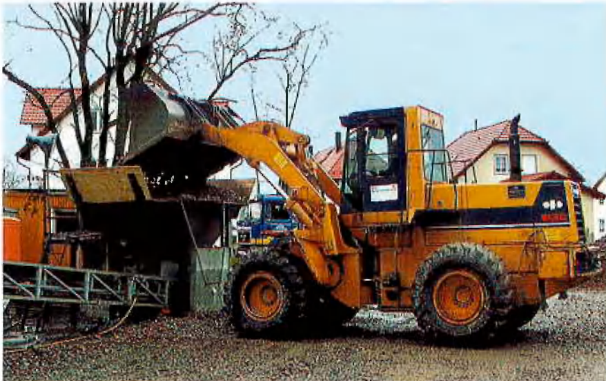
Beschickung des Aufgabetrichters bei der Verfüllung mit Hartgesteinschotter
