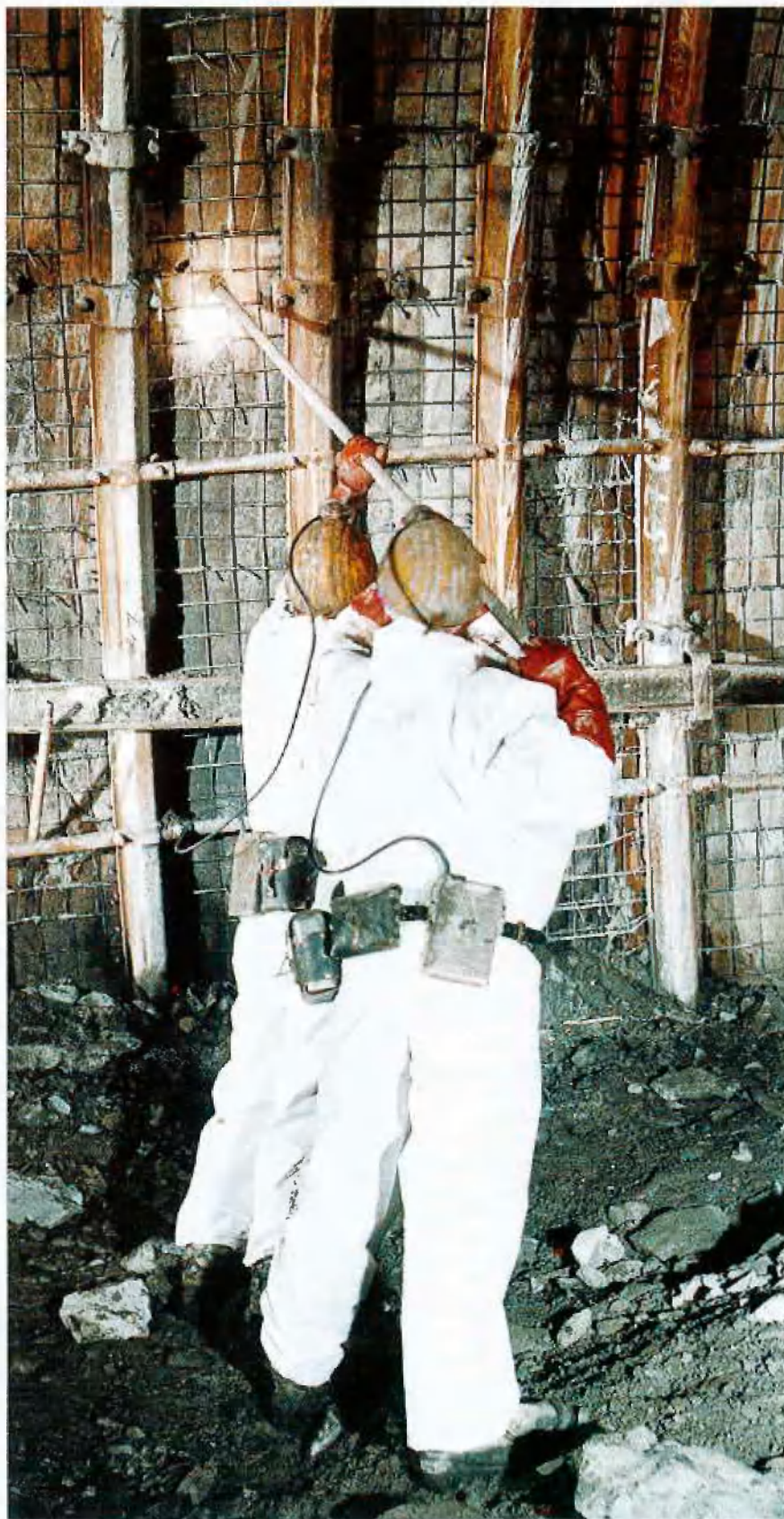
Setzen der Mörtelanker
