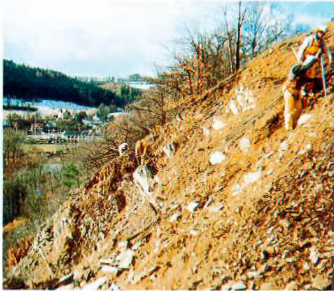
Hangsicherung mit Drahtnetzen und Ankern
