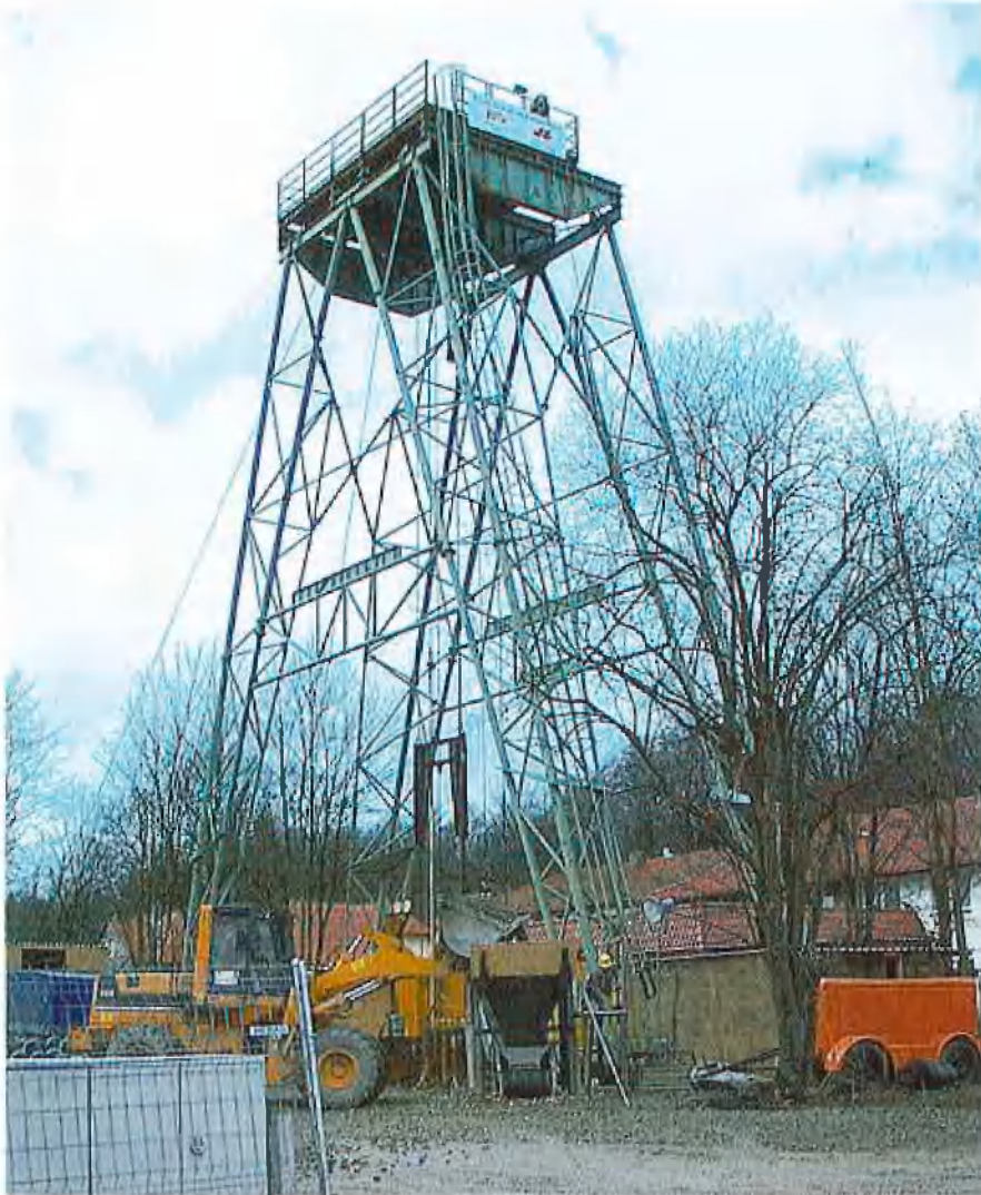
Fertig montiertes Fördergerüst
