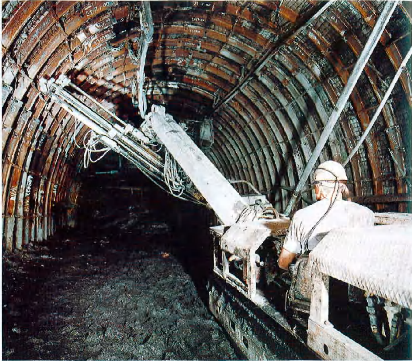
Bohren der Ankerlöcher
