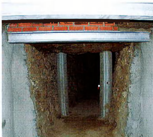
Sicherung eines Streckenkreuzes in der Parkhöhle Weimar
