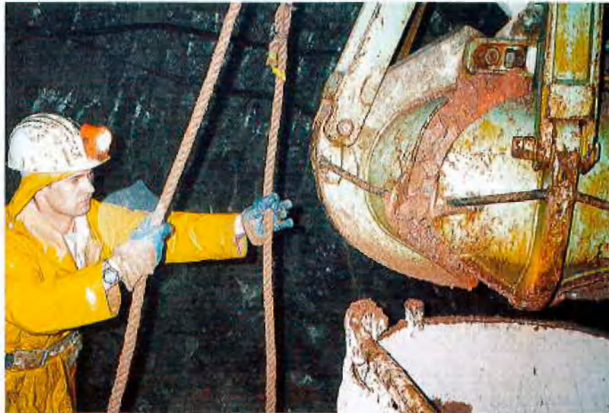
Beladen des Kübels mit geraubtem Schachtausbau
