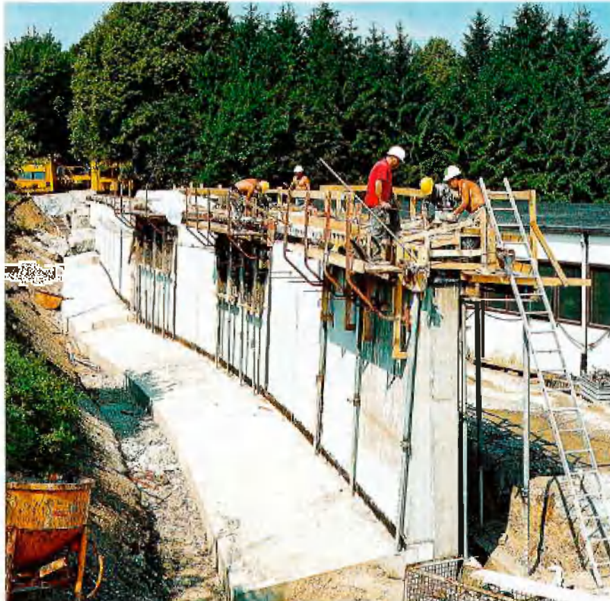
Bau einer Stützmauer in Remscheid
