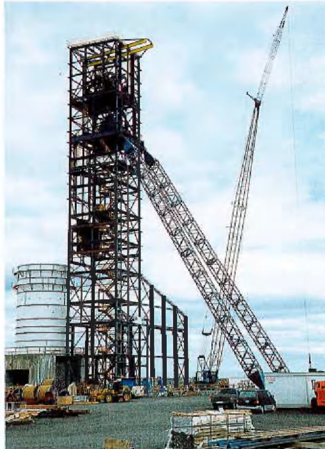
Schachtabteufen für HBM&S
