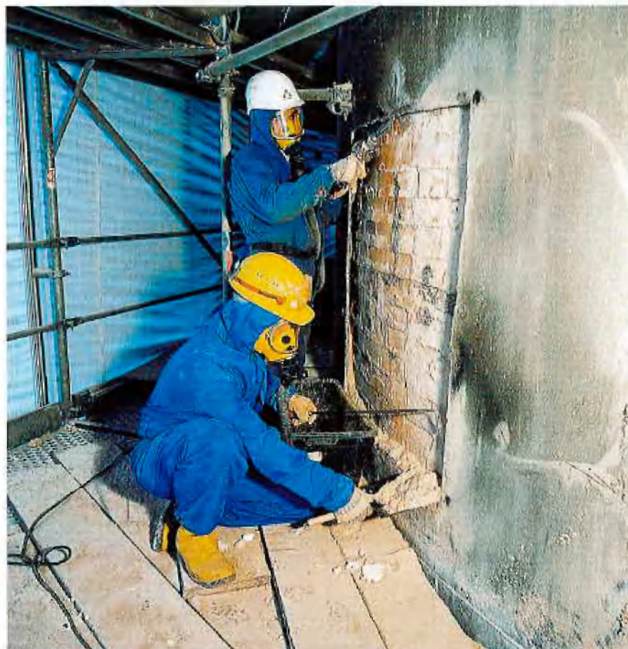
Asbestentsorgung in Duisburg
