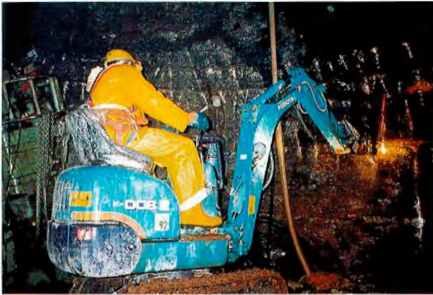
Spitzarbeiten mit dem Minibagger zur Erstellung der Verzahnung im Widerlagerbereich
