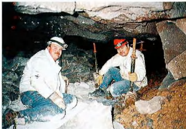
Temporäre Abstützung eines Stollens in Mendig
