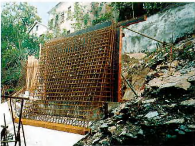
Stützwandbau im Vogtland
