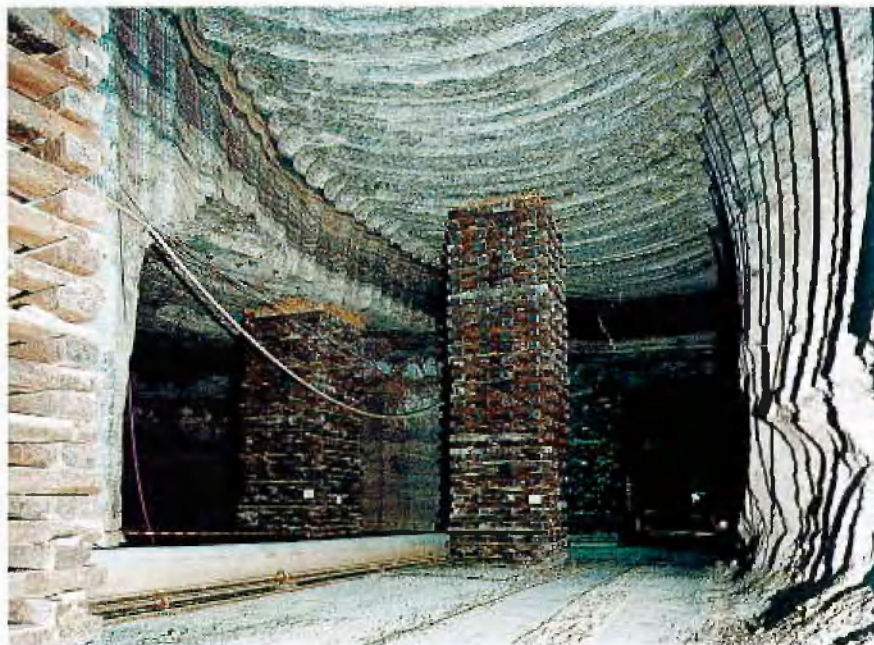
Holzkästen zur Hangendunterstützung
