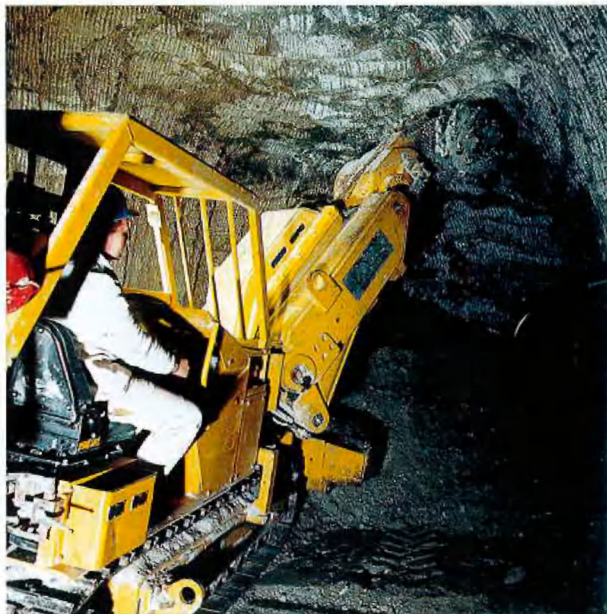
Vortrieb der Umfahrungsstrecke
