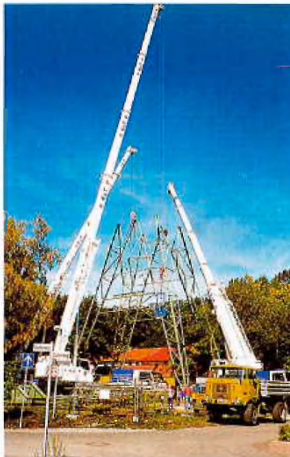
Aufbau des Fördergerüsts
