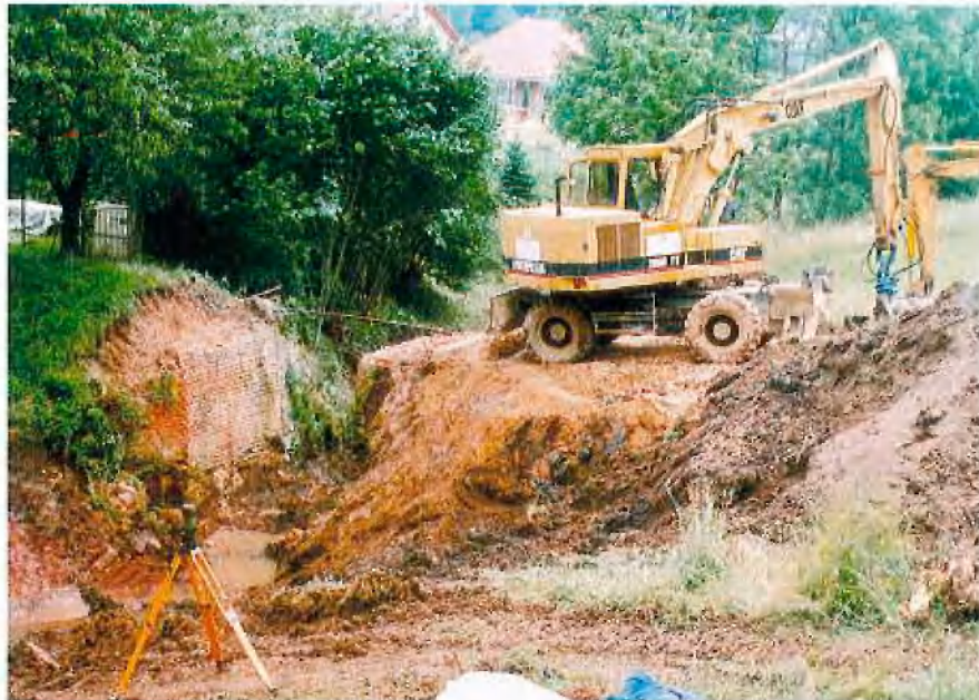
Beginn der Arbeiten am alten Bachbett
