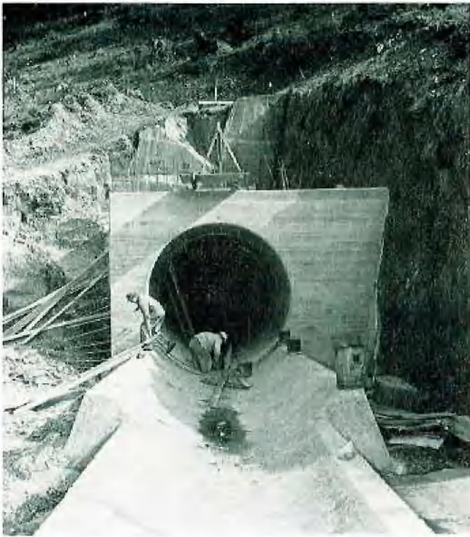
Eingangsbauwerk und Montagerinne für TVM mit Vorstollen
