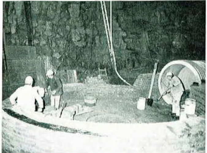
Anlegen des Außenkranzes
