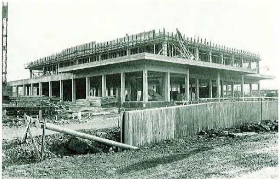
Sozialgebäude O & K Gesamtansicht mit davorliegender Stützwand
