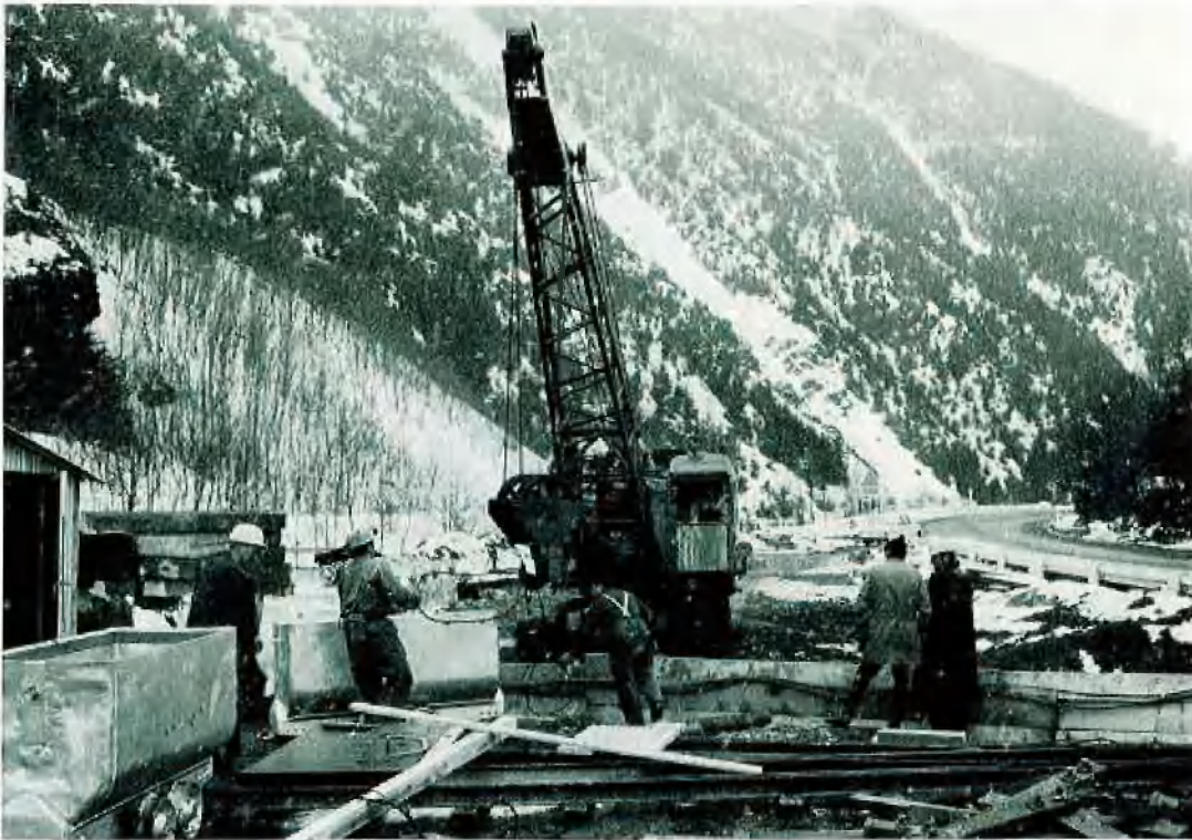
Montage der Baustelleneinrichtung am Düker einlauf im Okertal
