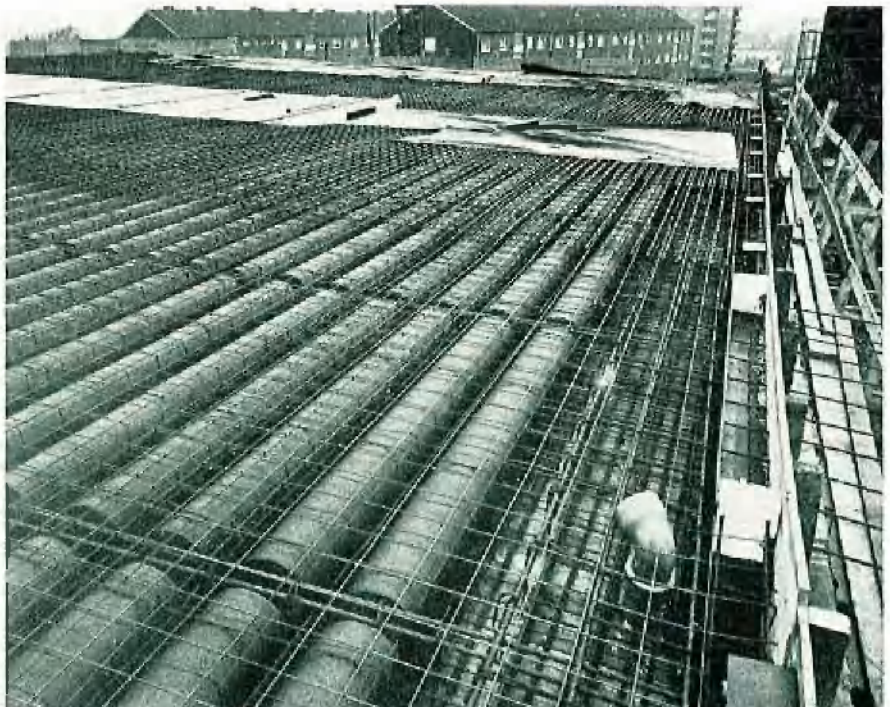
Rohbaudecke Massiv-Randstreifen mit Bügelbewehrung Einbau der Dachentwässerung und Auflagerplatten für die Fassadenelemente
