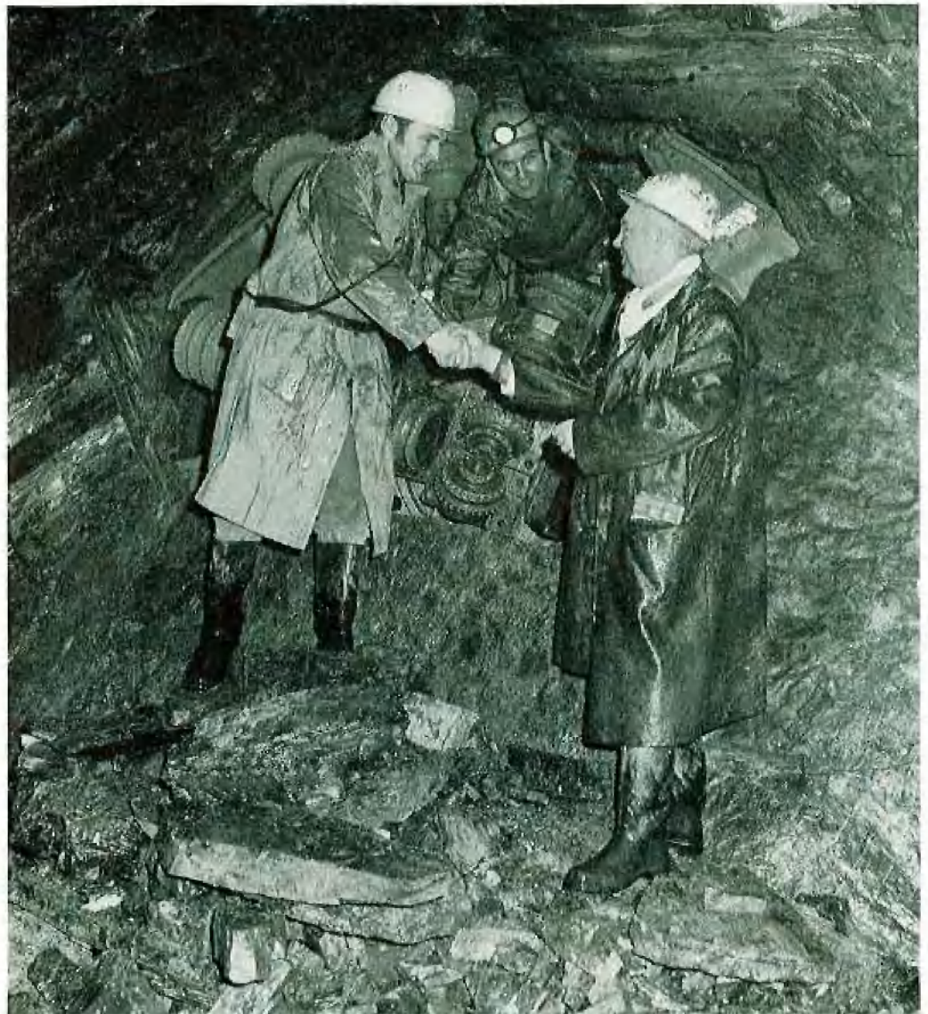
Bauleiter Zackerzewski und der Bauleiter des Gegenortes, Christian Ronacher, beglückwünschen sich am »Treffpunkt«. Im Hintergrund Maschinenfabriker Schwittay
