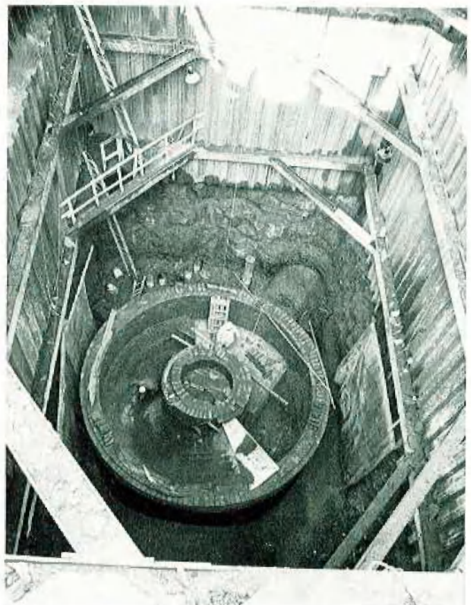
Blick in die Baugrube
