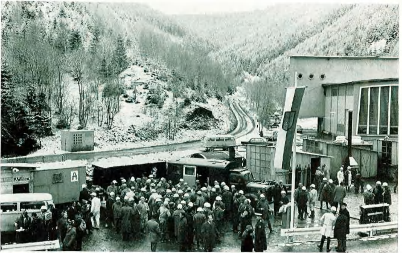
Die Baustelle im Okertal mit geladenen Gästen. Ein zünftiger Schnaps und warme Würstchen vertreiben die Kälte
