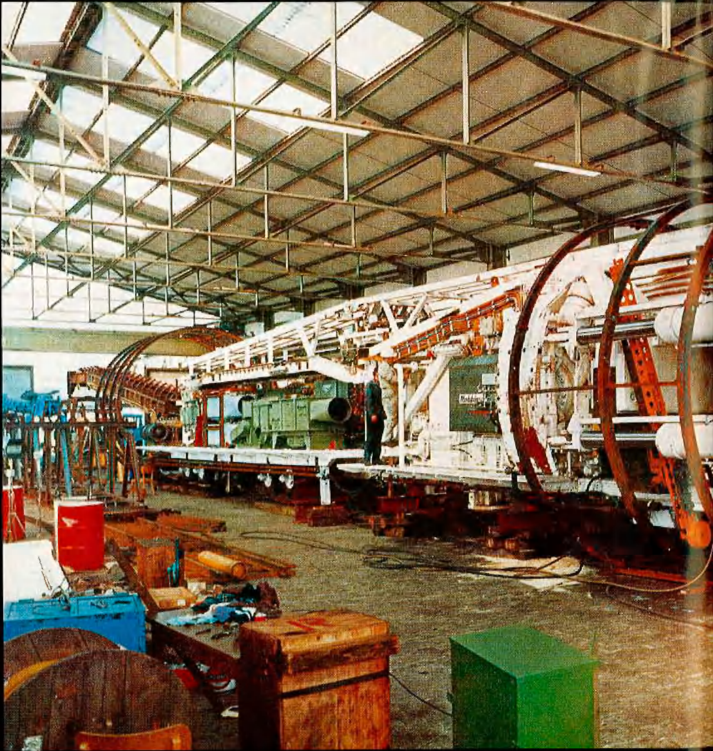
Montage der Streckenvortriebsmaschine und Anpassung von Zusatzeinrichtungen in den Werkstätten der Deilmann-Haniel GmbH, Dortmund-Kurl
