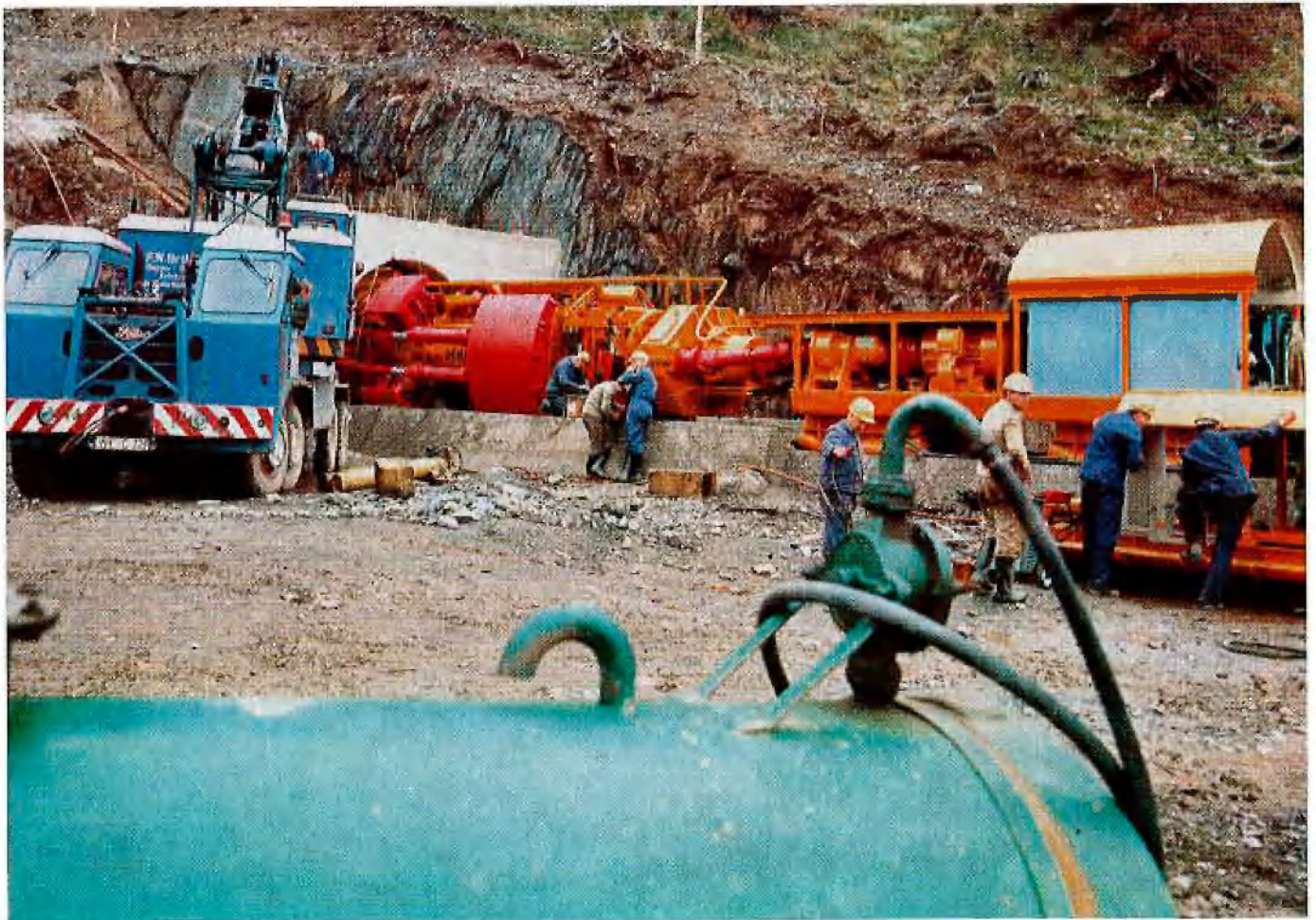
Montage der TVM (Tunnelvortriebsmaschine)
